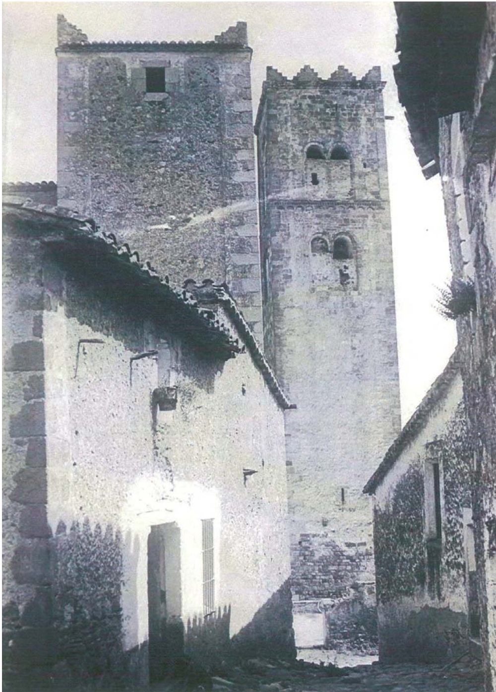
El campanar abans de la intervenció de 1928-1932 promoguda per mossèn Escudero (Arxiu SPAL, foto Antoni Gallardo, finals dècada de 1920, probablement en el curs d'aquestes obres)
