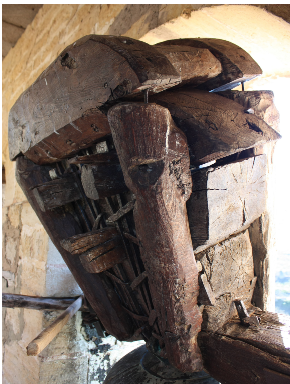
Yugo de madera de la Campana Grande de Moradillo con numerosos refuerzos de madera.
