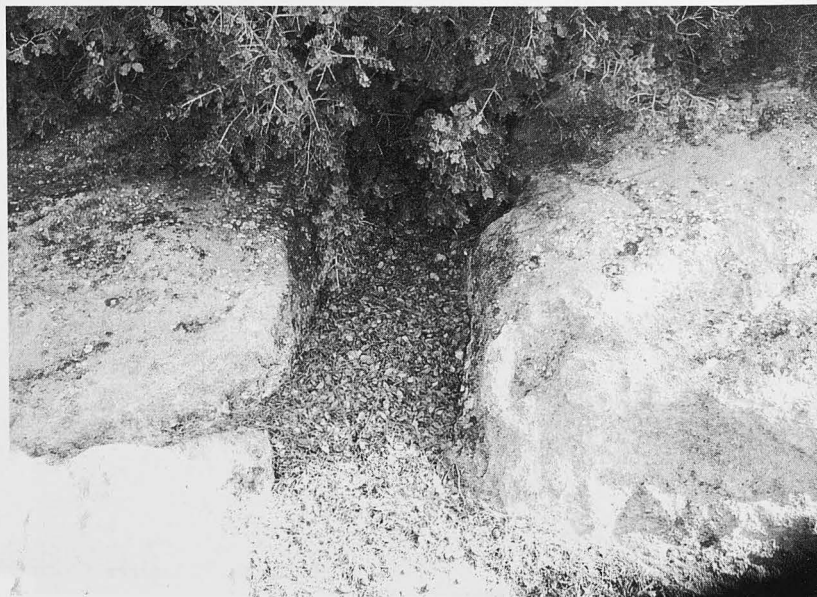
Canal excavado en la roca perteneciente a la acequia del riego del Cerro de los Molinos. S. XVII.
