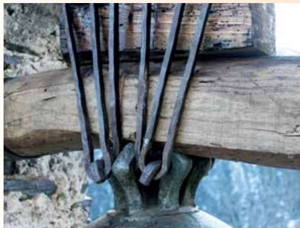
Detall de la corona de la campana i dels tirants de ferro.
