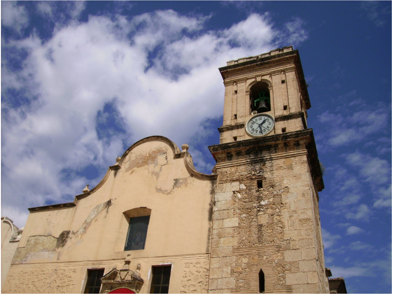
Torre-Campanario de la Iglesia de la Sangre de Cullera
