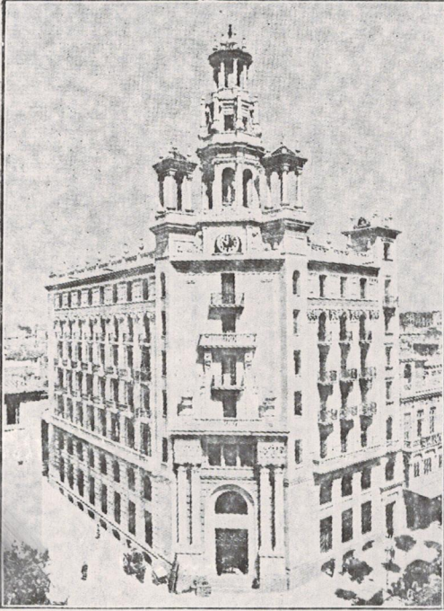
Edificio de la Caja de Previsión Social del reino de Valencia.
