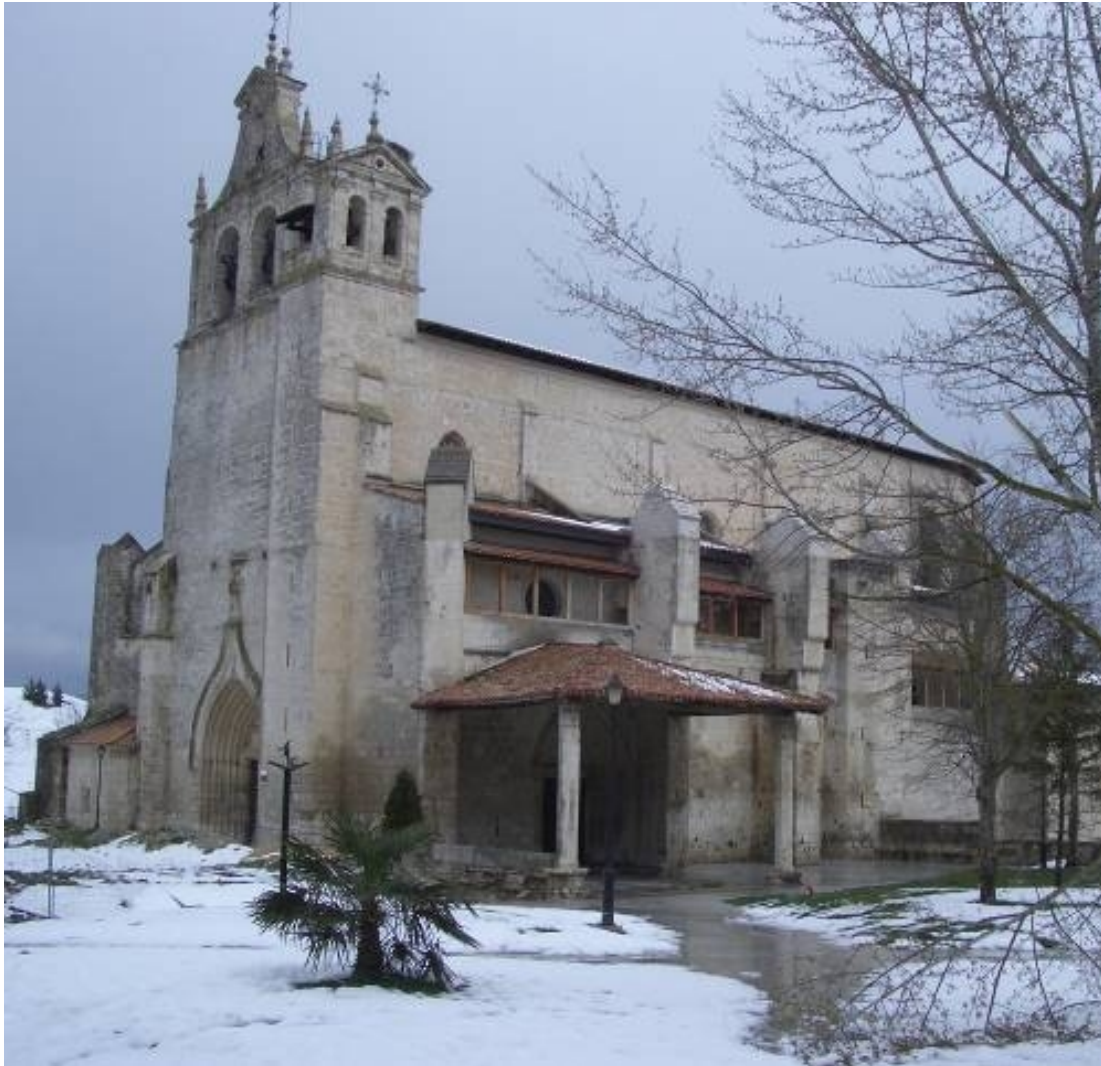
Iglesia de Santa María. Adarve y contrafuerte SO.
