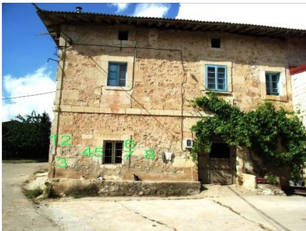
Casa nº 10 de la calle Mayor. Fachada sur.
