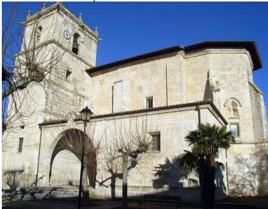
El reloj de sol en su nuevo emplazamiento.
