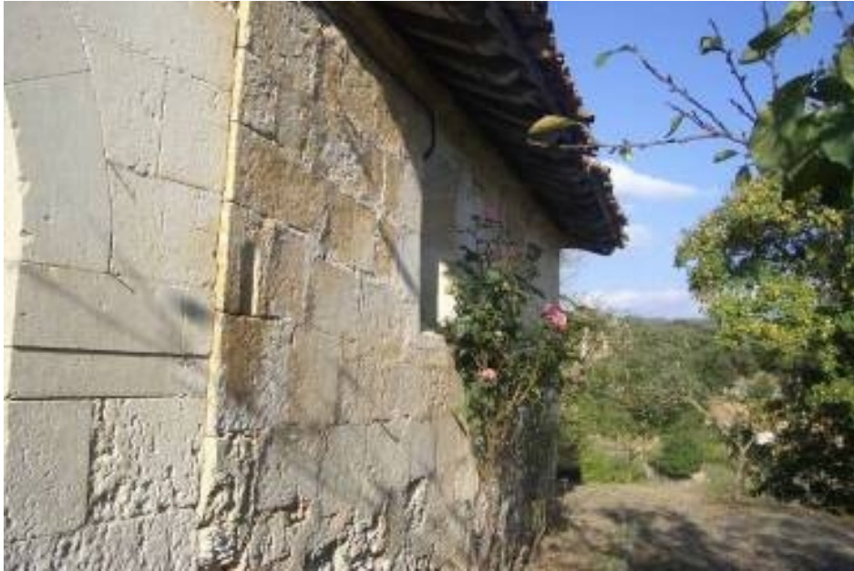
San Pedro de Aguillo. Costado sur de la sacristía.
