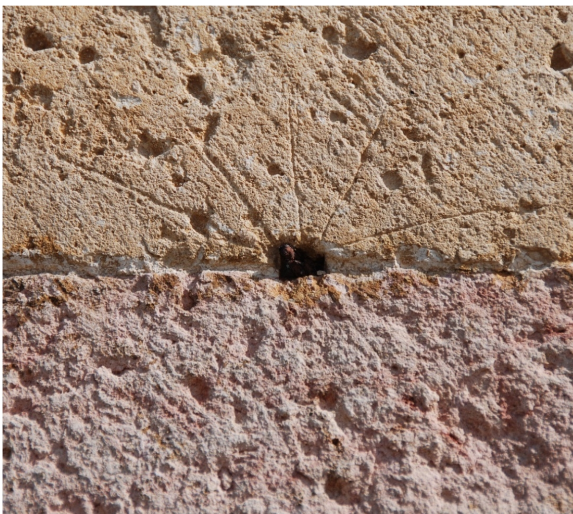
Reloj 1. Radial en junta de sillar, de 12 sectores.
