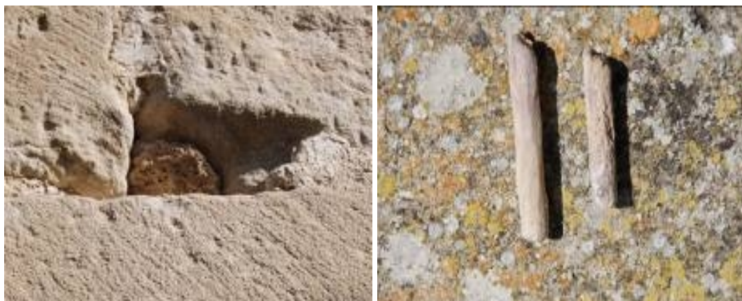
Orificio de la varilla ocluido y dos fragmentos de madera hallados en su interior.
