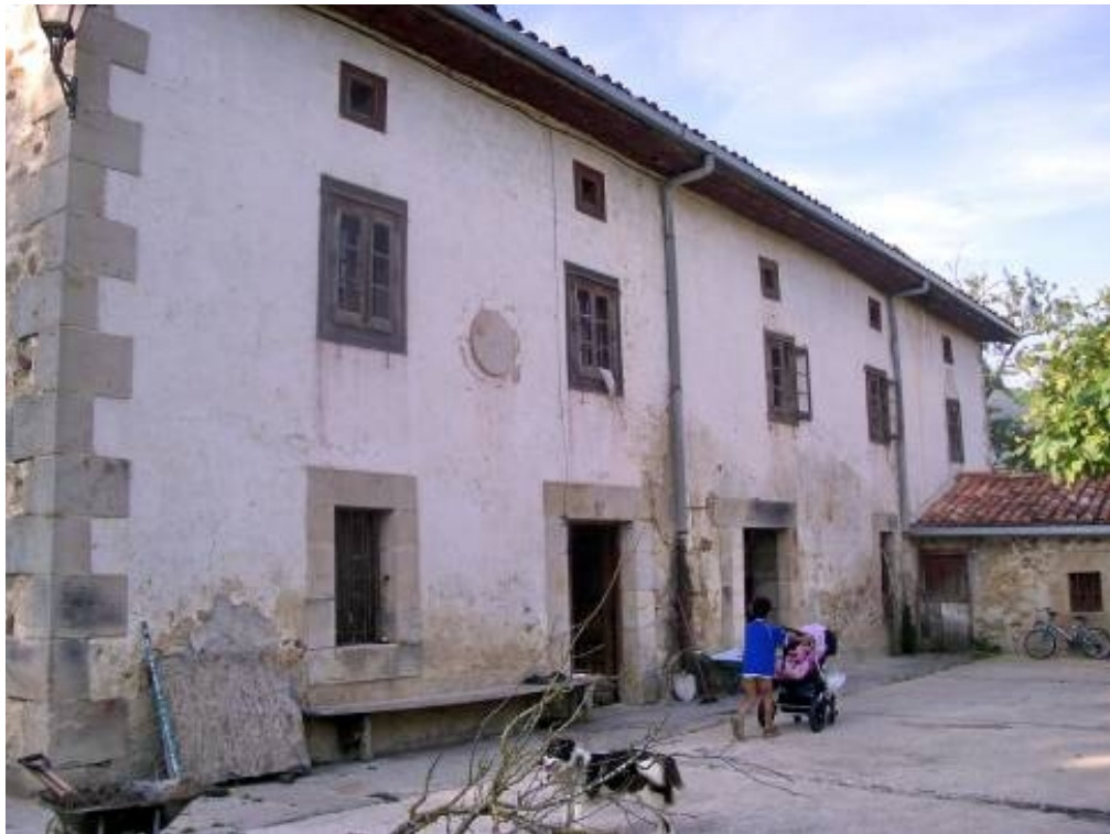
Fachada sur del caserío Beltrán en la actualidad.
