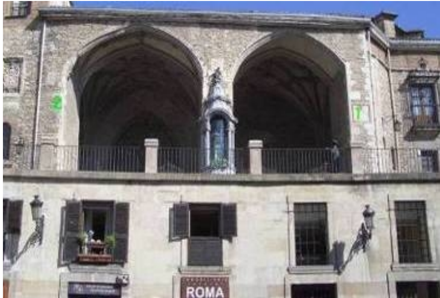
Pórtico de la iglesia de San Miguel de Vitoria.
