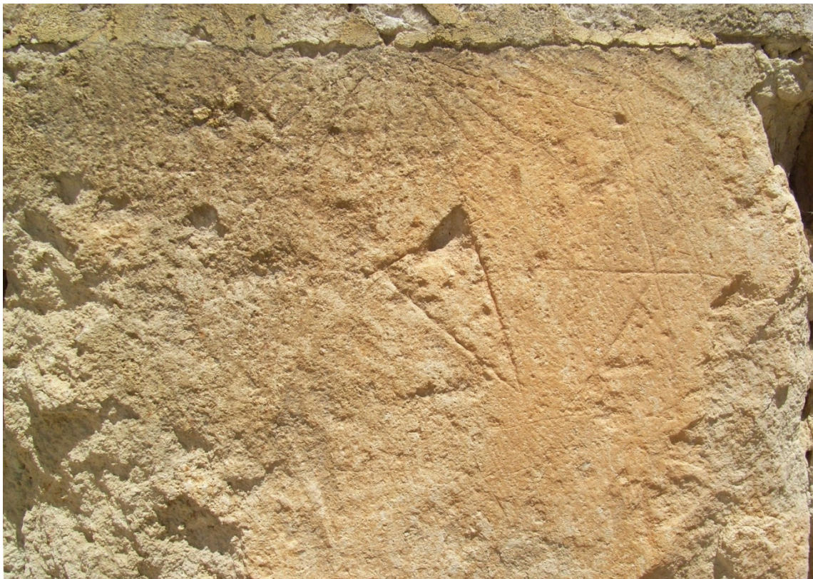
Reloj 2. Radial en junta de sillar.
