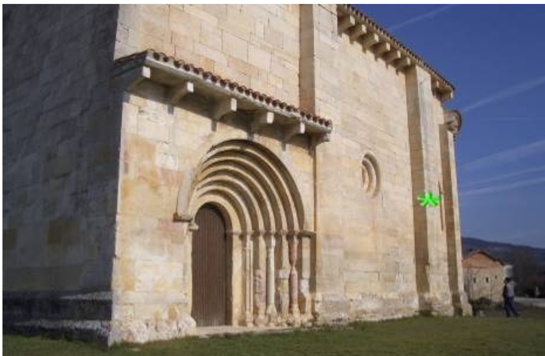
Situación del reloj de sol en el contrafuerte.
