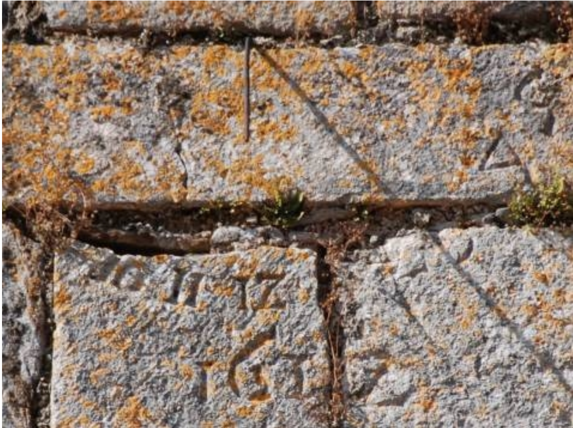
Semicircular en junta de sillar. Conserva la varilla original.
