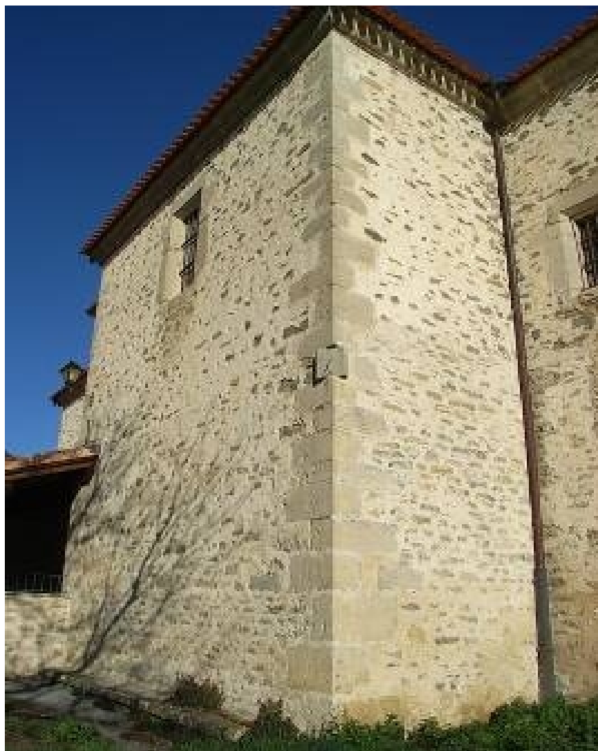
Situación del reloj de sol en la esquina sureste del crucero.
