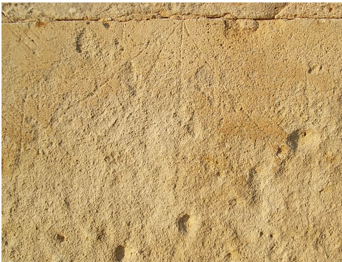
Reloj 6. Radial en junta de sillar.
