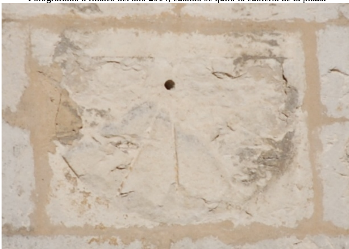
Semicircular en la cara del sillar, de 6x30°.
