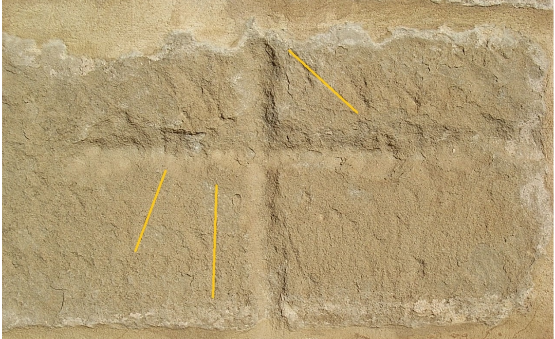
Reloj 3. Radial en junta de tres sillares.
