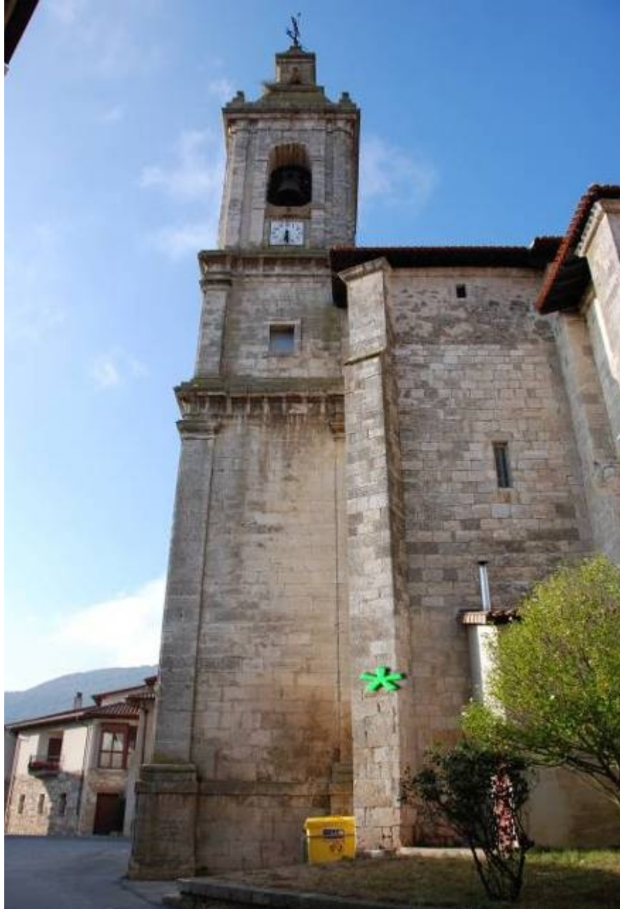
Situación del reloj de sol en el contrafuerte de la esquina SO de la nave.
