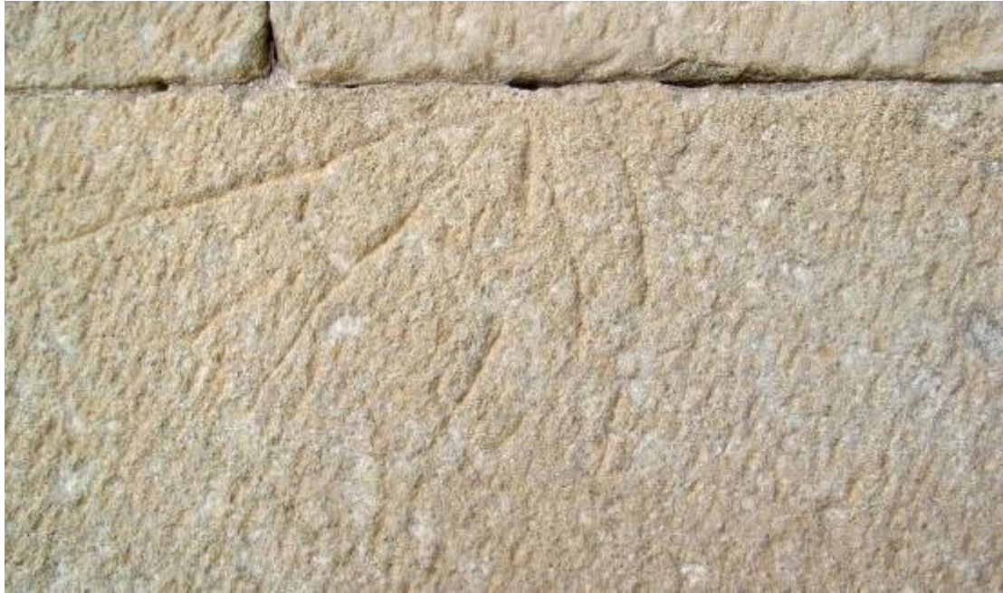
Reloj 1. Radial en junta de sillar.
