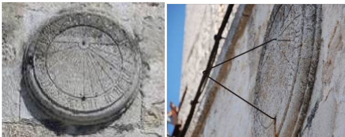
El reloj de Arrieta antes y después de colocarle la varilla.
