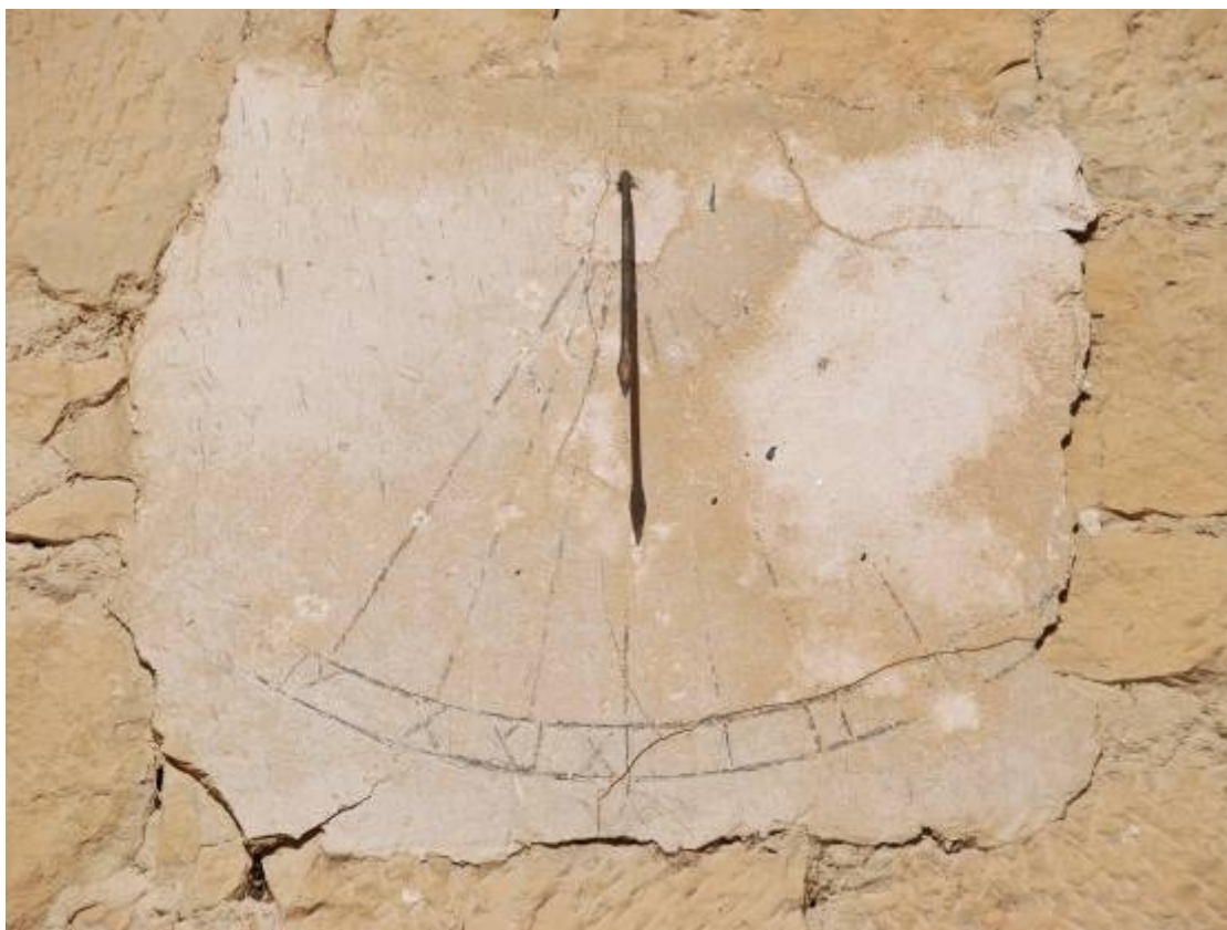
Reloj semicircular pintado en negro sobre el muro lucido. Deteriorado.
