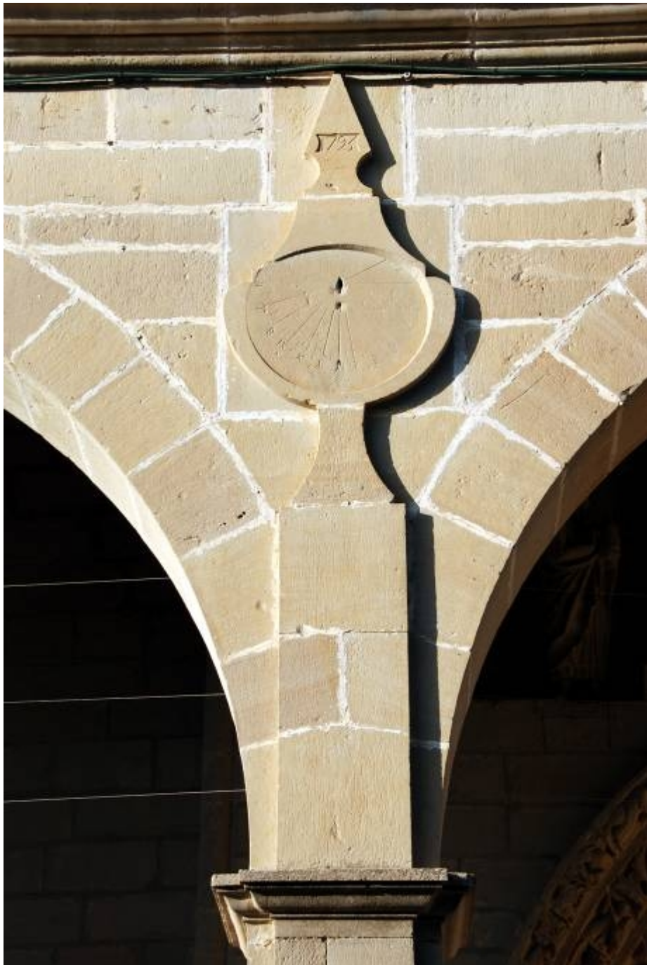
Tuesta. El cuadrante entre los dos arcos del pórtico.
