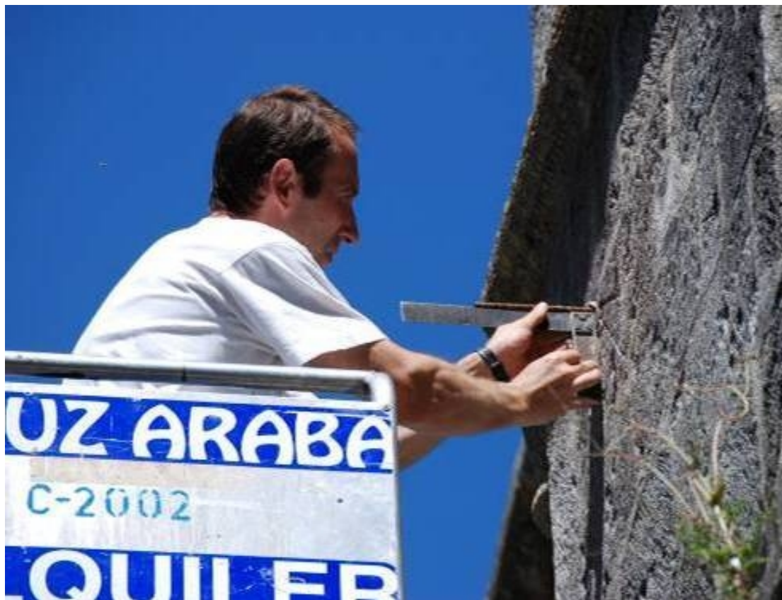
Reposición de la varilla (22 cm) del reloj canónico. Lanean. Eskuaira eta guzti!
