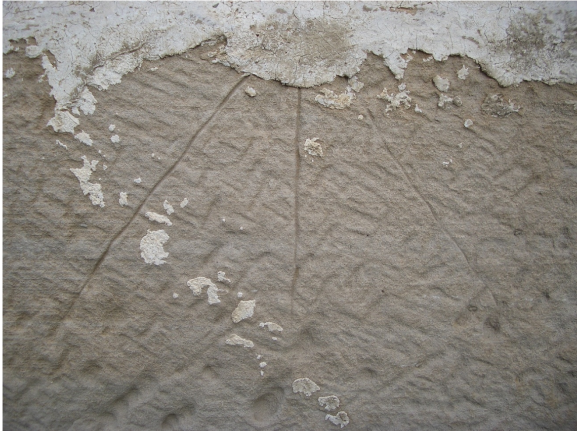
Reloj 1. Radial de tres líneas en junta de sillar. Doble Nona.
