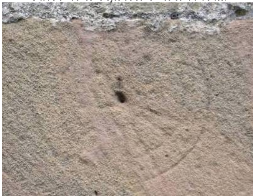
Reloj 1. Circular de 24x15°. Muy deteriorado.
