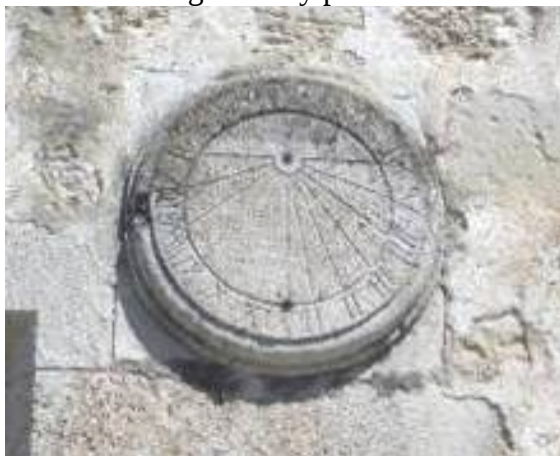
Circulares en relieve: borde moldurado, borde en arista.
