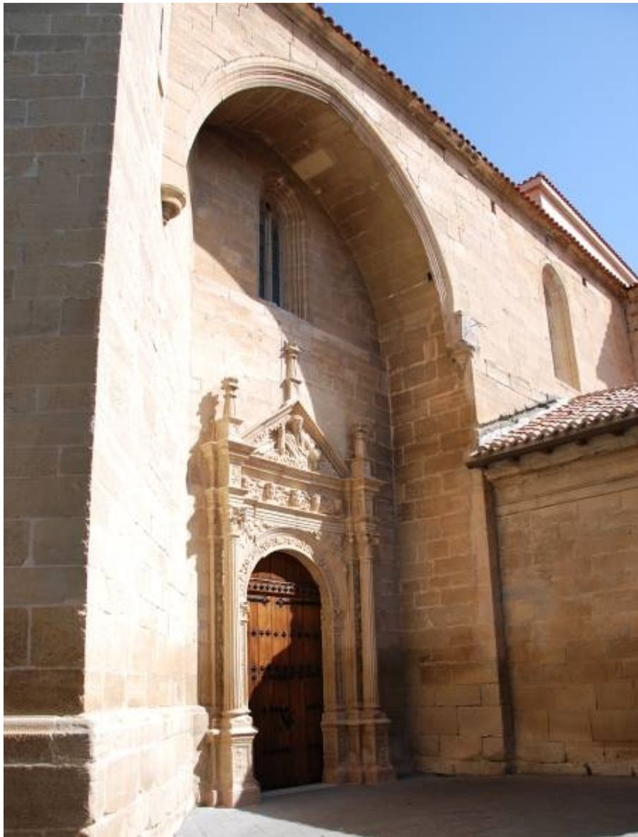
Moreda. El reloj sujeto con anclajes sobre la ménsula.
