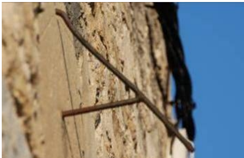
Varilla repuesta recientemente.
