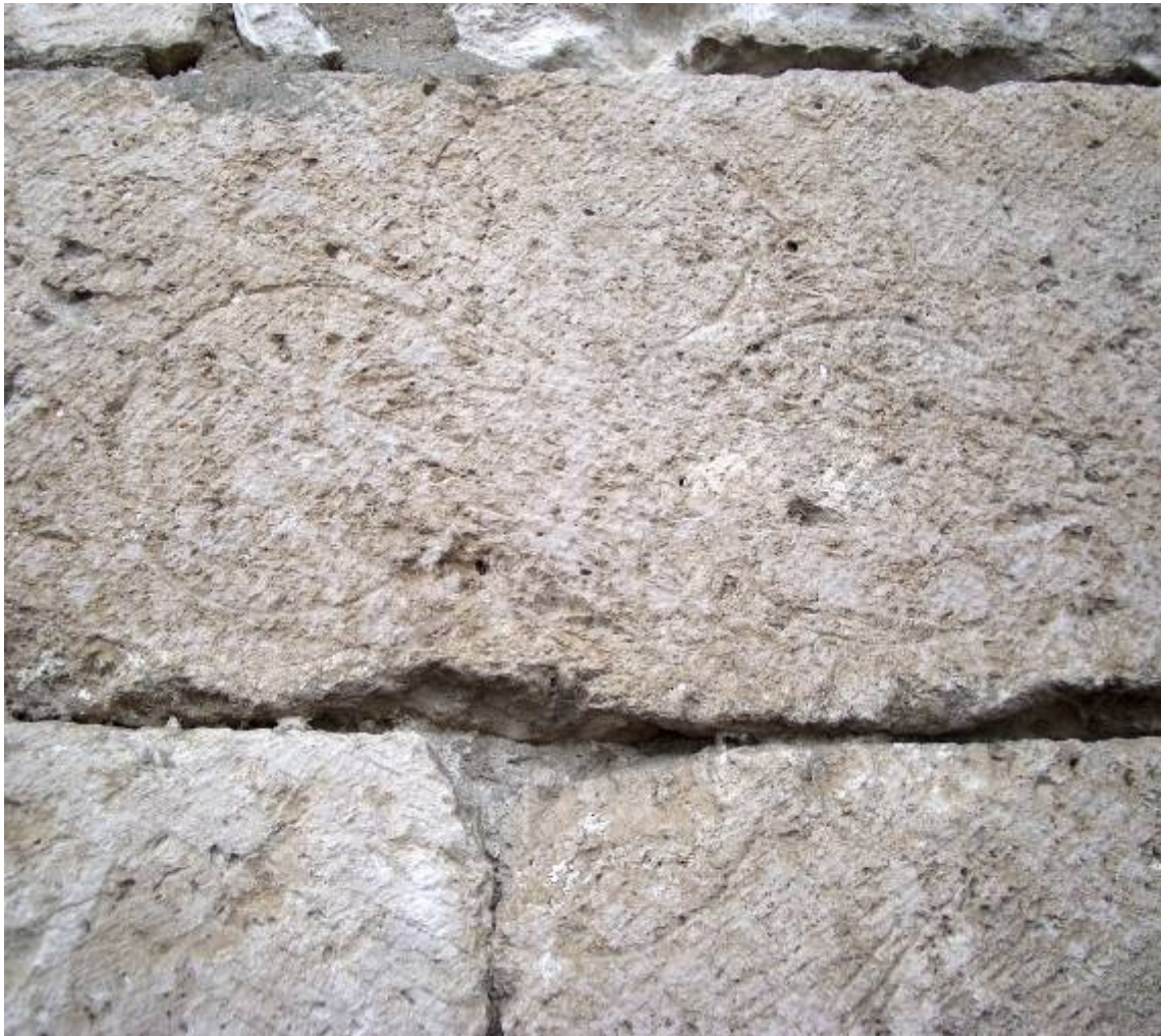
Pórtico. Contrafuerte de la esquina suroeste de la iglesia. Cuatro círculos.
