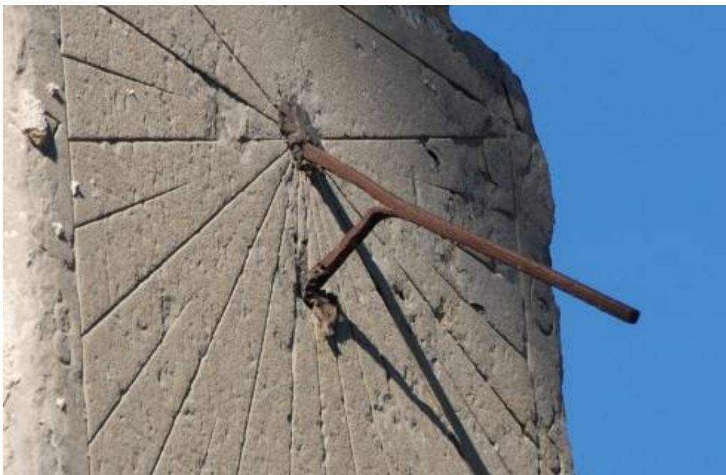
Varilla de hierro de una sola pieza, emplomada, de dos apoyos en Y.
