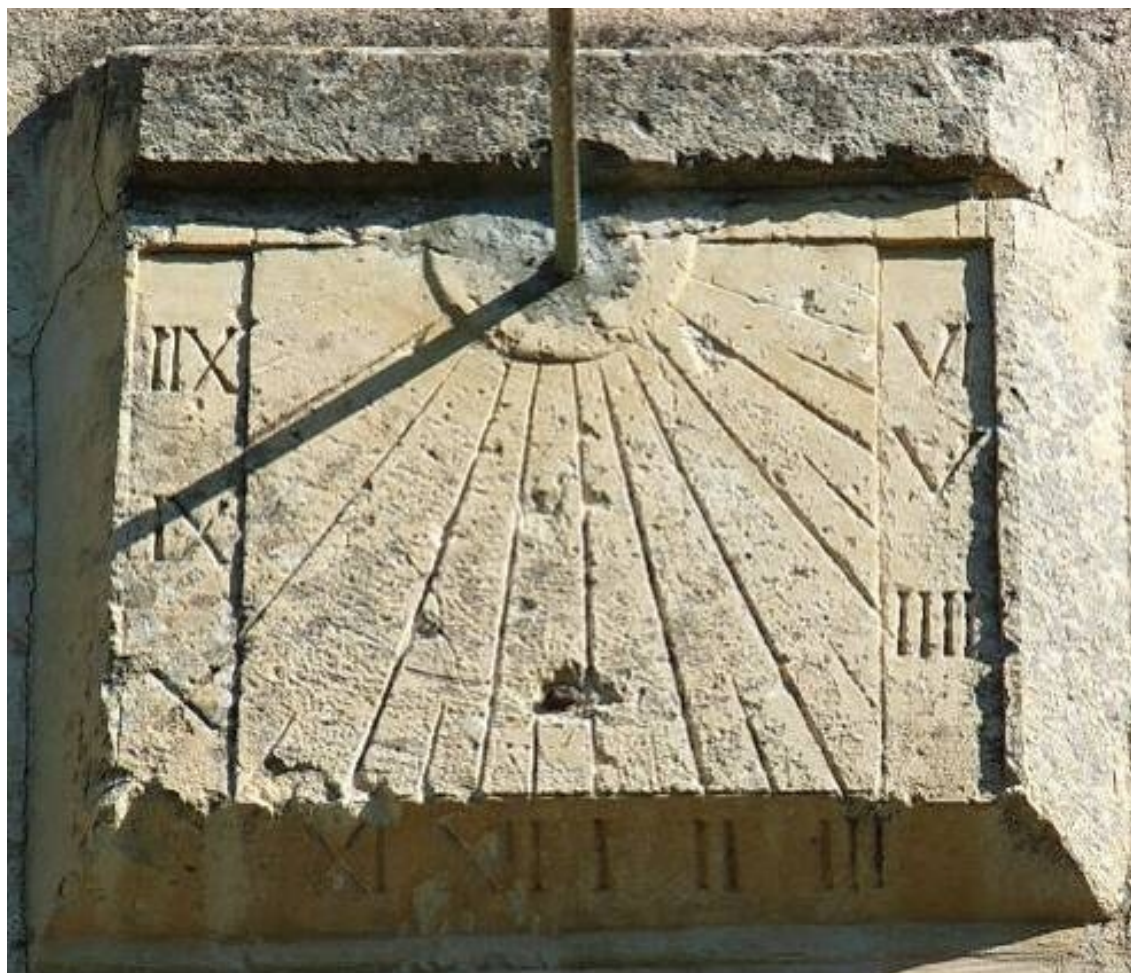
Reloj de meridiana desviada: el muro declina a poniente.
