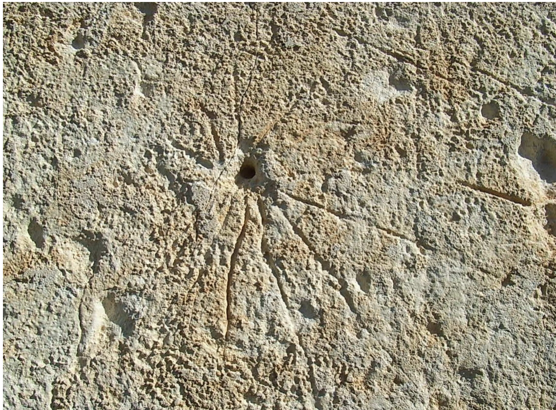
Reloj 1. Radial en la cara del sillar. Deteriorado.
