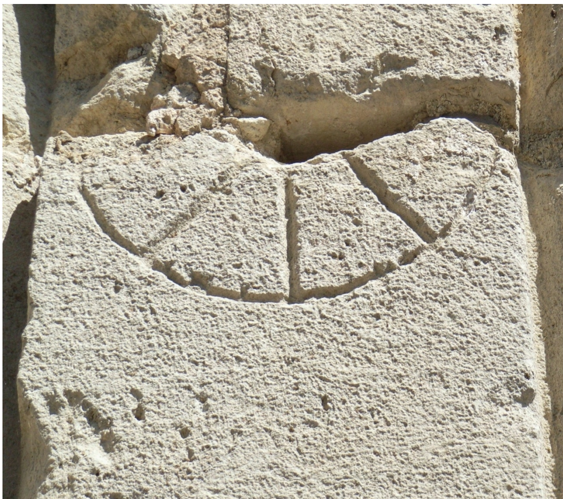
Reloj 1. Pilastra izquierda de la torre. Semicircular en junta de sillar, de 4 \times 45^\circ .
