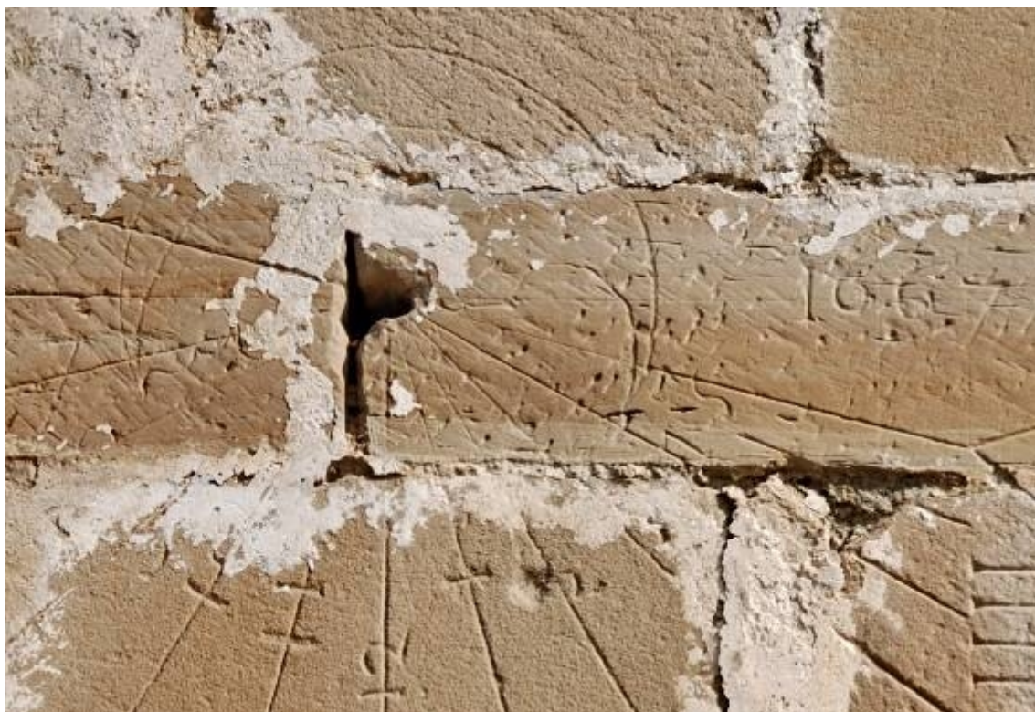
Detalle: círculo distribuidor, numeración arábica y fecha antes de la restauración.
