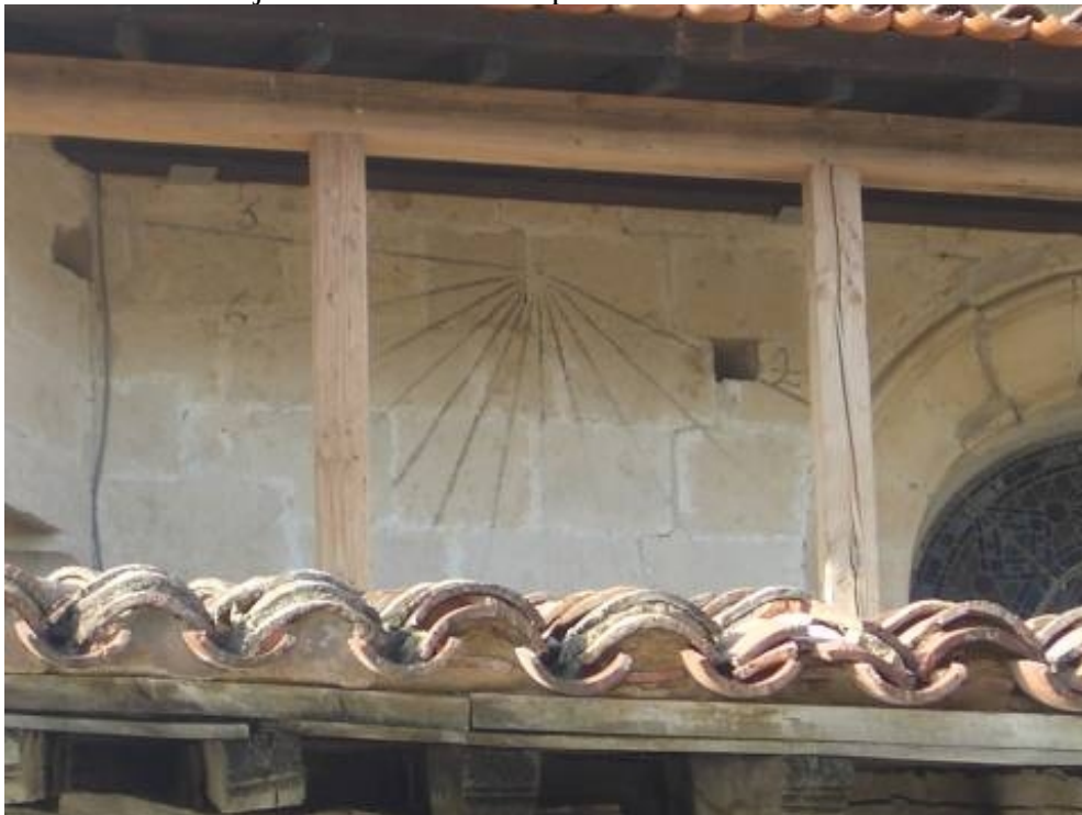
La nueva cubierta del paso de ronda que condena al reloj de sol a la sombra.
