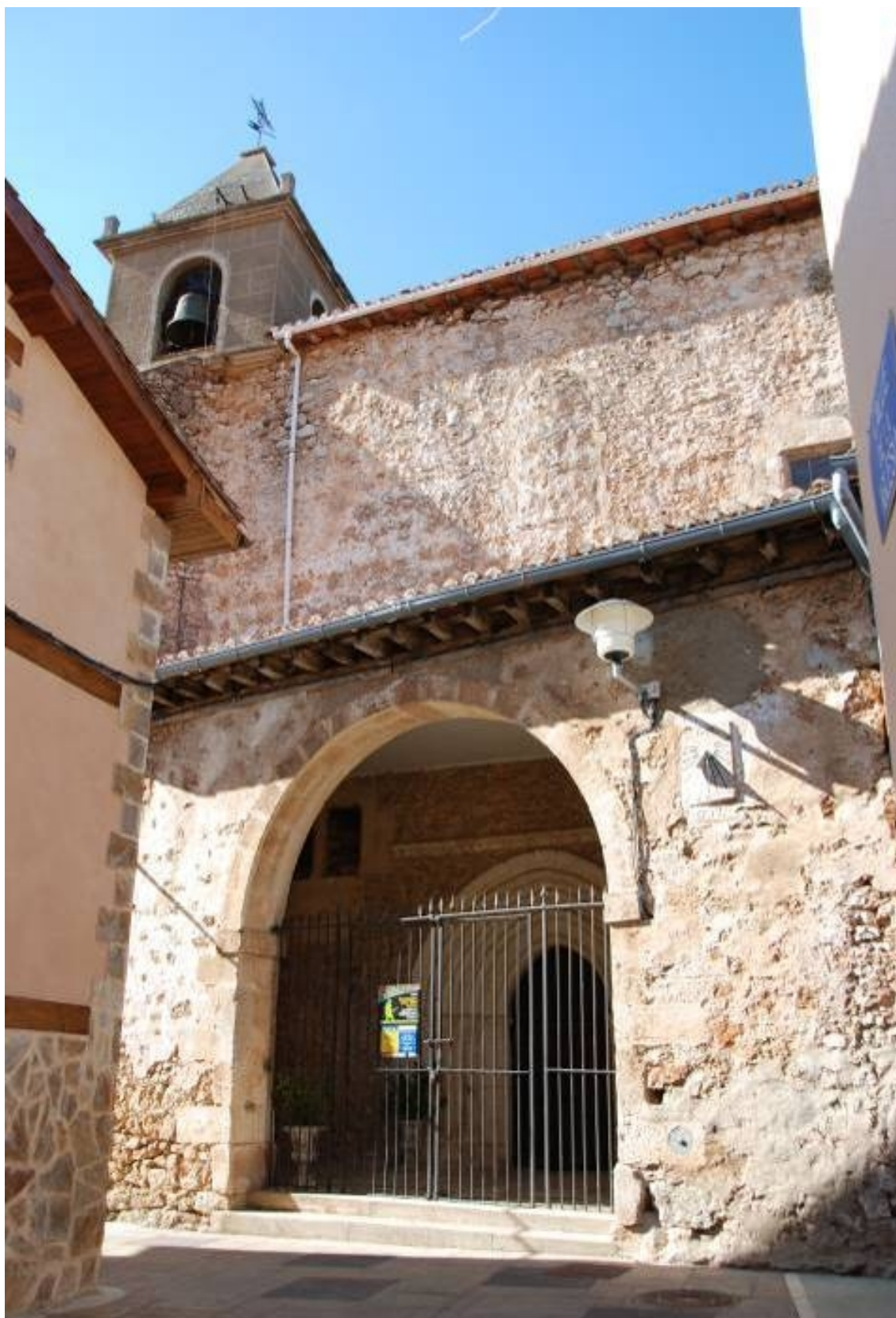
Situación del reloj de sol a la derecha del arco del pórtico.
