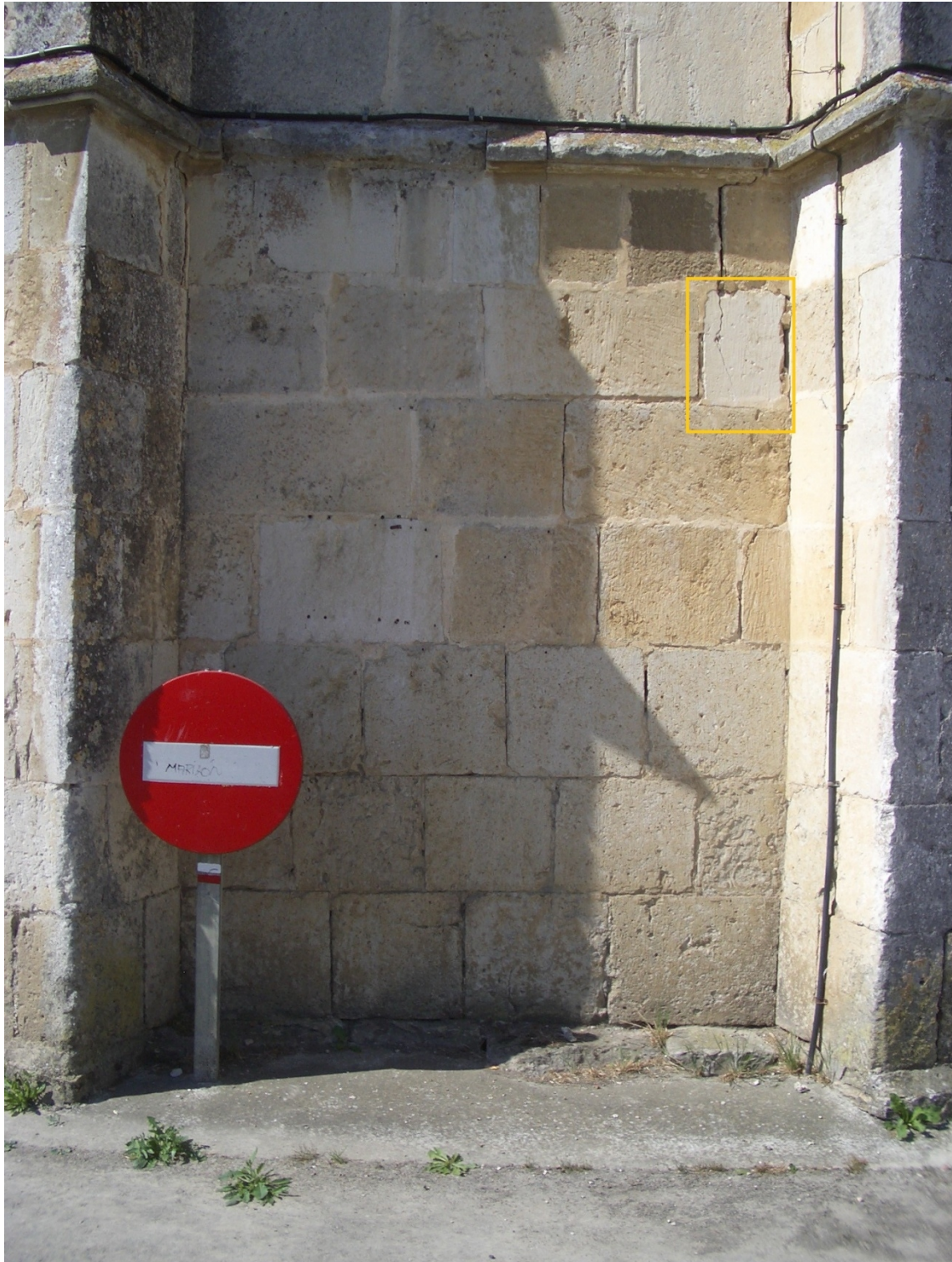
Sillar reutilizado en el muro norte del ábside.
