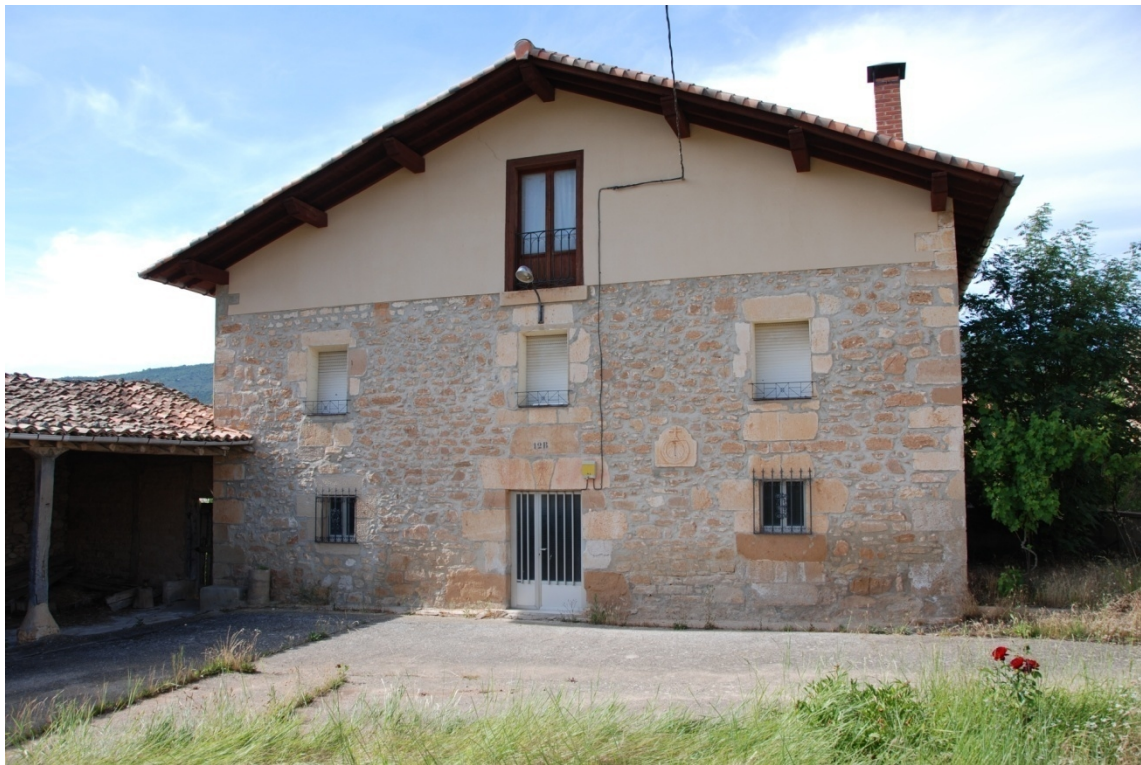
Fachada sur de la casa del reloj de sol.
