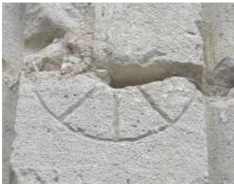
M3. Semicircular en junta de sillar.
