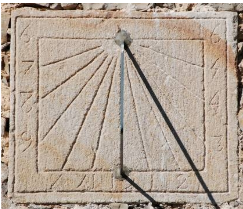
Varilla acodada. Se ha respetado el modelo original.
