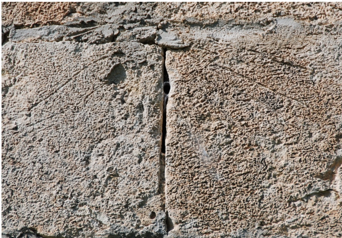
Reloj 4. Radial en junta de tres sillares.
