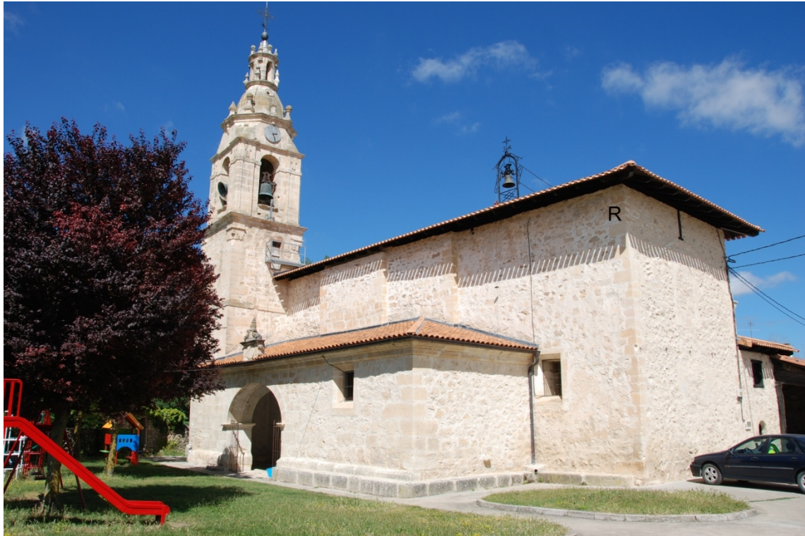
El reloj desubicado de la esquina sureste de la cabecera.
