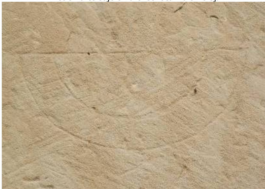
Semicircular en un sillar en la esquina SO de la sacristía.
