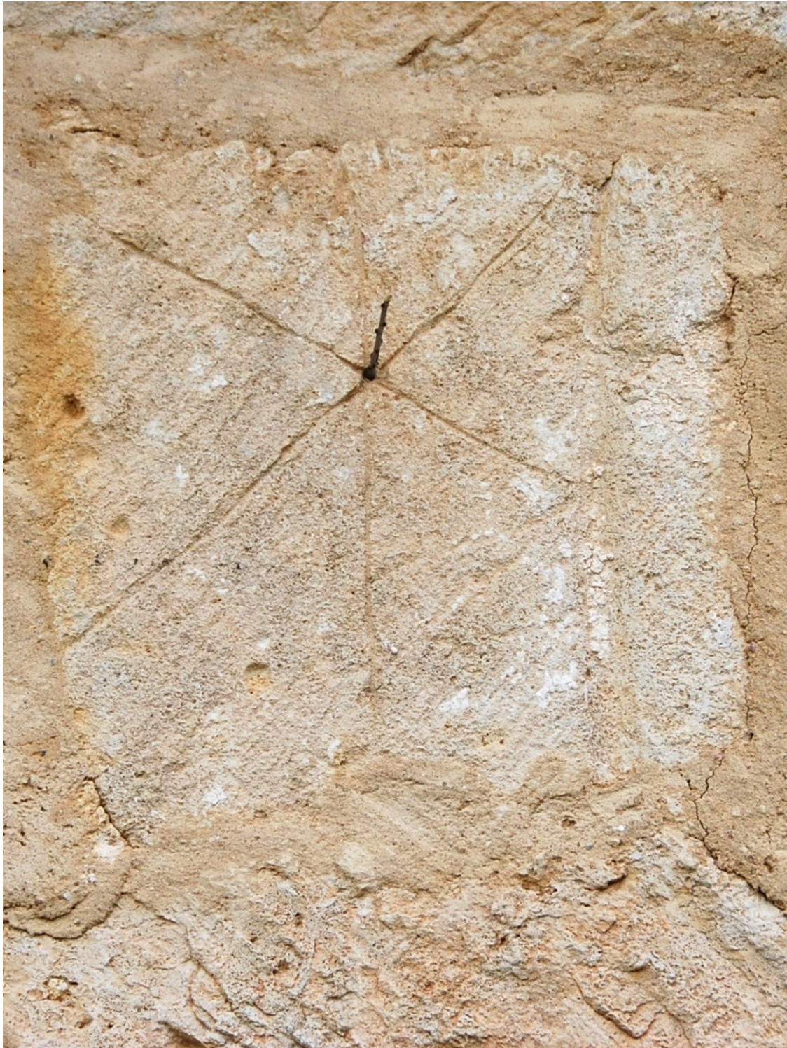
Radial de tres líneas en la cara del sillar. Fotografía del 24/01/2014.
