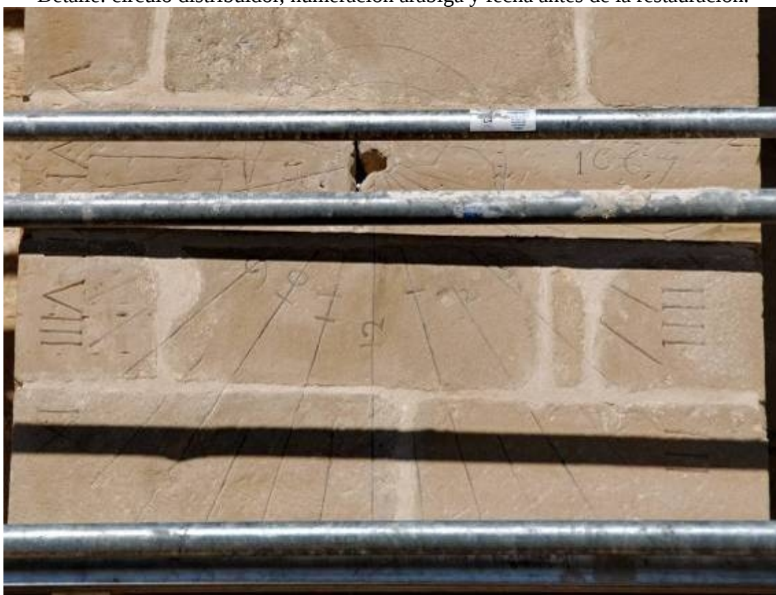
El reloj de sol en proceso de restauración. Fotografía tomada el 25/11/2010.
