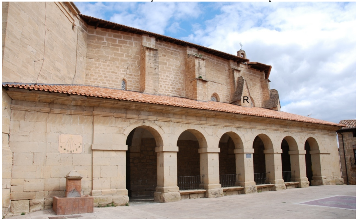
Situación del reloj canónico en el gablete del contrafuerte sur del ábside.
