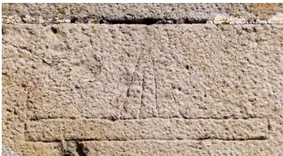
Reloj 2. Radial en junta de sillar.
