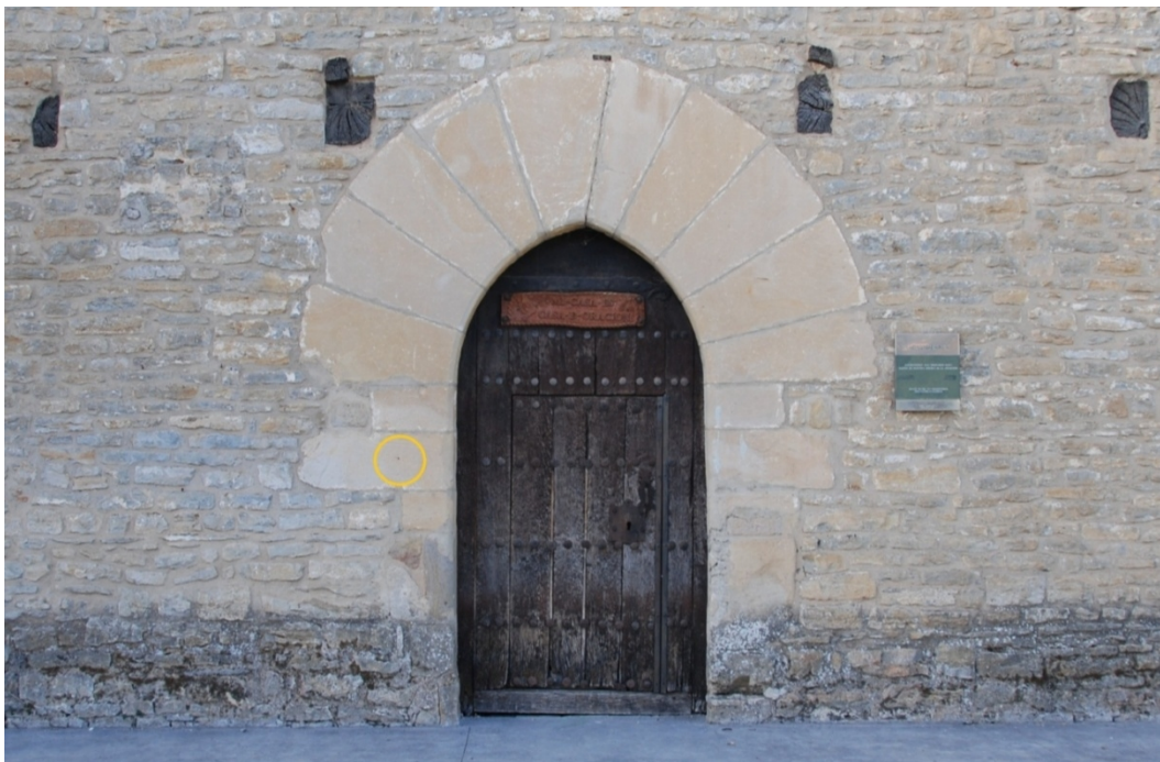
Portada de acceso al pórtico. Situación del reloj de sol.
