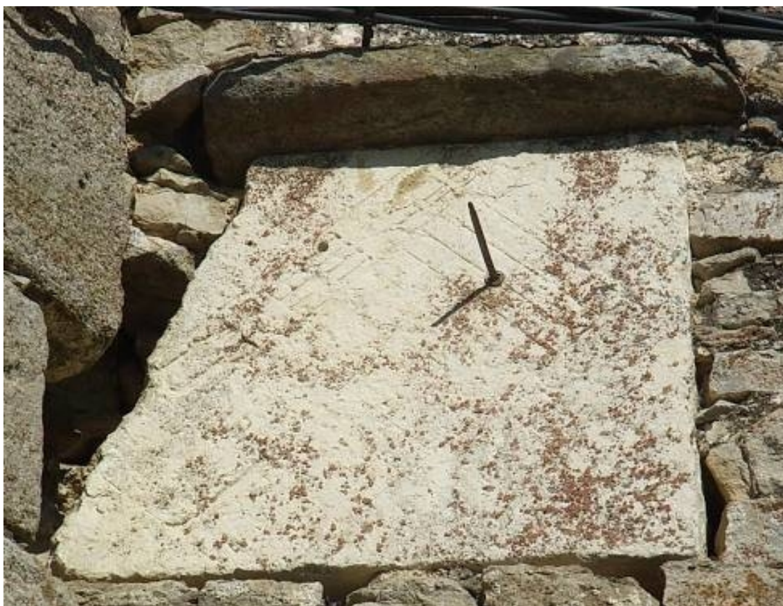
Reloj 1. Vertical a poniente. Varilla original emplomada.
