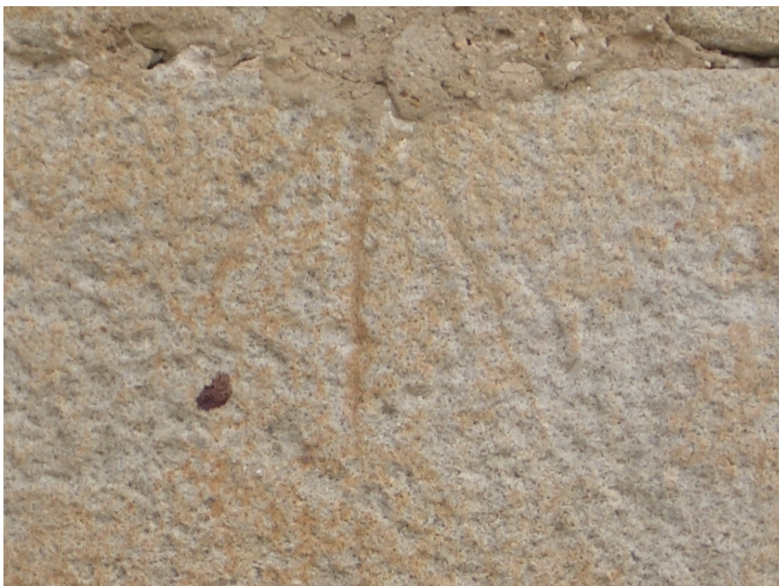
Radial en junta de tres sillares. Línea doble de Nona.
