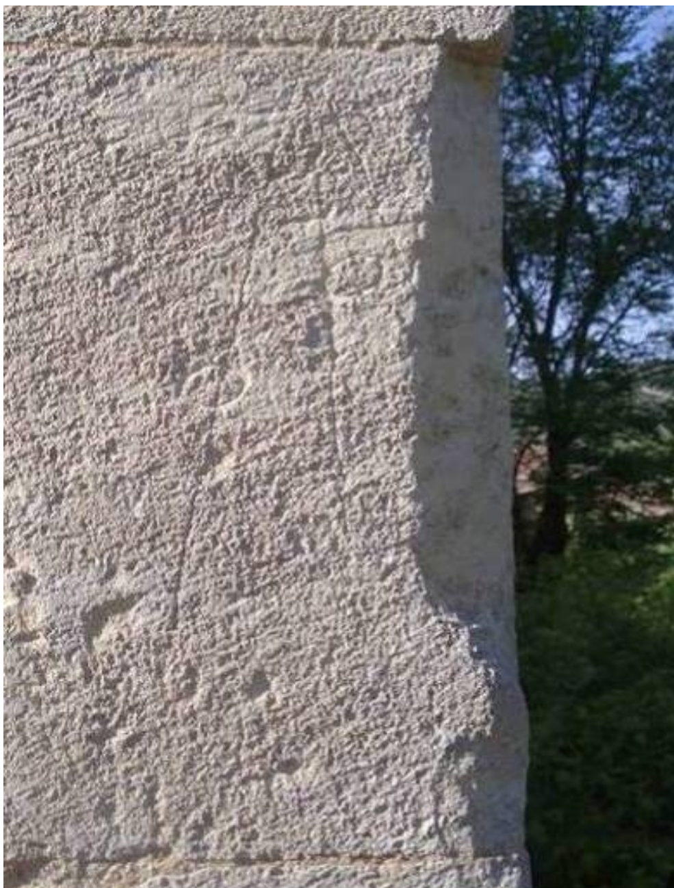
Imíruri. Radial de tres líneas en la esquina de la cabecera.
