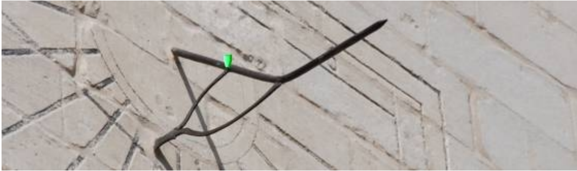
La punta está doblada desde el año 1962. Punto del gnomon que recorre la equinoccial.
