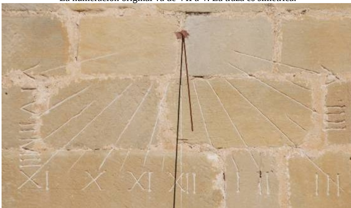
La numeración restaurada va de VI a V. La varilla está a la derecha de la meridiana.
