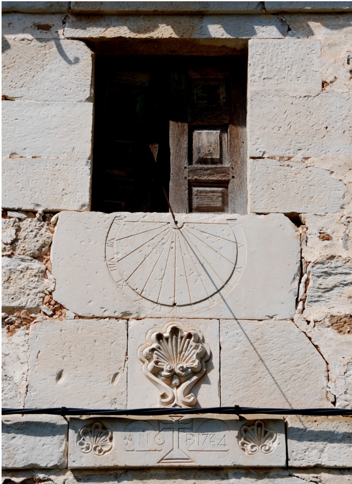
Le han colocado una varilla horizontal. Año 2015.
