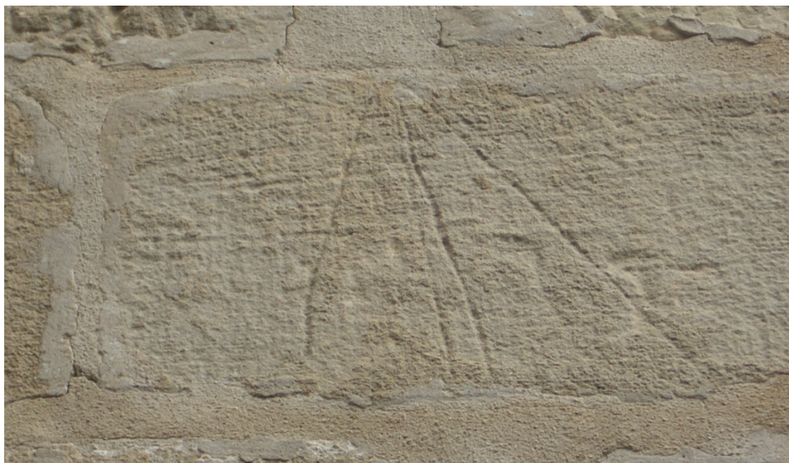
Reloj 8. Radial en junta de tres sillares.
