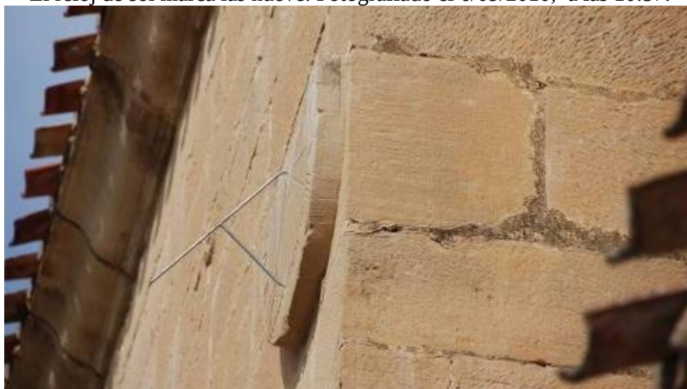
Varilla de dos apoyos en "Y". El reloj de sol está mal calculado.
