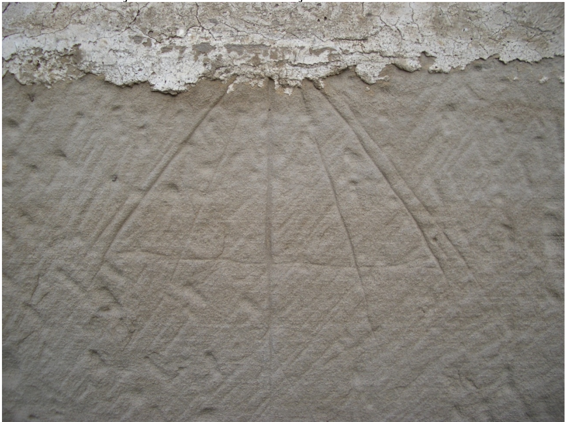
Reloj 2. Radial de tres líneas en junta de sillar. Líneas añadidas.
