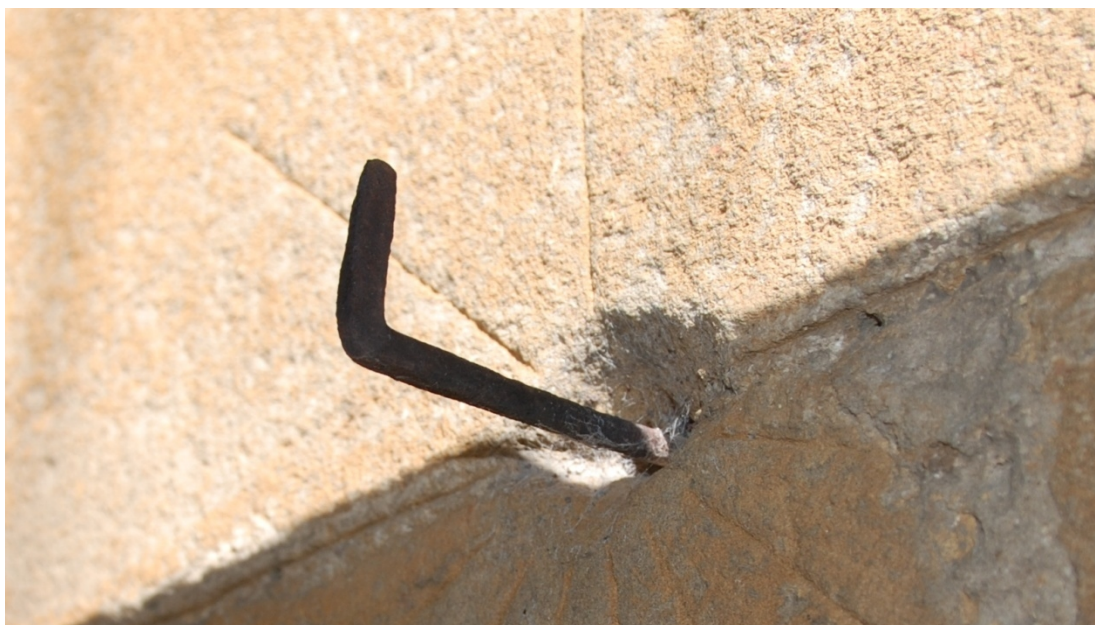
La varilla de hierro del reloj canónico antes de la restauración de 2008.
