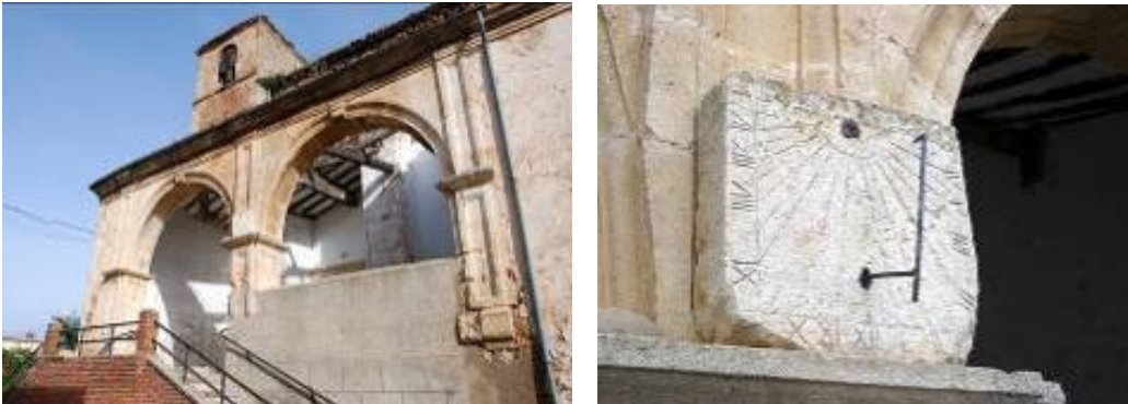
El reloj en el pilar central del pórtico. Varilla desaparecida.
