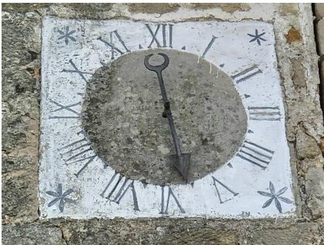
Manzanos. Cuadrante de reloj mecánico de una sola mano y numeración romana.
