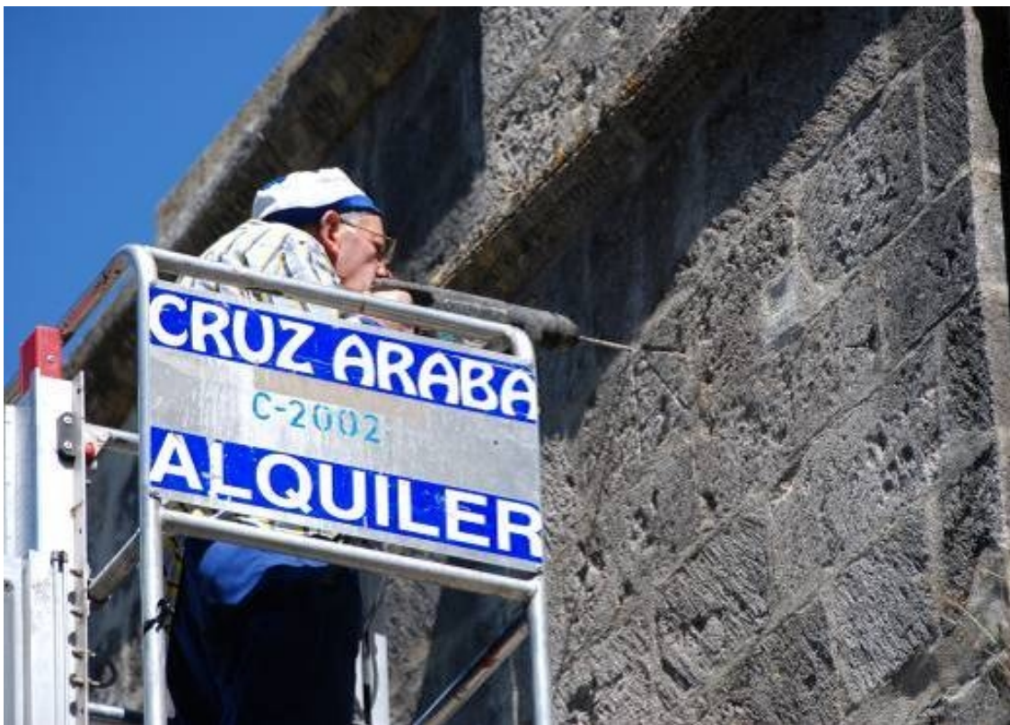
Taladrando el orificio de la varilla en la junta del sillar tapada con cemento.
