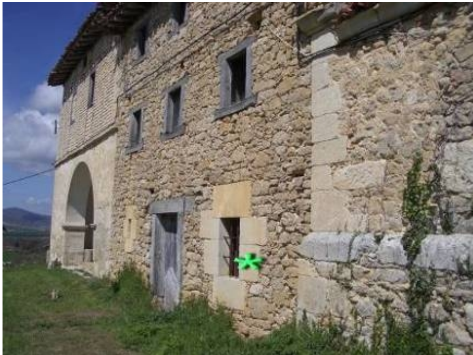
Marauri. La casa del pastor entre el pórtico y la sacristía.
