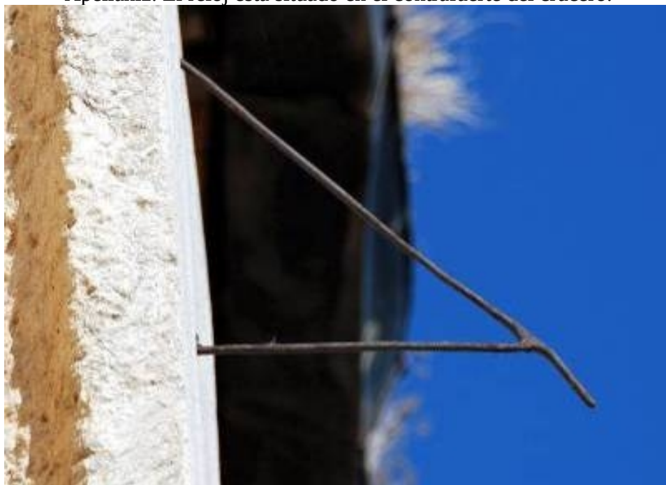
Varilla de dos apoyos con el extremo doblado.
