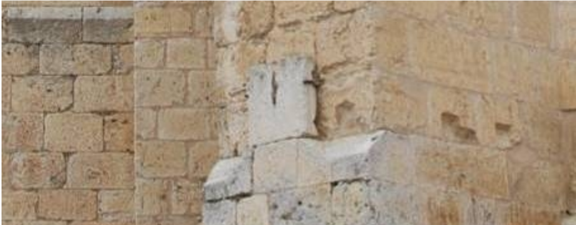
La peana que soporta el reloj forma parte del contrafuerte.
