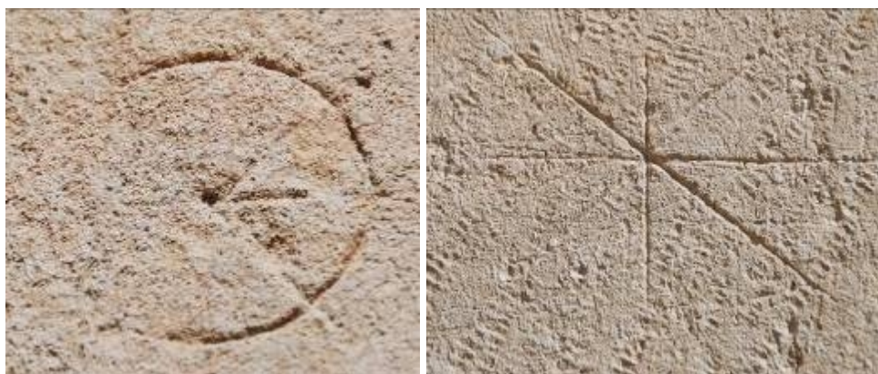
Grabados en el muro oeste del pórtico.
