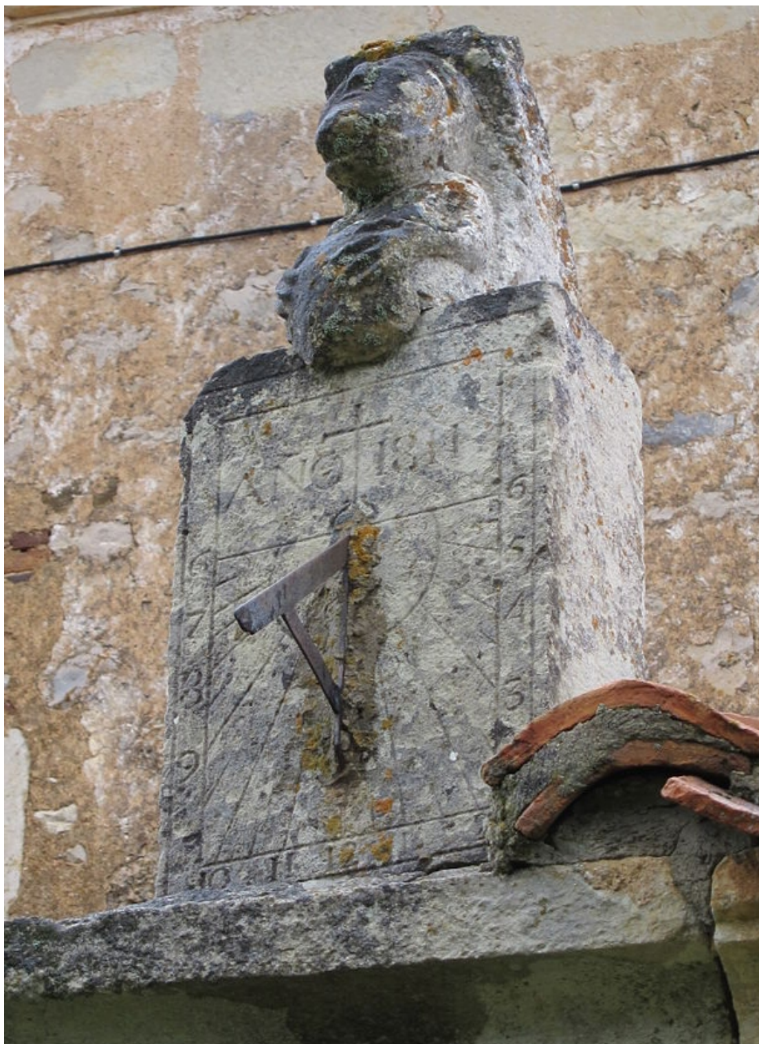
Rectangular vertical. Vertical a mediodía orientado.
