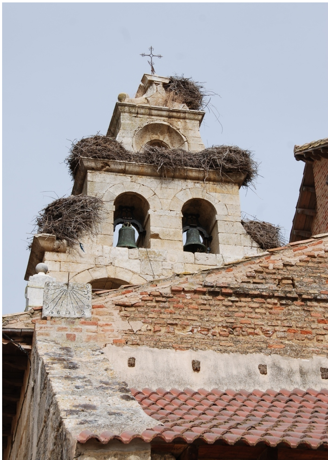
Apoyado en un murete de ladrillo en lo alto del muro oeste del pórtico.
