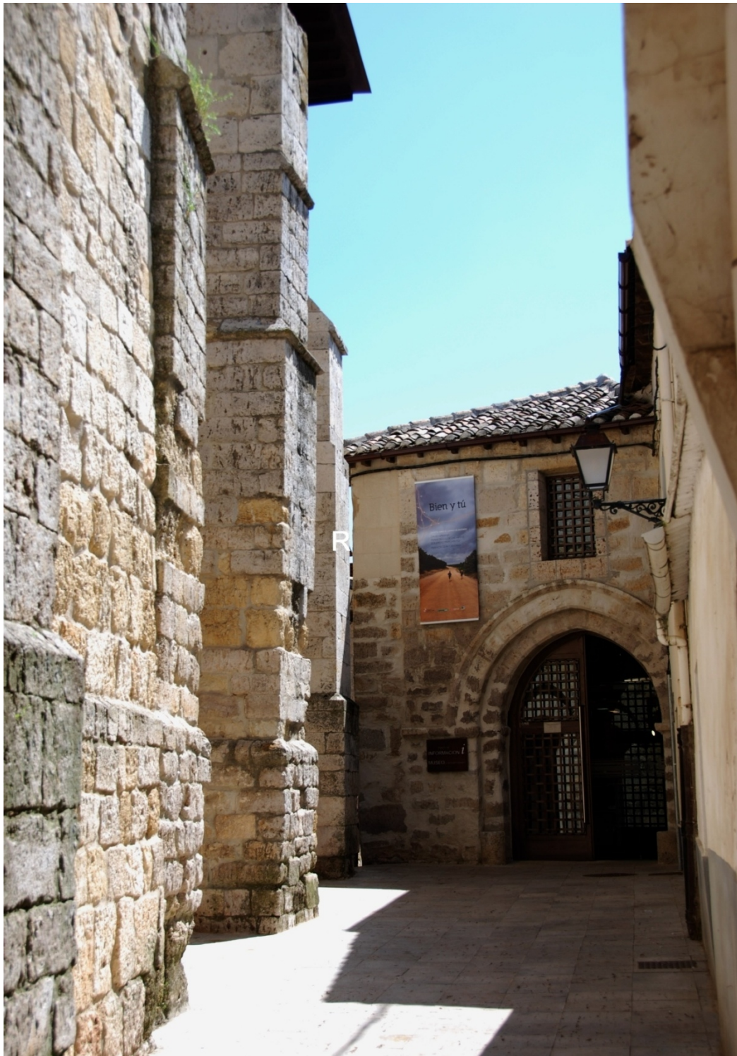
Situación del reloj de sol en el contrafuerte sur de la cabecera.
