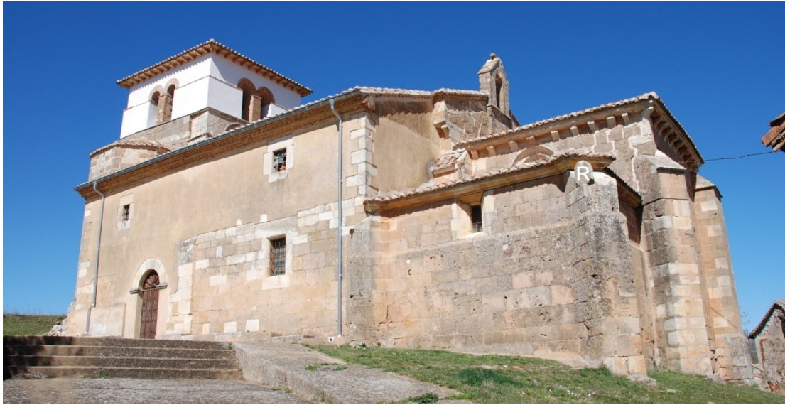
Apoyado sobre el contrafuerte de la esquina sureste de la sacristía.
