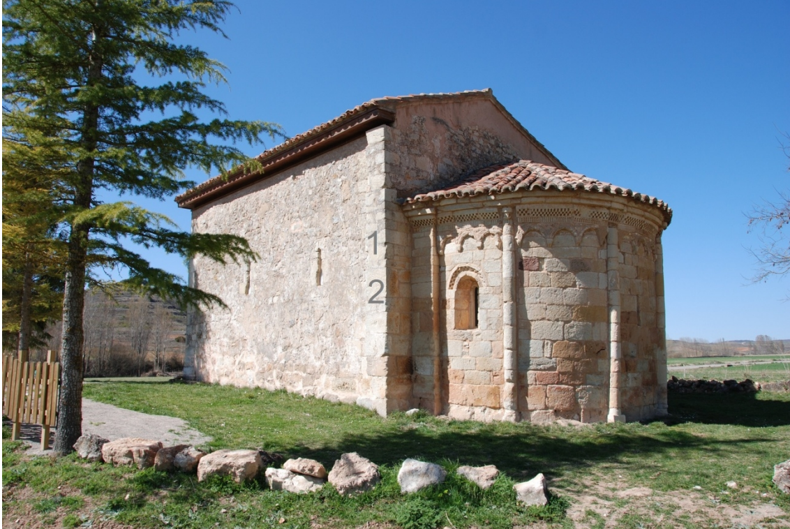
Ermita de San Pelayo. Relojes canónicos grabados en la esquina sureste de la nave.
