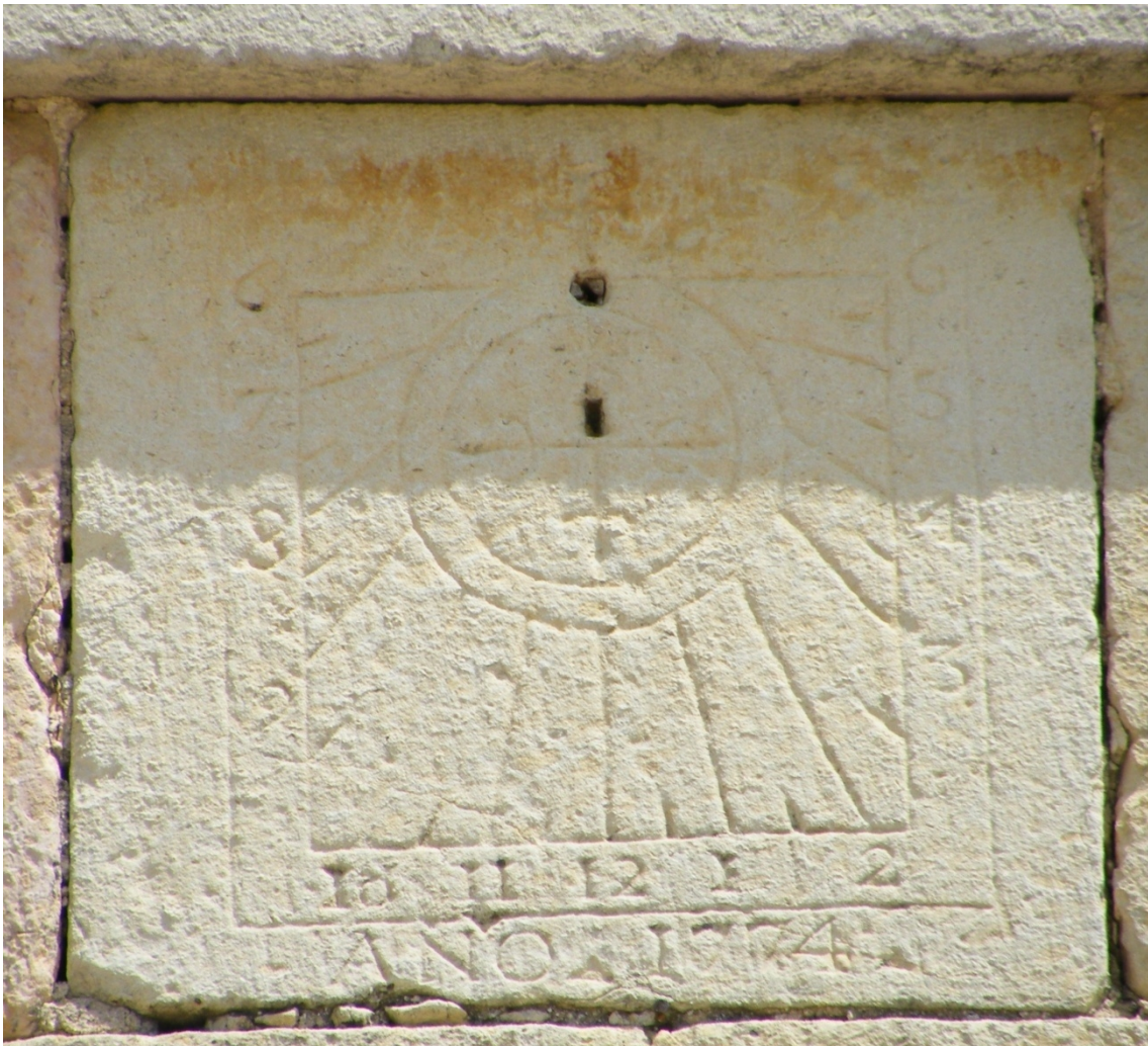
Reloj 1. Rectangular horizontal. Vertical a mediodía. AÑO 1774.
