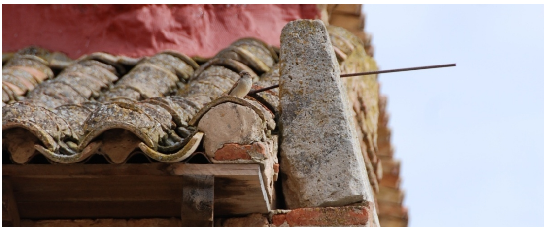
La varilla está en posición horizontal y atraviesa el sillar.
