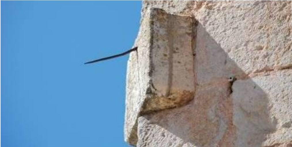
Varilla de perfil circular de un solo apoyo. Mal orientada.
