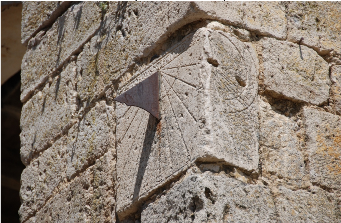
El sillar se sale del muro para orientar el reloj de sol a mediodía.
