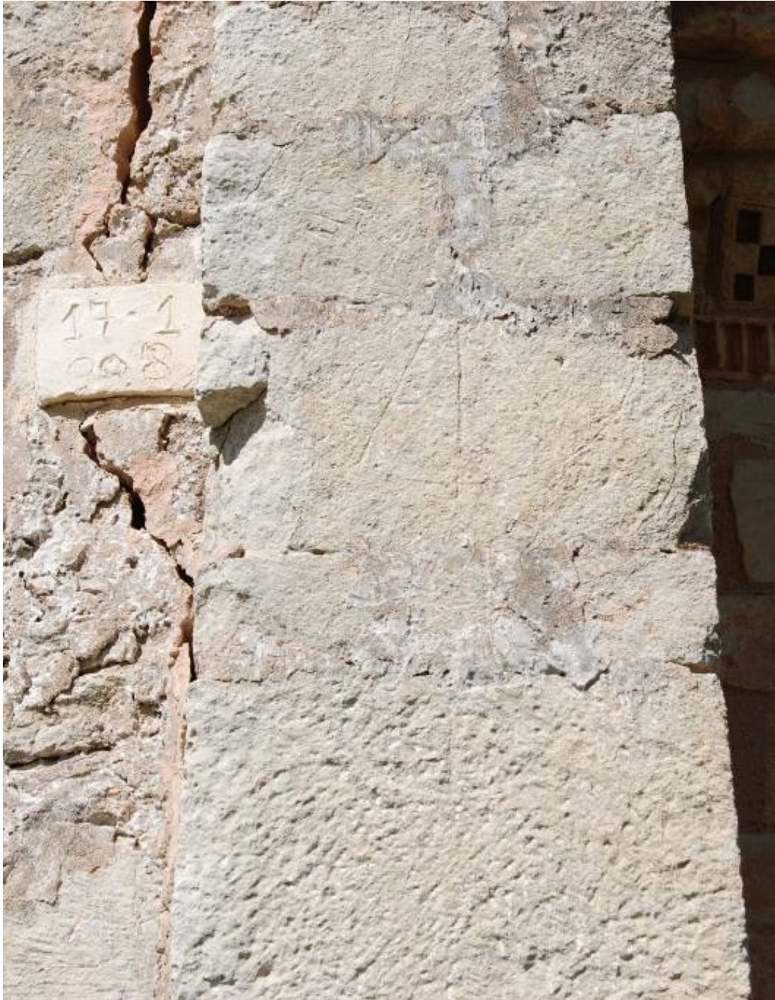
Situación de los dos relojes canónicos en los sillares de la esquina SE de la nave.
