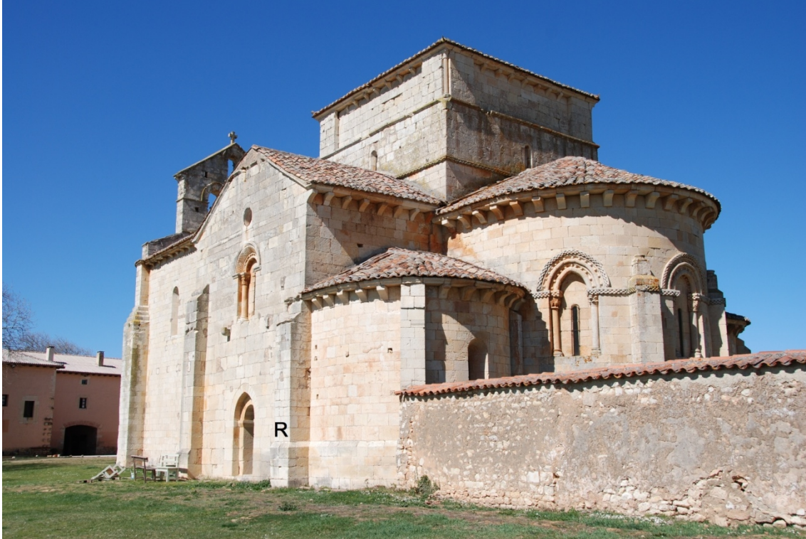
Situación del reloj canónico en el contrafuerte de la esquina sureste del crucero.
