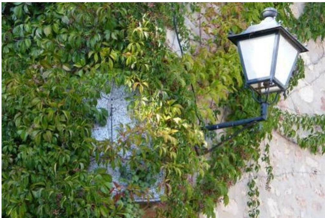
Empotrado en la esquina suroeste de la fachada principal, oculto tras la hiedra.
