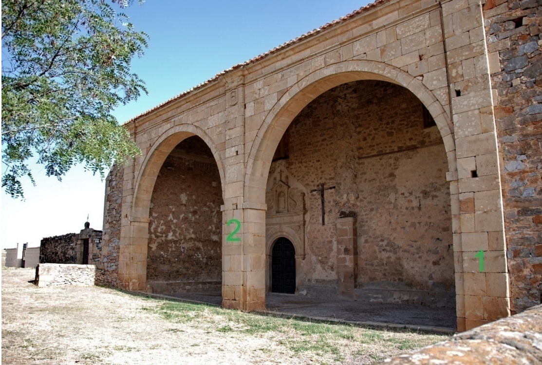
Pórtico construido en 1683. Situación de los dos relojes de sol.
