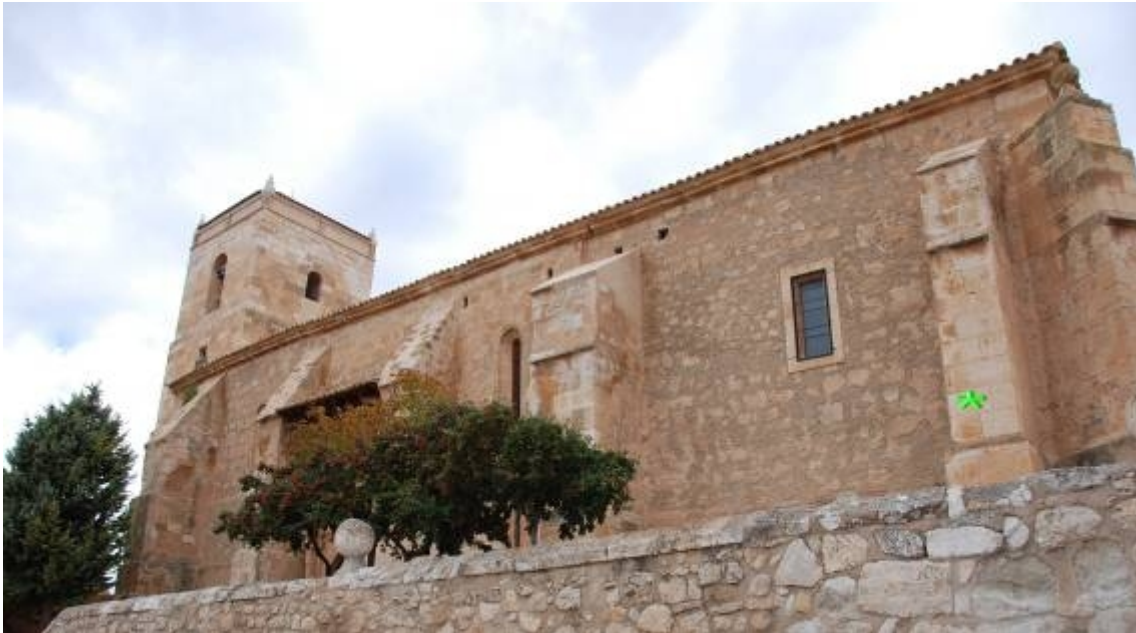
Grabado en el contrafuerte sur de la esquina de la cabecera.
