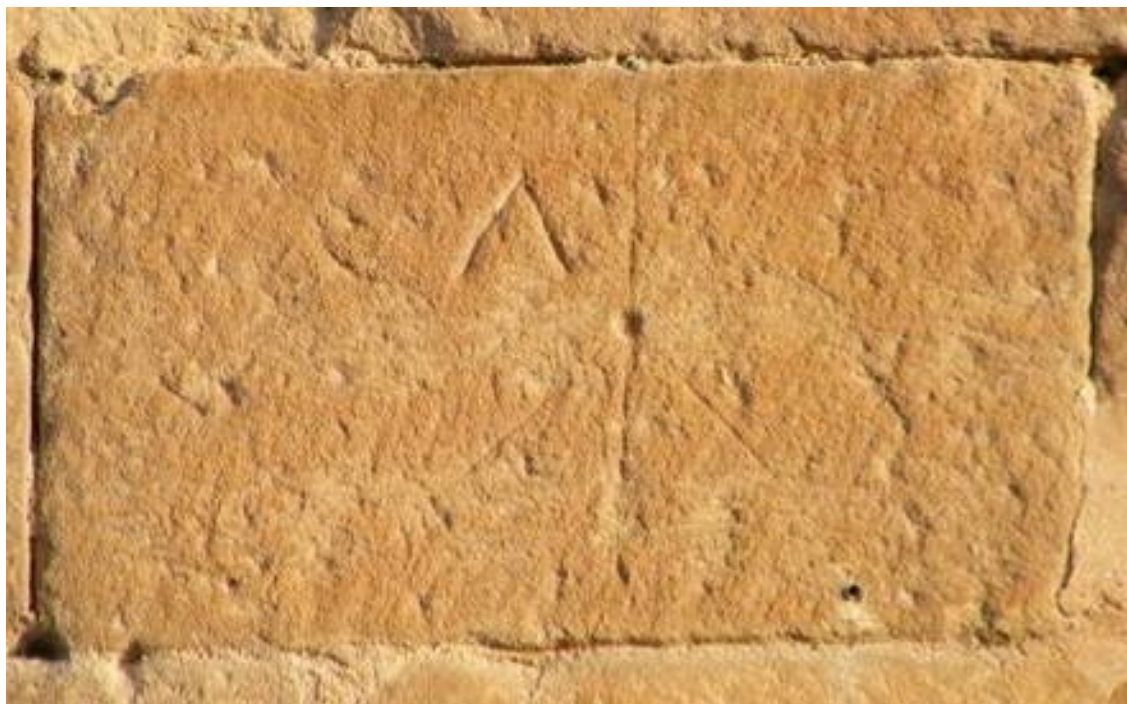
Fotografiado el 24/09/2011 tras las obras de restauración.
