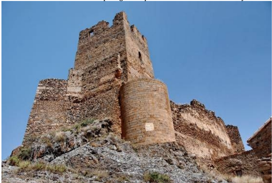
Vista desde el sur. Torre del homenaje, torre redonda artillera y recinto exterior.
