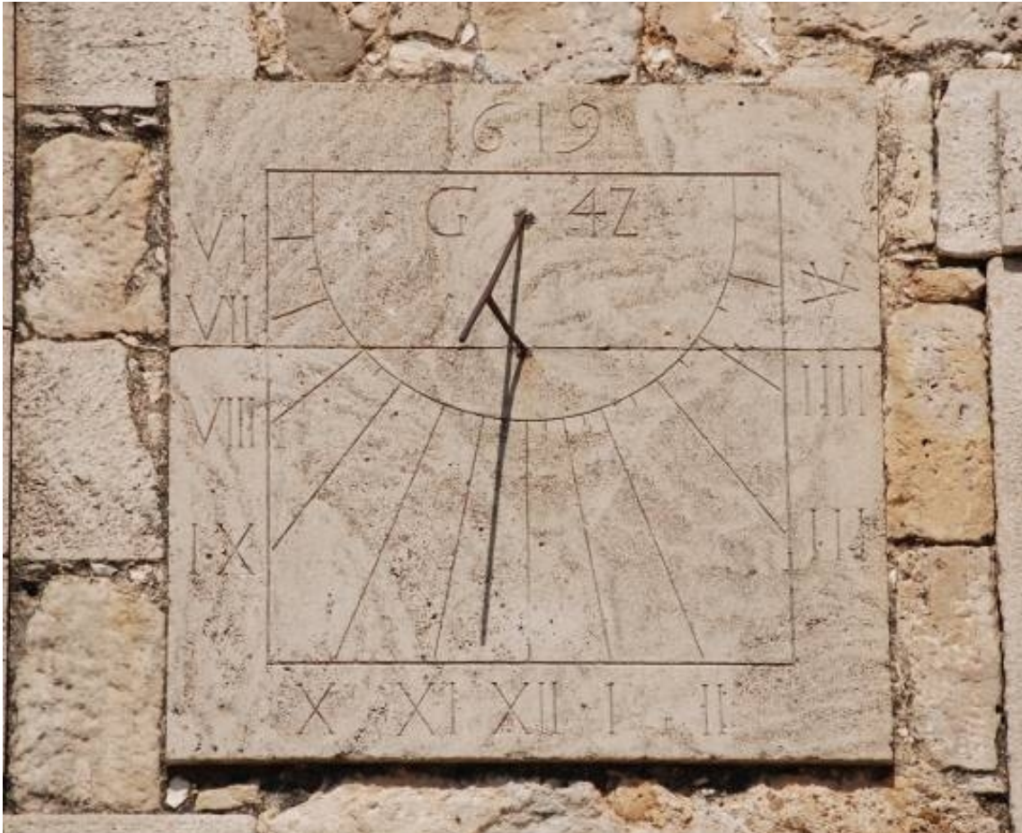
Reloj 1. Cuadrado. Vertical declinante a levante. Mal calculado. Cifra 2 en 'Z'.
