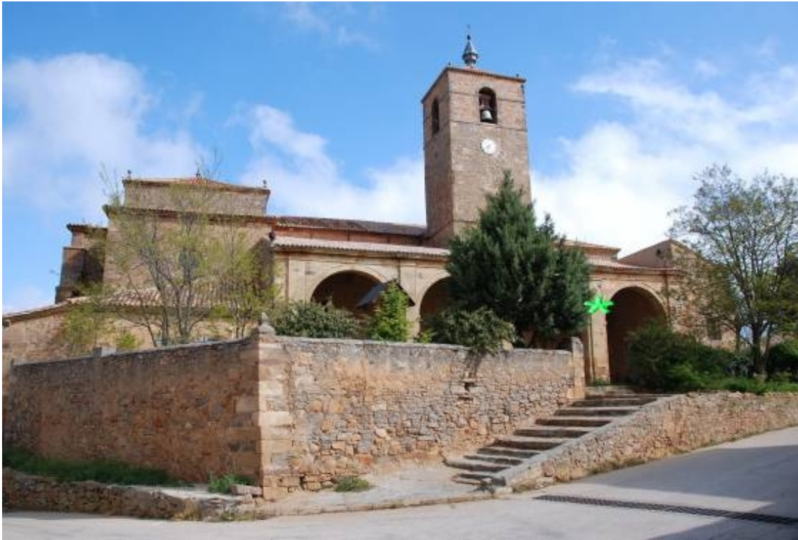
Situado el pilar derecho de la arcada del pórtico.
