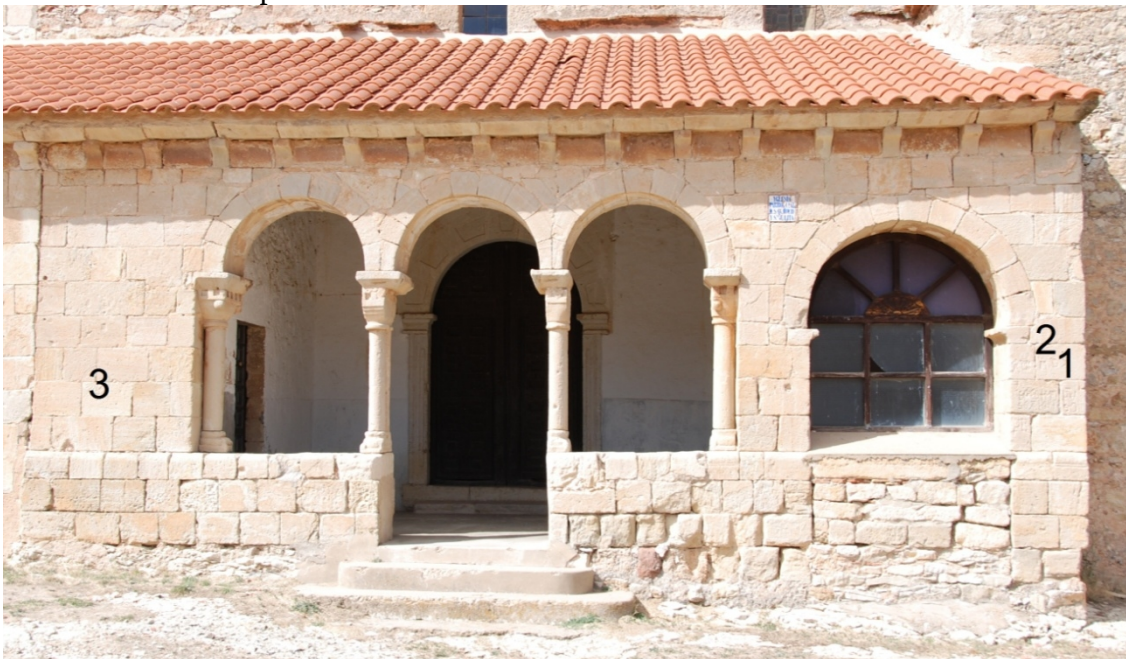
Situación de los tres relojes de sol.
