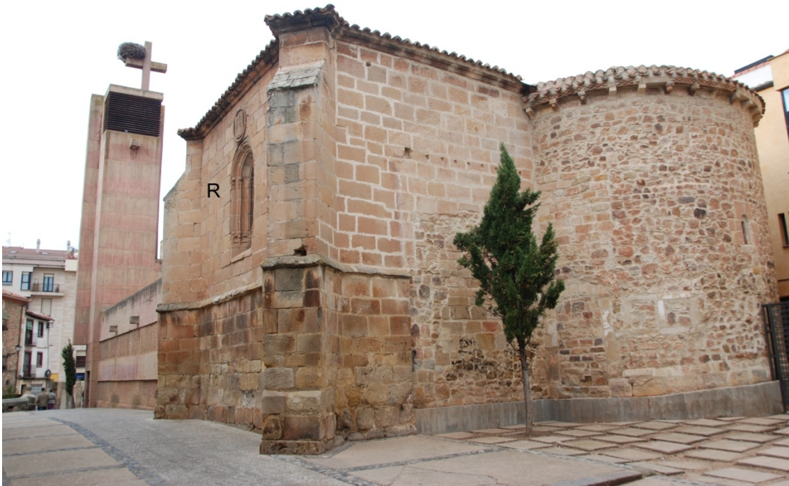
Fases constructivas: ábside románico, capilla del XVI, nave y torre des siglo XX.
