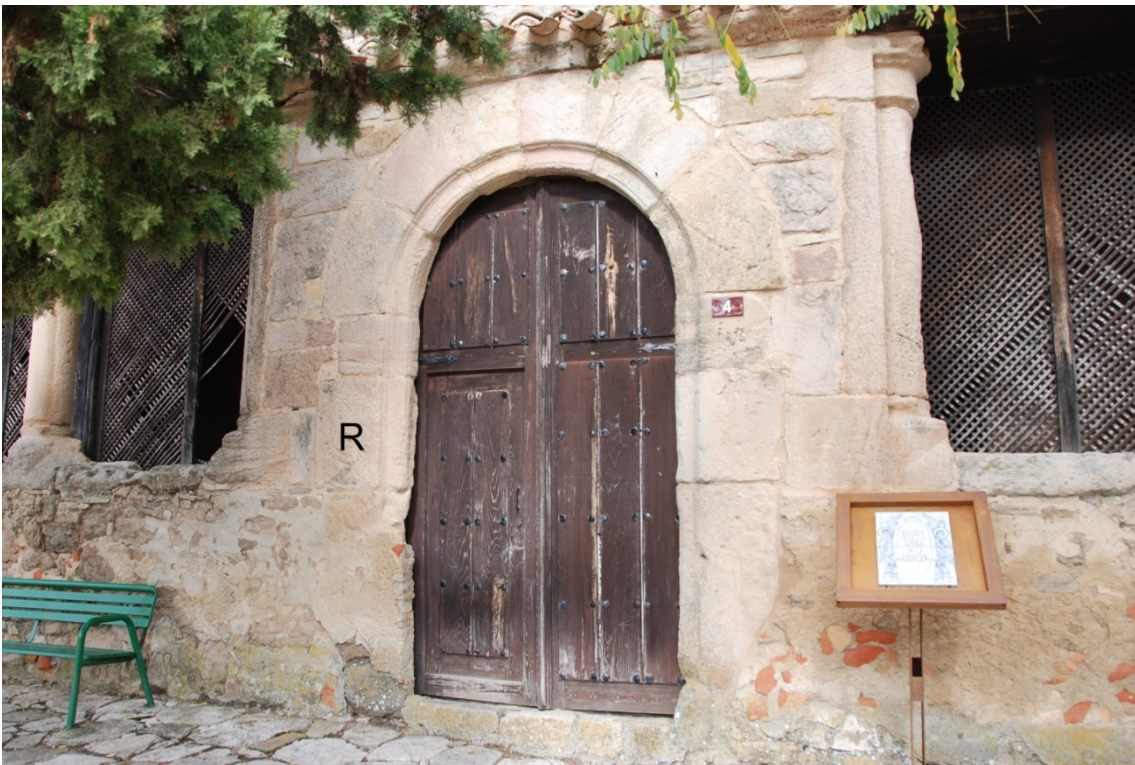
Situación del reloj de sol en la jamba derecha de la portada del pórtico.
