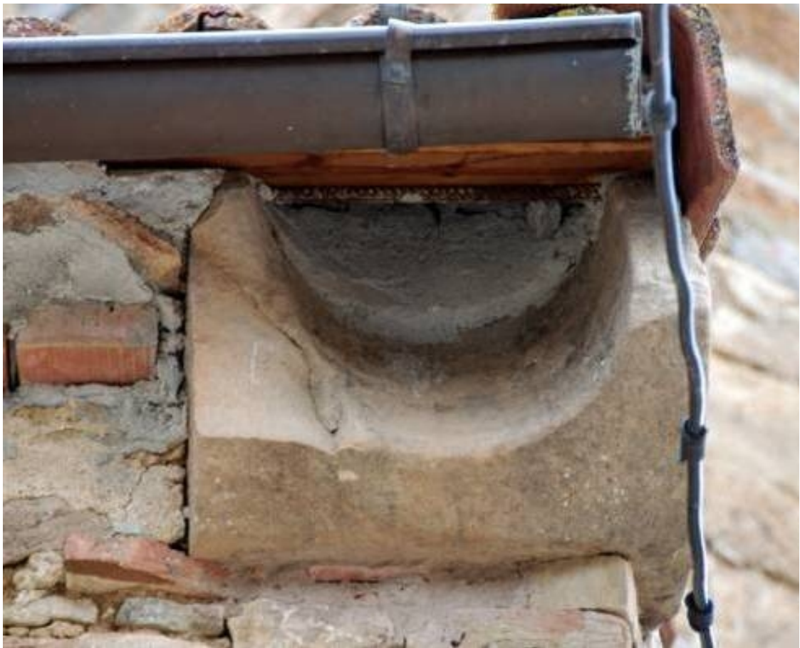
Líneas horarias. Arista izquierda rota. Desubicado. Cifra 5 de grafía en 'S'.
