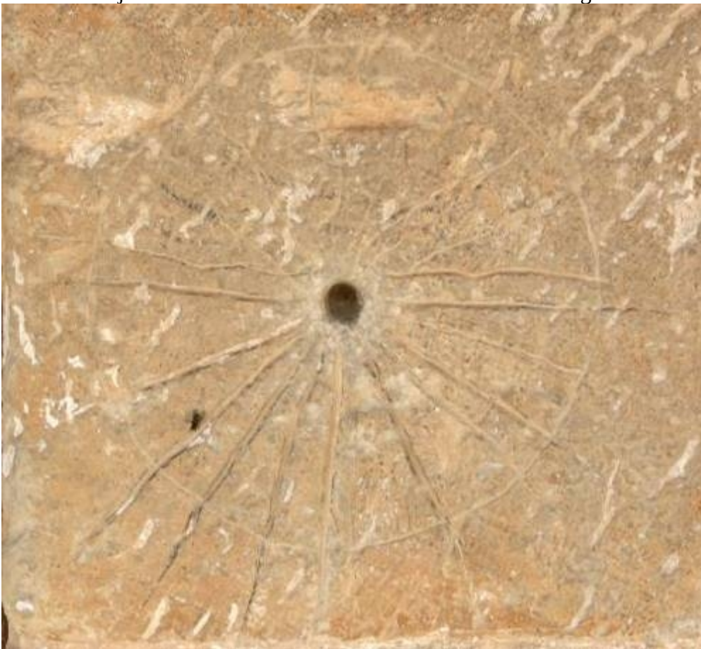
Reloj 2. Circular en la cara del sillar. Traza semicircular. Manipulado.
