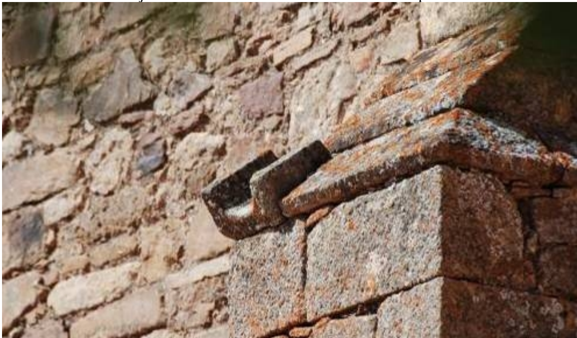
Reloj 4. Contrafuerte situado a la izquierda de la portada.
