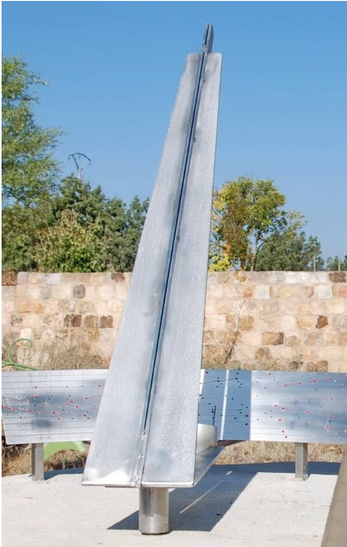
El gnomon orientado al sol deja pasar la luz a través de su ranura central.
