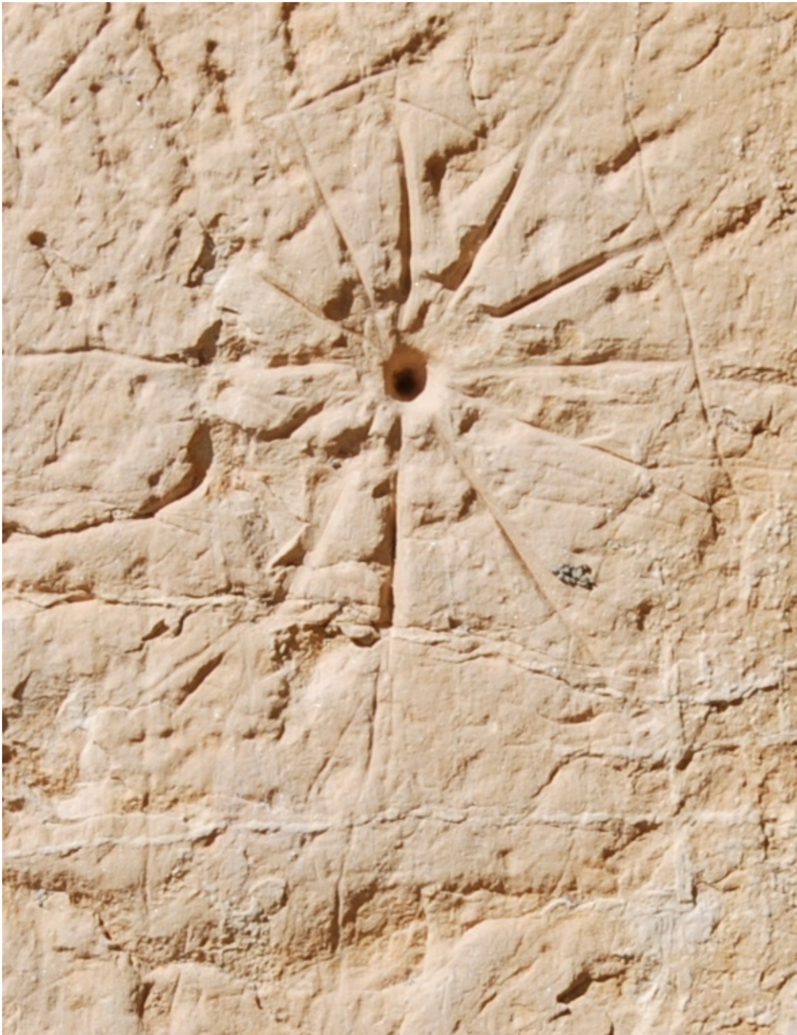
Radial en la cara del sillar, de 12x30°.
