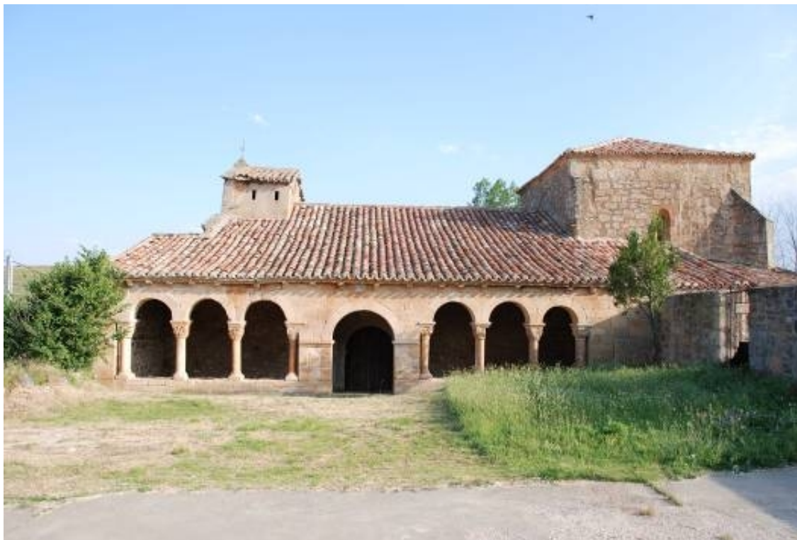
Vista sur de la iglesia. Arcada del pórtico.
