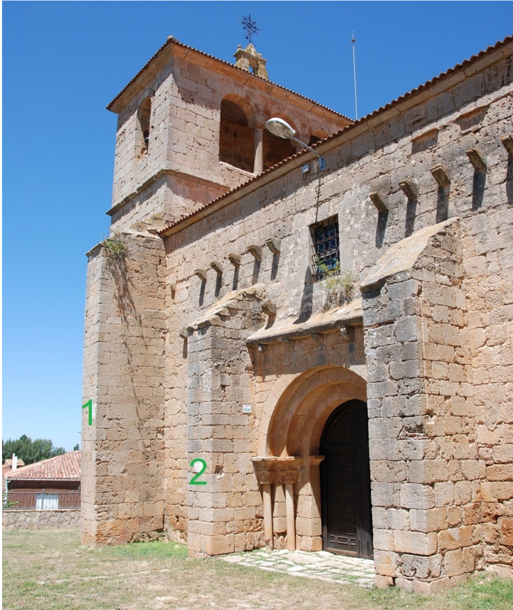
Los dos relojes de sol están situados en los contrafuertes.
