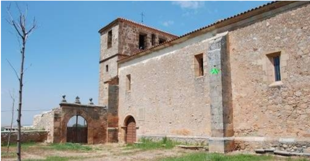
Grabado en un contrafuerte en el centro de la fachada sur.
