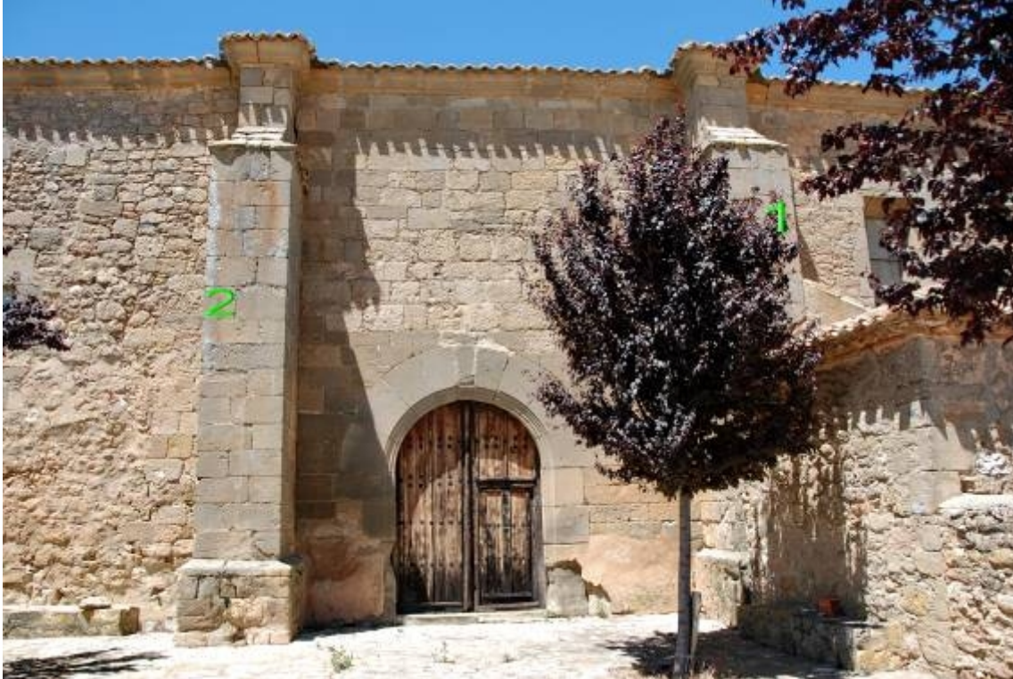
Relojes de sol en los contrafuertes de la fachada sur (siglo XVI).
