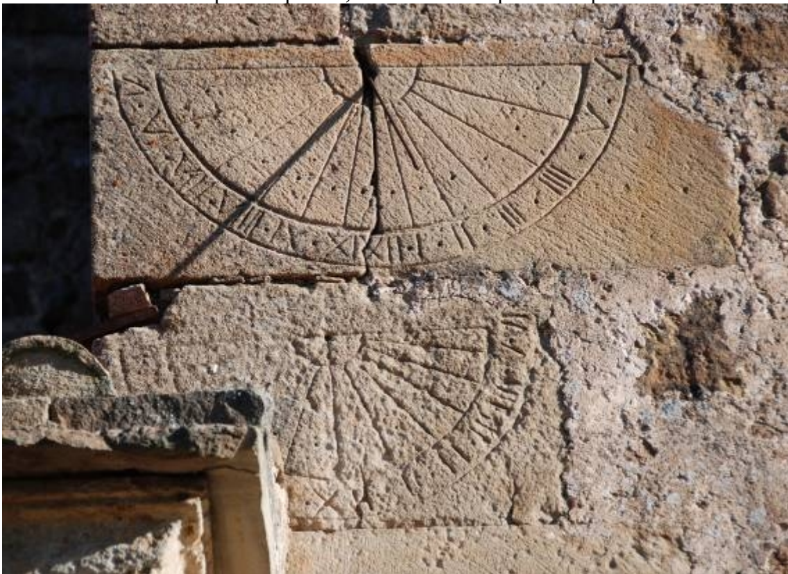
Esquina suroeste de la torre. Posición de los relojes 1 y 2.
