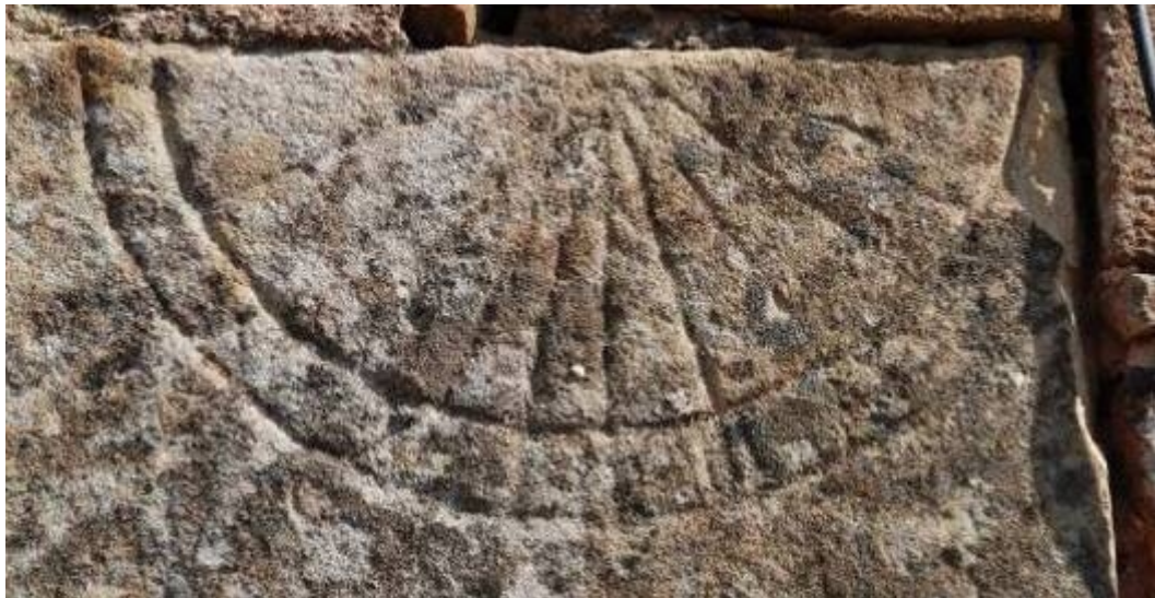
Reloj 2. Semicircular en junta de sillar. Meridiana desviada.
