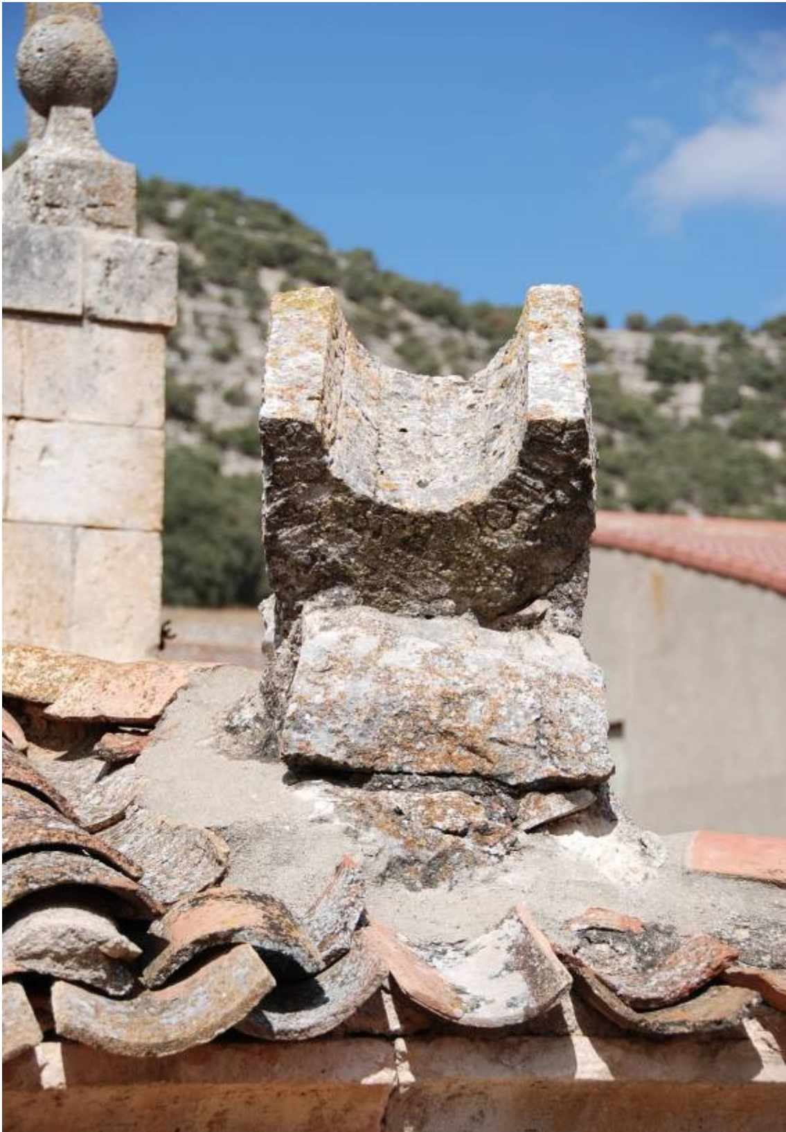
Fotografía tomada a la altura de la cornisa el 7/10/210 a las 13:54.
