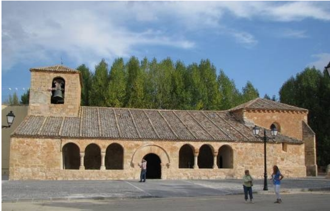
Situado en muro sur la torre, a la izquierda del arco del campanario.
