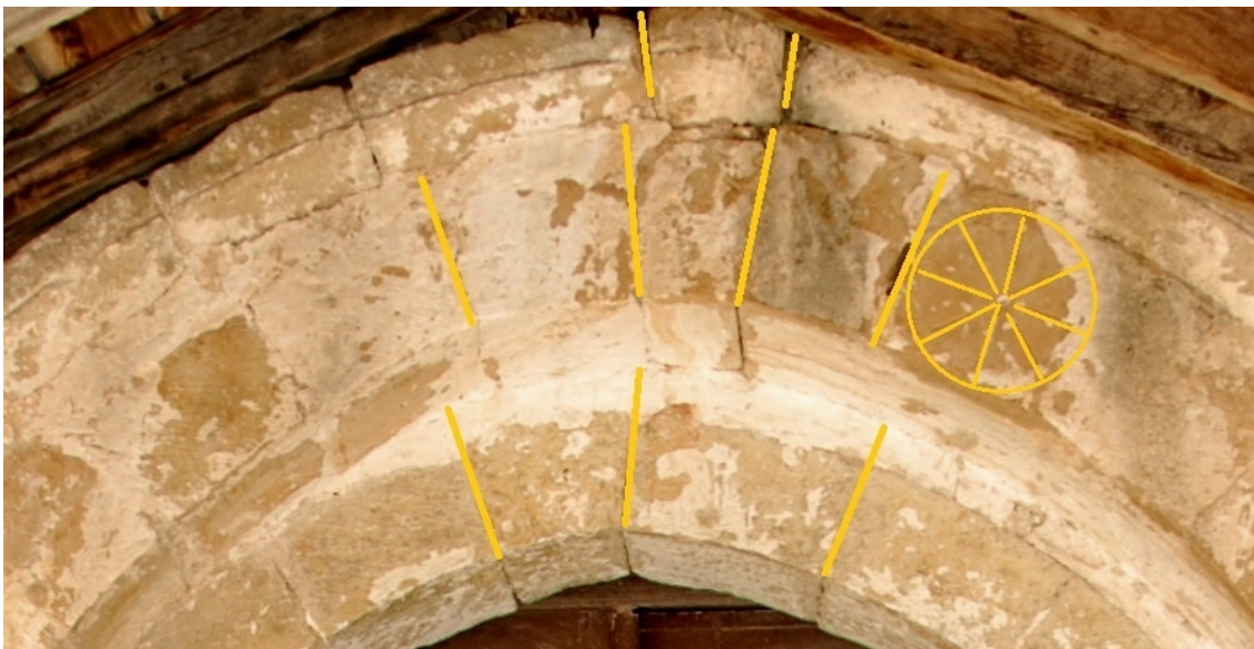
Ninguna de las dovelas funciona como verdadera clave. Posición del reloj n° 1.
