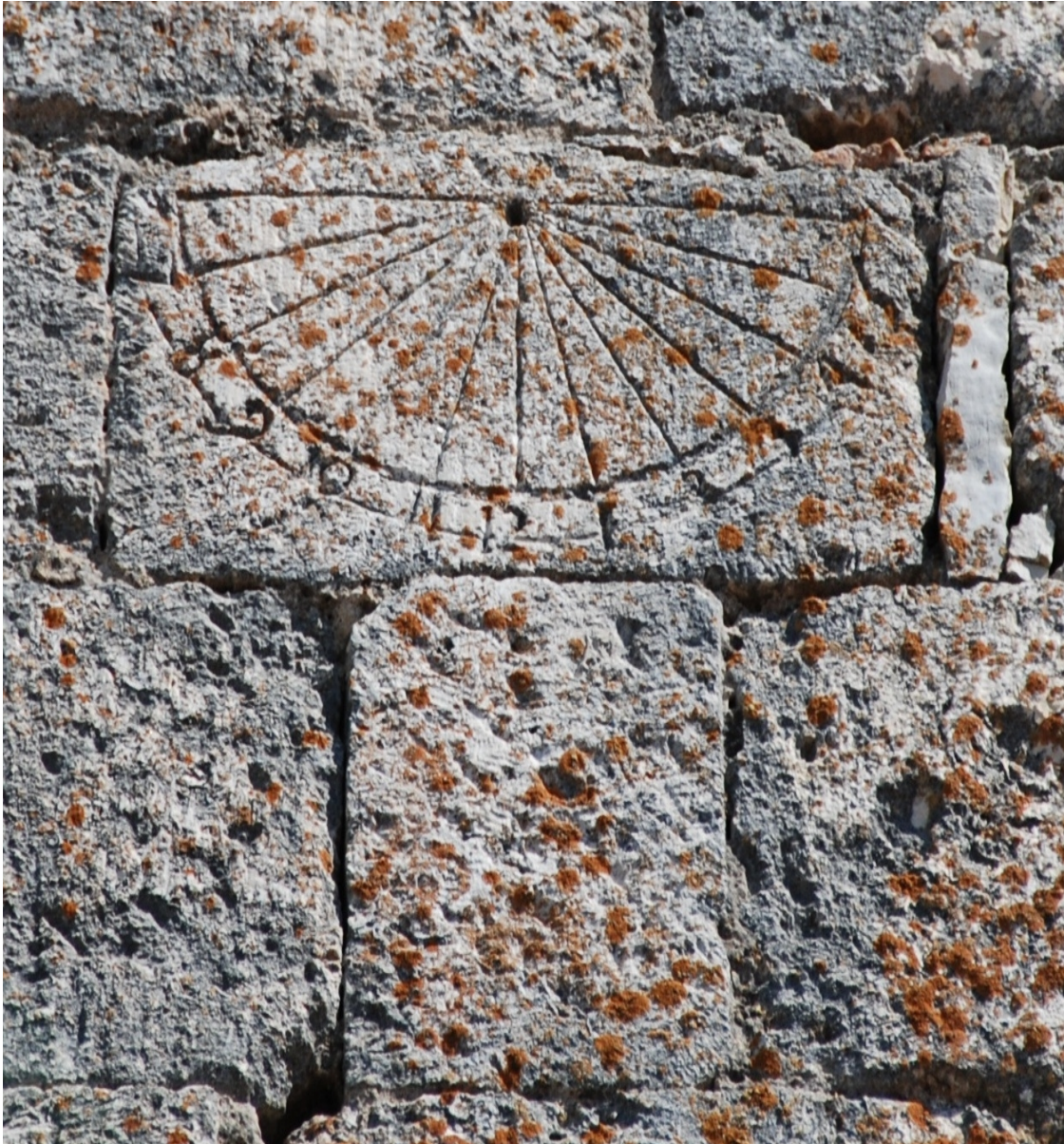
Semicircular en la cara del sillar, de 12x15°.
