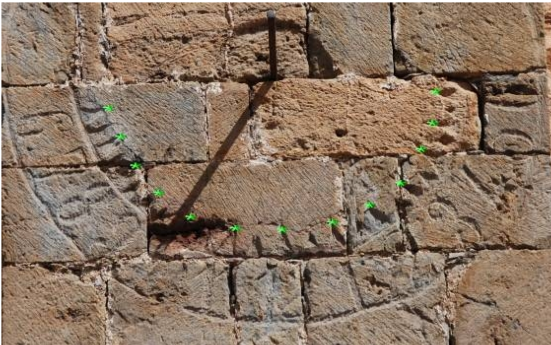
Circular en junta de sillar. Traza semicircular. D = 130 cm.
