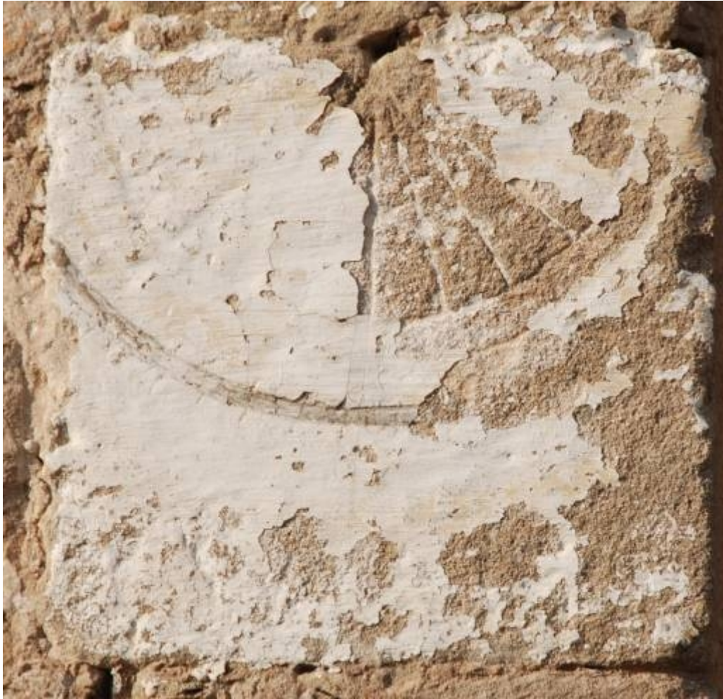
Reloj 1. Semicircular en junta, de 12 sectores aproximadamente iguales.
