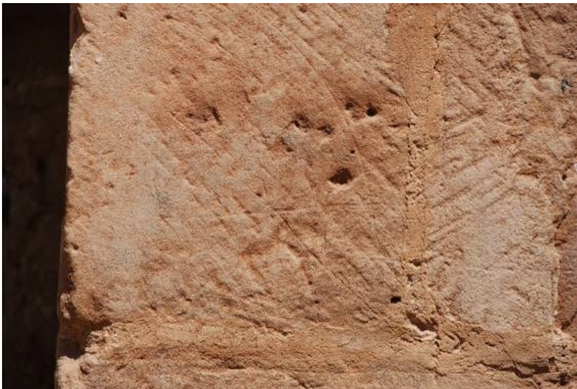
Grafito radial en el contrafuerte situado a la derecha de la portada sin orificio central.
