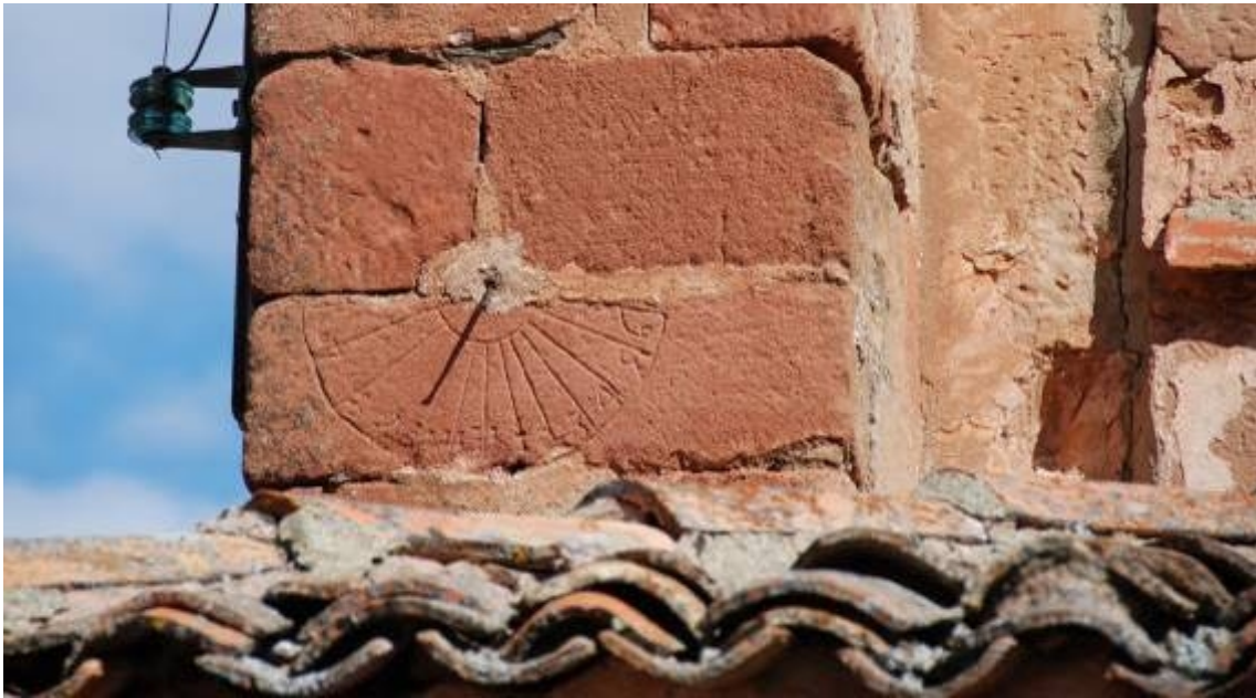
Anterior a la construcción del pórtico.
