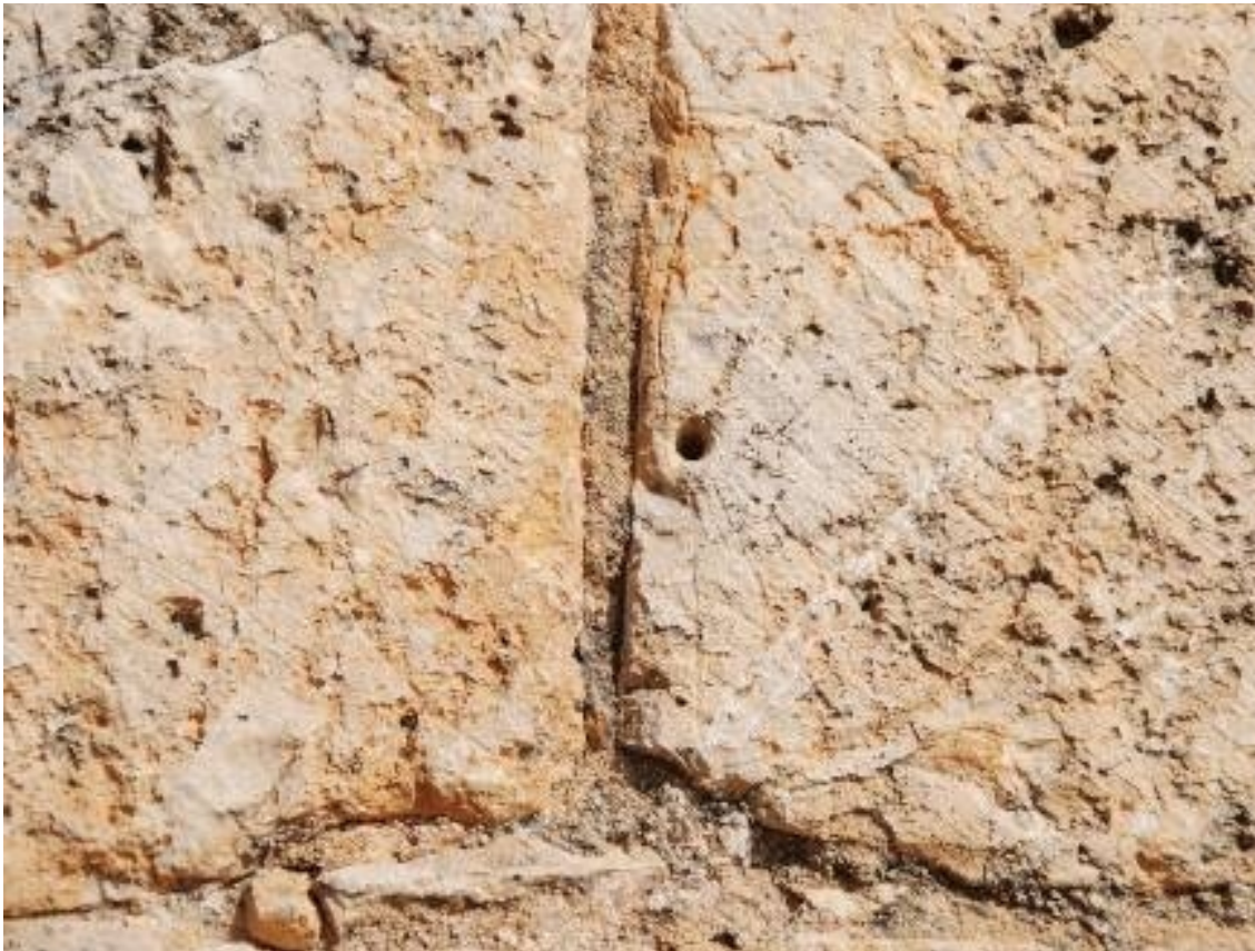
Circular en la cara del sillar. La traza invade dos sillares.
