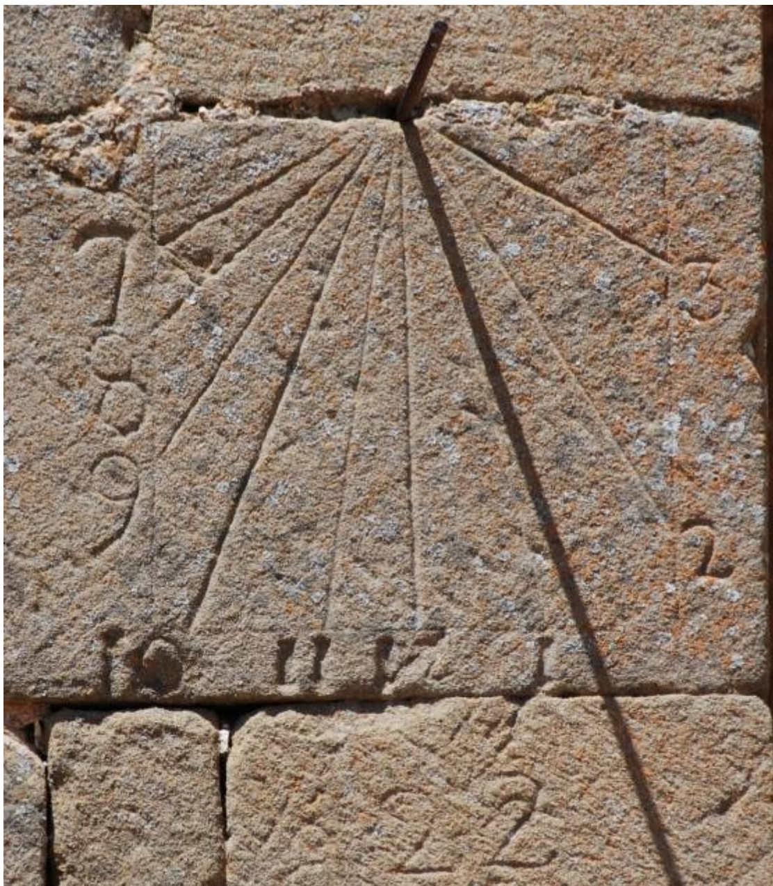
Reloj 1. Rectangular vertical en junta de sillar. Vertical declinante a levante.
