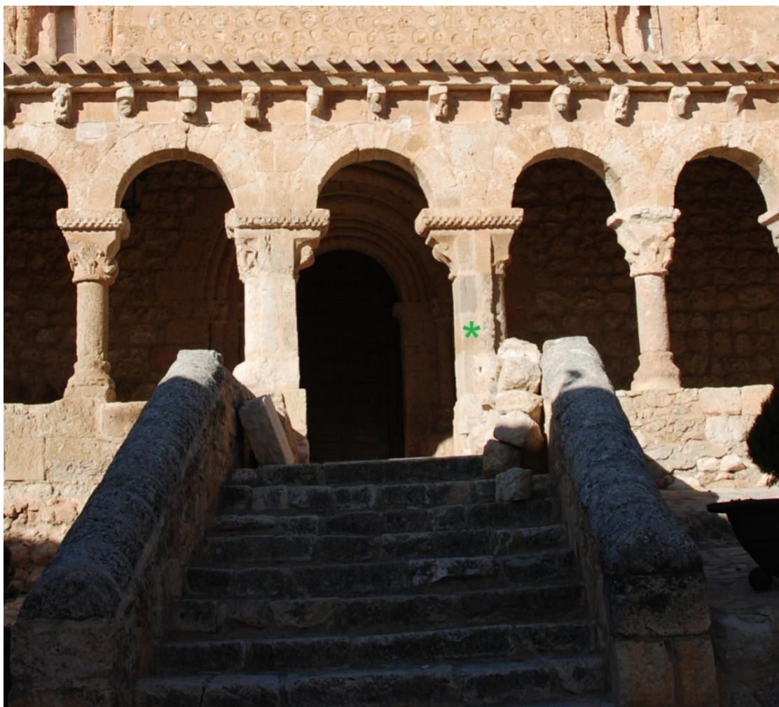
Puerta sur de la galería porticada. Situación del alquerque del III.
