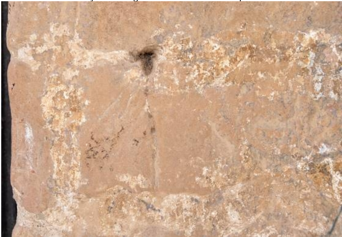
Radial en junta de sillar.
