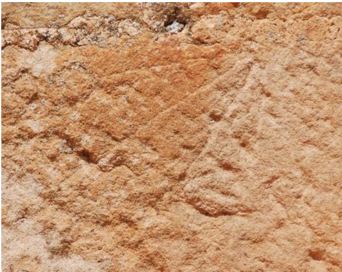
Reloj 1. Radial en junta de tres sillares. D = 30 cm.
