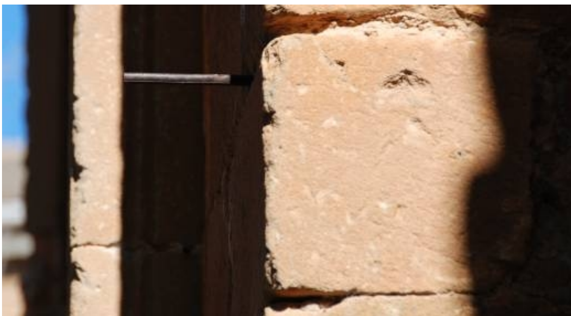
Cara este del sillar del reloj. Varilla horizontal repuesta.
