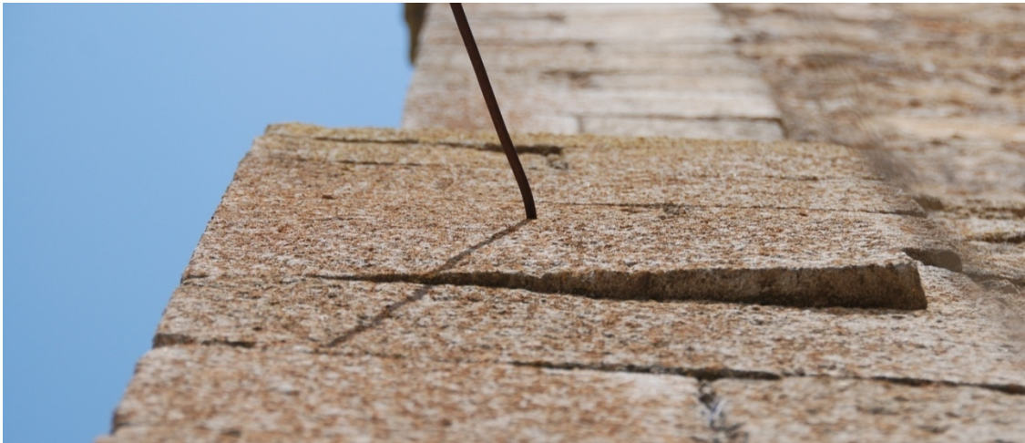
El sillar se sale del muro para orientar el reloj de sol a mediodía.
