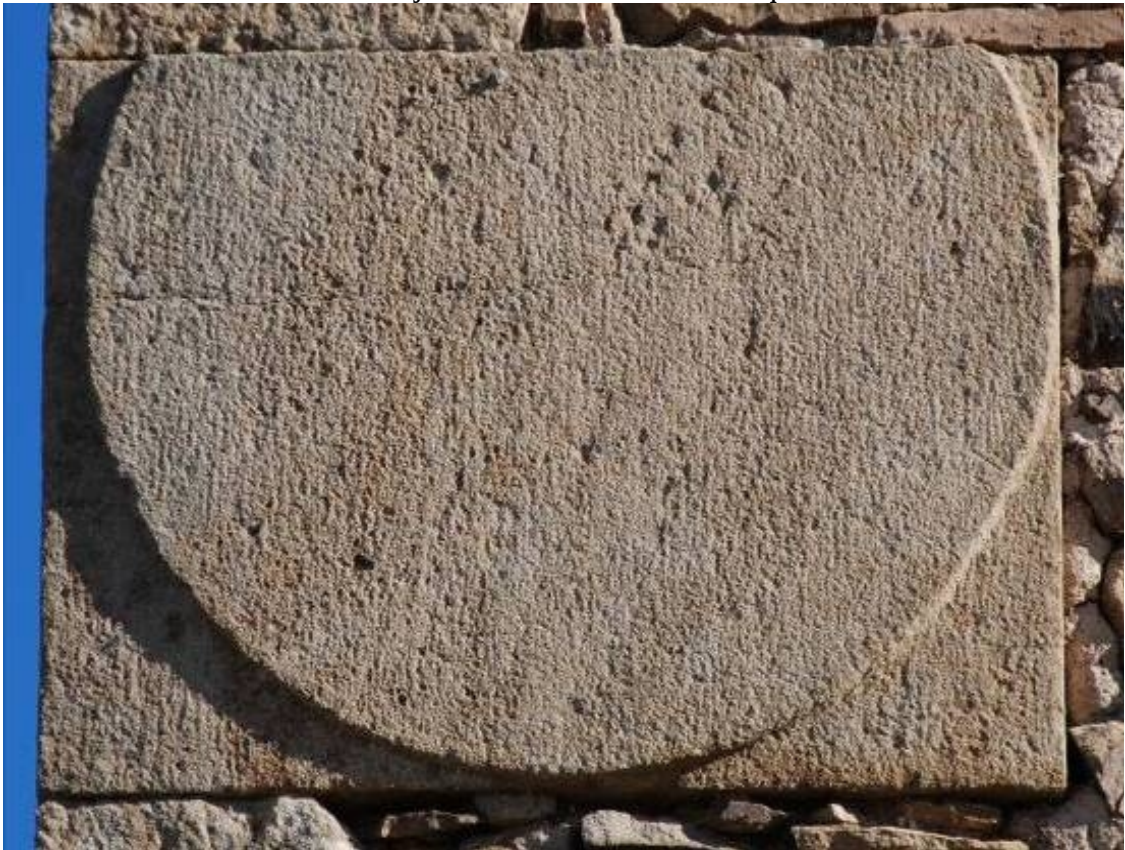
Reloj de sol no nato. No ha funcionado nunca, carece de orificio.
