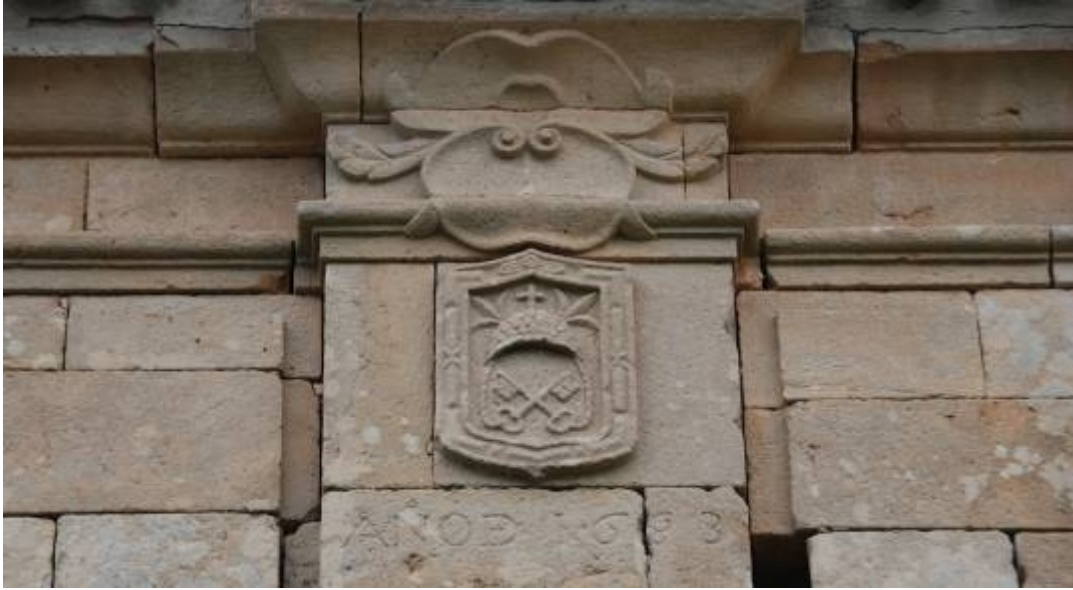
Pórtico de la iglesia de Pozalmuro. AÑO DE 1683.
