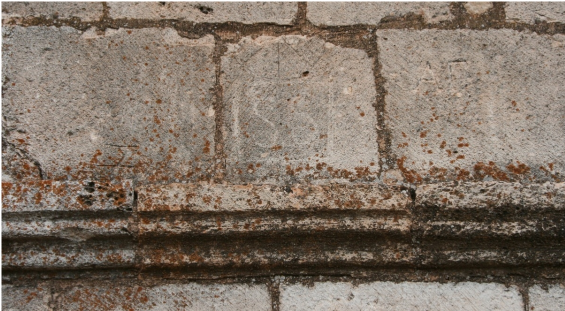
Situación del reloj canónico nº 1 en el muro de la galería porticada.
