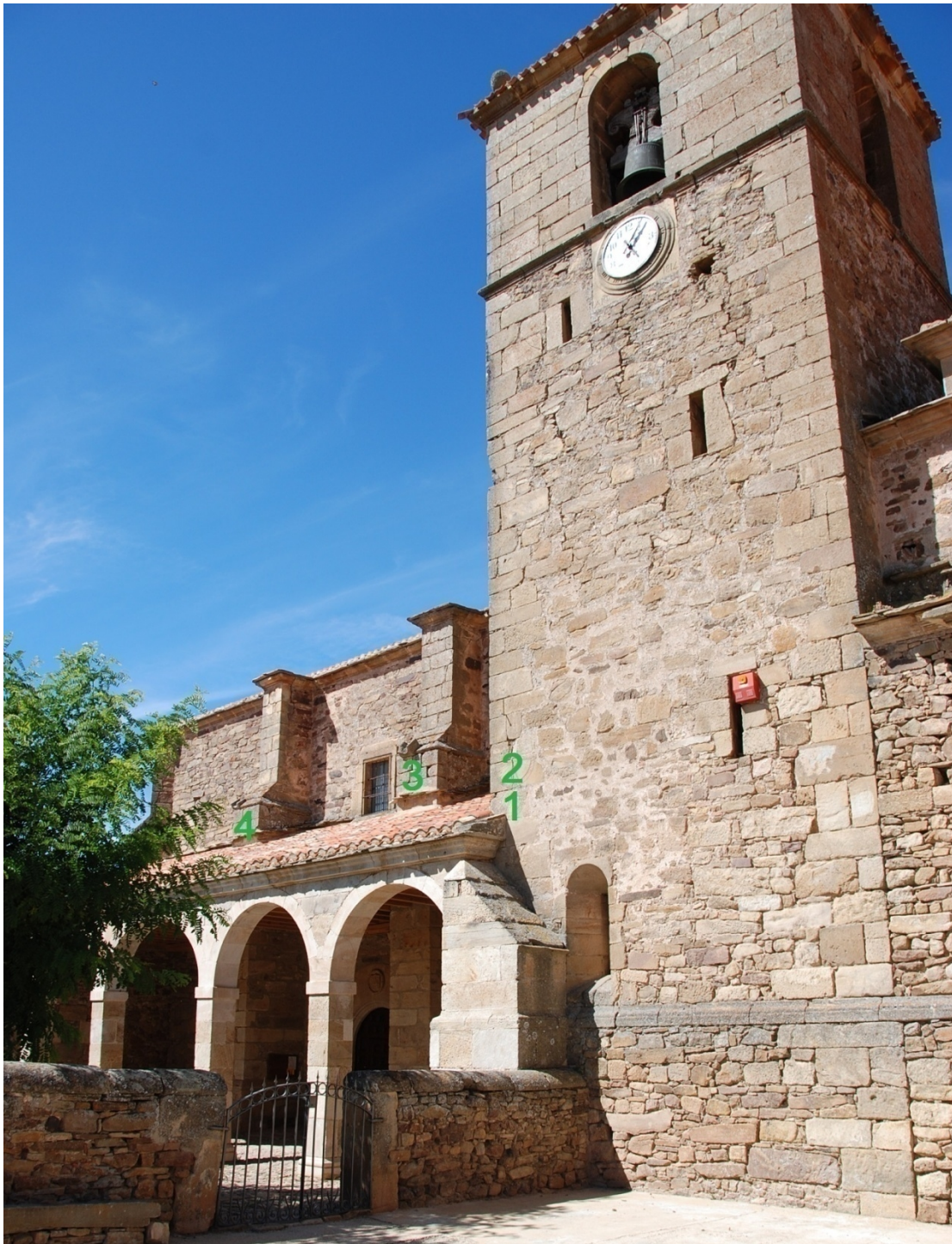
Torre y nave del siglo XVI; pórtico, crucero y cabecera añadidos en el XVIII.
