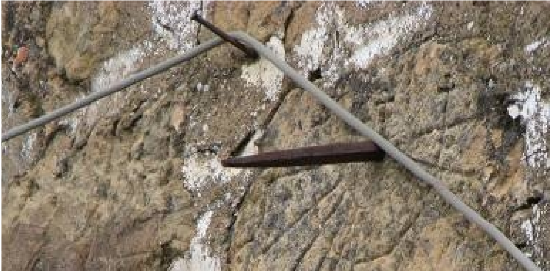
Un clavo mal orientado hace las veces de varilla.
