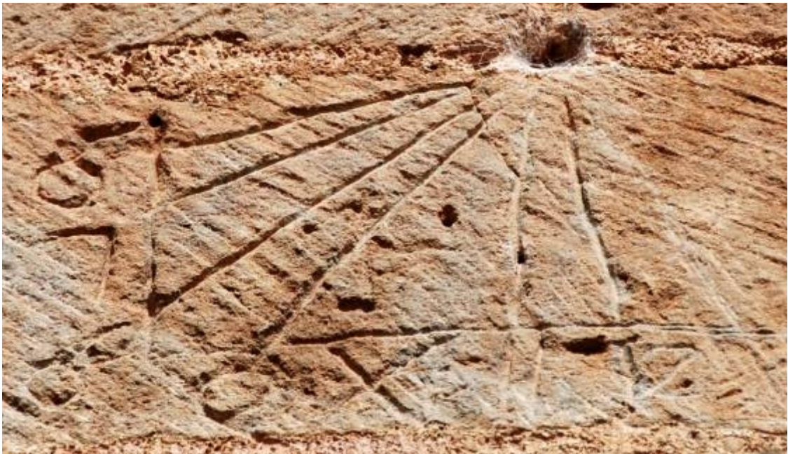
Reloj 1. Rectangular en junta de tres sillares. Meridiana desviada.
