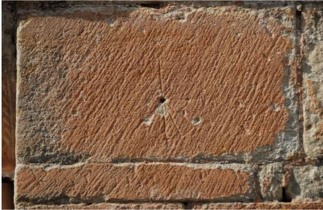
La traza está girada hacia la derecha. La línea de Sexta no es vertical
