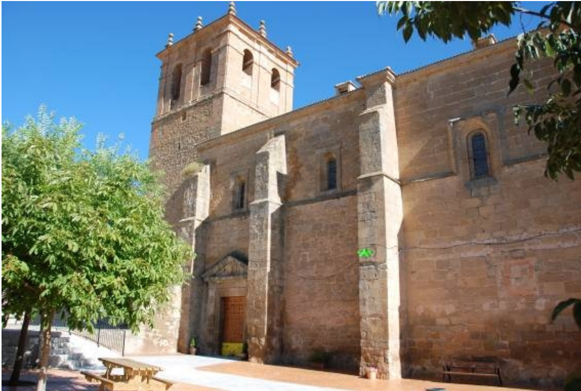
Situación del reloj de sol en un esquinual del contrafuerte.
