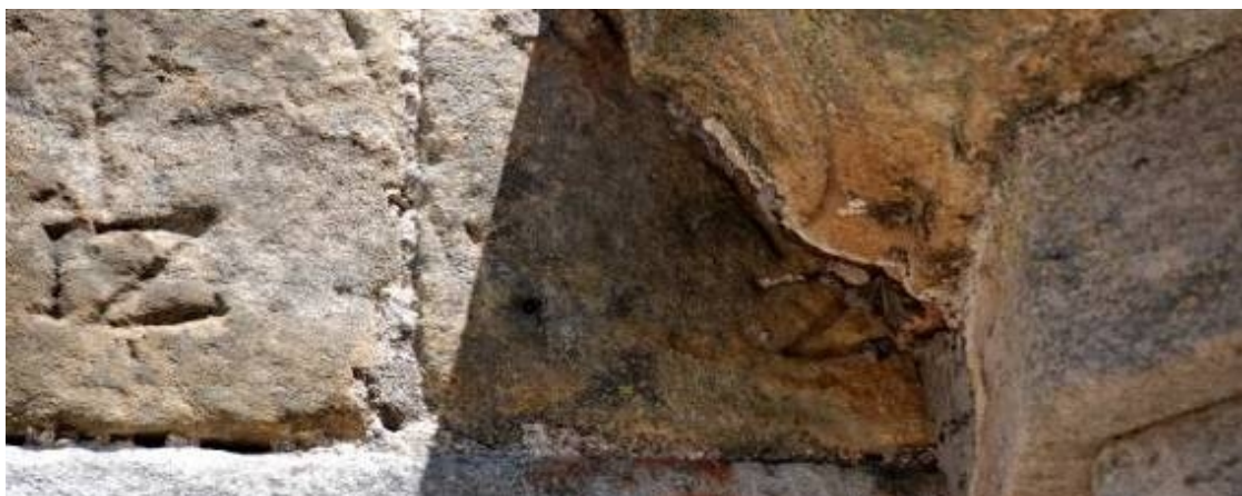
Detalle. Línea y cifra dos en “Z” ocultas bajo la cornisa de la sacristía.
