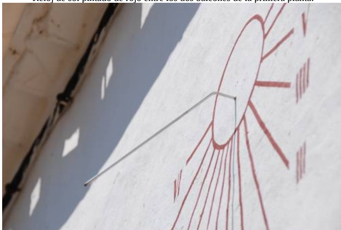
Varilla de acero inoxidable con el apoyo situado por debajo del polo.
