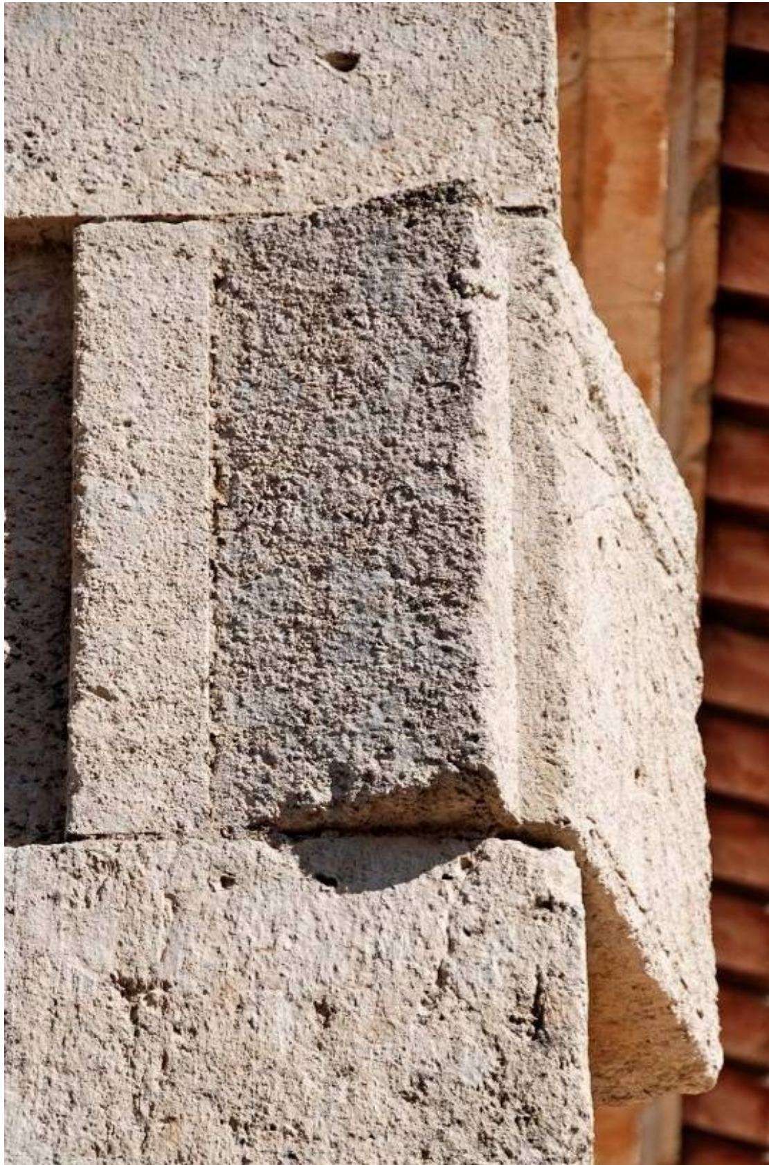
El sillar del reloj de sol se sale de la esquina para orientar la traza a mediodía.
