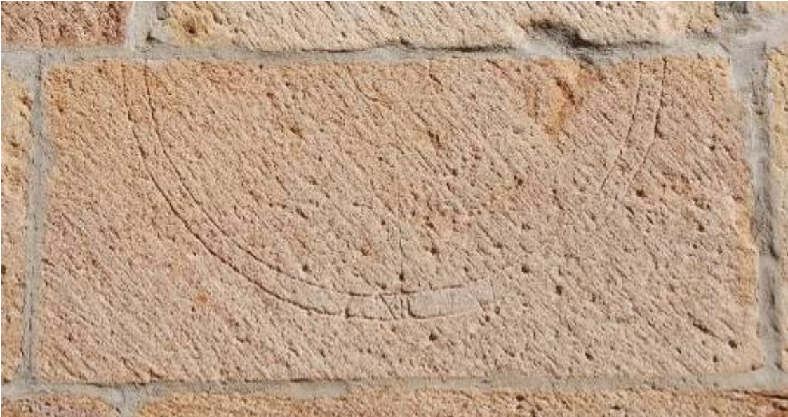
Reloj 1. Semicircular en junta de sillar. Semicírculo distribuidor. Meridiana. XII.
