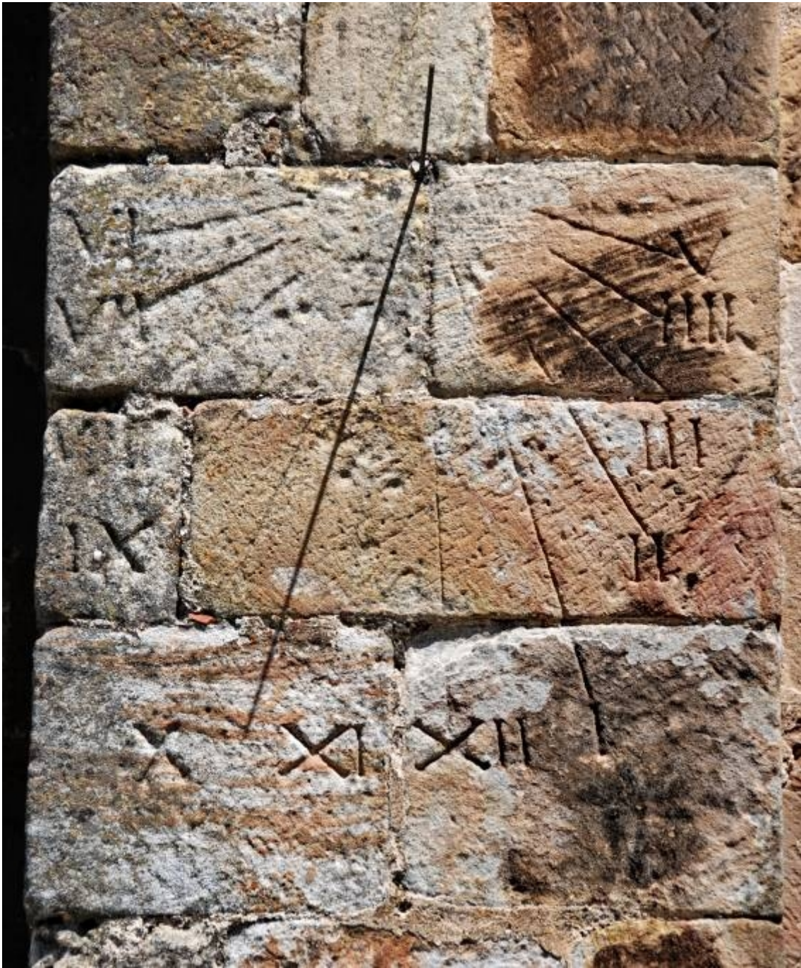
Reloj 1. Radial en junta de tres sillares. Vertical declinante a levante.
