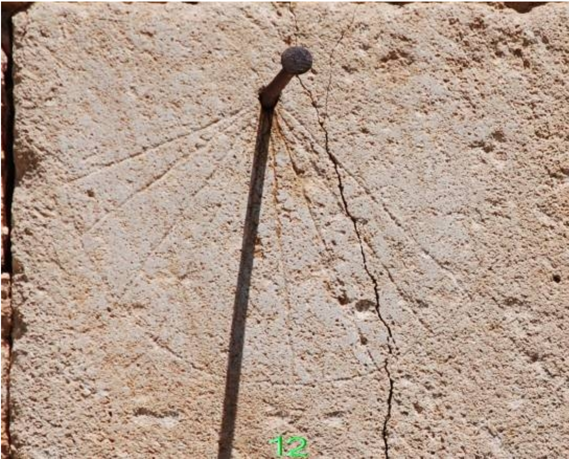
Reloj 1. Meridiana desviada. Declinación a levante.
