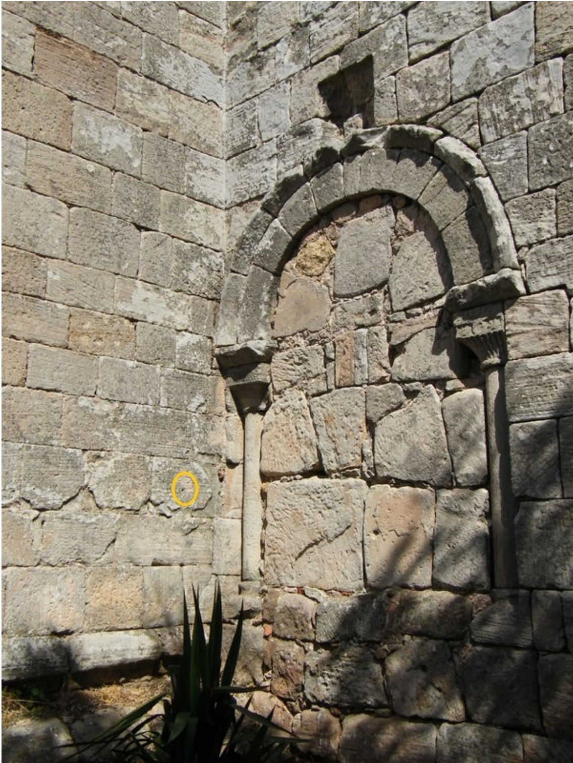
Reloj de sol canónico. Esquina de la nave con el brazo sur del crucero.
