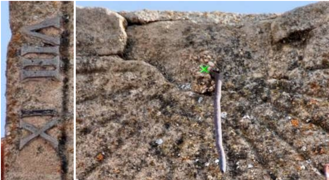
Números de plomo. Varilla desplazada del polo.
