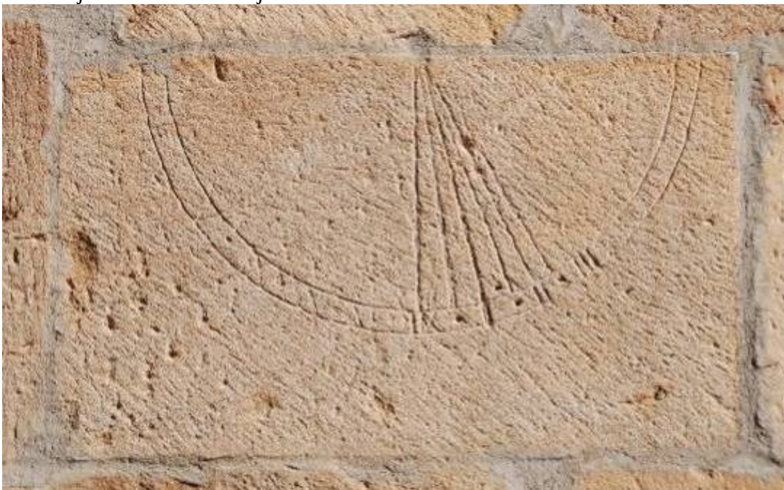
Reloj 2. Semicircular en junta de sillar. Líneas marcadas de doce a dos y media.
