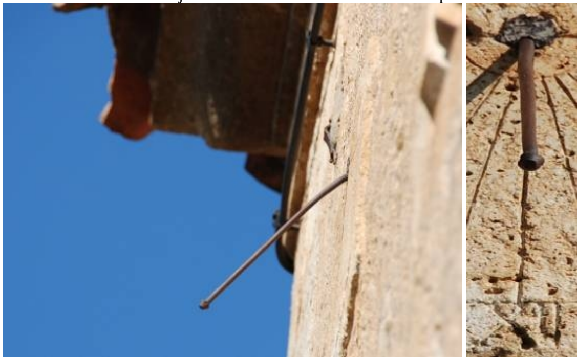
Varilla original de un solo apoyo, emplomada y terminada en punta cónica.
