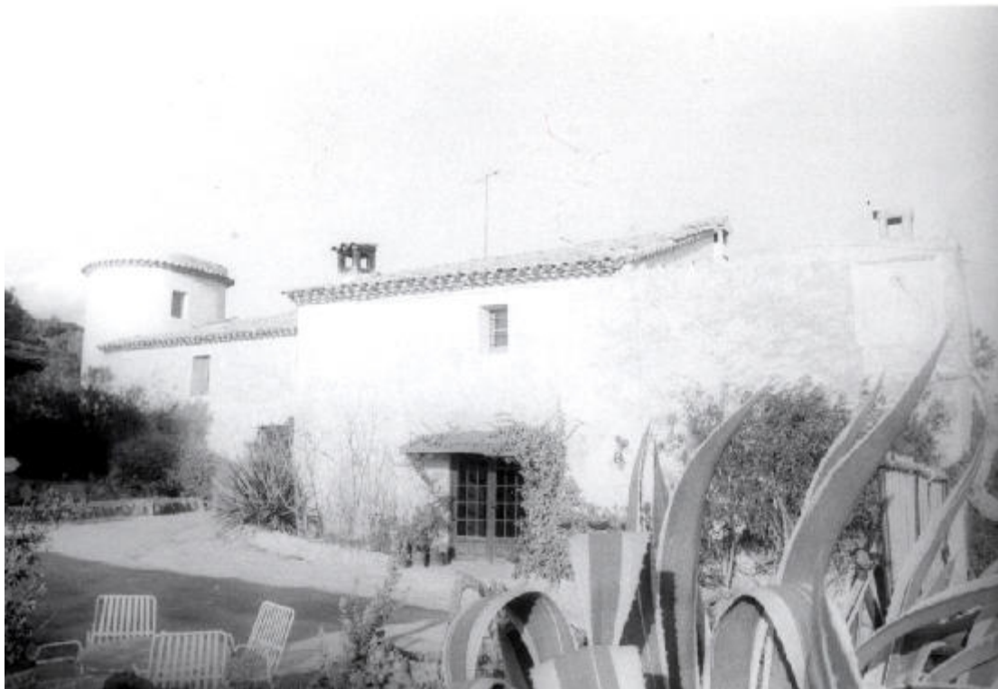
Masía dels Masos. Vendrell. Baix Penedès. PATRIMONI.GENCAT M. Ferré i Jané.
