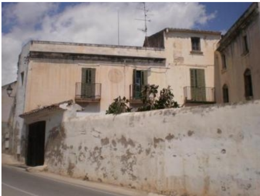
Can Zidret. Sant Pere de Ribes. Garraf. DIBA Mapes de Patrimoni Cultural 08231/449.
