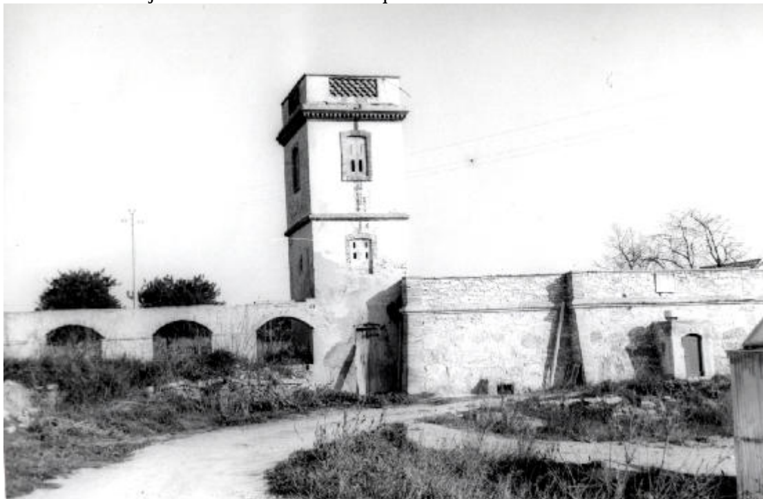
Centre de captació d'aigües per regar. Llorenç del Penedès. Baix Penedès. PATRIMONI.GENCAT M.Ferré i Jané.
