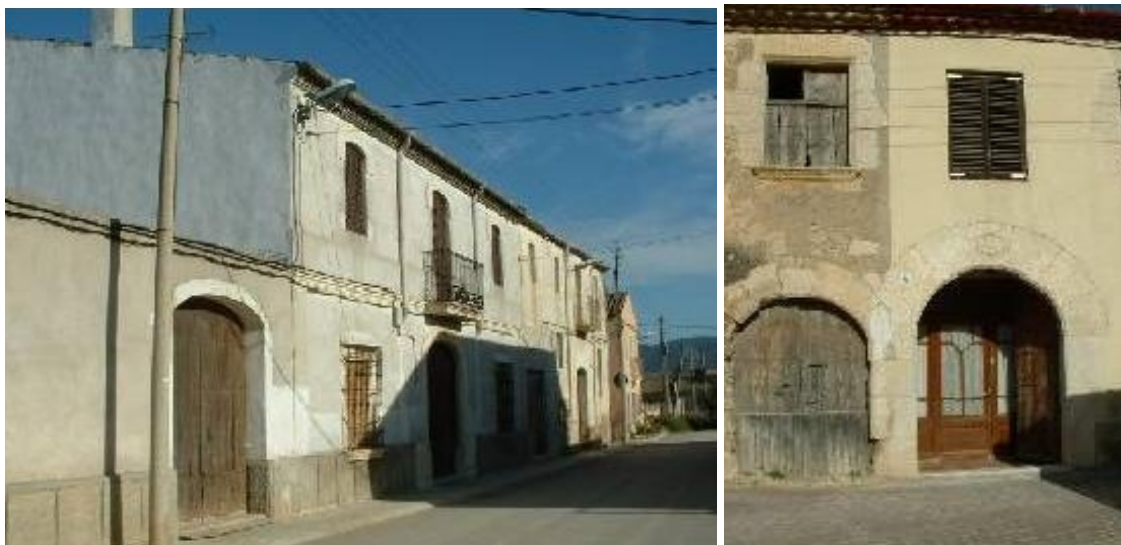
14. Cal Ferreret. Avinyonet del Penedès. Alt Penedès. DIBA Mapes de Patrimoni Cultural.
