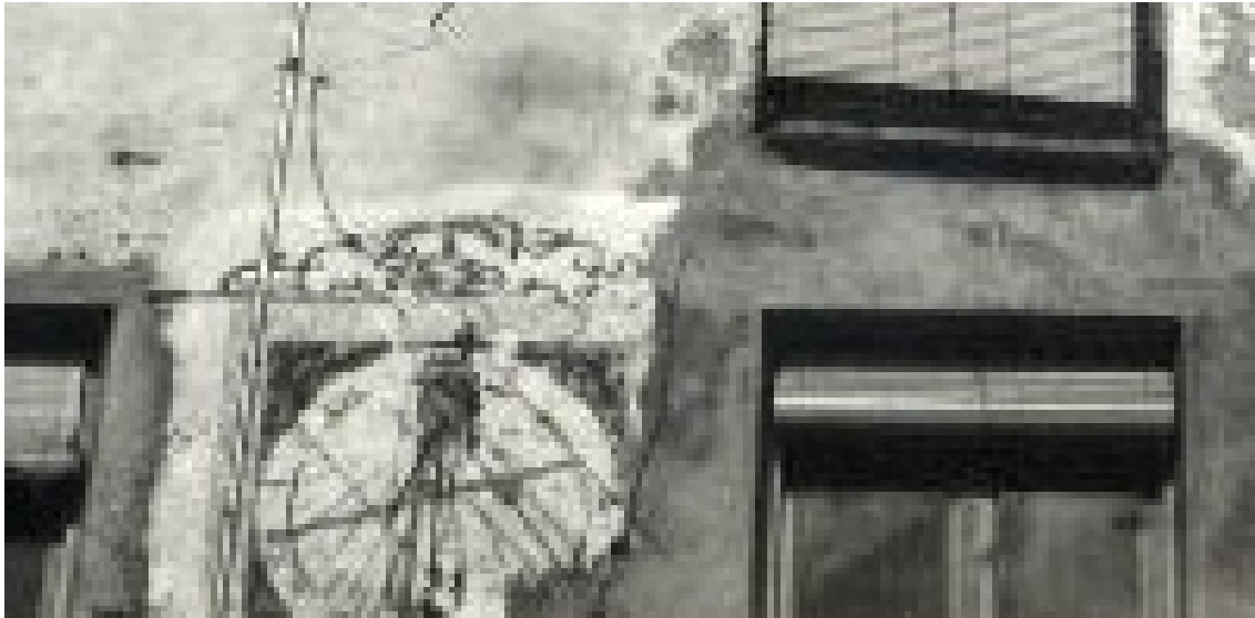
Circular inscrito en un cuadrado, marco y remate decorados con motivos geométricos. Vertical declinante a poniente. Línea equinoccial
