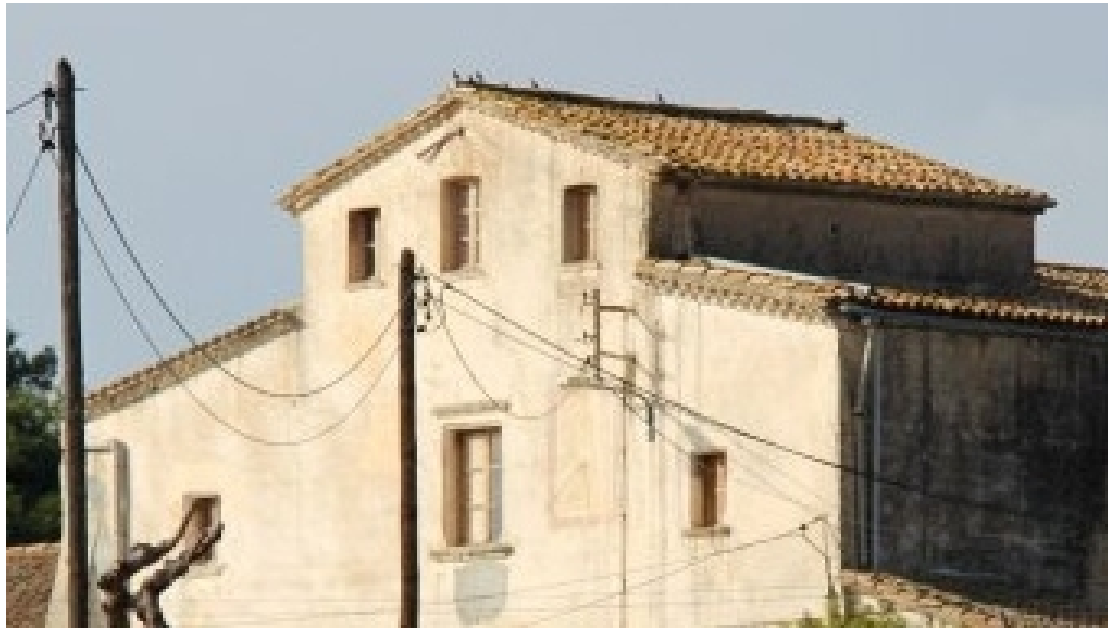
Situado a la derecha de la ventana central del primer piso. Rectangular vertical Varilla de un apoyo.
