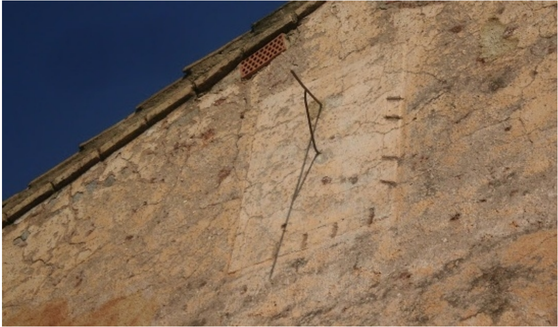
Rectangular. VDP. Marcas en la banda horaria. Varilla de dos apoyos en 'Y'.
