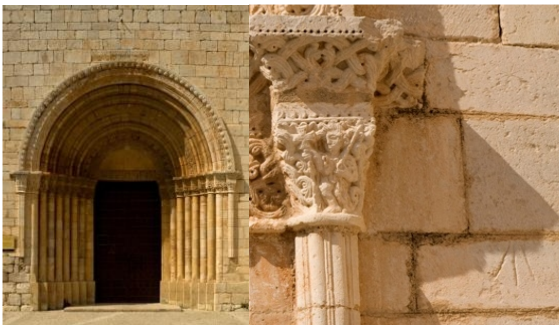
Canónico. Radial de tres líneas en junta de sillar.
