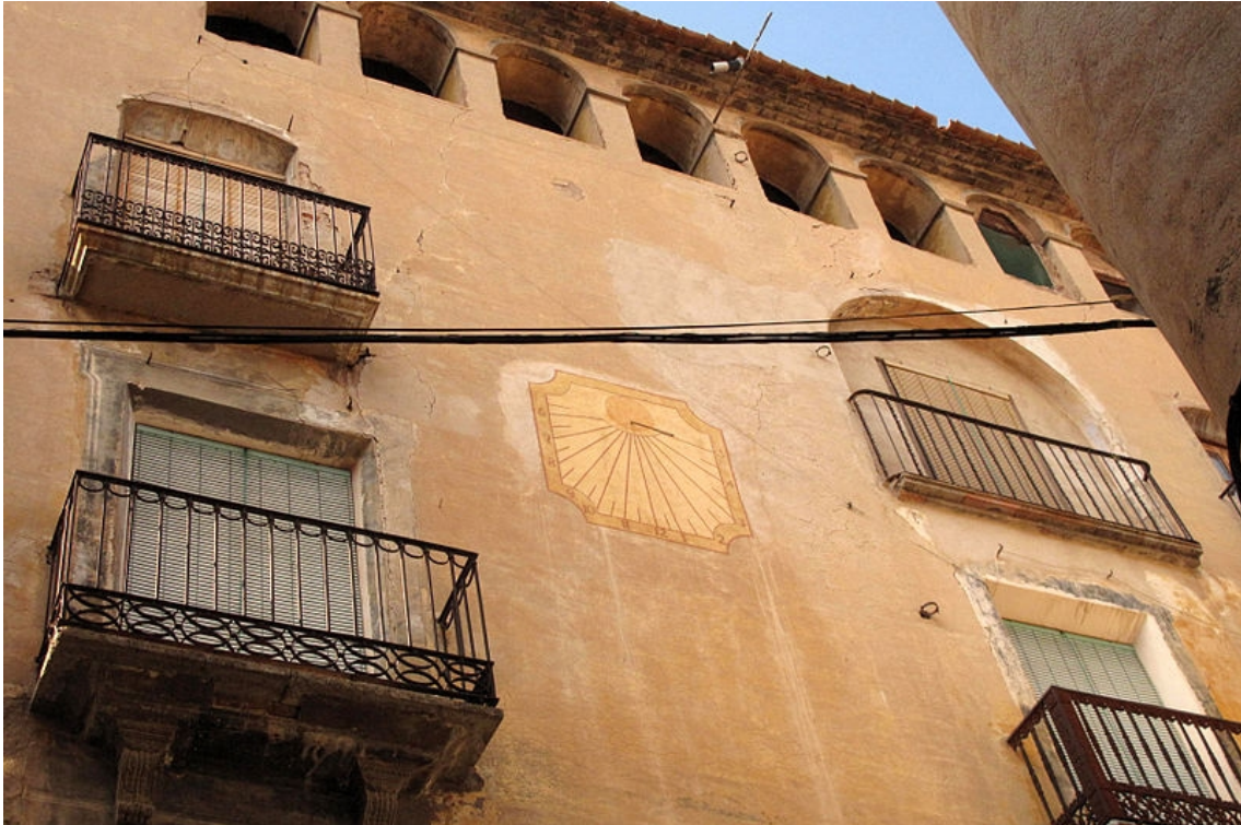
Ca l'Amorós. Porrera. Priorat. PATRIMONI.GENCAT Enfo 2010.
