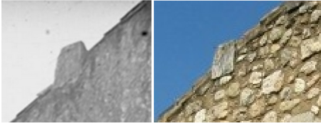
Reloj de sol de piedra exento. Números arábigos. Varilla de un apoyo.
