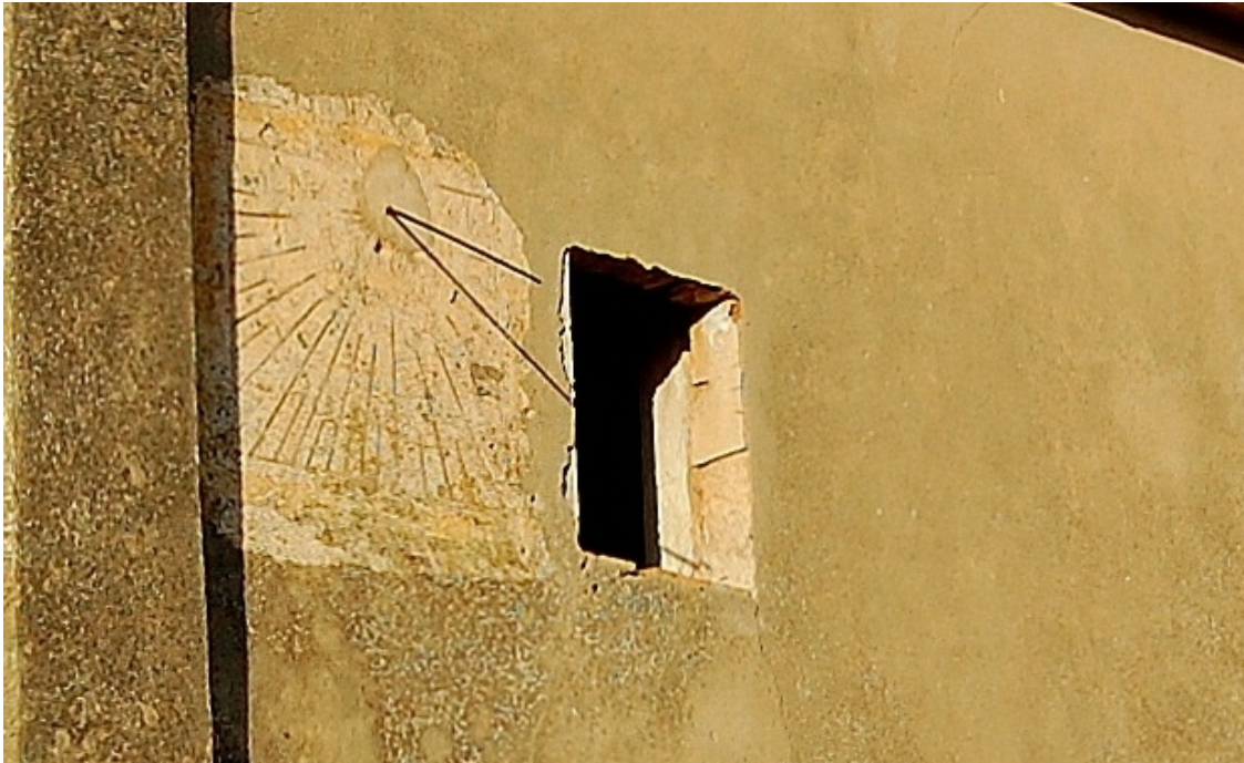
Rectangular. VDP. Marca medias y cuartos. Varilla reparada.
