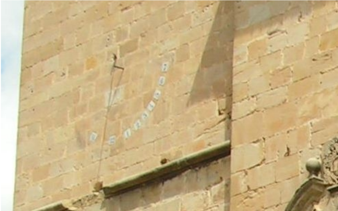
VDL. Horas en números arábigos de 11 de la mañana a 7 de la tarde. Varilla de dos apoyos en 'Y'. Posible complementario en el costado oeste de la torre.
