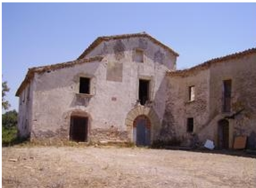
Can Ros. Subirats. Alt Penedès. DIBA Mapes de Patrimoni Cultural 08273/112.
