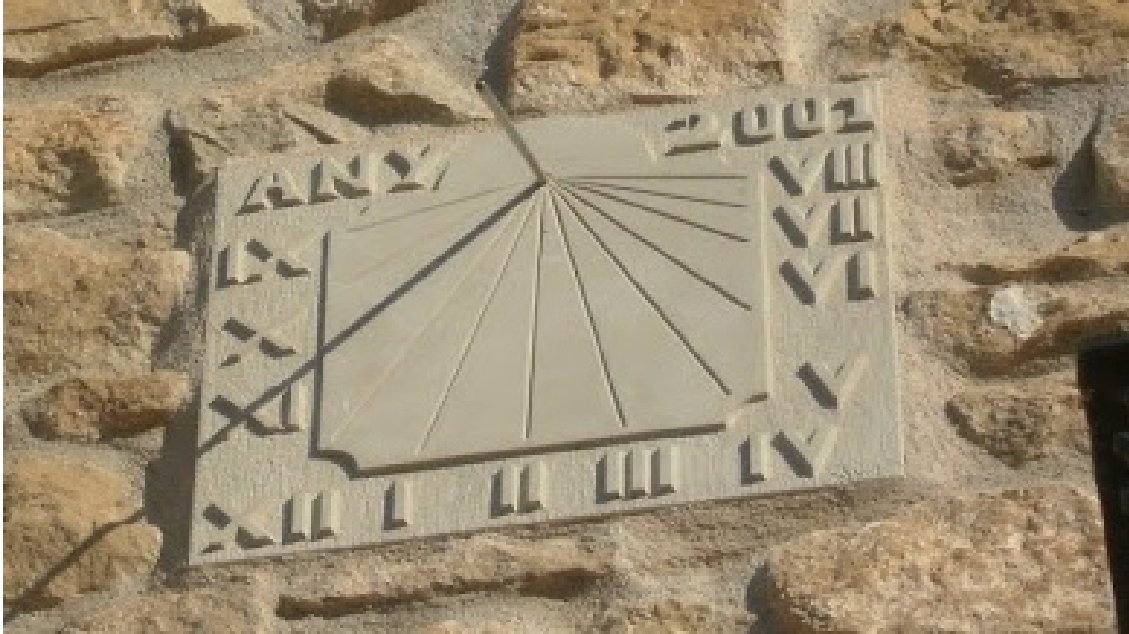
Reloj de sol decorativo grabado en una placa de piedra empotrada en el muro de mampostería, con los números horarios y la inscripción de la fecha en hueco relieve. MD. Horas en números romanos, de IX de la mañana a VIII de la tarde. Varilla horizontal. Fecha: ANY 2002. Firmado.
