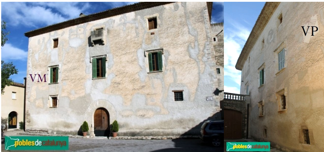
Palau Gralla / Torre-ramona. Subirats. Alt Penedès. Fotos Albert Esteves 2012.
