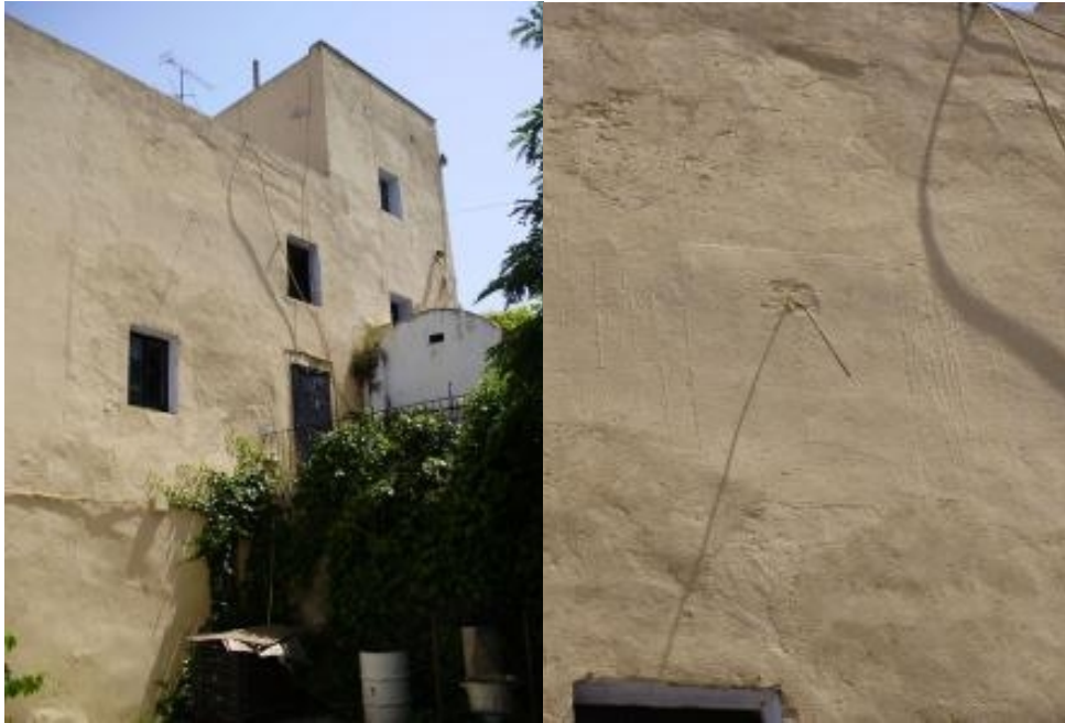
Can Ribalta. Torrelavit. Alt Penedès. DIBA Mapes de Patrimoni Cultural 08287/67.
