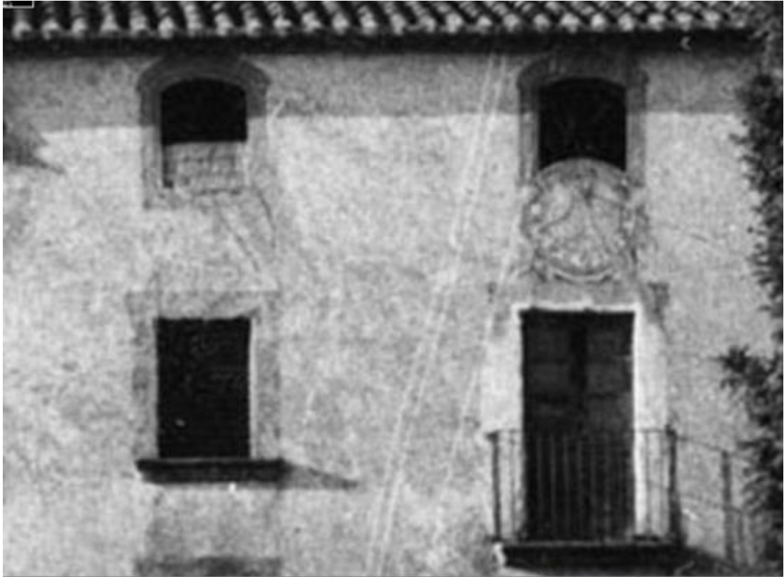
Circular. Polo desplazado hacia la derecha. VDL. Varilla de un apoyo.
