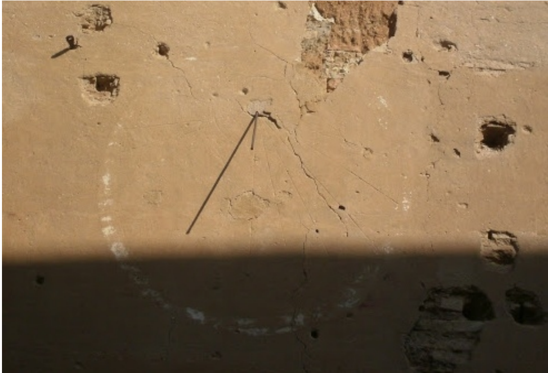
Situado entre los balcones central e izquierdo. Circular. Círculo distribuidor. VDL. Marca de seis a cinco. Numeración desaparecida.. Varilla de un apoyo.
