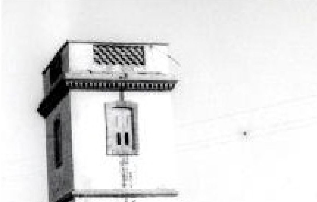
Reloj de sol doble haciendo esquina en lo más alto de la torre.
