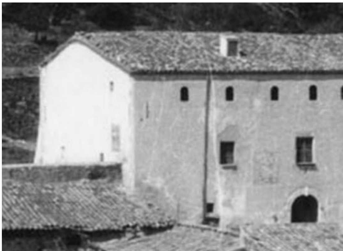
Reloj doble. Dos cuadrantes rectangulares. Fachadas sur y oeste.
