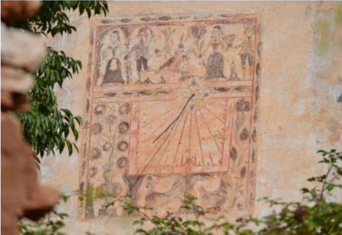
Cuadrante VDL del reloj doble. Polo desplazado hacia la derecha. Horas en números árabigos, de 7 de la mañana a 4 de la tarde. Marca también medias y cuartos. Varilla de un apoyo mal orientada. La casa se construyó el año 1778.
