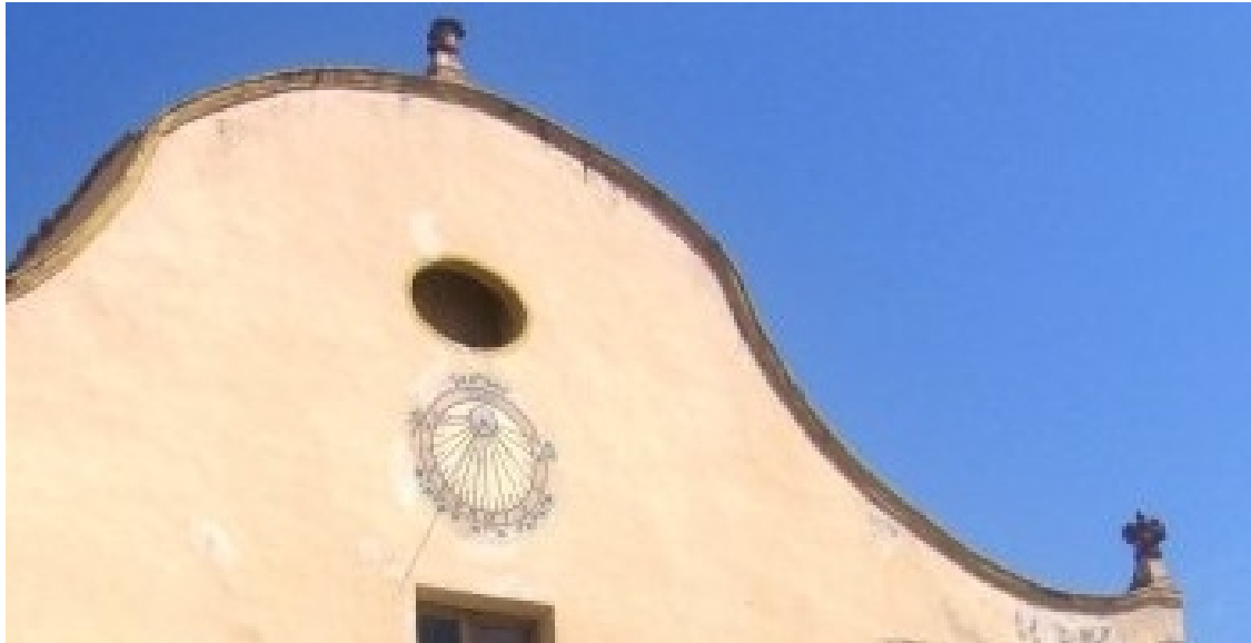
Circular. Marco exterior decorado con racimos y pámpanos. Horas en números arábigos, de 5 de la mañana a 5 de la tarde. VDL. Varilla de un apoyo. Año 1870.
