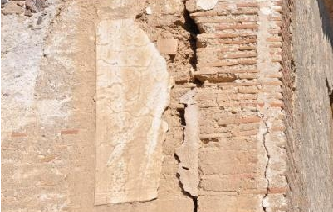
La grieta en muro de ladrillo ha originado el desprendimiento de la mitad derecha de la superficie enlucida del reloj de sol. En la descripción se dice que tiene orientación sudeste y que marcaría de siete a seis.
