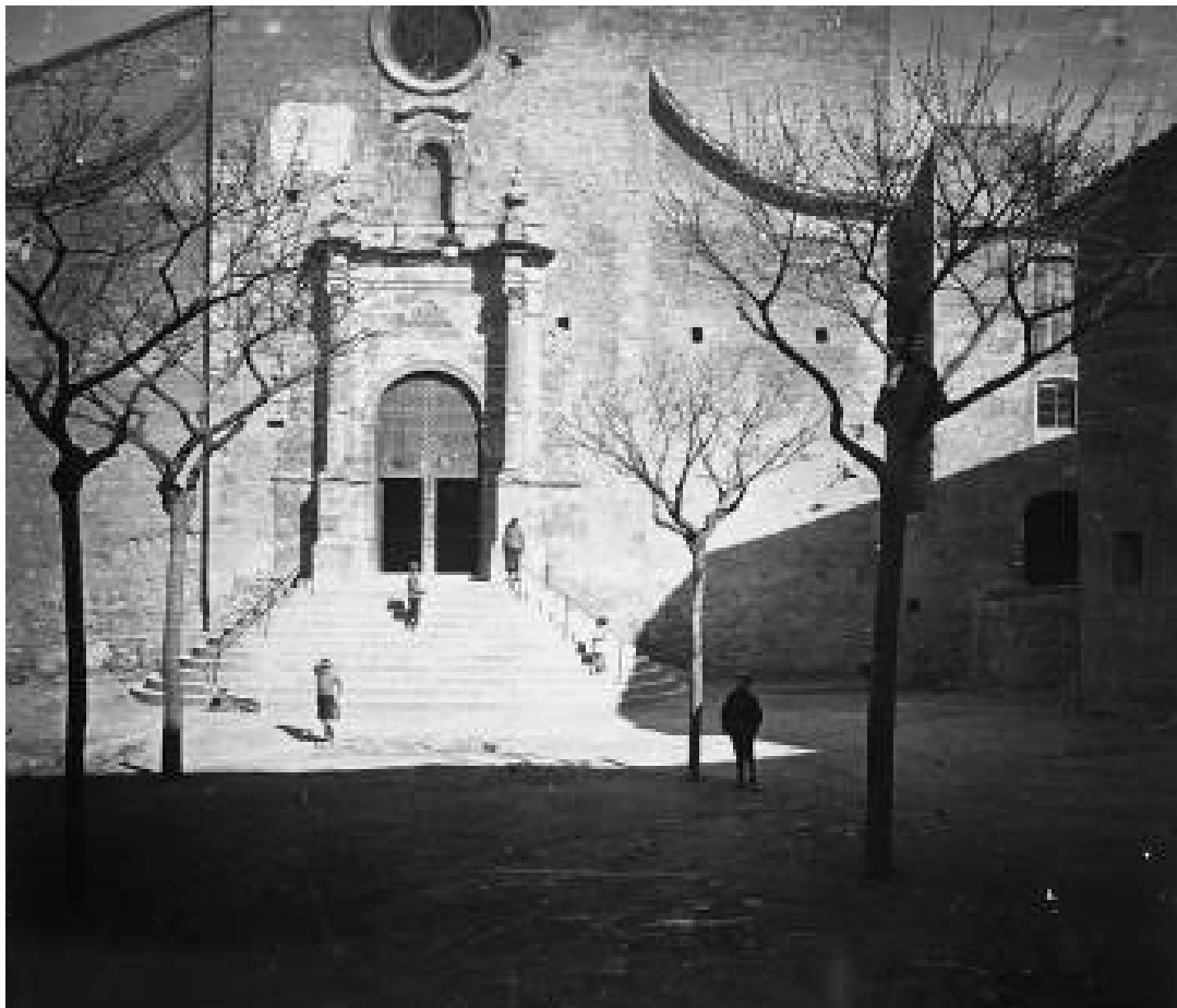
Església de Capçanes. Priorat. BC Fons fotogràfic Salvany. 1923. R.
