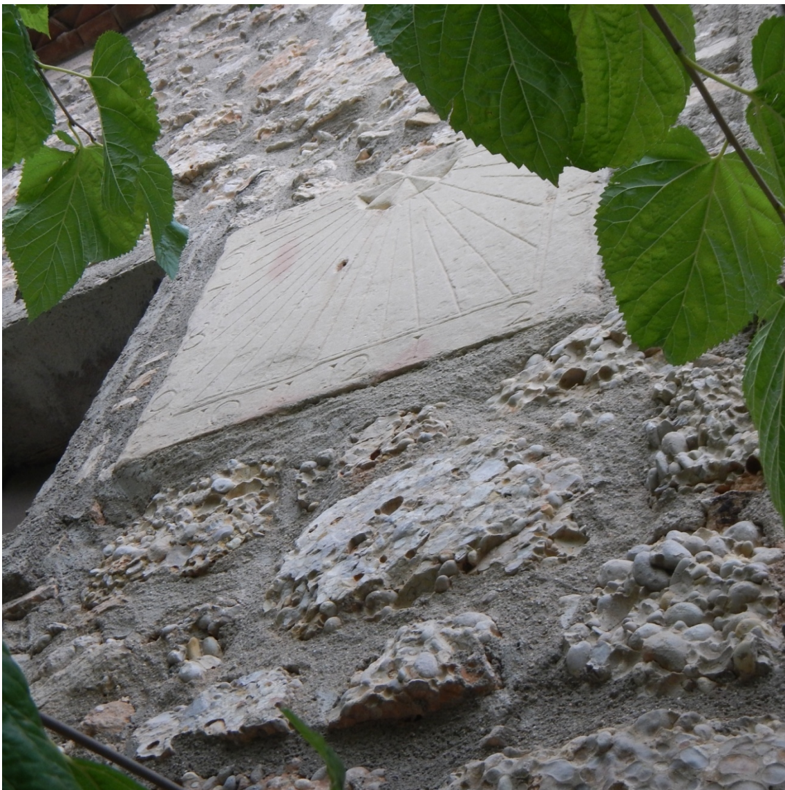
Reloj de sol doble. Cuadrante vertical declinante a levante.
