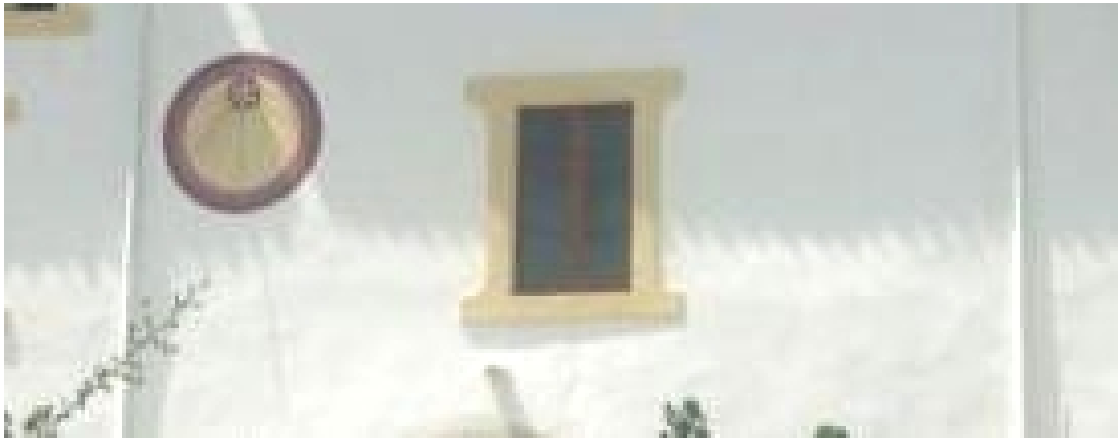
Circular. Hexafolio decorando el polo. VDL. Horas en números romanos, de V de la mañana a IV de tarde. Varilla de un apoyo. Año 1816.
