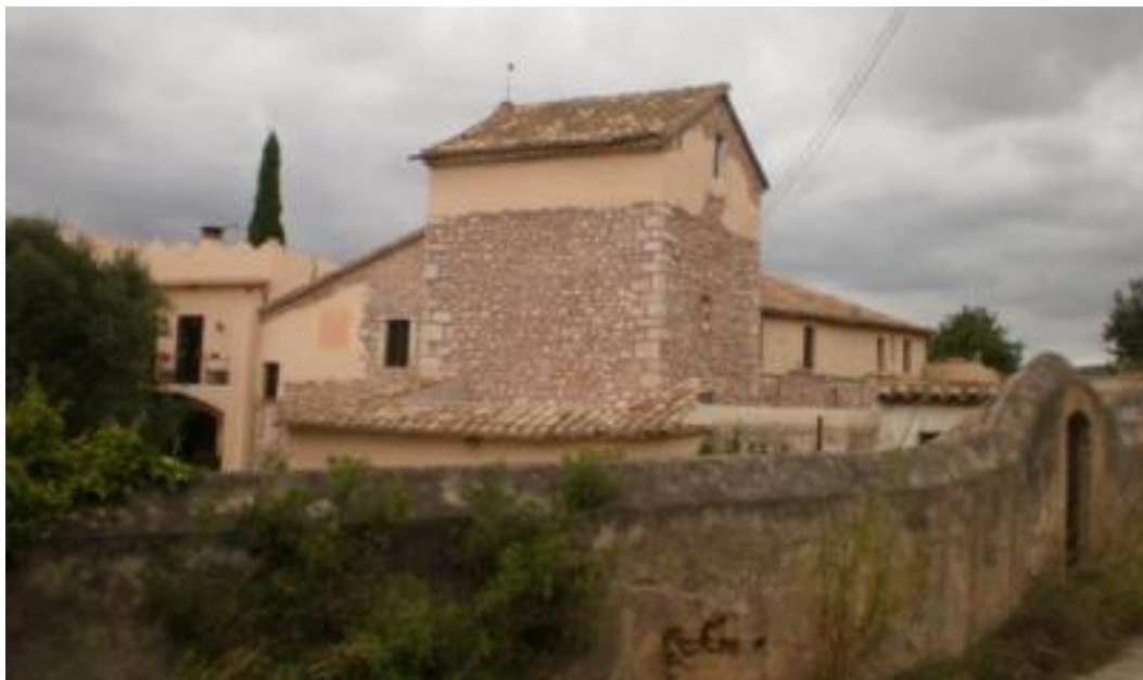
Torre de Can Bruguera. Sant Pere de Ribes. Garraf. DIBA Mapes de Patrimoni Cultural 08231/4.
