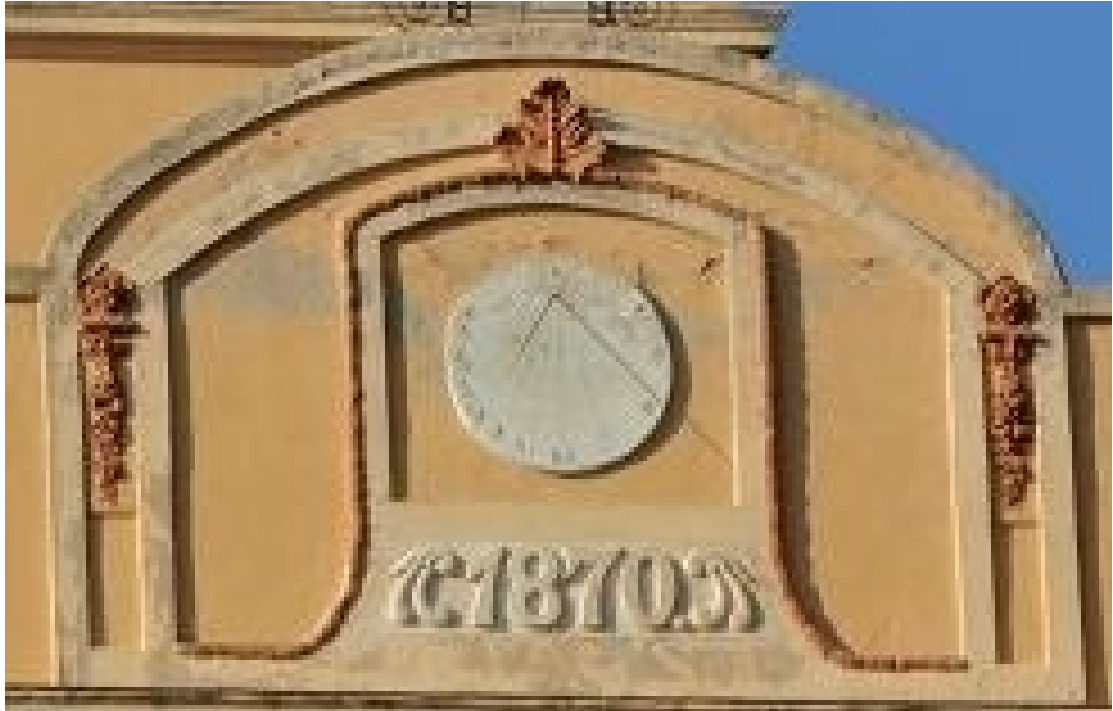
Circular. VDL. Horas en números romanos, de V de la mañana a IV de la tarde. Varilla de un apoyo. Año 1870.
