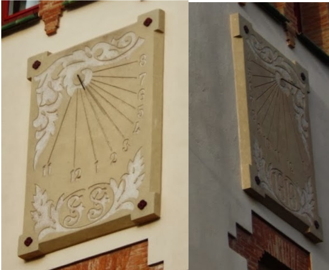
Reloj de sol doble: VDL y VDP. Radiales esgrafiados en una superficie rectangular saliente del muro, con orejas y lados biselados. Los espacios que dejan libres la traza están decorados con motivos geométricos. Los dos cuadrantes están numerados en arábigos; el VDP, de 11 a 8, y el VDL, de 4 a 1. Varilla de un apoyo.
