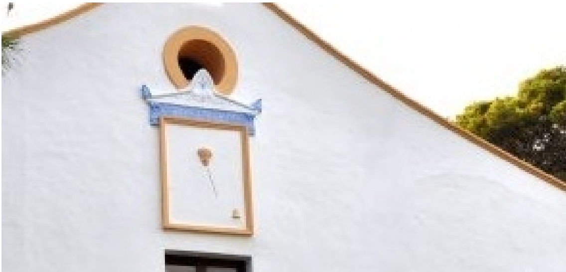
Rectangular: Marco y frontón en relieve. Varilla de un apoyo.
