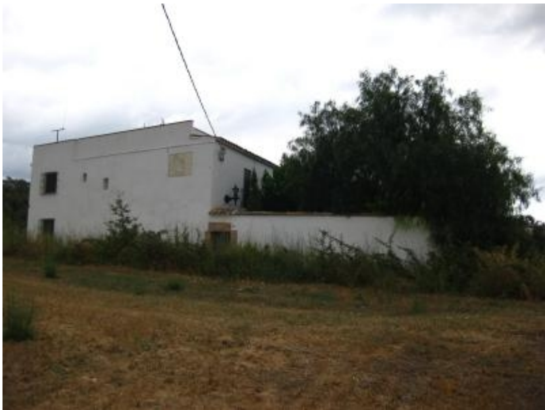
Cal Tort de Massenyès. Torrelavit. Alt Penedès. DIBA Mapes de Patrimoni Cultural 08287/136.
