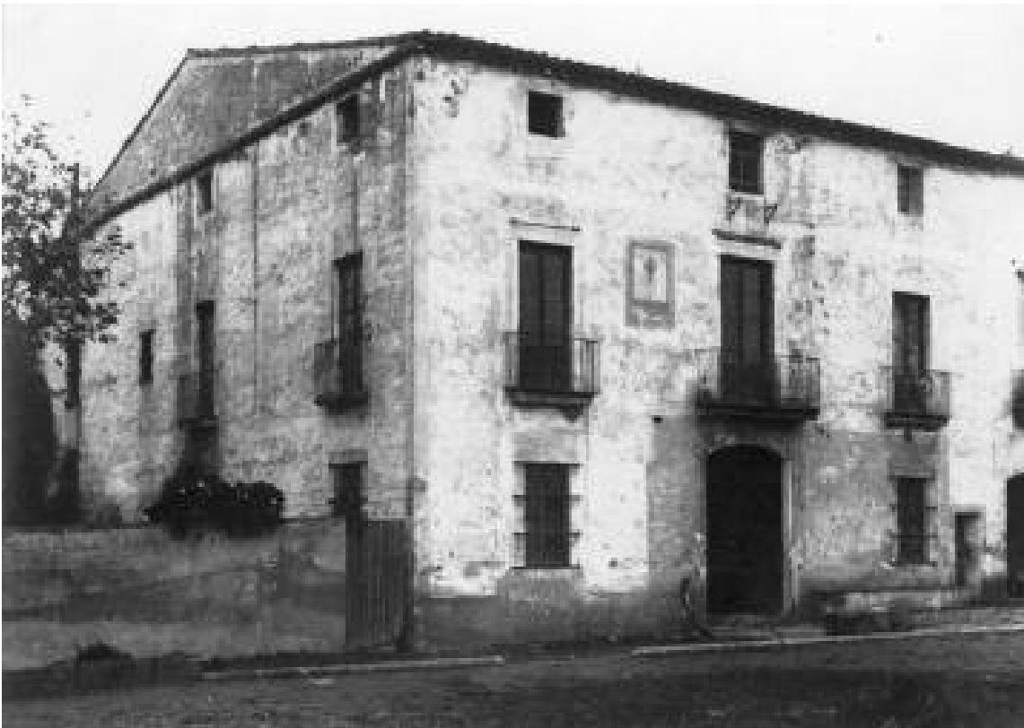
Vista general d'una casa. Espanya. AFCEC. 1890-1936.
