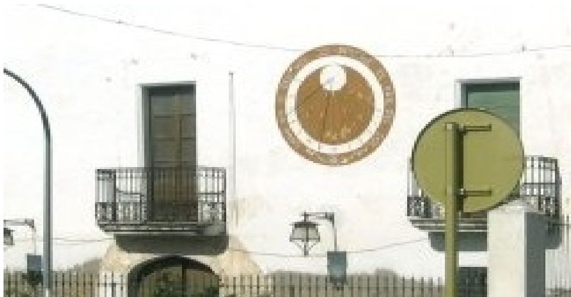
En 2006 presentaba múltiples desprendimientos de la pintura.
