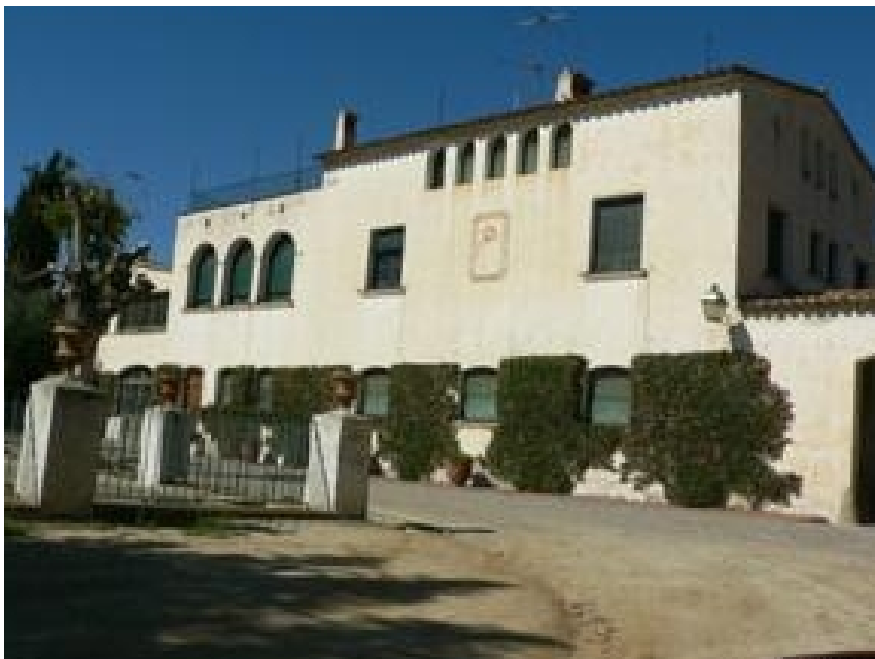
Can Badia. Cabriels. Maresme. DIBA Mapes de Patrimoni Cultural 08030/81.
