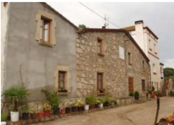
Can Rimbles. Dosrius. Maresme. Canyamars. Veïnat Rimbles. Al costat de la finestra central hi ha un senzill rellotge de sol, de perímetre rectangular
