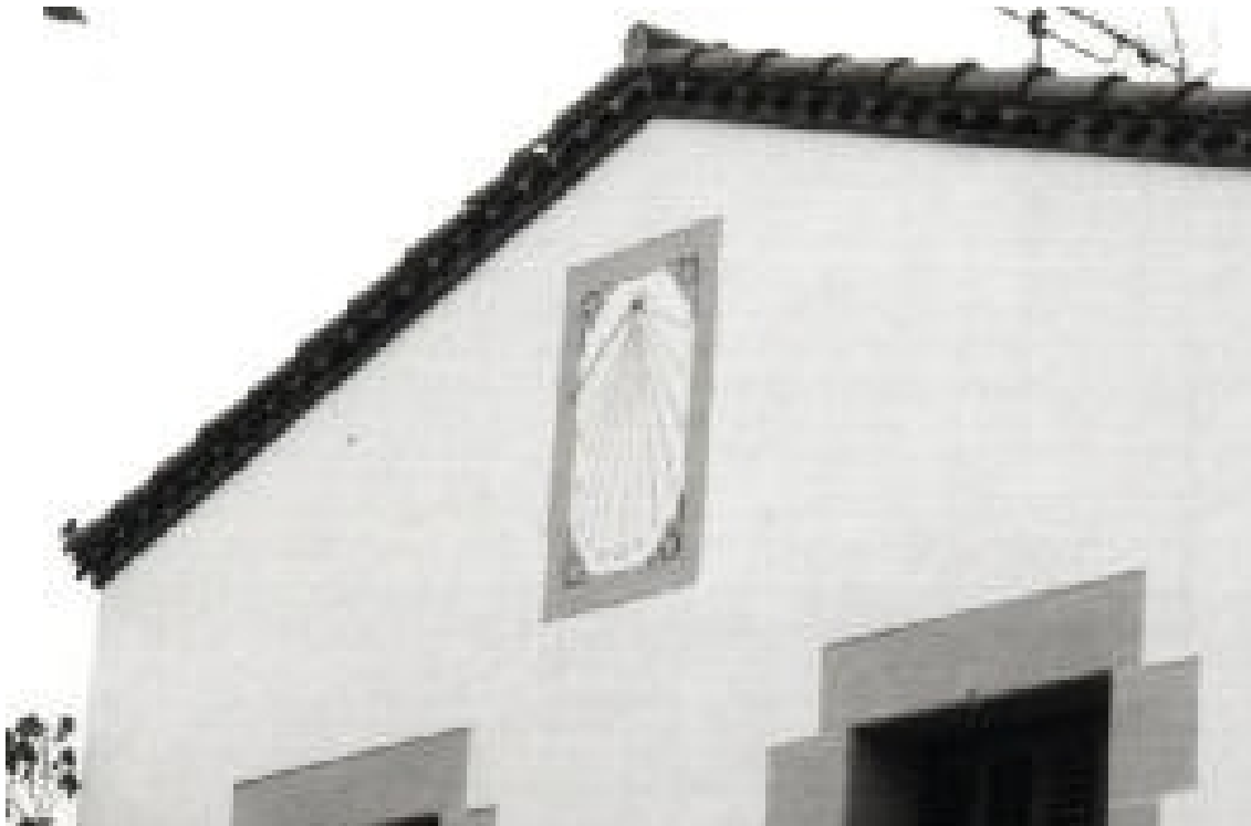
Radial en el interior de un rectángulo con un motivo decorativo que se repite en las cuatro esquinas y marco de otro color. Vertical declinante a levante. Varilla de un apoyo.
