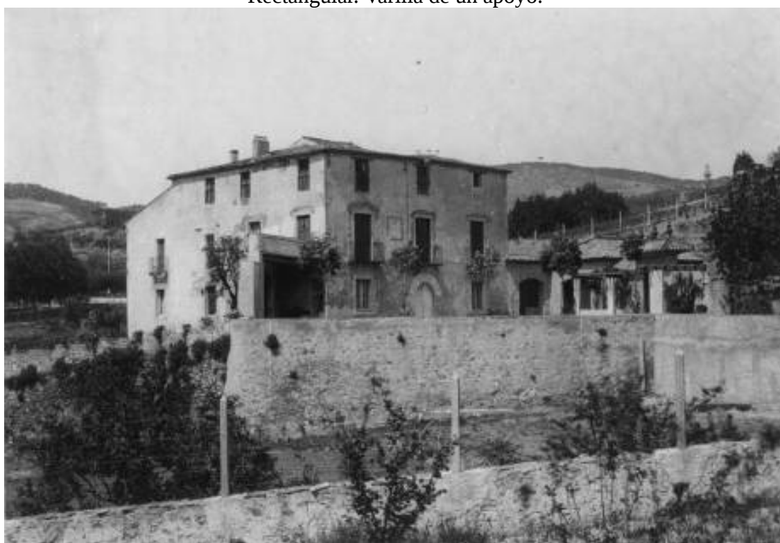
Casa de les Monges. Alella. Maresme. AFCEC J. Danés i Torras. 1931.
