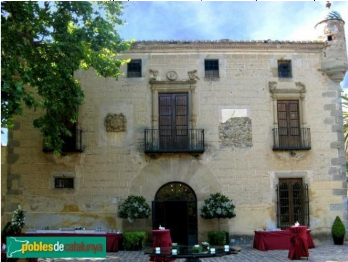
Argentona - Can Cabanyes (Foto: Albert Esteves, 2007)
