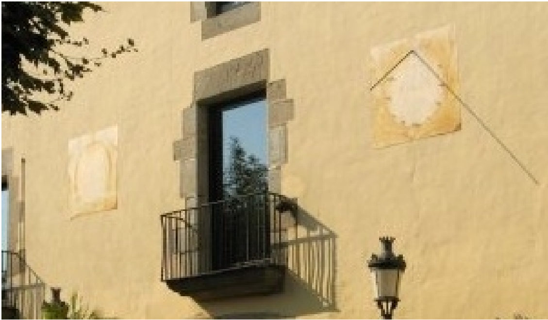
La decoración ha desaparecido. El reloj izquierdo ha perdido la varilla.
