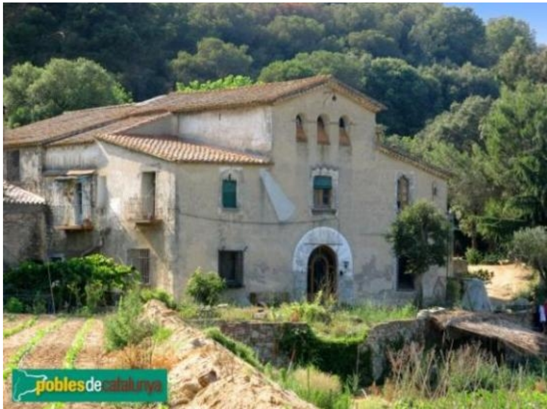
Can Calopa o Can Bramona. Argentona. (Foto: Albert Esteves, 2007)
