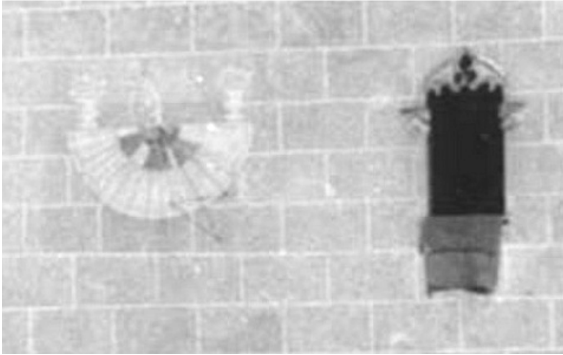
Semicircular con dos jarrones y una palmera en el remate. Varilla acodada. Tiene más líneas horarias a la mañana que a la tarde, sin embargo la varilla corresponde a un reloj declinante a poniente.
