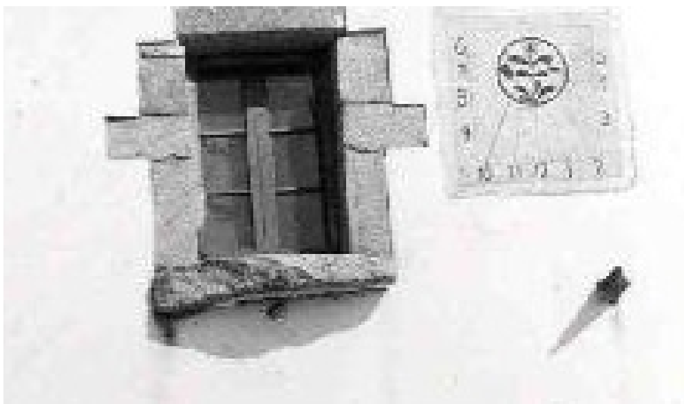
Cuadrado. Círculo distribuidor decorado con plantas. VDL. Horas en números arábigos, de 6 de la mañana a 5 de la tarde. Líneas de medias horas. Varilla de un apoyo.
