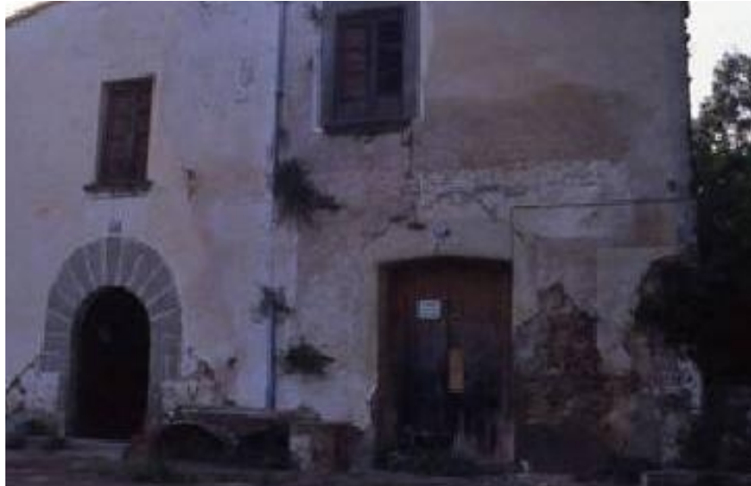
Can Cabot. Argentona. Maresme. DIBA Mapes de Patrimoni Cultural 08009/303.
