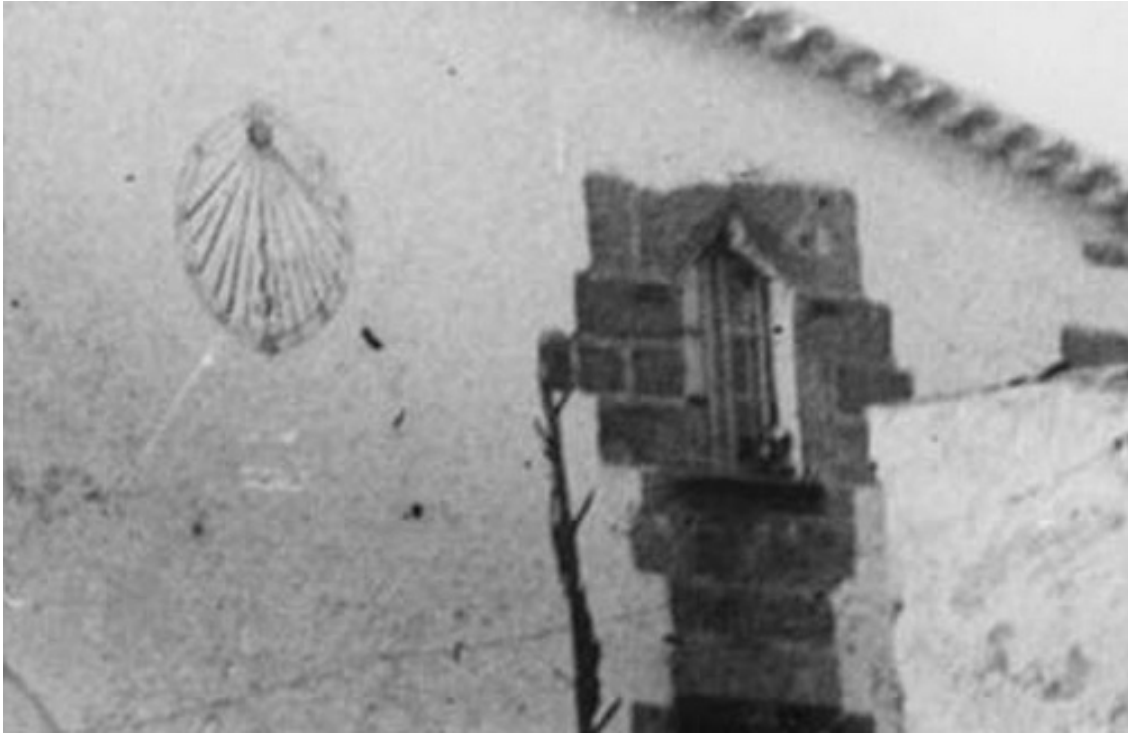
Ovalado. VDP. Numerado en arábigos. Líneas de medias horas. Campanilla en el extremo de la línea de mediodía. Varilla de un apoyo.
