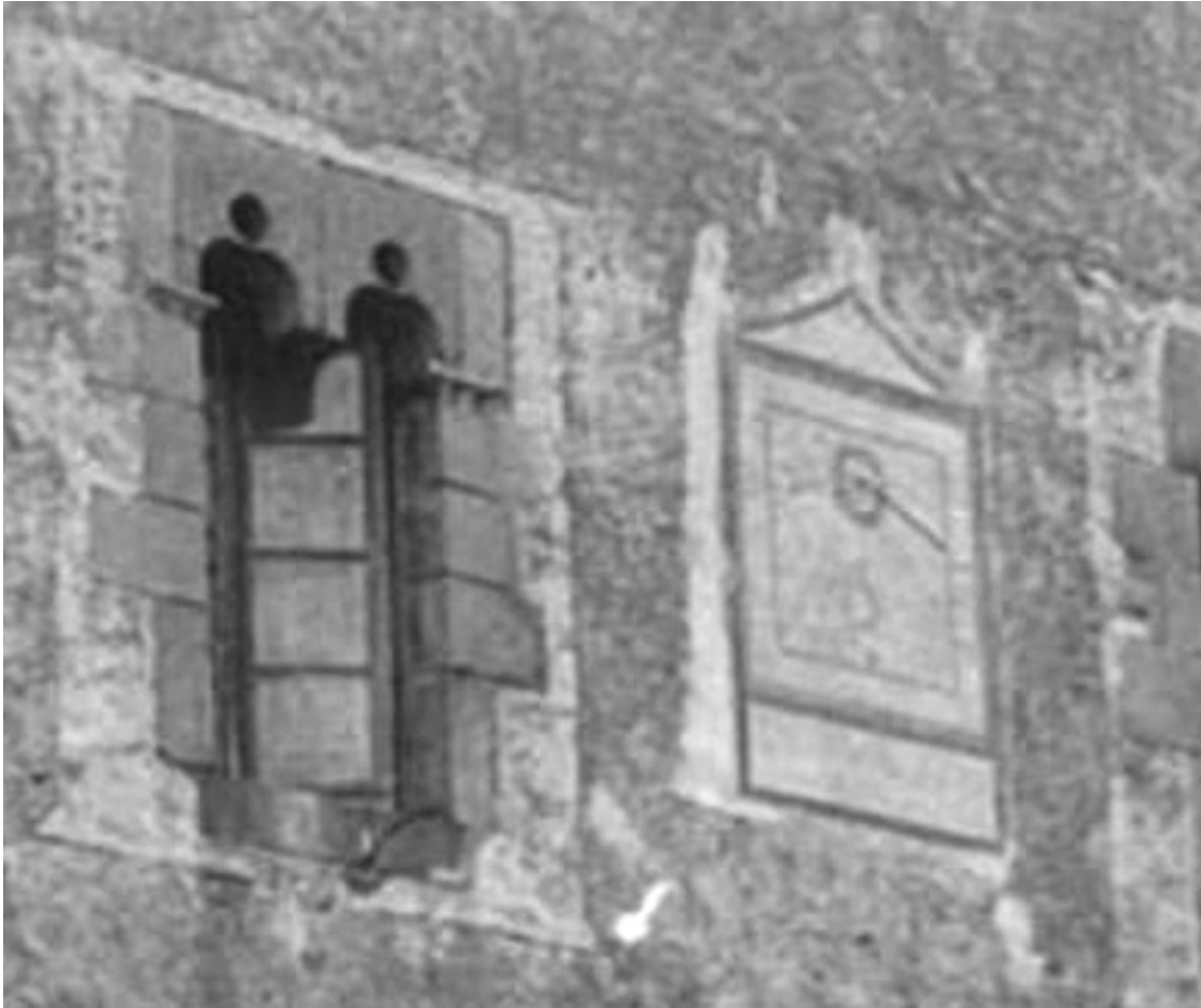
Rectangular, cartela en la base (¿inscripción?) y frontón triangular. Varilla de un apoyo.
