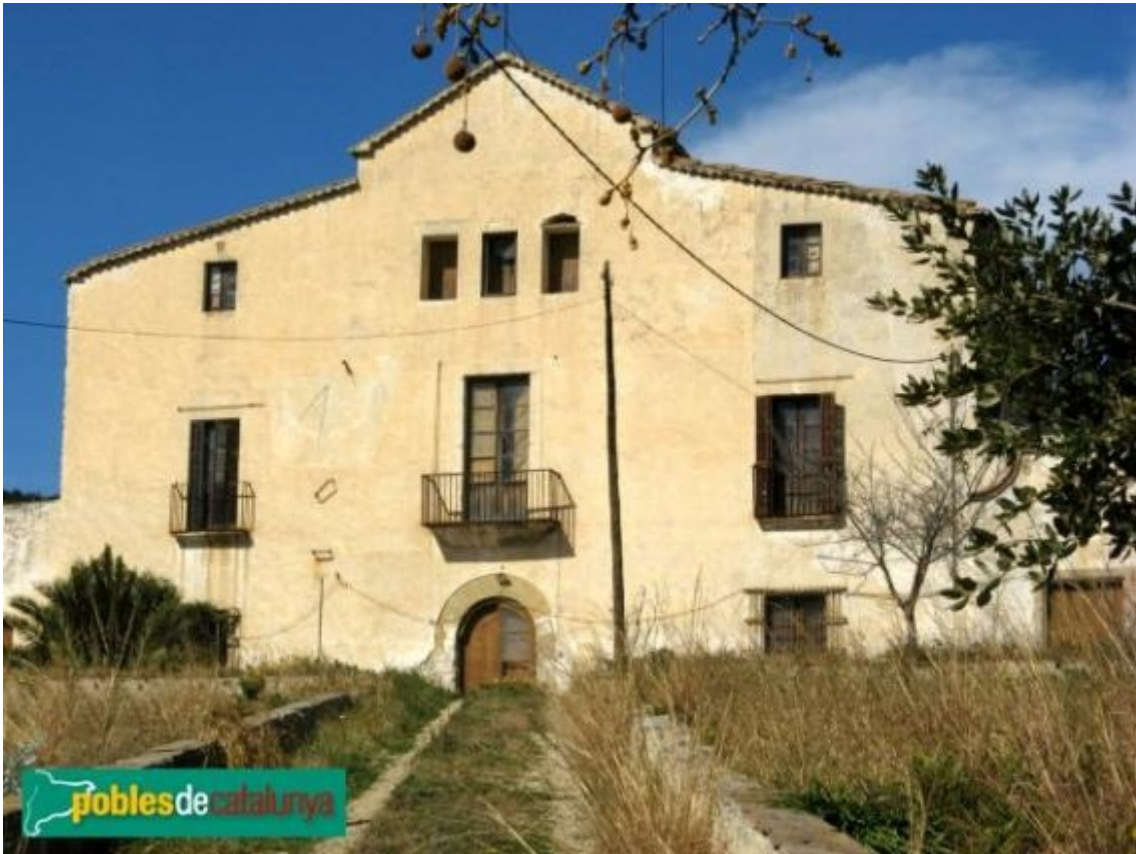
Can Torredá o Can Matas de Dalt. Tiana. Maresme. Albert Esteves 2007.
