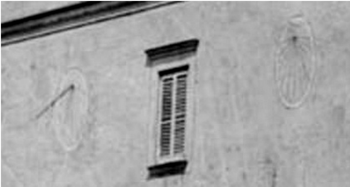
Pareja de relojes ovalados clónicos. El reloj de la derecha ha perdido la varilla.
