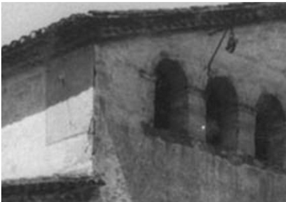
Reloj doble. Cuadrante declinante a poniente. Varilla de un apoyo.
