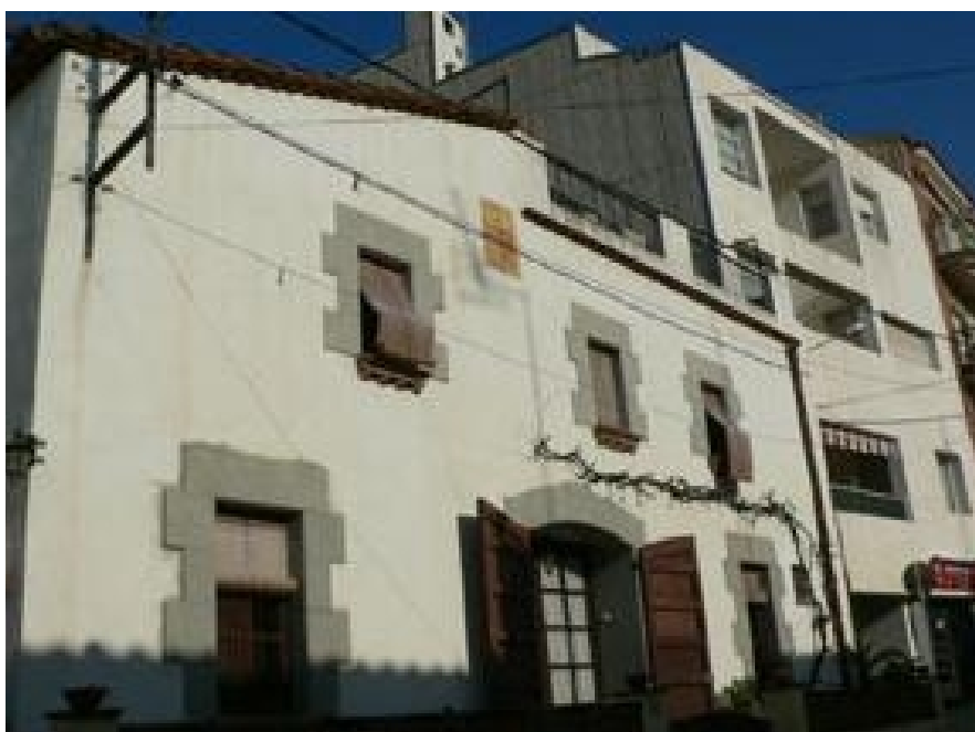
Can Popa. Arenys de Munt. Maresme. DIBA Mapes de Patrimoni Cultural 08007/91
