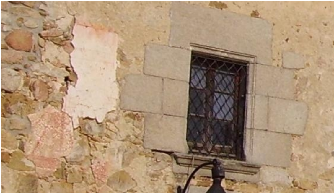
Solamente quedaba en el año 2009 parte de la superficie rectangular enlucida, la esquina superior derecha del marco y algunas líneas pintadas de almagre.
