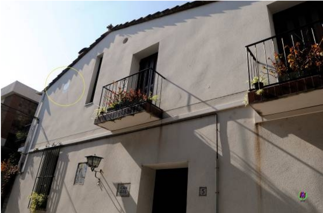
Situación del reloj de sol en la segunda planta de Can Gil.
