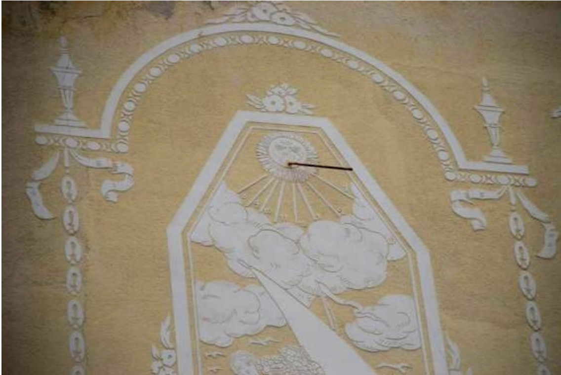
Reloj de sol decorativo. No está bien trazado. Varilla mal orientada.
