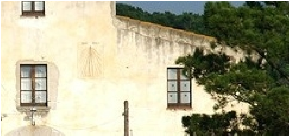
Situado a la derecha de la ventana central de la primera planta. Ovalado en el interior de un rectángulo. Inscripción en la parte de arriba.
