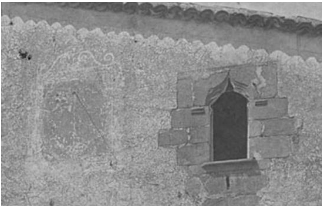
Circular en el interior de un rectángulo, marco decorativo y dos eses en el frontón. Vertical declinante a poniente. Varilla de un apoyo.
