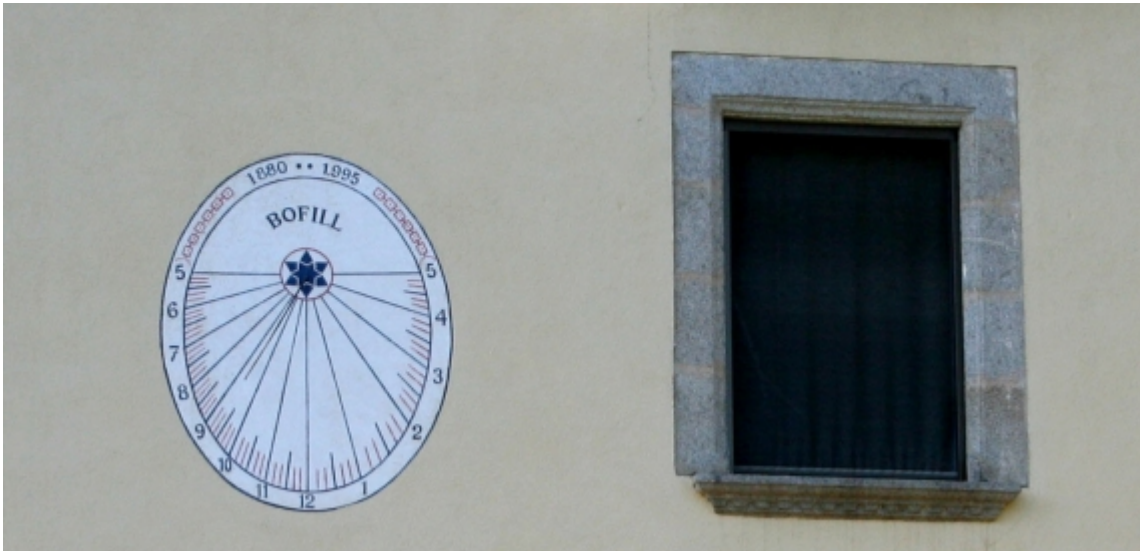
Ovalado. Estrella de seis puntas decorando el polo. VDL. Horas en números arábigos, de 5 de la mañana a 5 de la tarde. Marcas de diez minutos. Varilla de un apoyo. Inscripción de fecha: 1880-1995.
