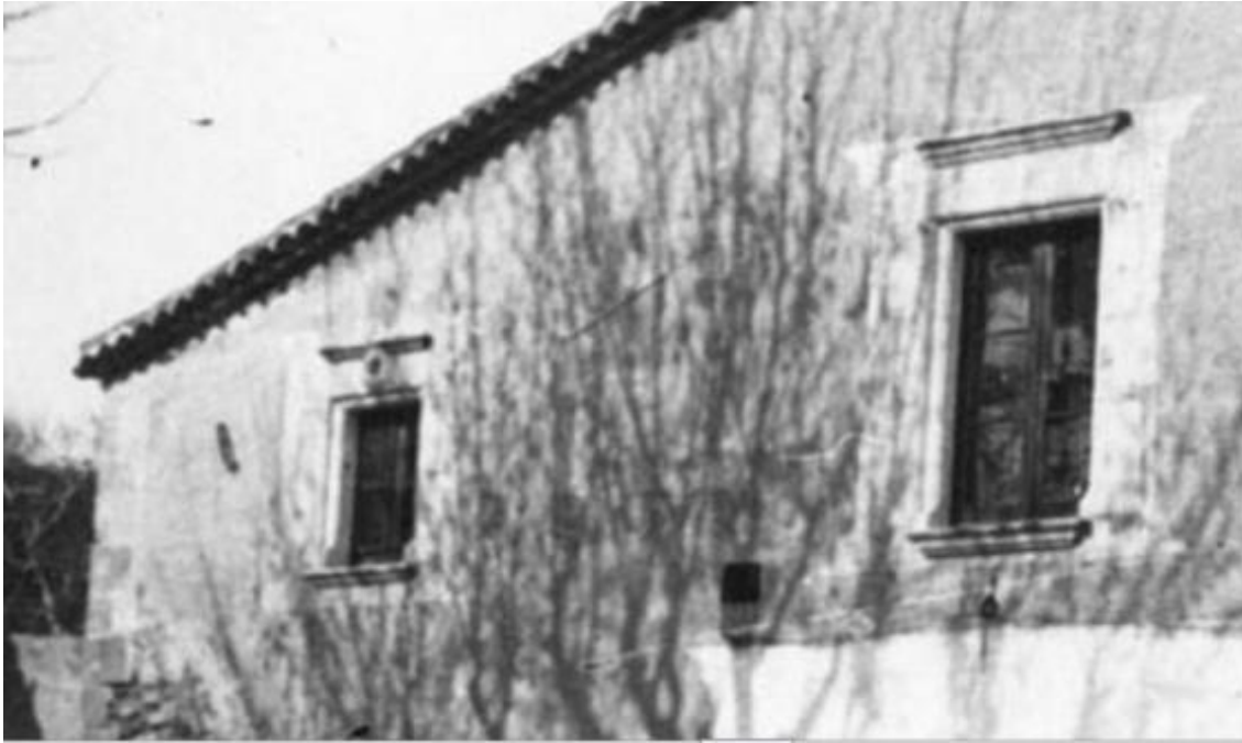
Solamente se distingue la varilla entre la sombra de las ramas del árbol en la fachada.
