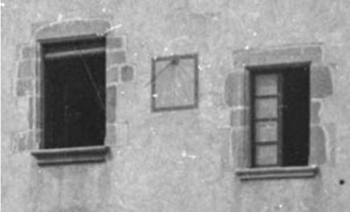
Cuadrado. Vertical declinante a levante. Varilla de un apoyo.
