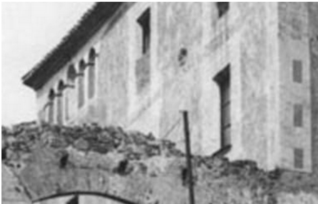
Varilla de un apoyo asomando por encima del arco de la puerta.
