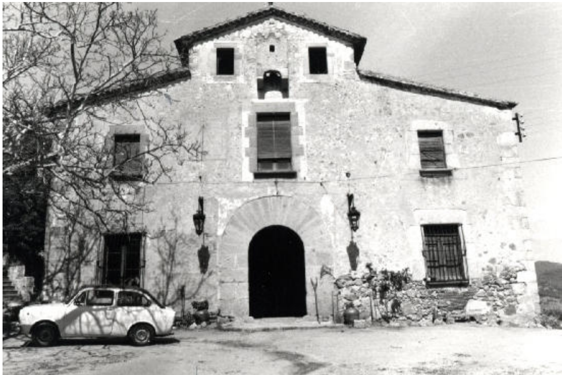
Can Coix. Argentona. Maresme. PATRIMONI.GENCAT J. Subirachs.
