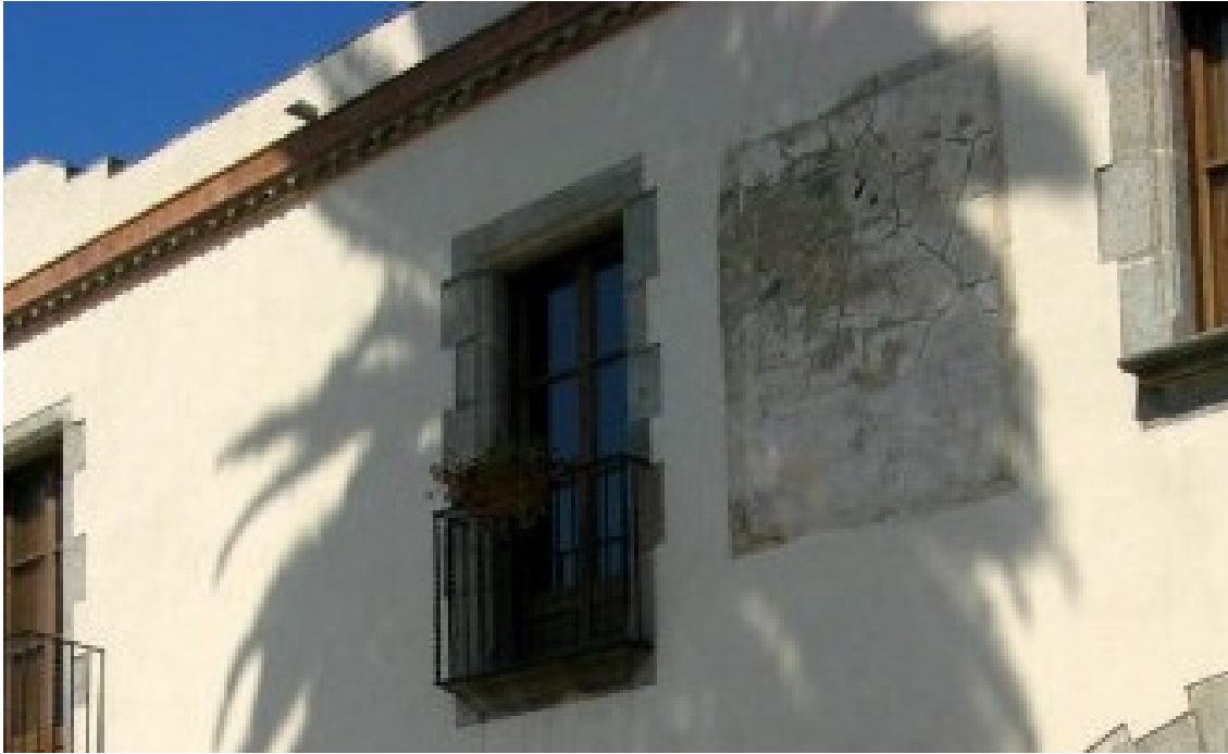
Se ha rehabilitado la masía. Se inauguró ssin reloj de sol en enero de 2014.
