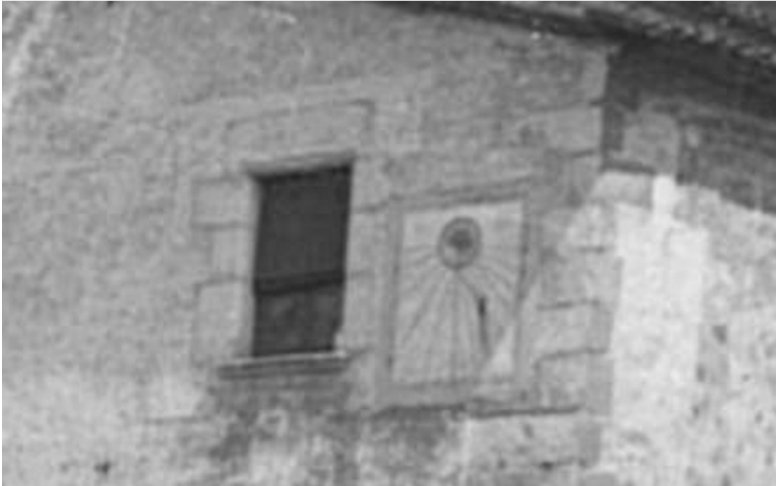
Rectangular vertical. Vertical declinante a poniente. ¿Doble?
