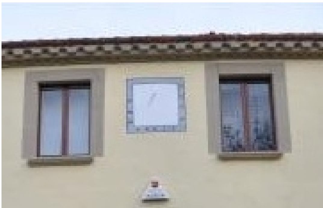
Reloj de sol pintado de azul y blanco situado entre las dos ventanas del primer piso. Cuadrado. VDL. Numerado en romanos. varilla de un apoyo.
