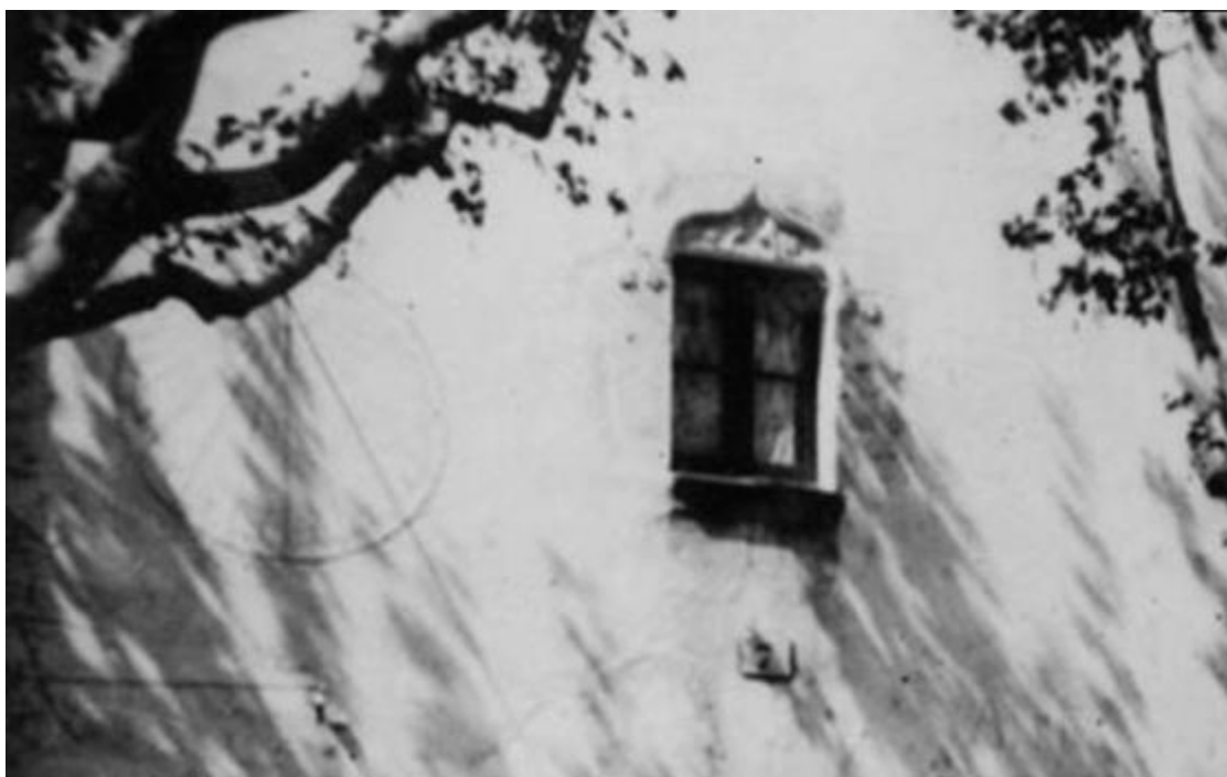
Circular. Varilla de un apoyo. VDP. Fechado en 1873.
