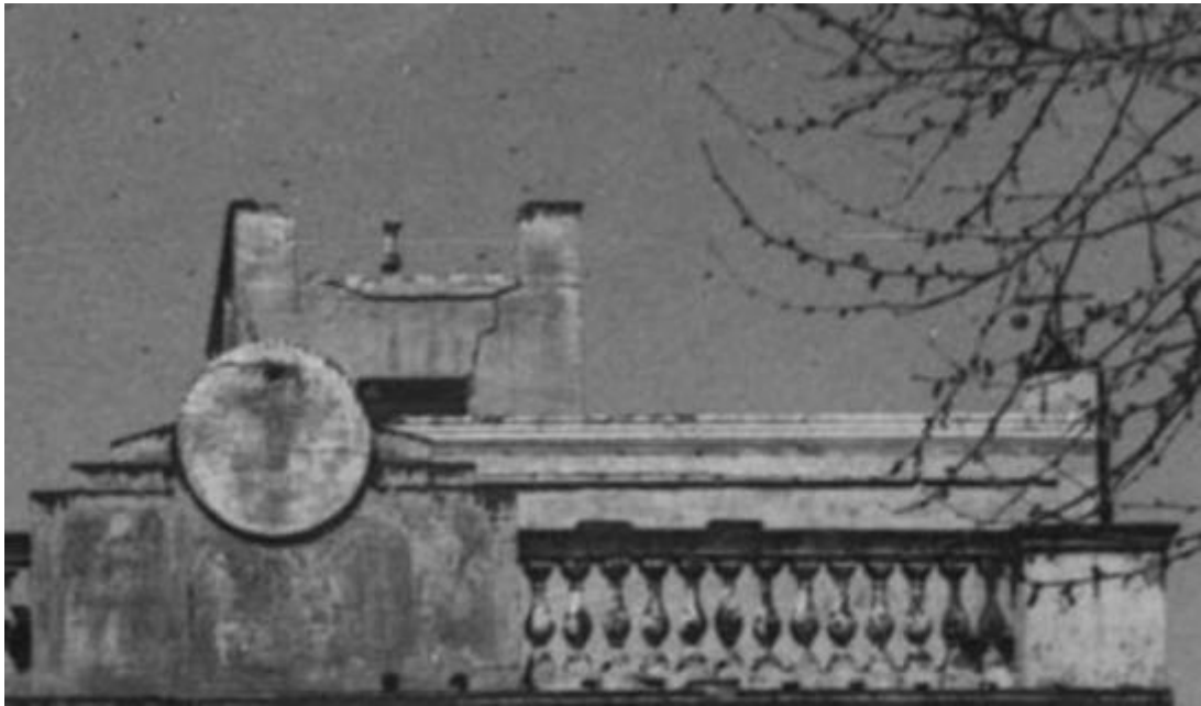
Circular. Varilla de un apoyo desaparecida.
