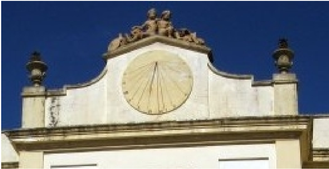
Circular. Vertical declinante a levante. Números romanos. Varilla de un apoyo.
