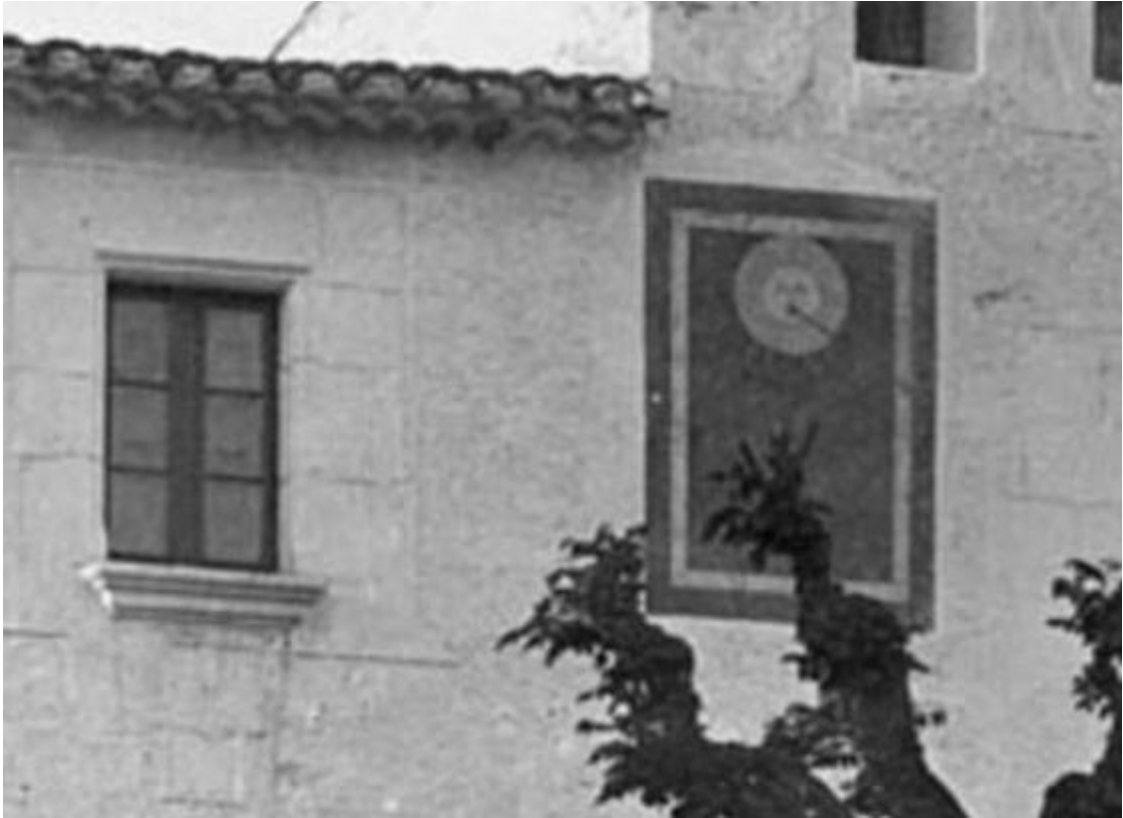
Rectangular. Vertical declinante a poniente. Varilla de un apoyo.
