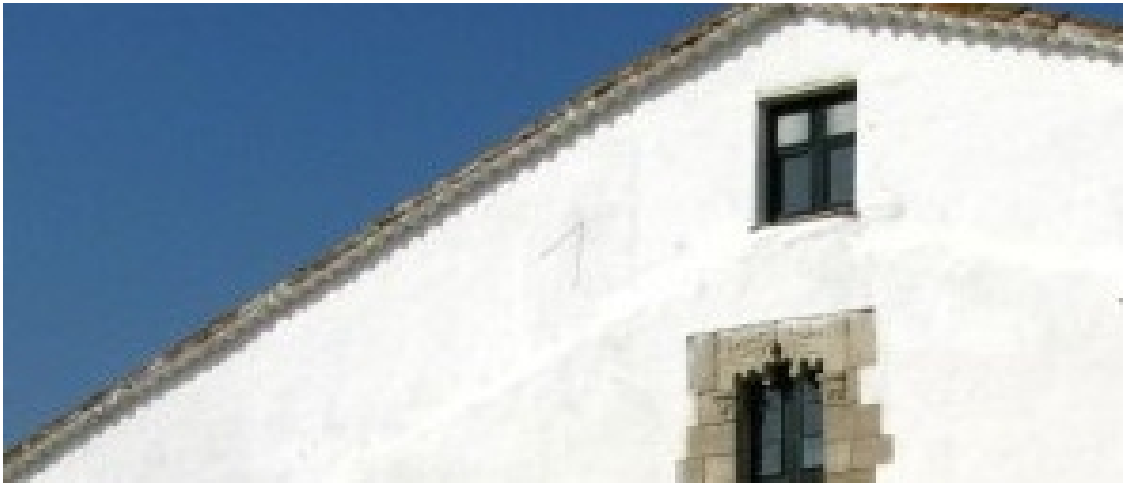
Han blanqueado el reloj de sol. Queda la varilla.
