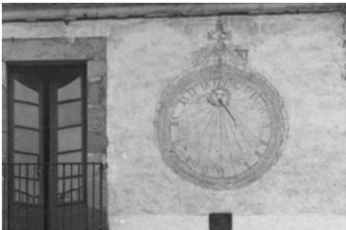
Circular con remate decorativo. Vertical declinante a poniente. Varilla de un apoyo.
