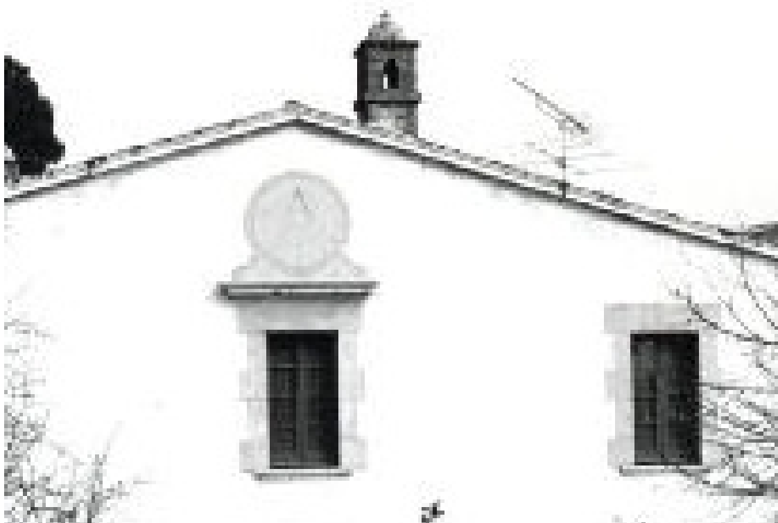
Circular sobre basa. Varilla de un apoyo.
