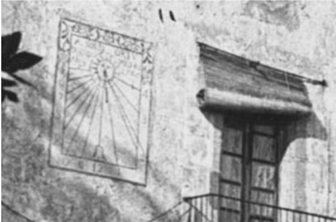
Rectangular. Vertical declinante a levante. Horas en arábigos de 5 a 4. Campanita del Ángelus. Varilla de un apoyo. Inscripción: A SOLIS ORTV...
