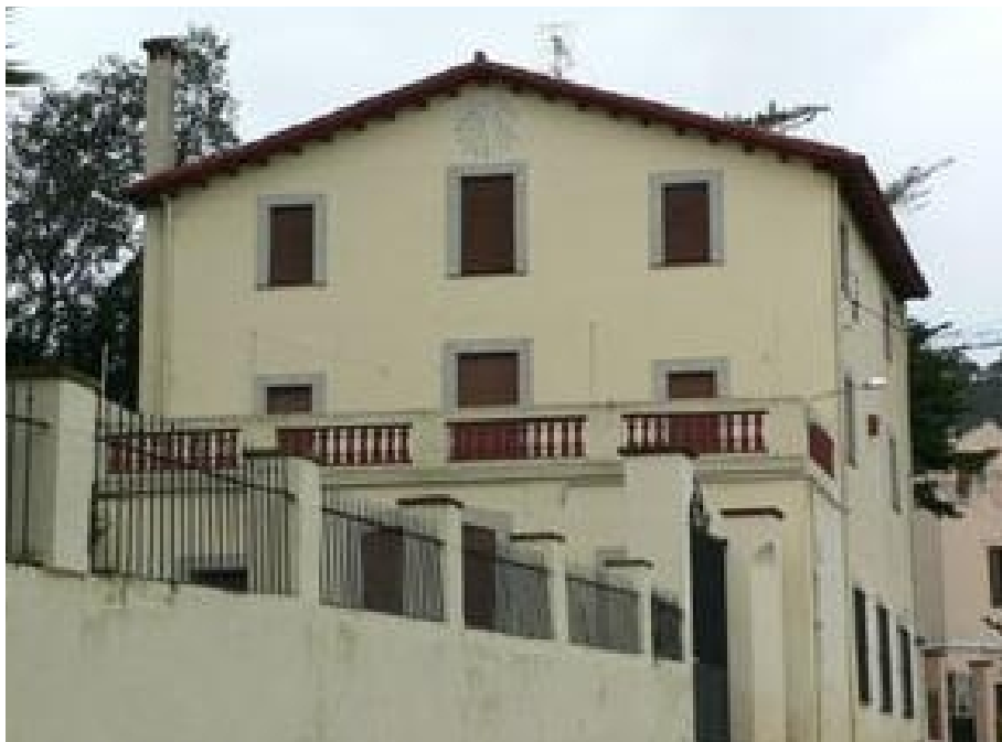
Can Mas Sardá. Arenys de Munt. Maresme. DIBA Mapes de Patrimoni Cultural 08007/78
