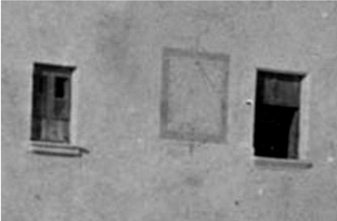
Rectangular. Vertical declinante a poniente. Varilla de un apoyo.
