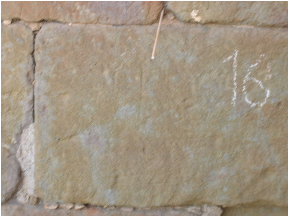
Reloj 16. Radial en junta de tres sillares.
