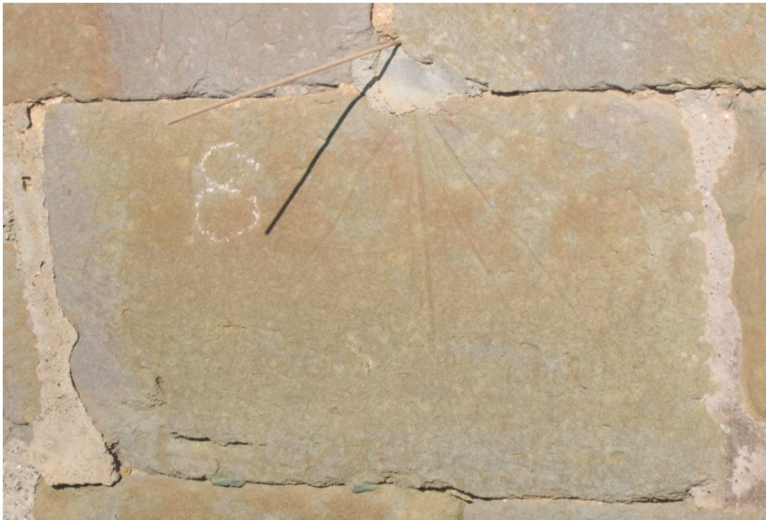
Reloj 8. Radial en junta de tres sillares. Líneas añadidas. Junta tapada.
