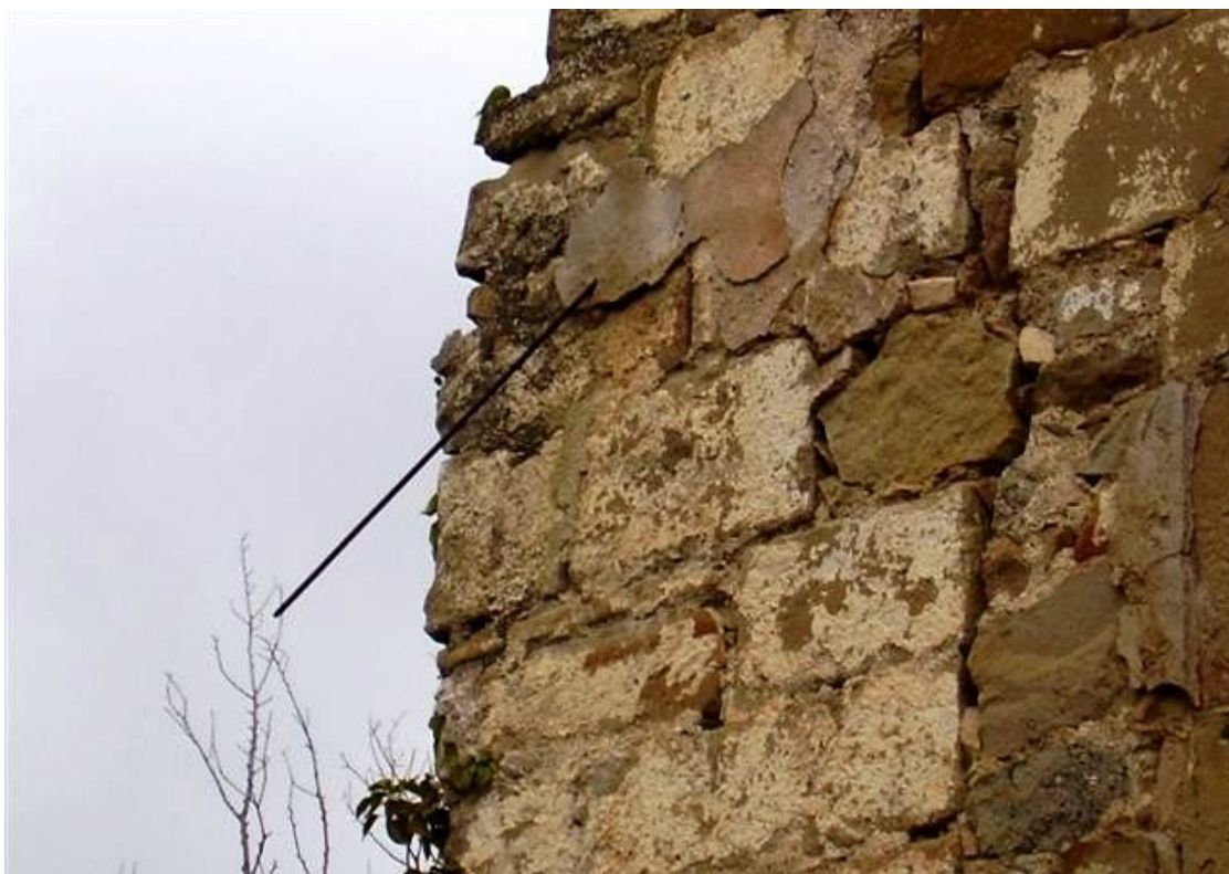
Solo queda la varilla de un apoyo, y junto al polo una pequeña parte de la superficie enlucida sobre los sillares de la esquina izquierda de la fachada principal de la casa. VDL. A la vuelta de la esquina pudo estar el reloj complementario.
