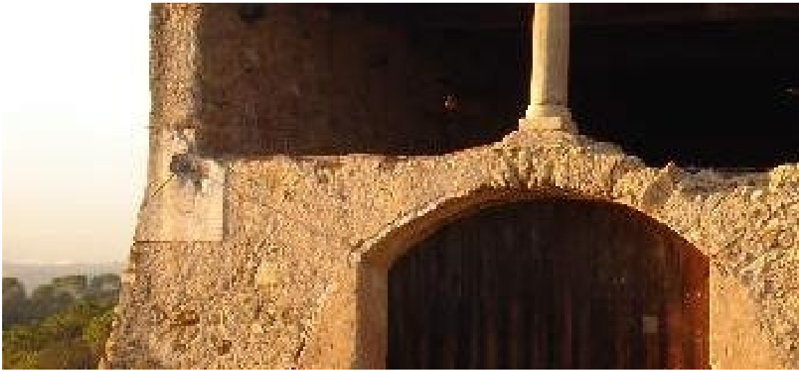
Cuadrante declinante a levante del reloj de sol doble. Varilla de un apoyo.
