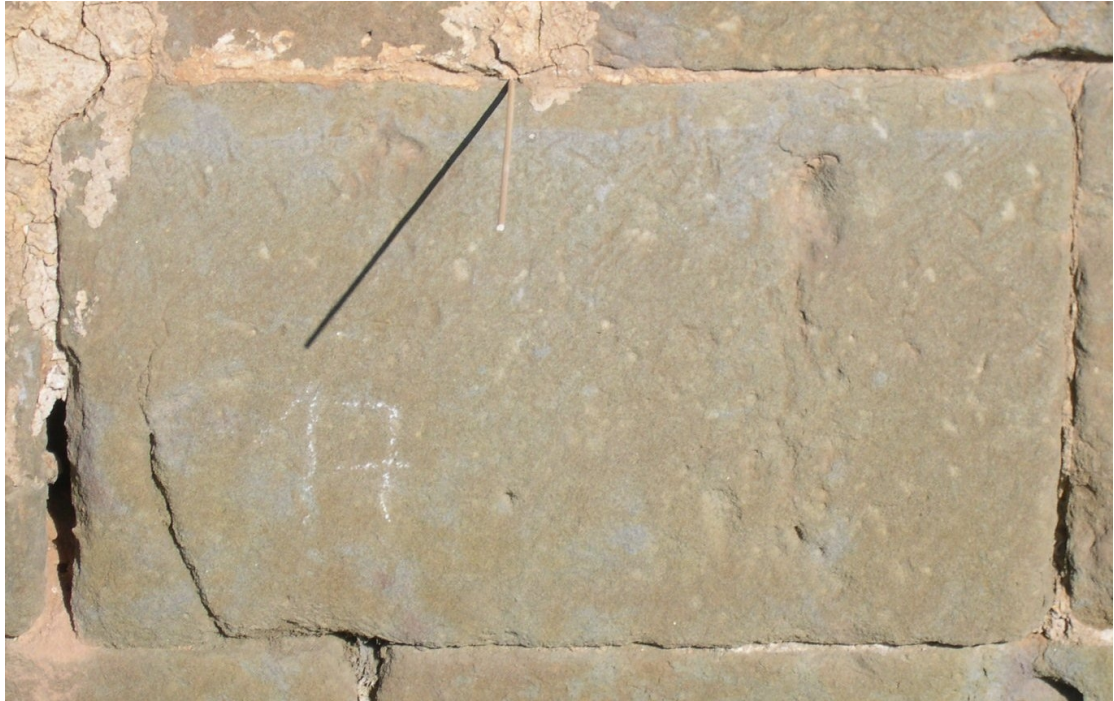
Reloj 17. Radial en junta de tres sillares.
