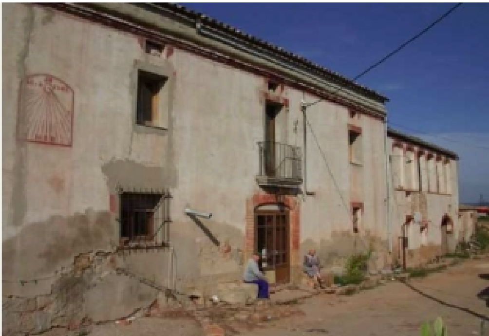
Cal Garrell. Òdena. Anoia. Òdena. Anoia. DIBA Mapes de Patrimoni Cultural 08143/110.
