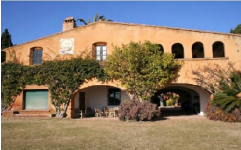
9. Mas del Sol-.Blanes. La Selva. Bosc de Sant Francesc. Destaca un rellotge de sol a la primera planta de la façana sud.
