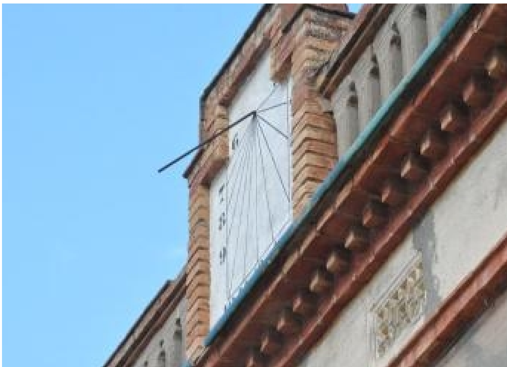
Rectangular pintado de negro sobre fondo blanco. Mal trazado: la línea de las 6 de la mañana y la de las 5 de la tarde están sobre la horizontal que pasa por el polo. Línea de las doce girada hacia la izquierda. Números arábigos. Varilla de un apoyo.
