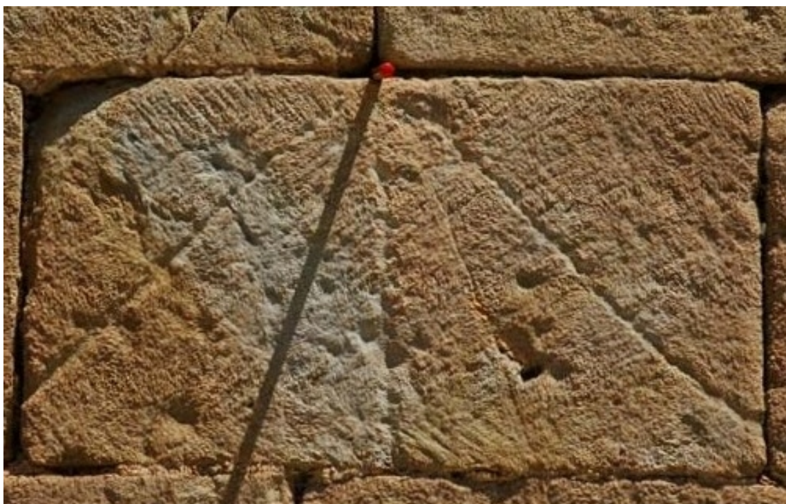
Canónico radial de tres líneas en junta de tres sillares. Línea media para Nona.
