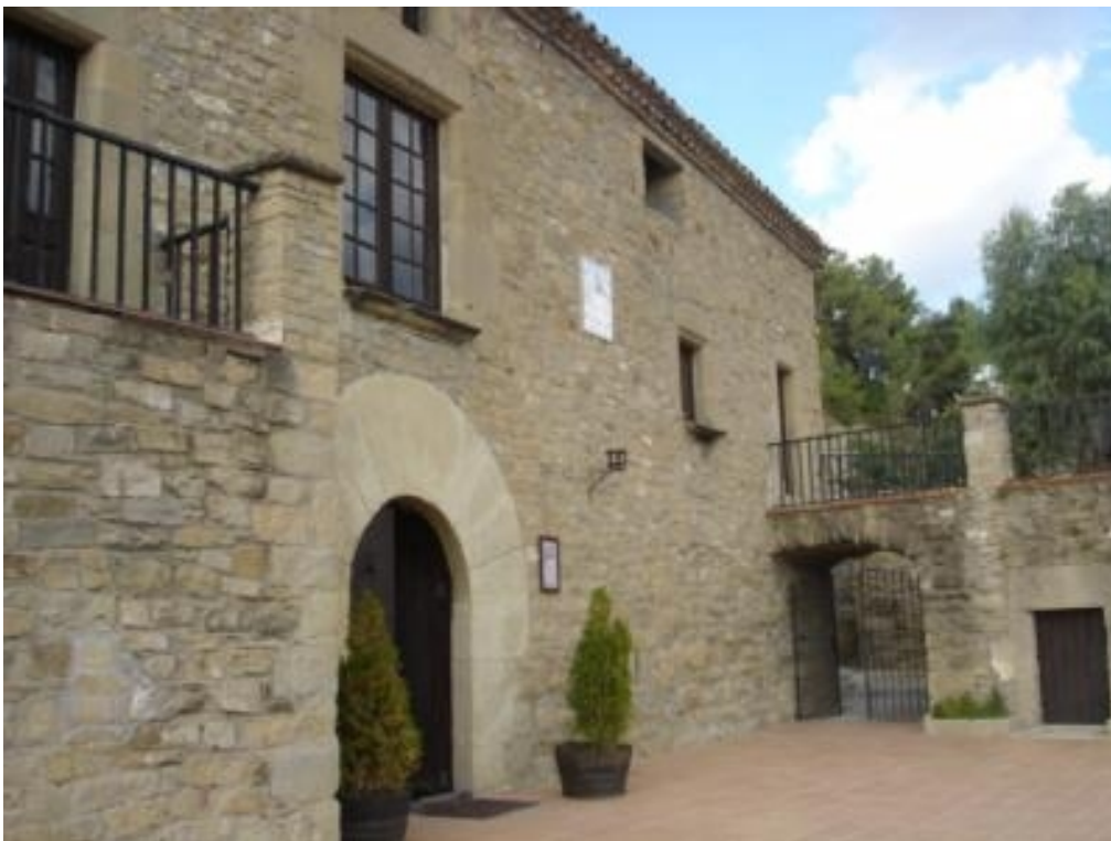
Mas el Cingle. Talamanca. Bages. DIBA Mapes de Patrimoni Cultural 08277/48.
