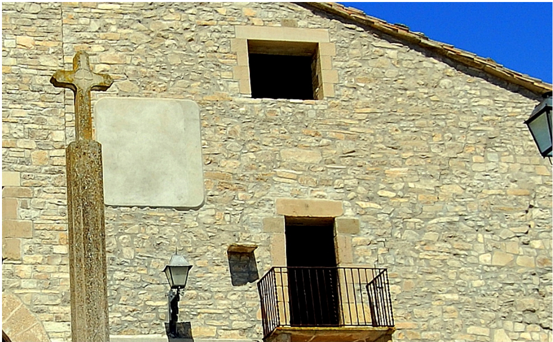
Superficie enlucida de cemento preparada para construir un reloj de sol.
