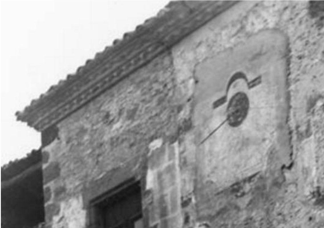
Rectangular rematado en frontón semicircular, con las esquinas cortadas en cuarto de círculo. VDL. Varilla de un apoyo.
