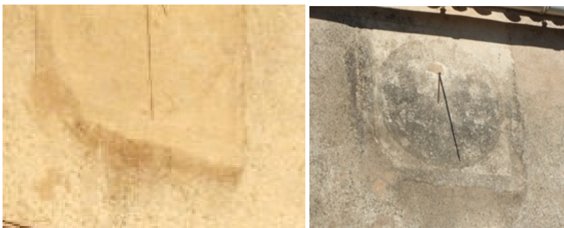
Circular en el interior de un rectángulo. Varilla de un apoyo.
