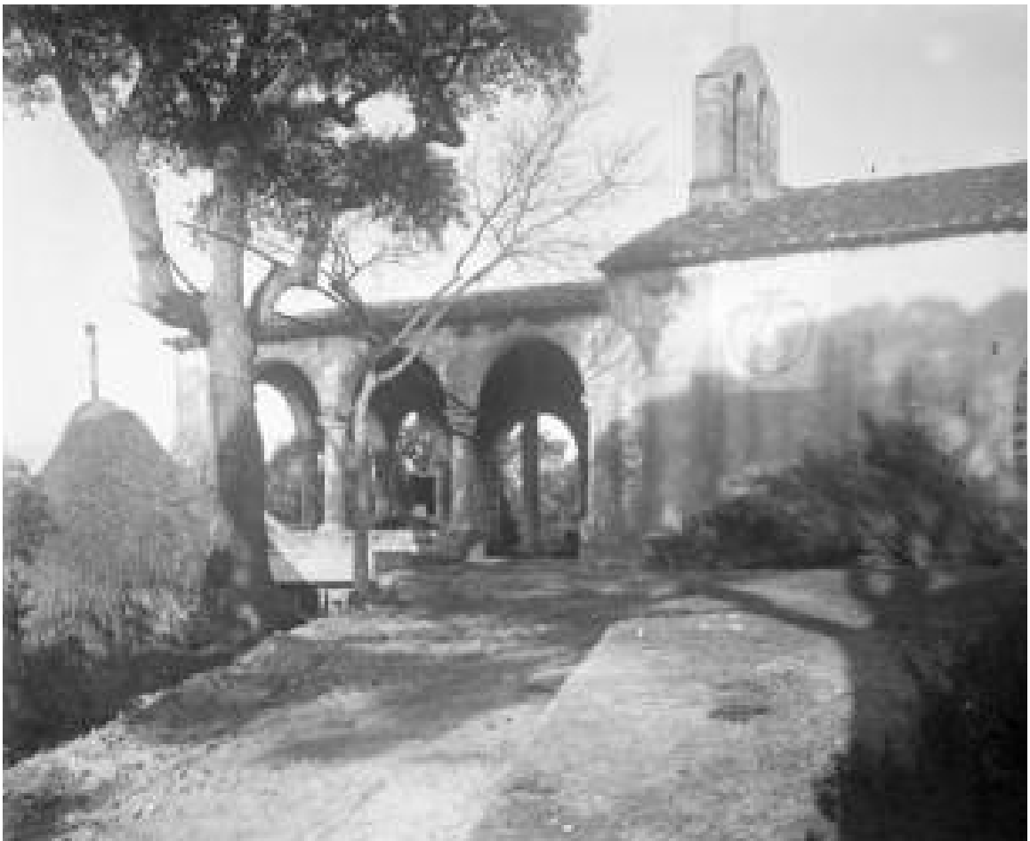
Ermita de la Mare de Dèu de la Serra. Montnegre. Fogars de la Selva. La Selva. AFCEC Rossend Flaquer i Barrera. 1924. R.
