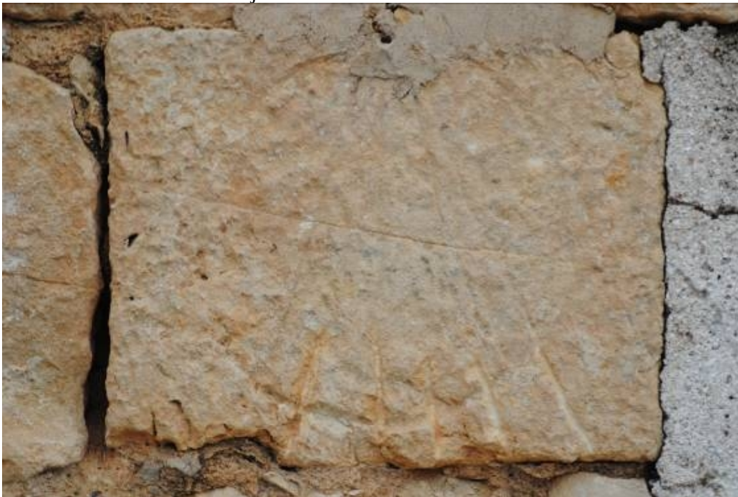
Reloj 2. Radial en junta de sillar.
