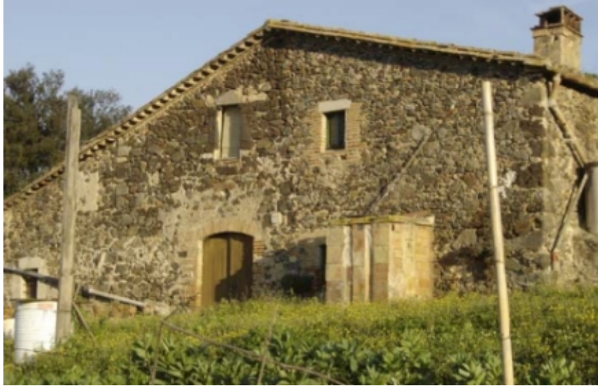
139. Can Puig. Vilobí d'Onyar. Rellotge de sol a la façana principal.
