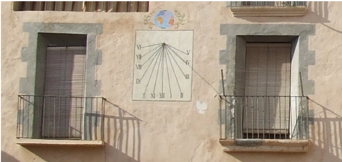
Radial en el interior de un rectángulo blanco pintado entre los dos balcones de la segunda planta. Encima lleva un globo terráqueo entre dos ramas. VDL. Horas en números romanos de VI de la mañana a V de la tarde, escritos en los extremos de las líneas horarias. Varilla de un apoyo.
