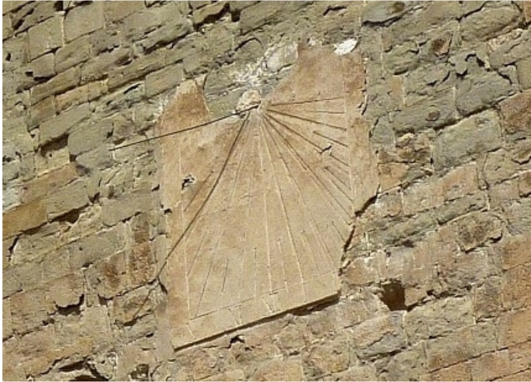
Superficie cuadrada enlucida sobre el muro de sillarejo. Desprendimientos laterales. Vertical declinante a poniente. Horas en números romanos. Líneas horarias corregidas. Medias horas. Varilla de un apoyo mal orientada.
