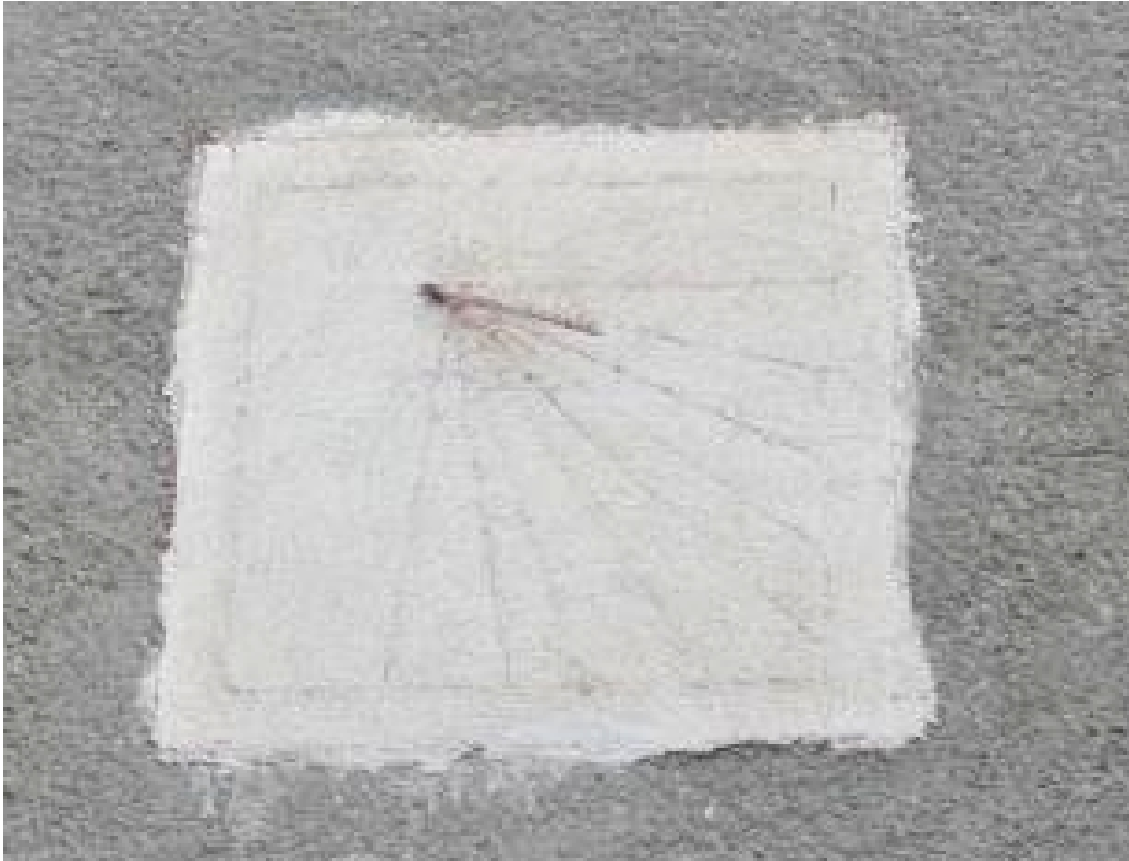
Rectangular. Grabado sin pintar sobre fondo blanco. Polo desplazado hacia la izquierda. La línea de mediodía no es vertical. Las líneas horarias no convergen en el polo. Mal trazado. Varilla de un apoyo.
