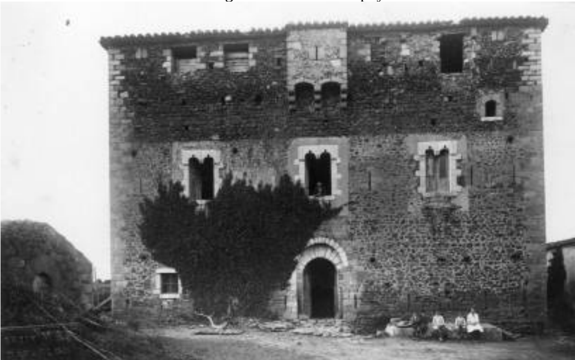
Torre Marata. Maçanet de la Selva. La Selva. AFCEC 1890-1918.
