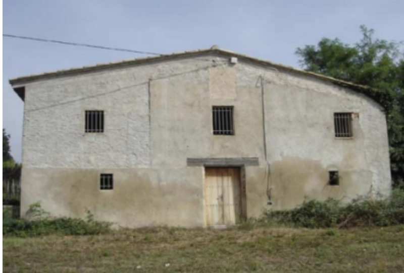
151. Can Batlló. Sant Dalmai. Rellotge de sol a la façana principal.
