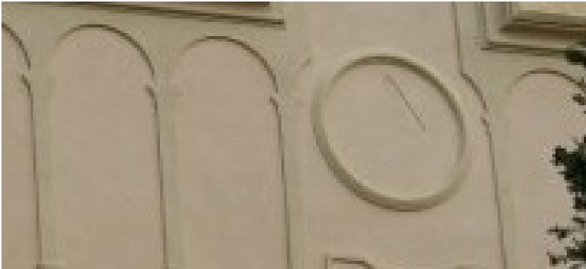
Circular demarco oldurado. Sin traza ni numeración. Varilla de un apoyo.
