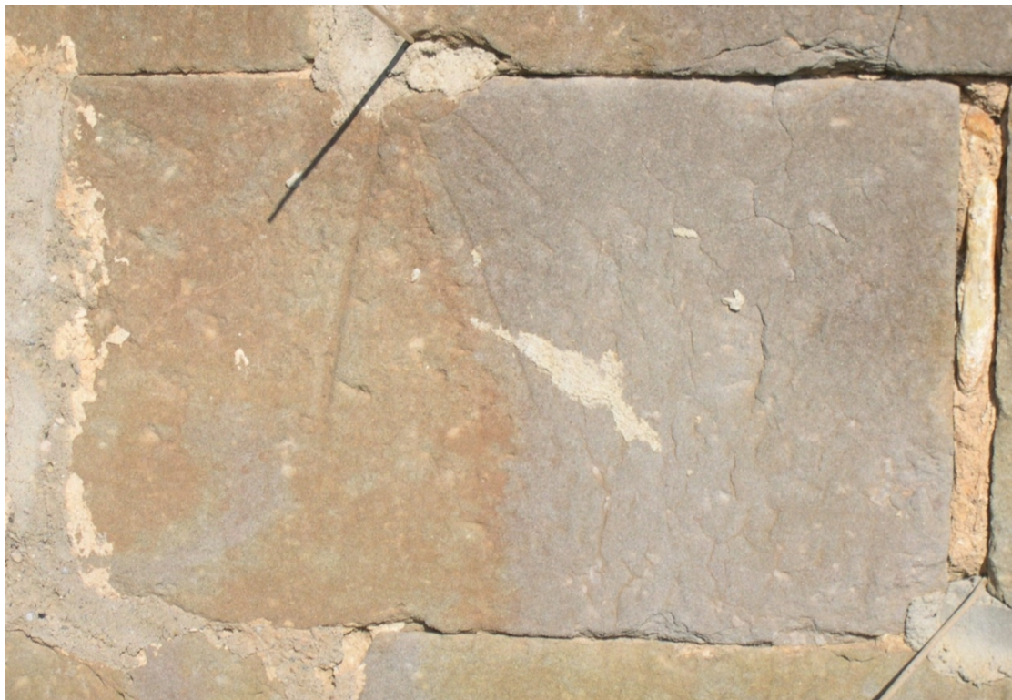
Reloj 9. Radial en junta de tres sillares. Junta tapada.
