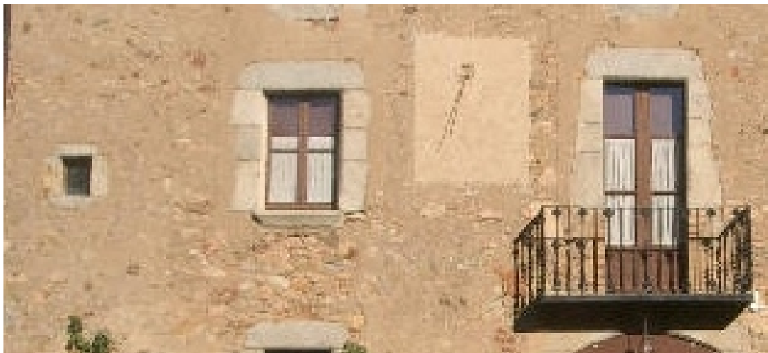
Rectangular vertical. VDL. Varilla de un apoyo.
