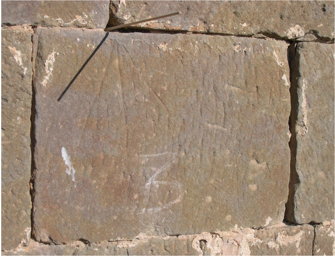
Reloj 3. Radial de tres líneas en junta de 3 sillares.
