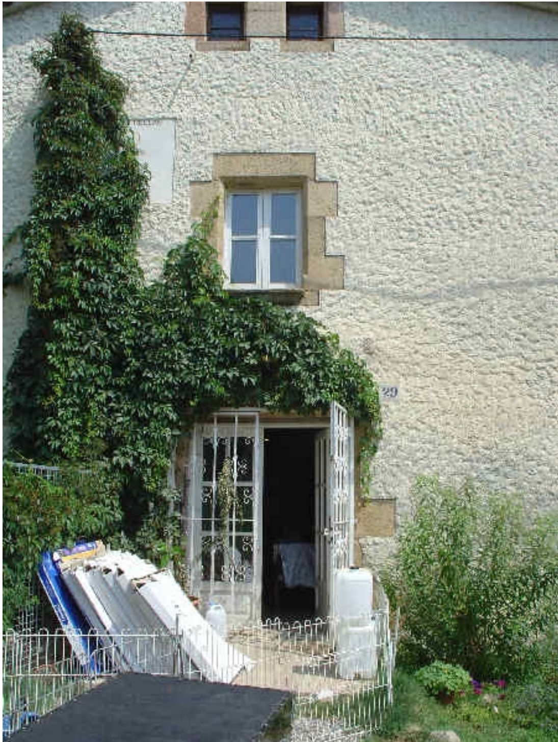
Can Torrelles. Riudarenes. La Selva. PATRIMONI.GENCAT I. Forts/M. Pibernat 2005.
