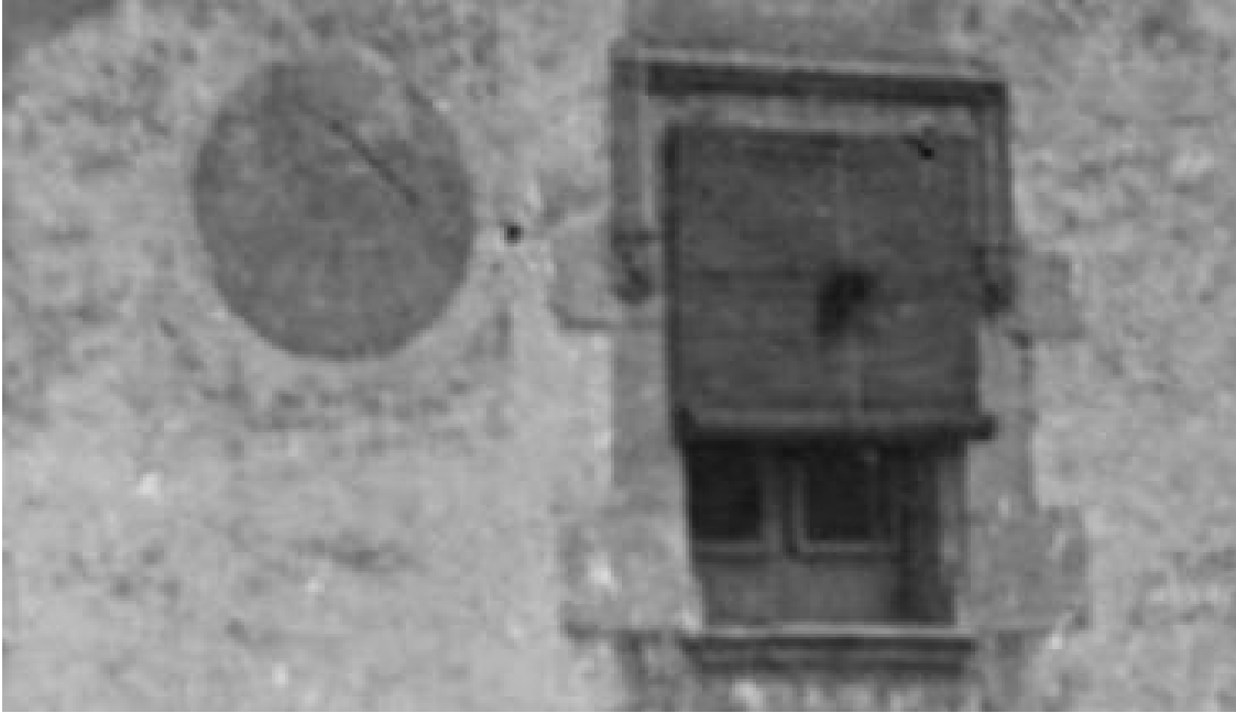
Circular. Varilla de un apoyo.
