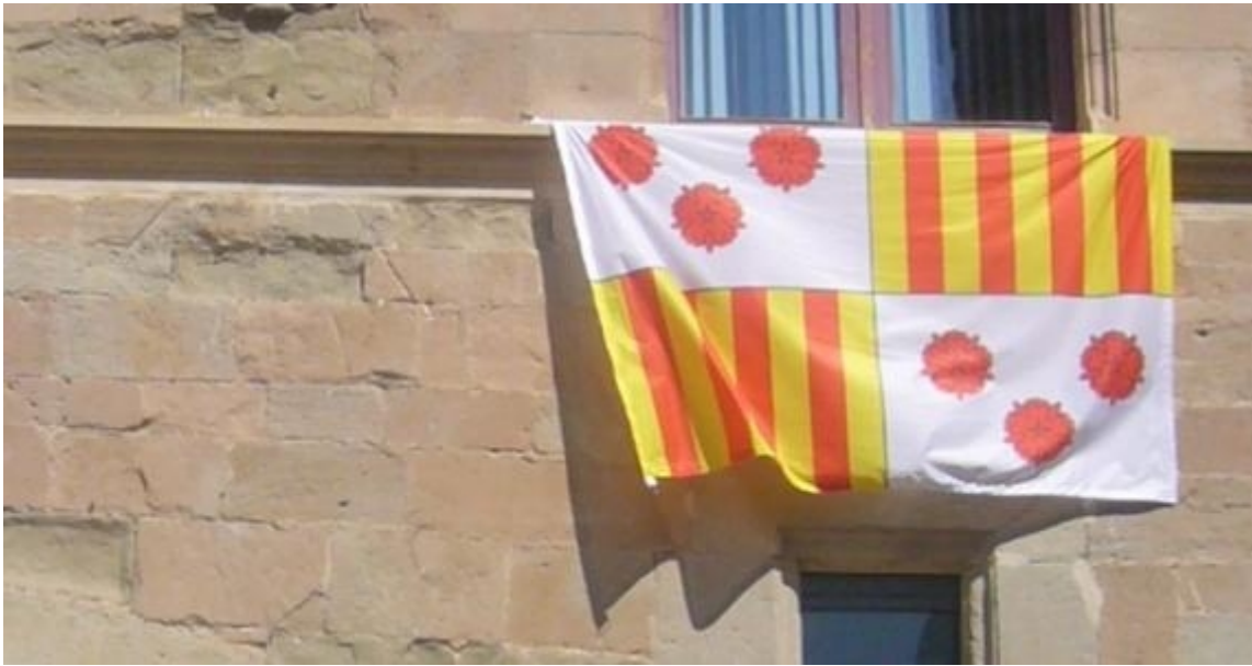
La varilla ha desaparecido. Se distinguen algunas líneas en los sillares. Se ha reconstruido el tramo de imposta que se picó al grabar el reloj de sol.
