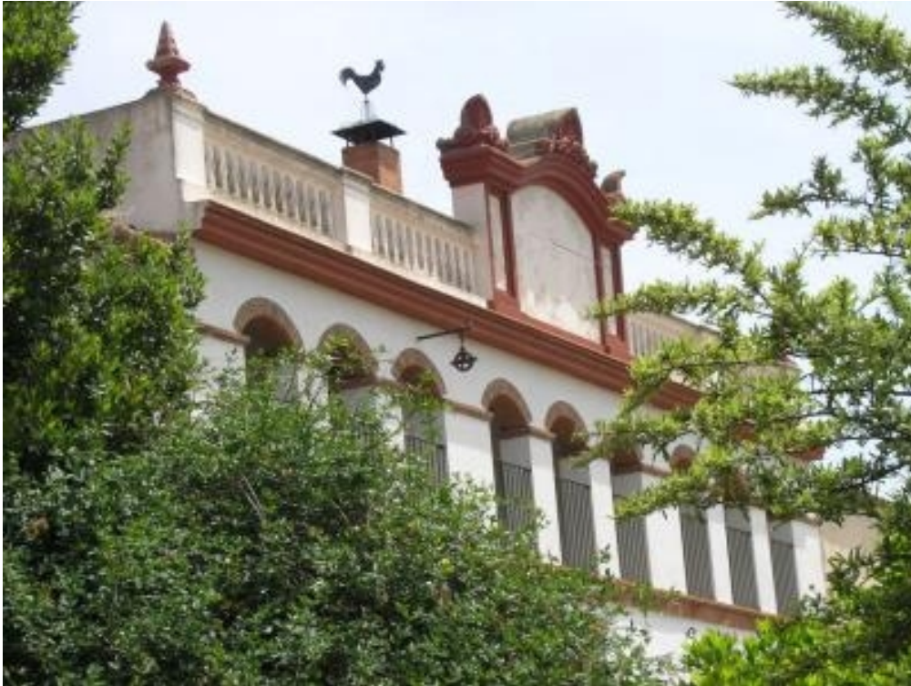
Can Vila. Les Hostalets de Pierola. Anoia. DIBA Mapes de Patrimoni Cultural 08162/48.
