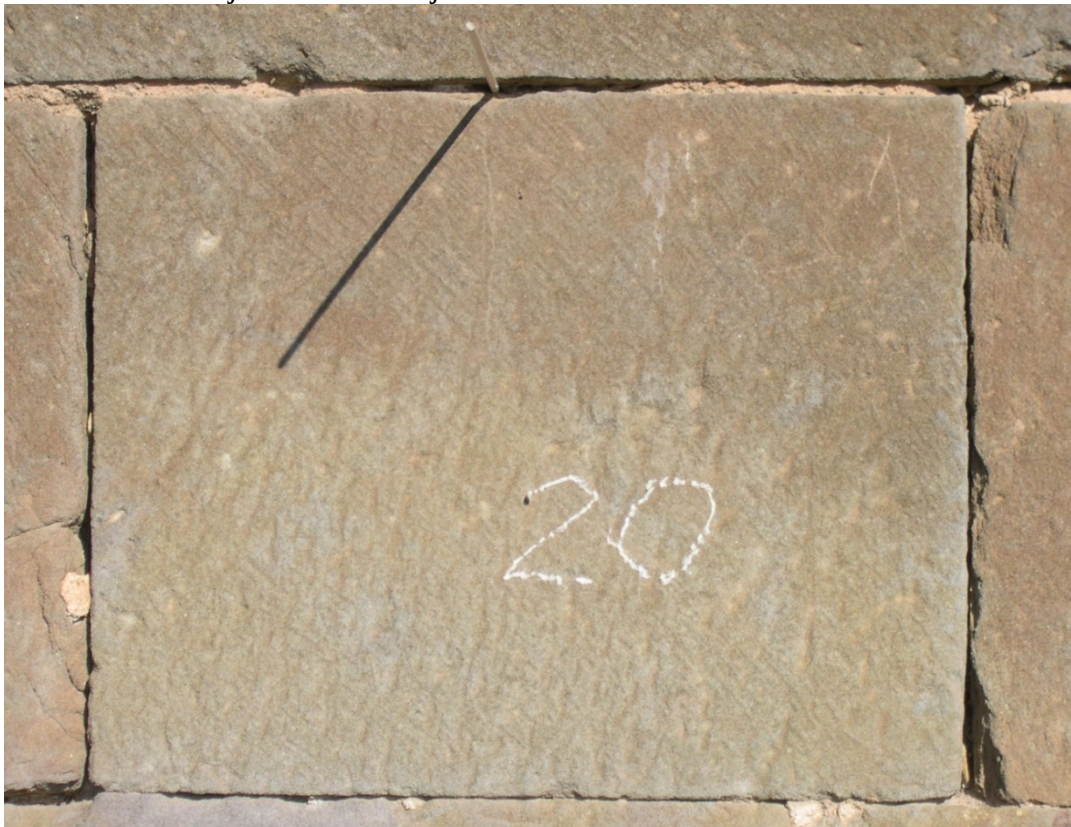
Reloj 20. Radial en junta de sillar.
