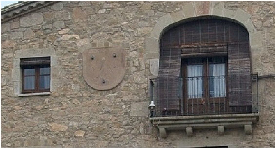
Forma de escudo. Marco de piedra rodeando la placa. Varilla de un apoyo.
