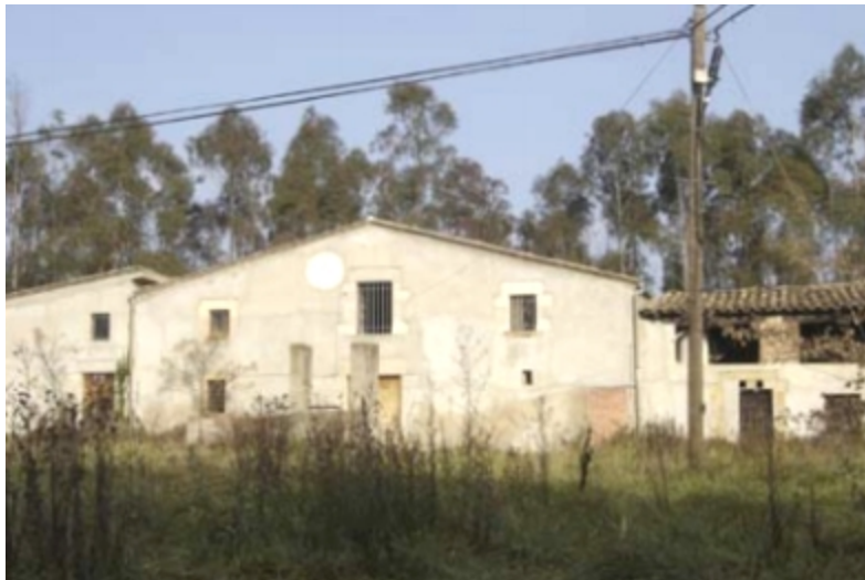
5. Can Rossinyol Gran. Sant Dalmai. Rellotge de sol a la façana principal.
