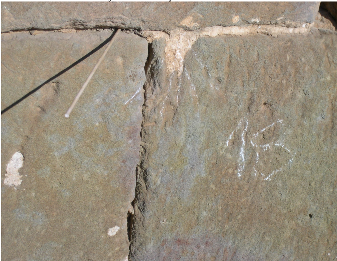
Reloj 18. Radial en junta de sillar.
