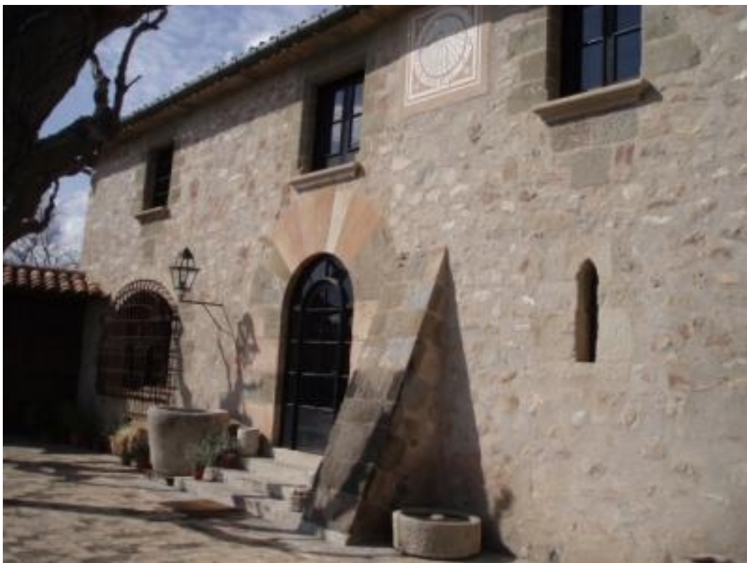
Cal Mateu. Santa Margarida de Montbui. Anoia. DIBA Mapes de Patrimoni Cultural 08250/59.
