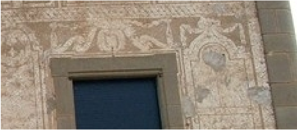
Situado a la derecha del balcón. Polo desplazado hacia la izquierda. Reloj de sol doble: cuadrante vertical declinante a poniente.
