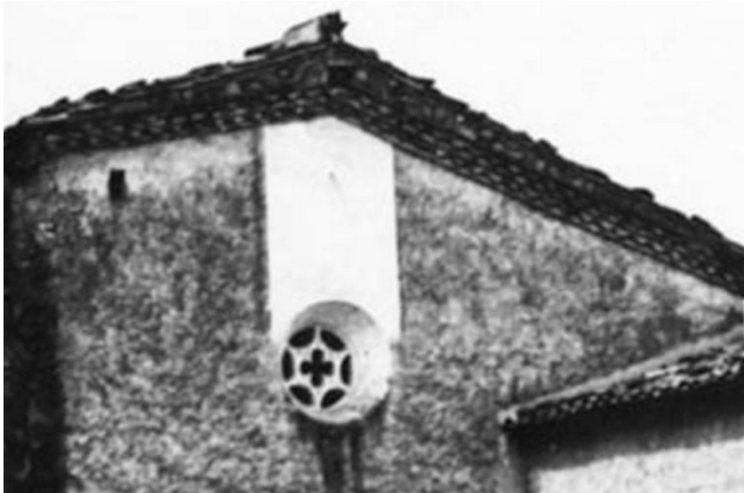
Rectangular con el lado inferior siguiendo el borde de la ventana circular y el superior el rafe del tejado. Varilla de un apoyo. Recién pintado...
