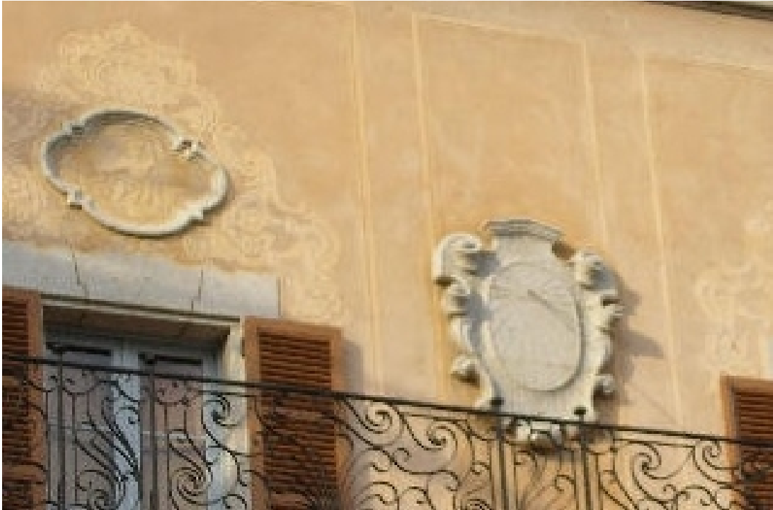
Ovalado. Piedra. Marco barroco. Vertical a mediodía. Varilla de un apoyo.
