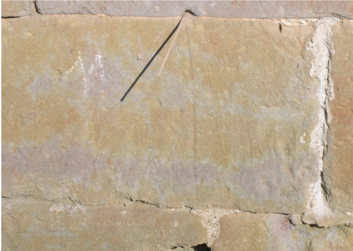
Reloj 11. Radial en junta de sillar. Línea de Sexta. Orificio en la junta.
