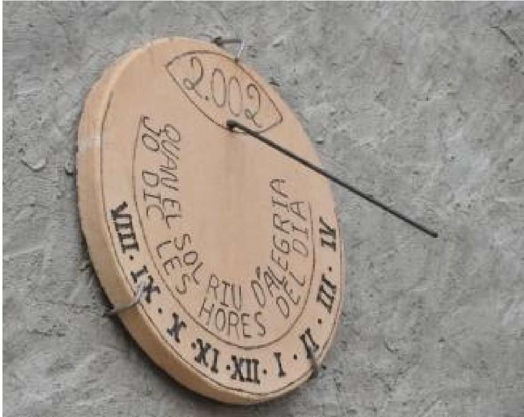
Placa de barro cocido. Varilla de un apoyo mal orientada. Leyenda siguiendo el borde del círculo interior: QUAN EL SOL RIU D'ALEGRIA, JO DIC LES HORES DEL DIA. Fechado en 2002.
