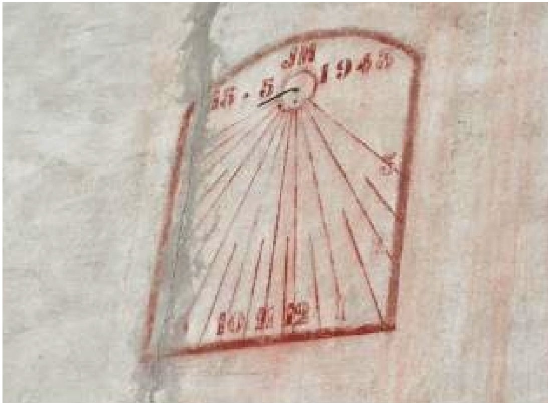
Pintado de almagre sobre el encalado en el extremo izquierdo de la fachada sur. Marco simple. Rectangular rematado en frontón curvo rebajado. Pequeño círculo distribuidor. VDL. Línea de las doce girada hacia la derecha. Marca de 6 a 3 con los números pintados sobre las líneas horarias. Varilla de un apoyo. Medias horas. Inscripción en el frontón: J. M. 15.5.1943. Autor: Josep Mussons.
