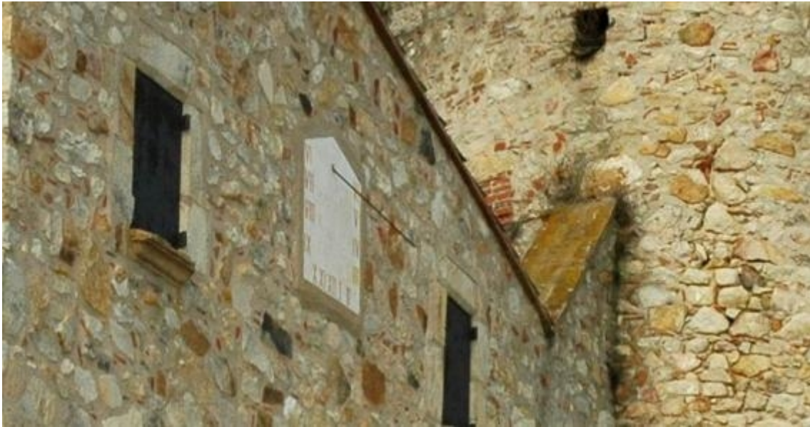
Rectangular rematado en frontón triangular. VM. Romanos de VI a VI. Varilla de un apoyo.
