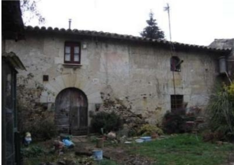
161. Casa Gran de can Pèlach. Sant Dalmai. Rellotge de sol a la façana principal.
