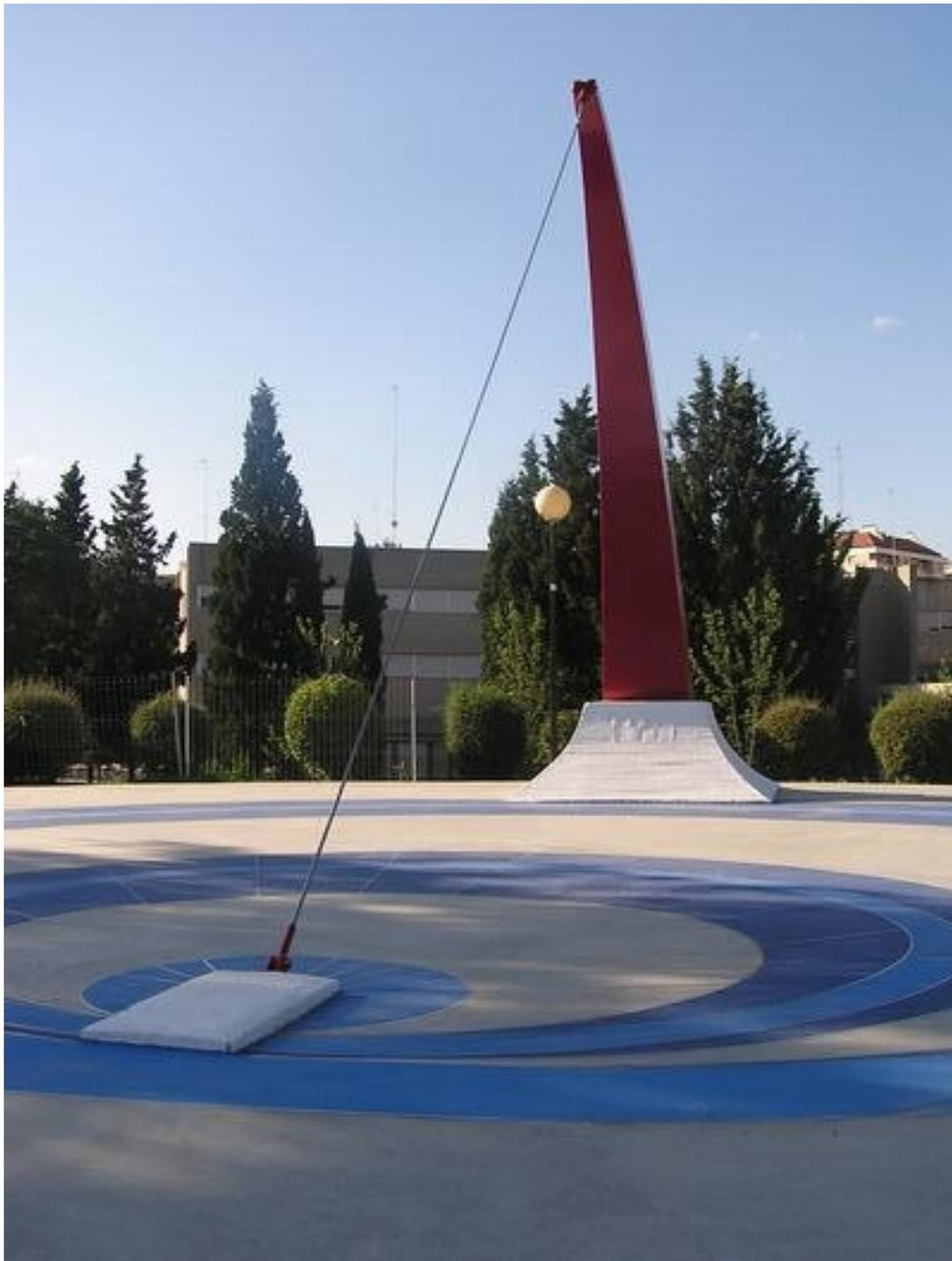
Construido en hierro y hormigón pintado en azules de distintos tonos. El gnomon es un cable sujeto a un mástil curvo de hierro que visto de lado simula medio arco con la cuerda tensada en posición de disparo. Numerado en romanos. Leyendas: “SAN JORGE”, “EL PILAR”.
