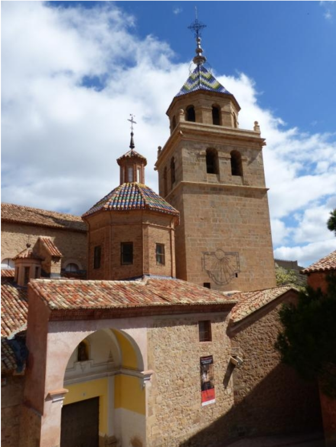
Situado en el costado sur del primer cuerpo de la torre.
