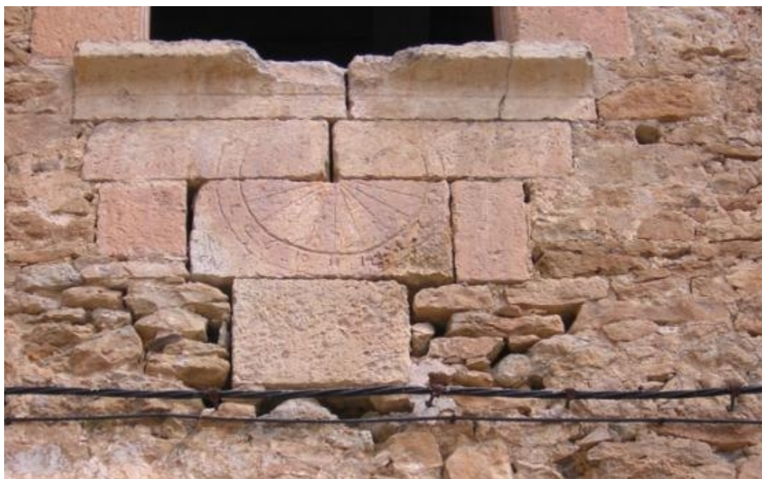
Grabado en los sillares, bajo la ventana izquierda de la primera planta.
