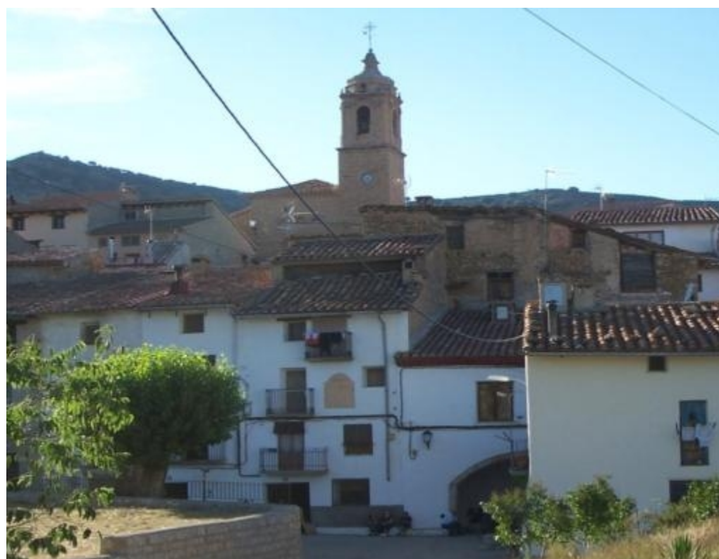
La casa del reloj de sol antes y después de la restauración.
