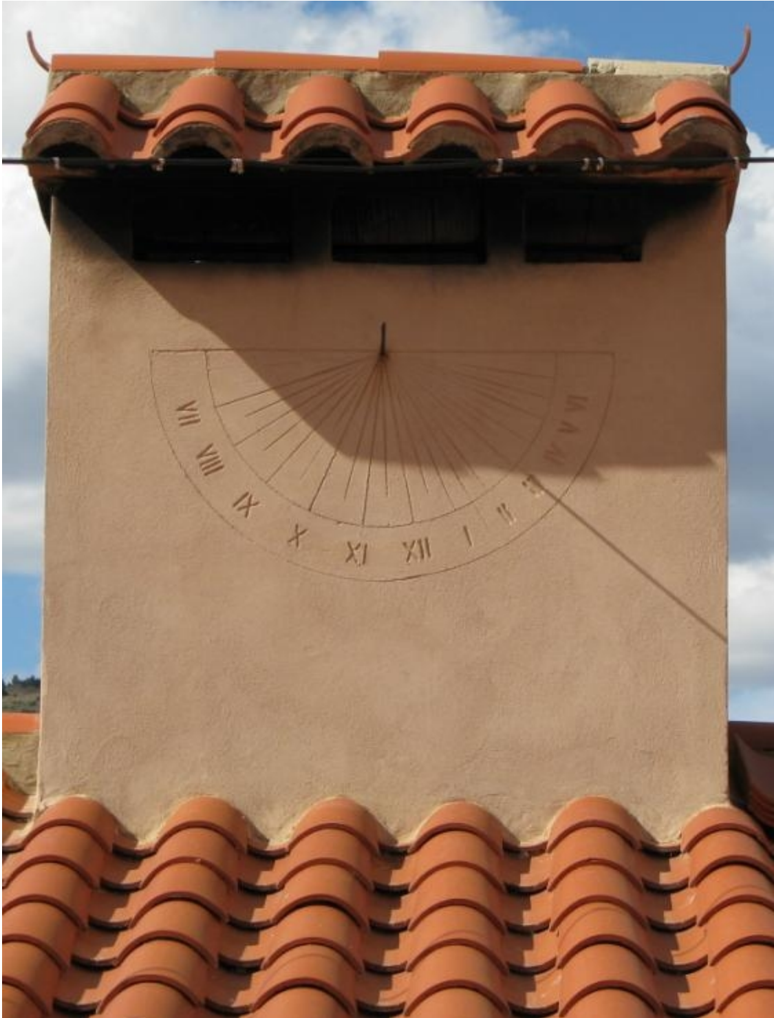
Reloj de sol decorativo. Meridiana desviada. La fachada declina a levante.
