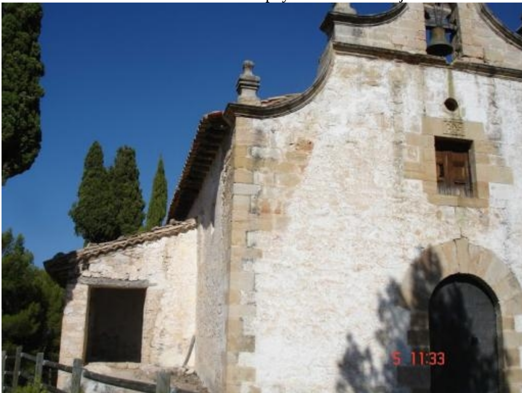
Grabado en el dintel de una ventana de la fachada sur, cerca del alero.
