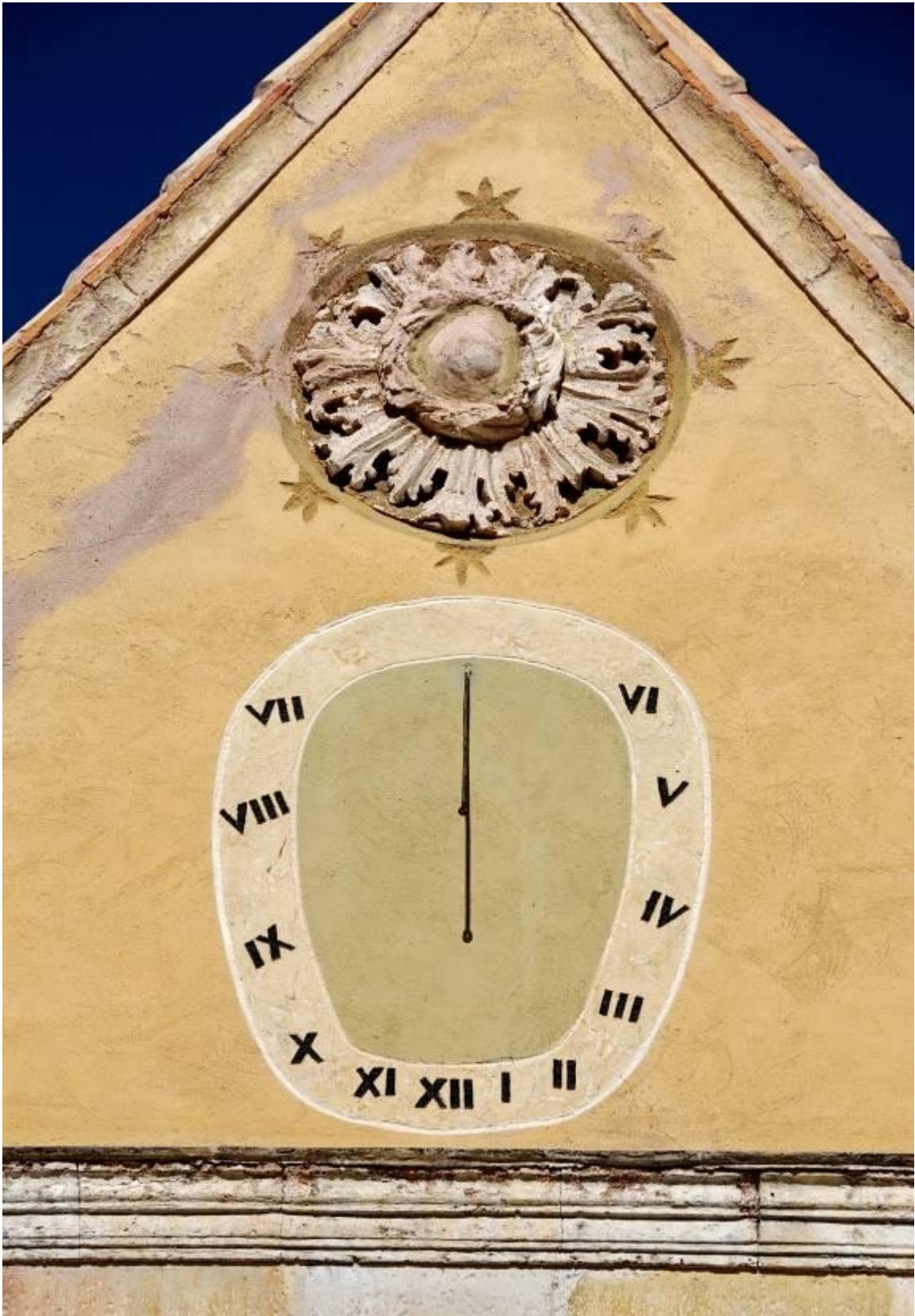
Ovalado. VDP. Romanos de VII a VI. Varilla mal orientada.
