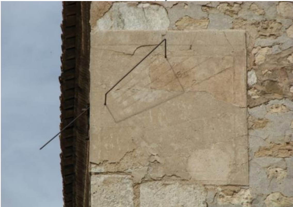
Reloj doble. Cuadrante vertical declinante a nordeste. Dec: 103^{\circ} .
