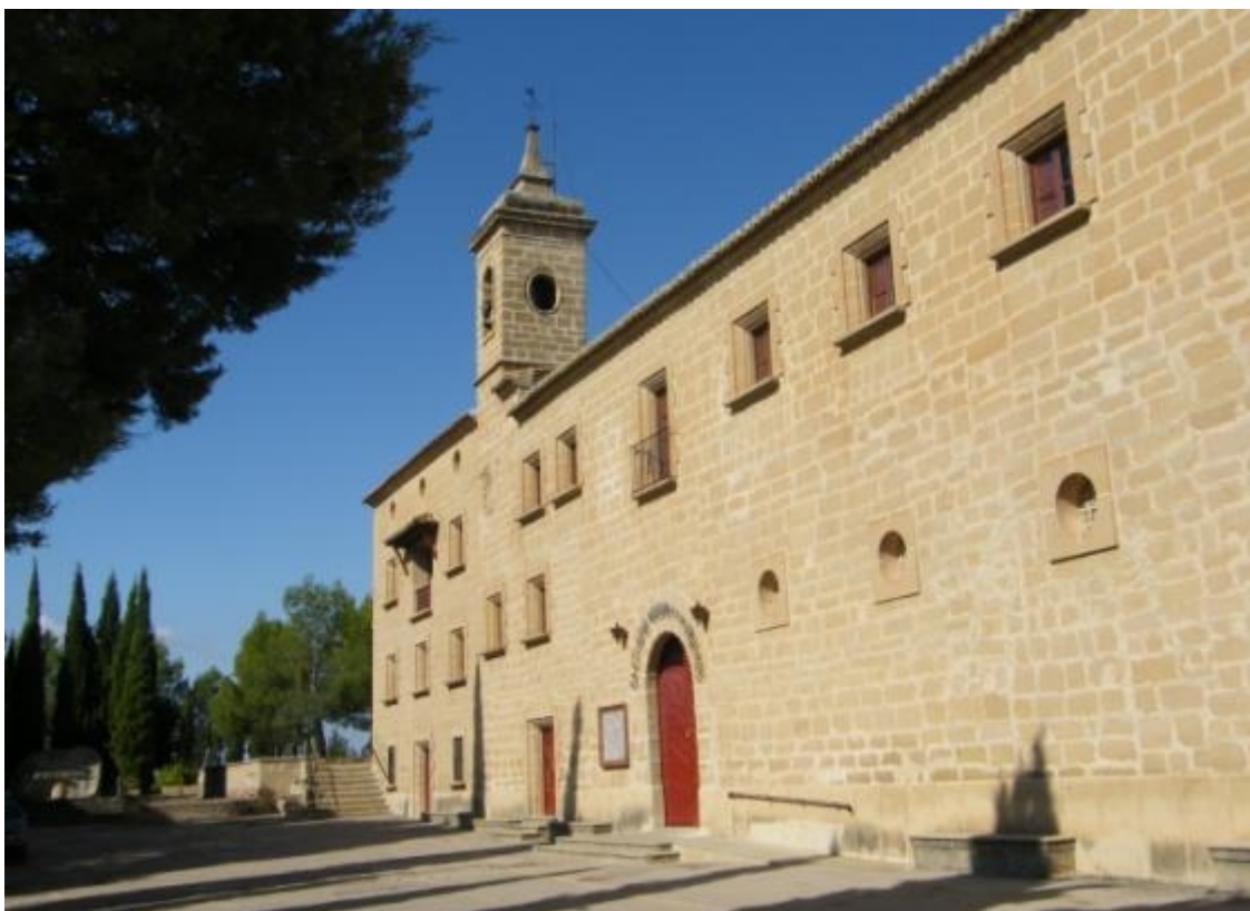
Reloj de sol en el muro sur bajo el campanario.
