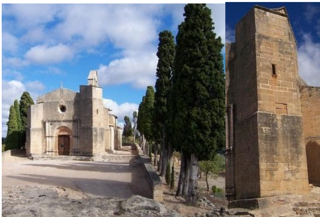
La ermita vista desde la fachada principal y escalera de caracol de subida al coro.
