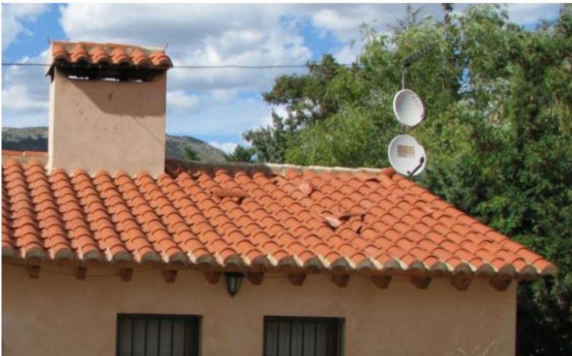
Grabado sobre el cemento fresco en la chimenea de la casa.
