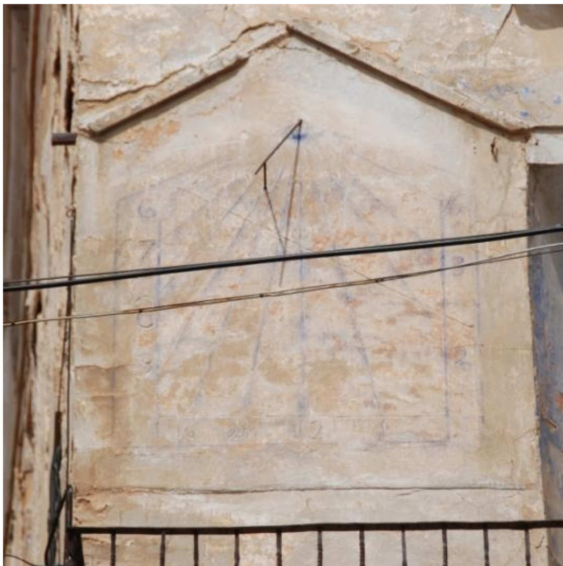
Rectangular rematado en frontón triangular. Vertical declinante a levante.
