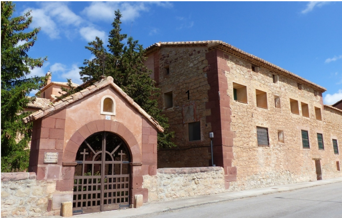
Fachada lateral del convento junto a la puerta de entrada. Situación del reloj de sol.
