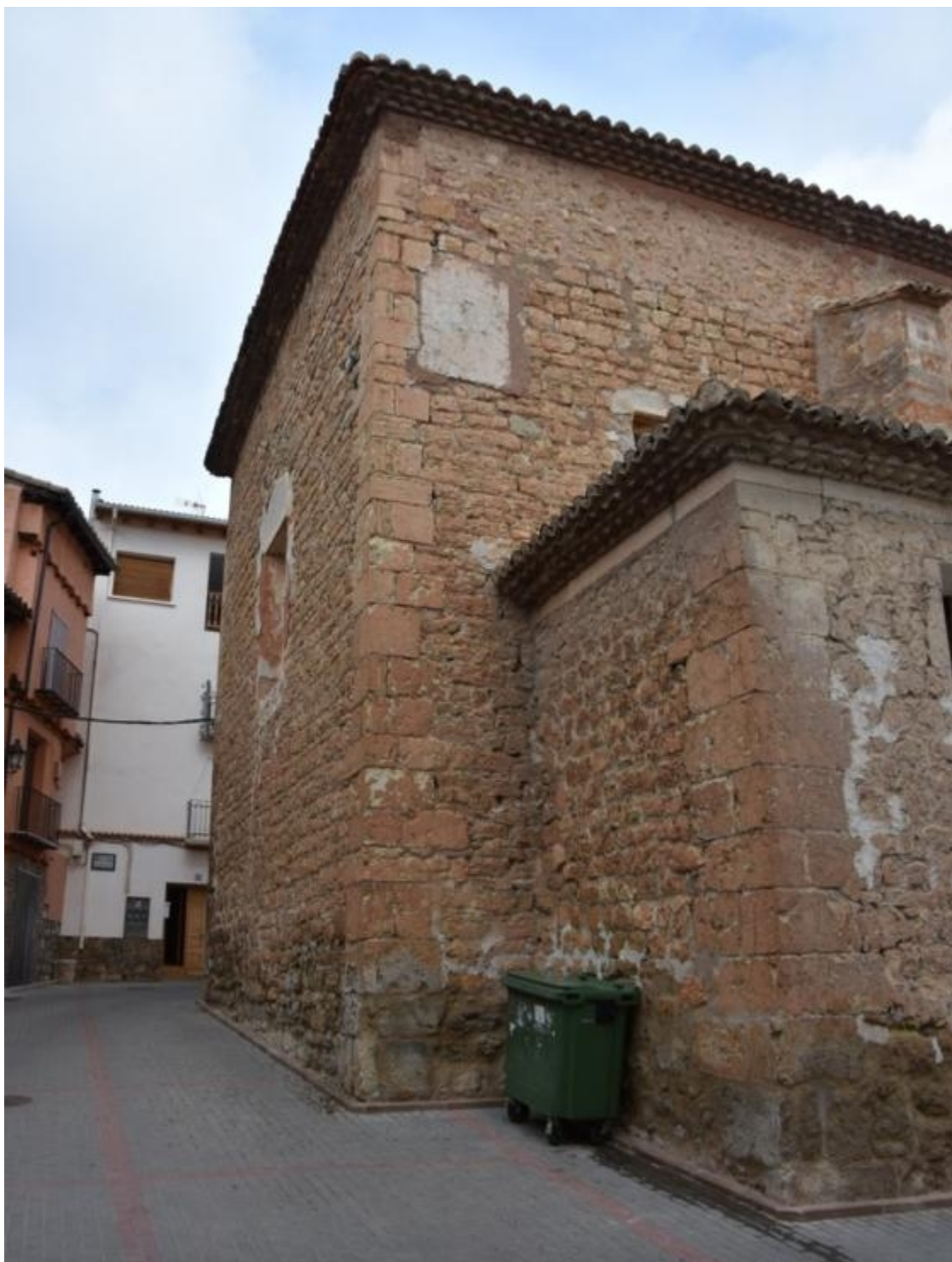
Reloj de sol grabado en una superficie enlucida sobre el muro de mampostería, en la fachada sur de la iglesia cerca de la esquina izquierda de la nave,
