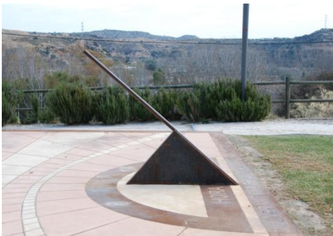
Gnomon de hierro con un apoyo triangular de chapa.
