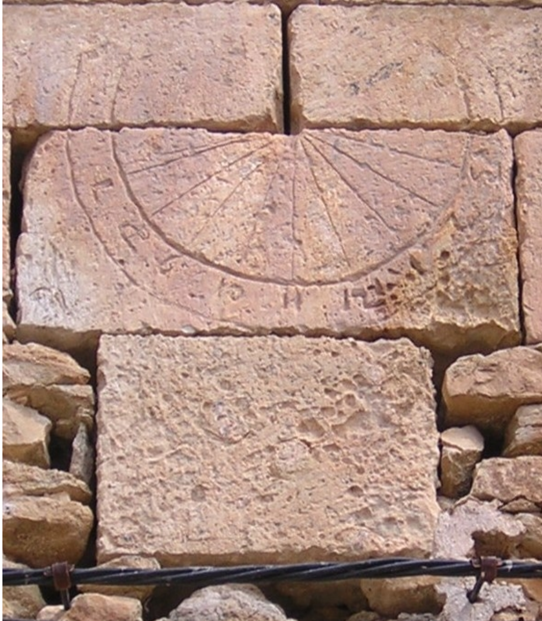
Meridiana desviada hacia la derecha: la fachada declina a levante.
