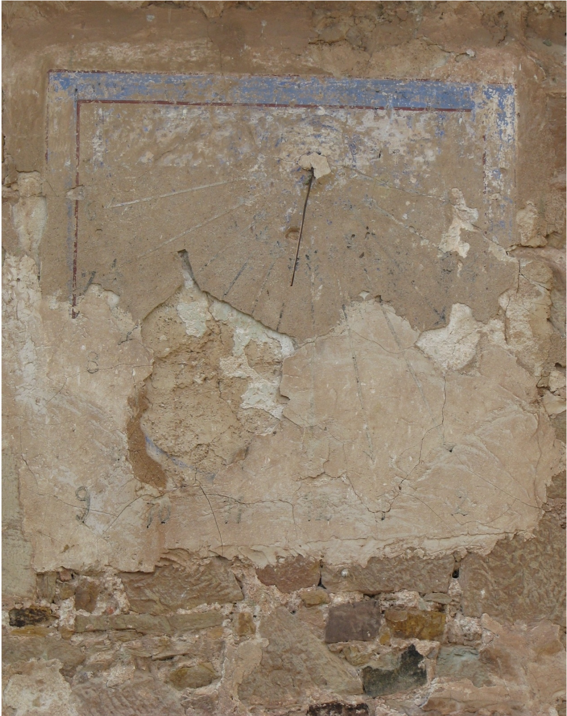
La mitad inferior de la placa enlucida se desprendió y se restauró el reloj.
