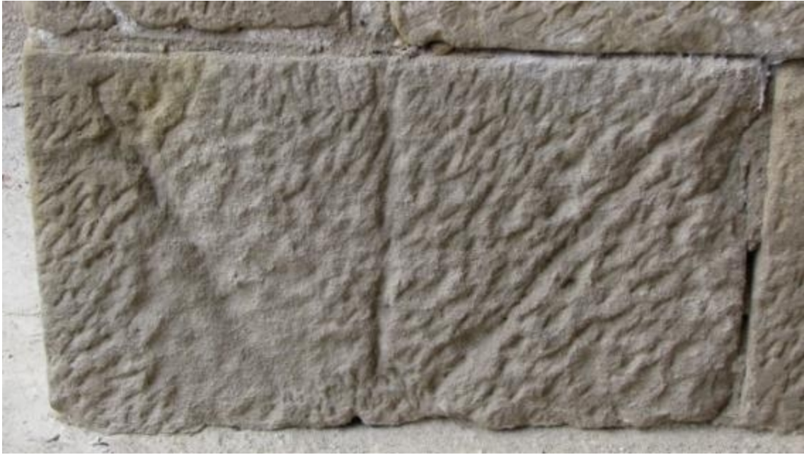
Grabado 2. Escaleras de acceso a la torre. Sillar girado 180°.
