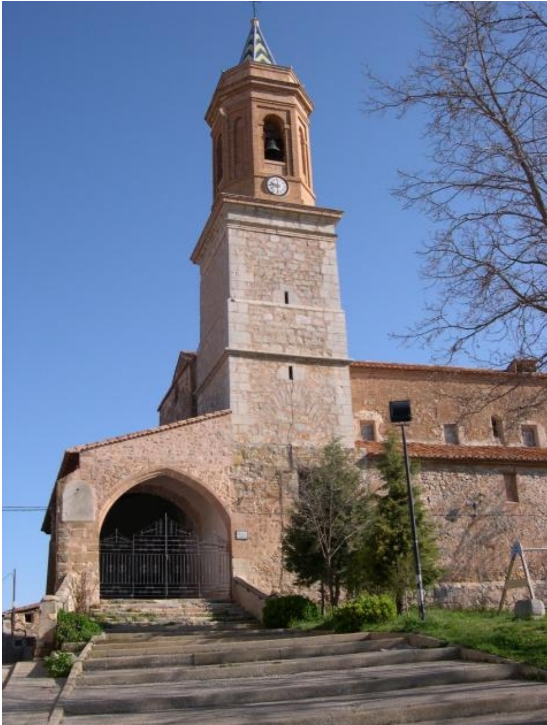
Reloj de sol situado a la izquierda del arco apuntado de acceso al pórtico.
