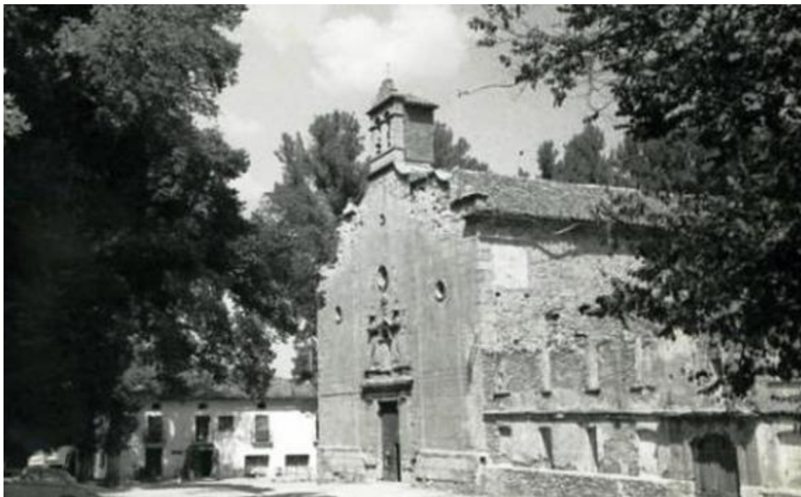
Superficie rectangular enlucida en la fachada lateral este. VDL. Desaparecido.
