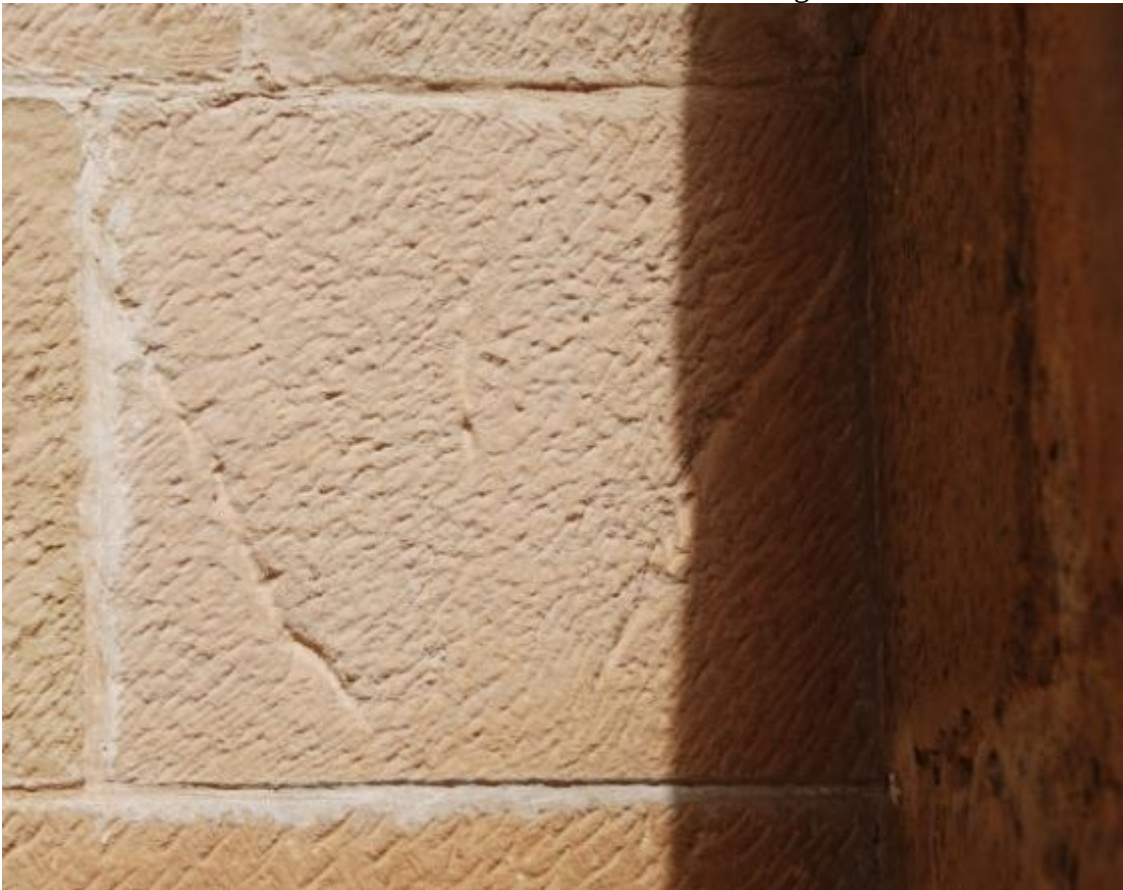
Grabado 3. Escaleras de acceso a la torre. Sillar girado 180°. Grabado moderno.
