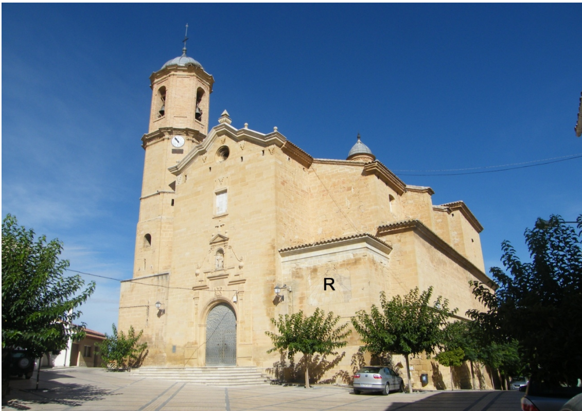
Situación del reloj de sol en la fachada principal de la iglesia.
