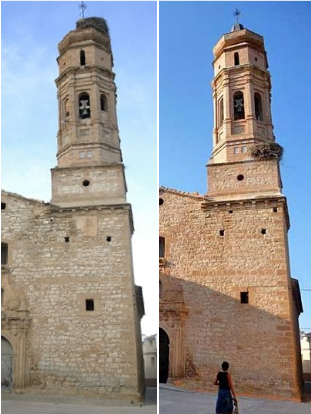
Fachada principal. Reloj de sol en el muro sur en el primer cuerpo de la torre.
