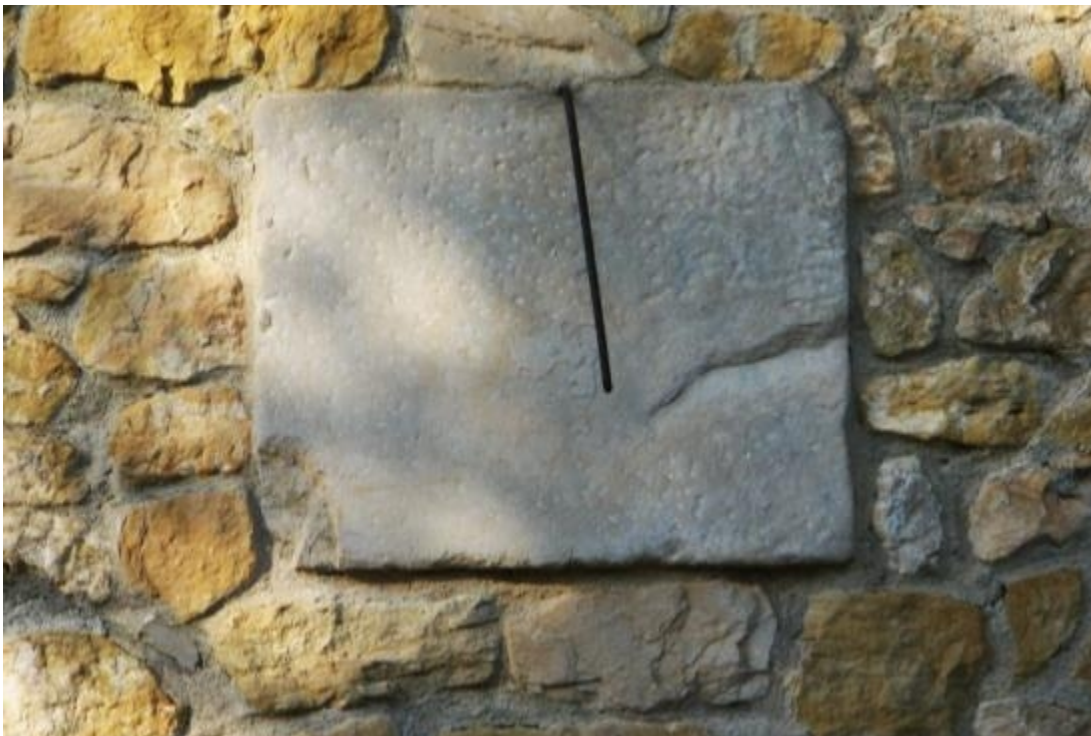
Placa de piedra empotrada sobre la portada. Varilla de un apoyo mal orientada.
