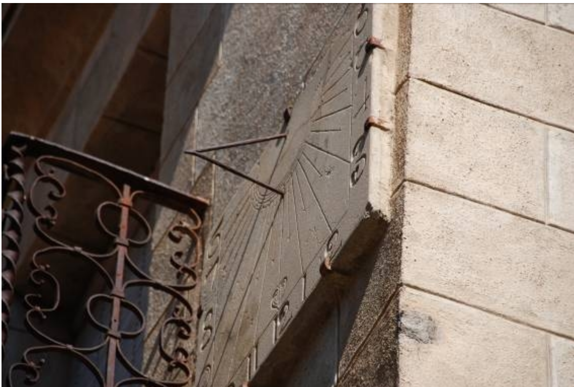
Esquina SE de la casa, a la altura del balcón de la segunda planta. Varilla acodada.
