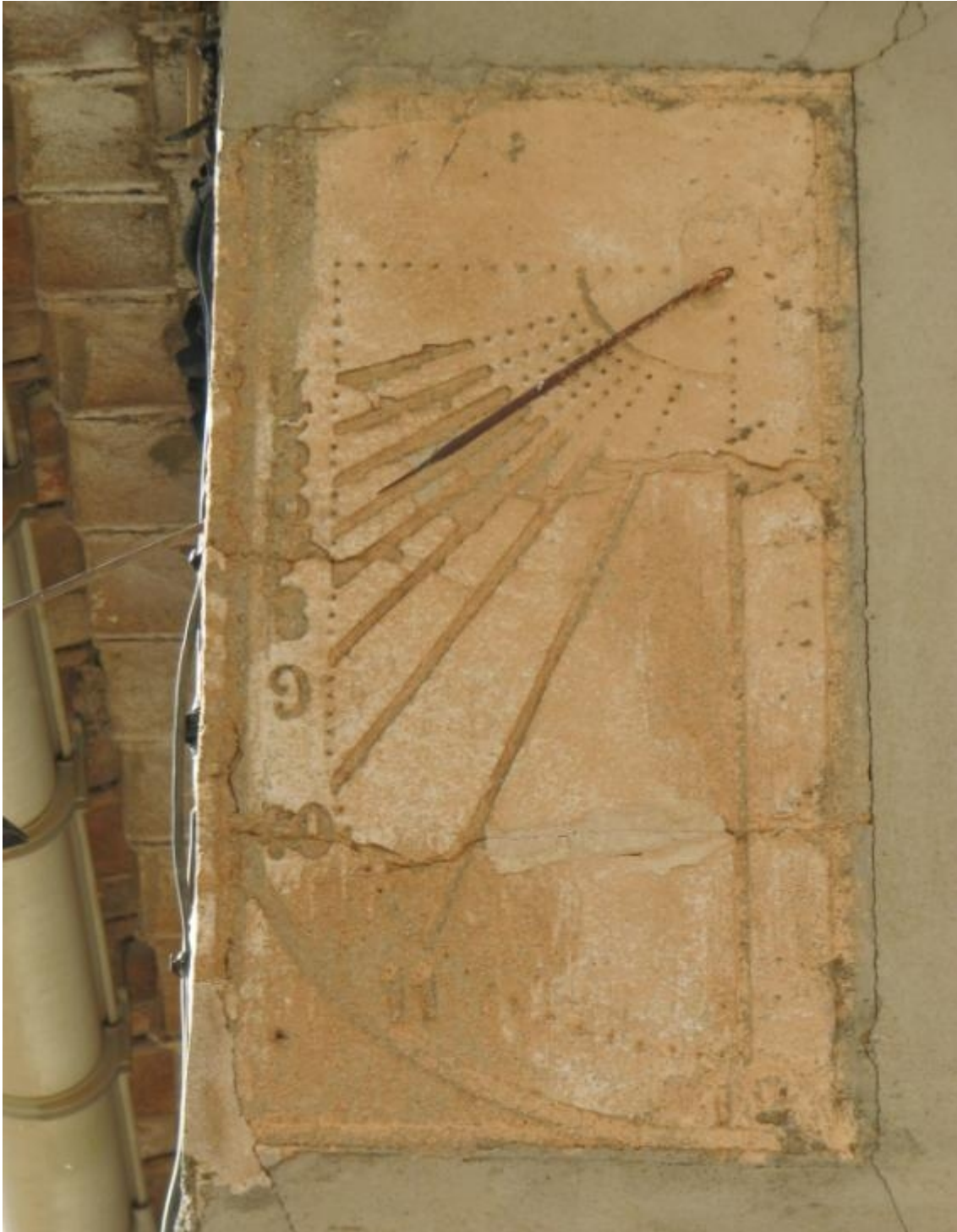
Reloj de sol doble. Cuadrante vertical declinante a levante. Declinación: 65.
