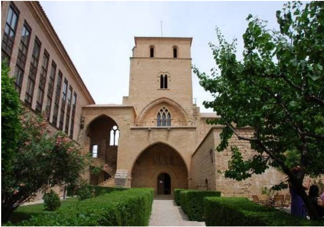
Torreón a los pies de la iglesia. La planta baja del torreón es el pórtico.
