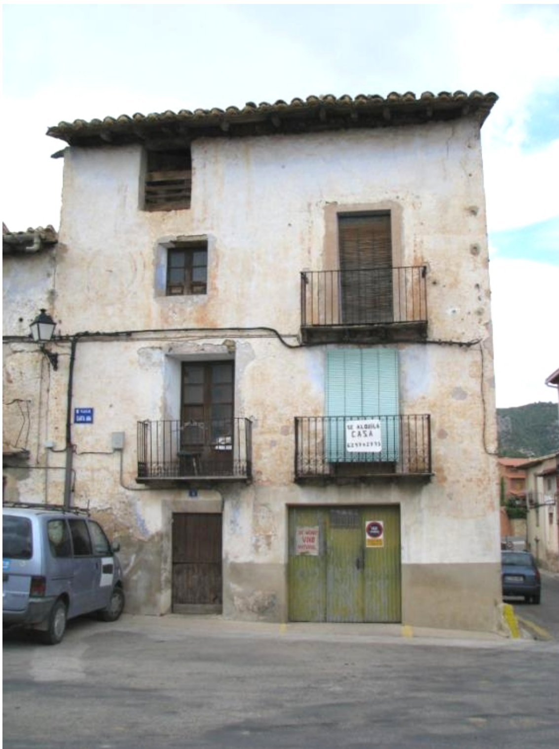
Situado a la izquierda de la ventana de la segunda planta.
