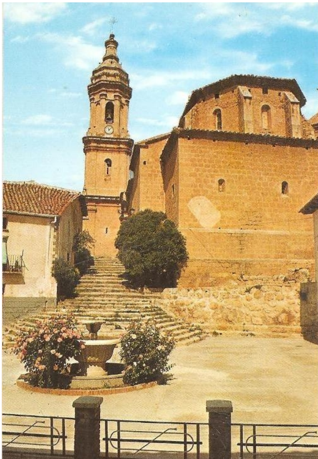
Superficie rectangular enlucida en la fachada este.
