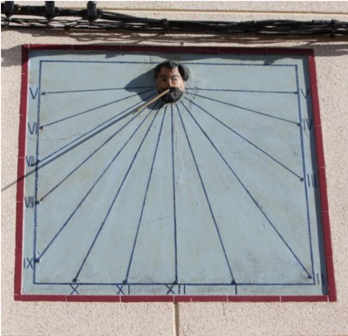
Estado del reloj de sol en el año 2015, tras el arreglo de la fachada.
