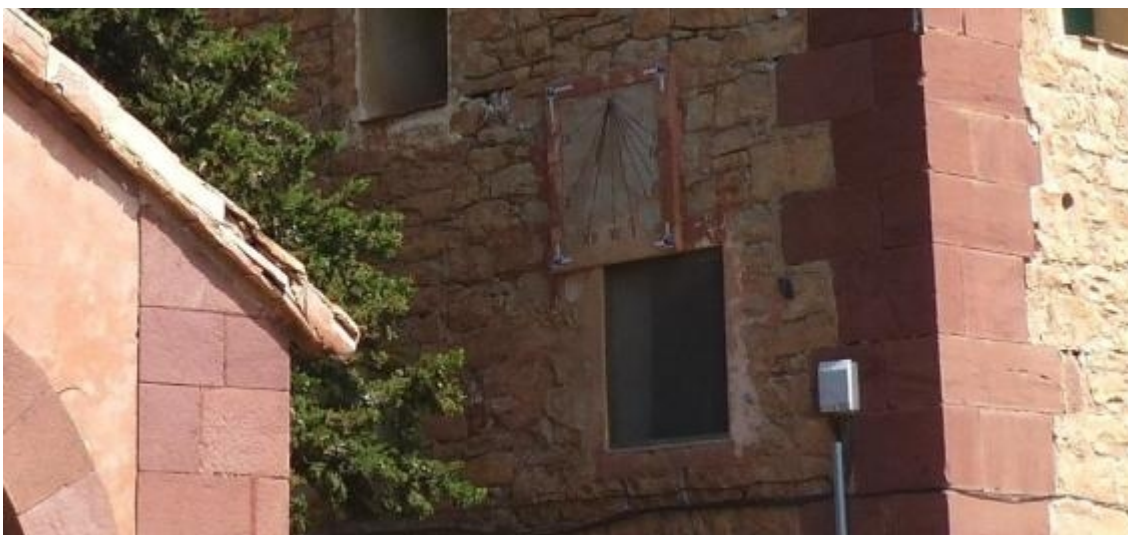
Fachada lateral del convento. Situación del reloj de sol.
