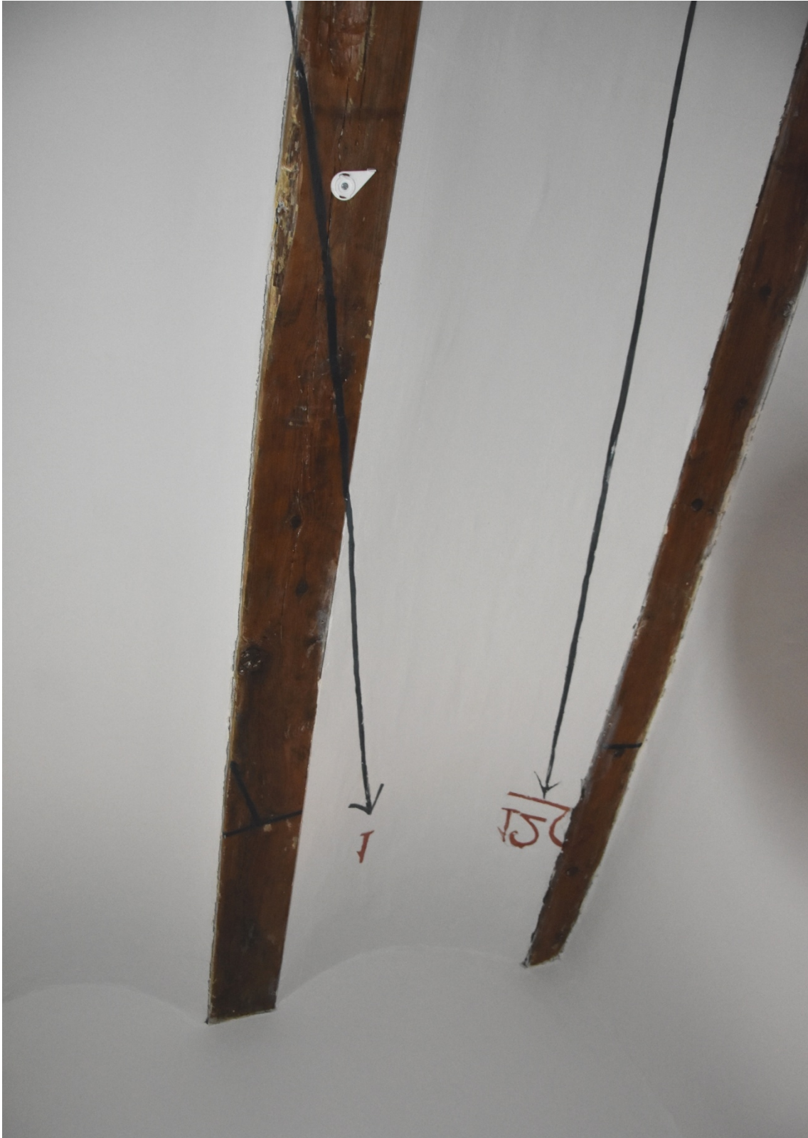
Cuarto de la ventana. Parte del techo situada sobre la ventana.
