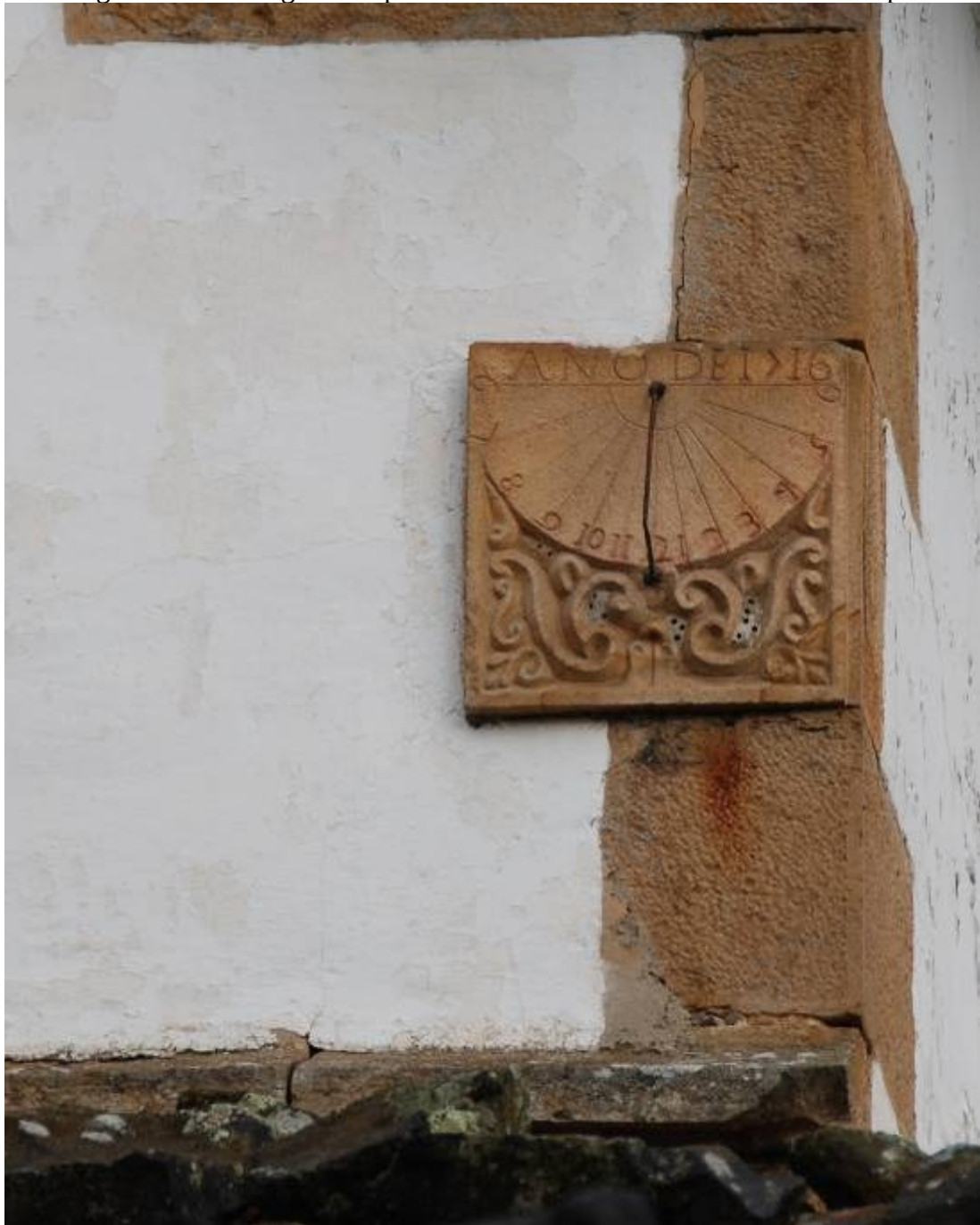
Esquina sureste de la nave, el reloj de sol por encima del tejado del pórtico.
