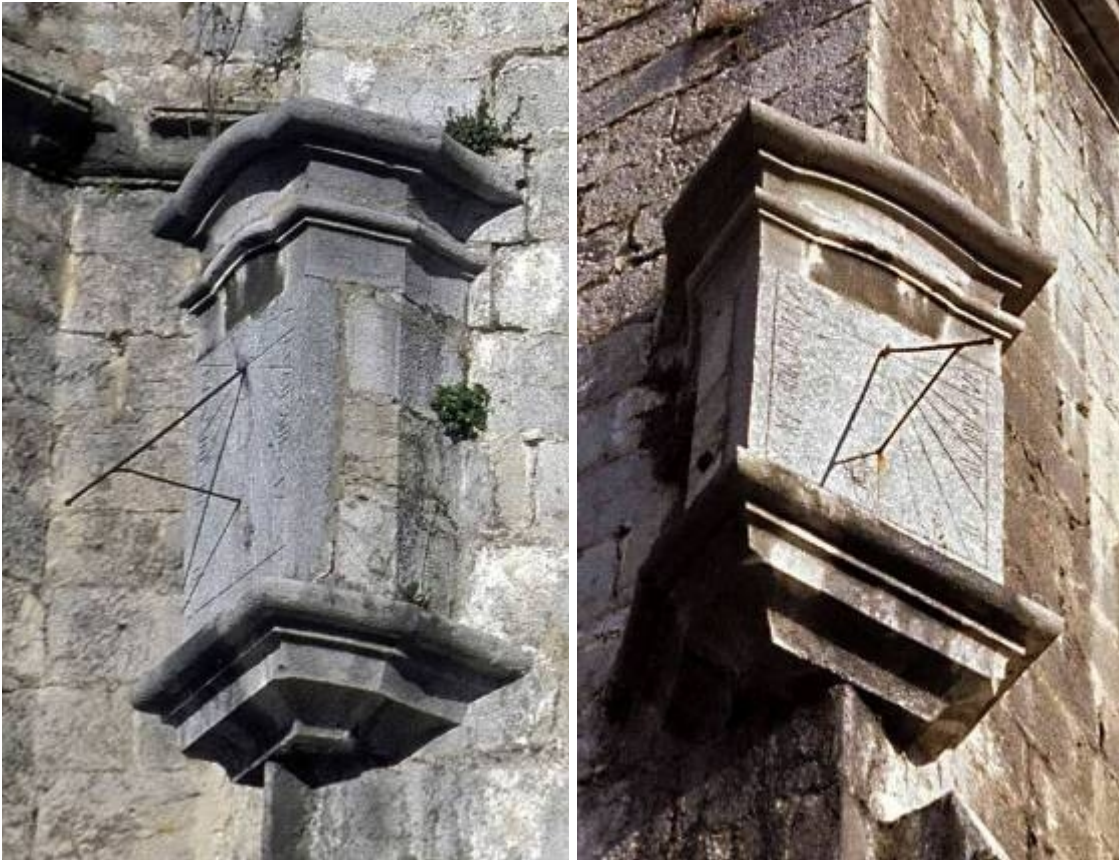
Esquinas noroeste y suroeste de la torre. Año 1991. guregipuzkoa.net/photo/1055449
