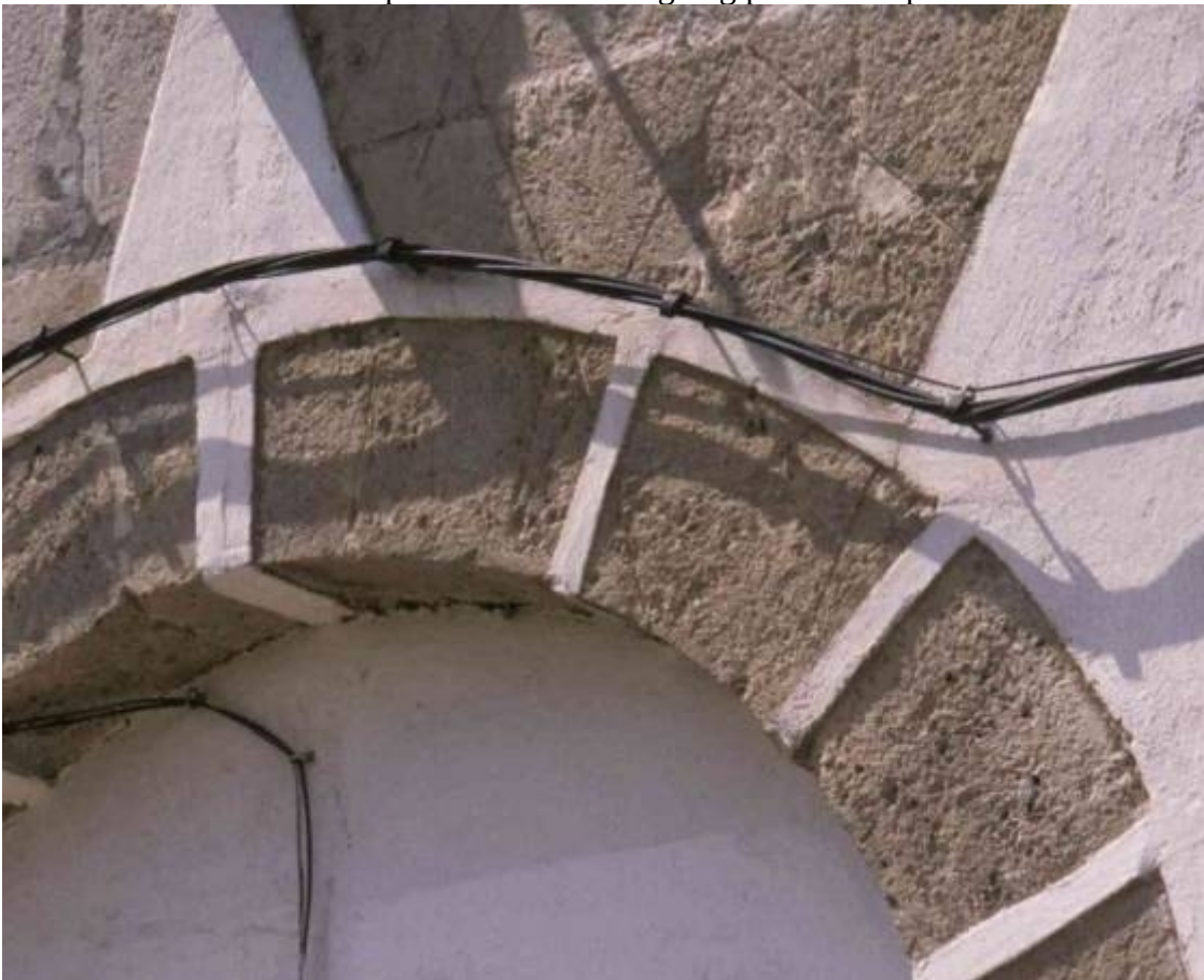
Detalle. Líneas de las once y de las doce se adentran en las dovelas.
