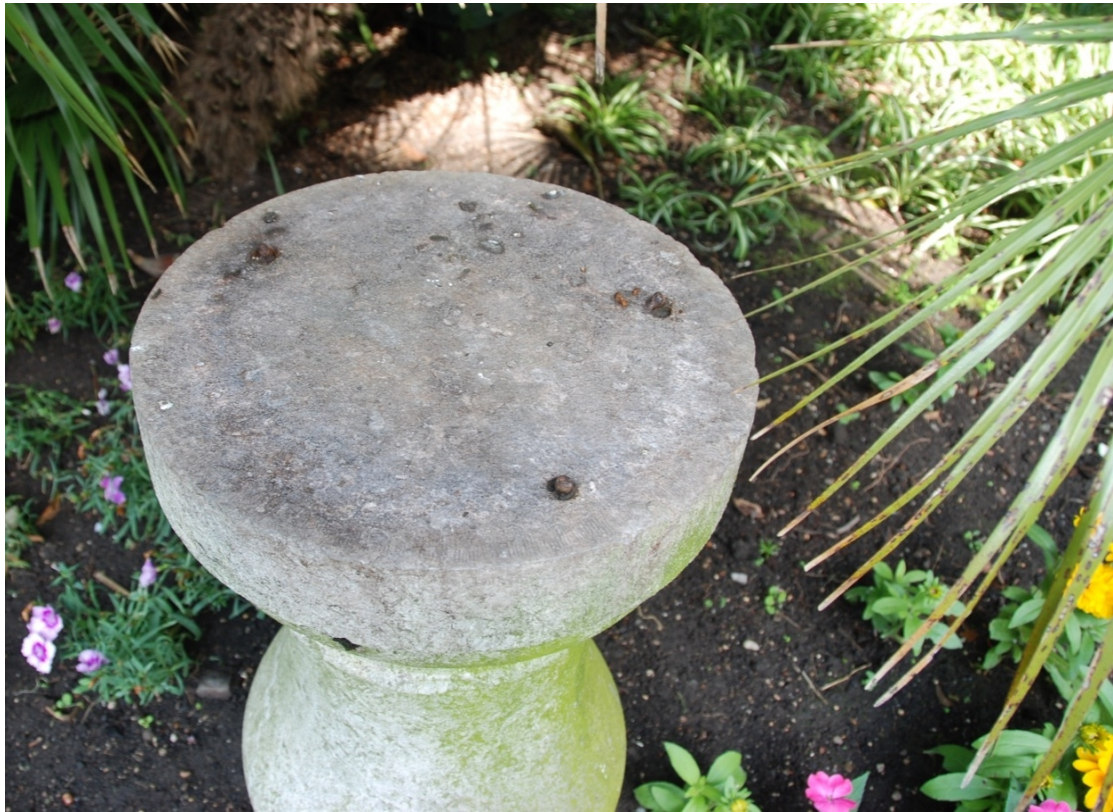
Detalle: los tres puntos de sujeción de la base del mortero meridiano.
