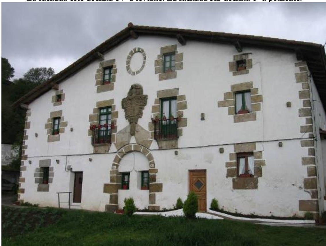
Fachada este del caserío Aginaga tras la restauración.
