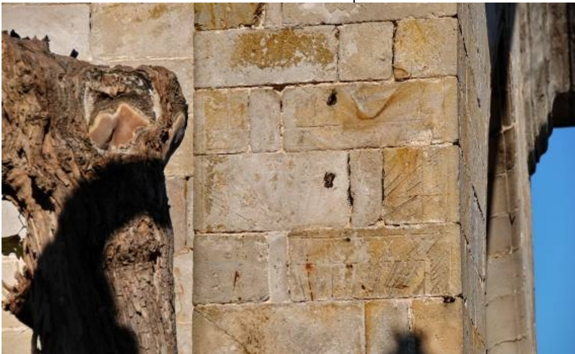
Varios sillares soporte de un reloj solar reutilizados en la construcción de la capilla.
