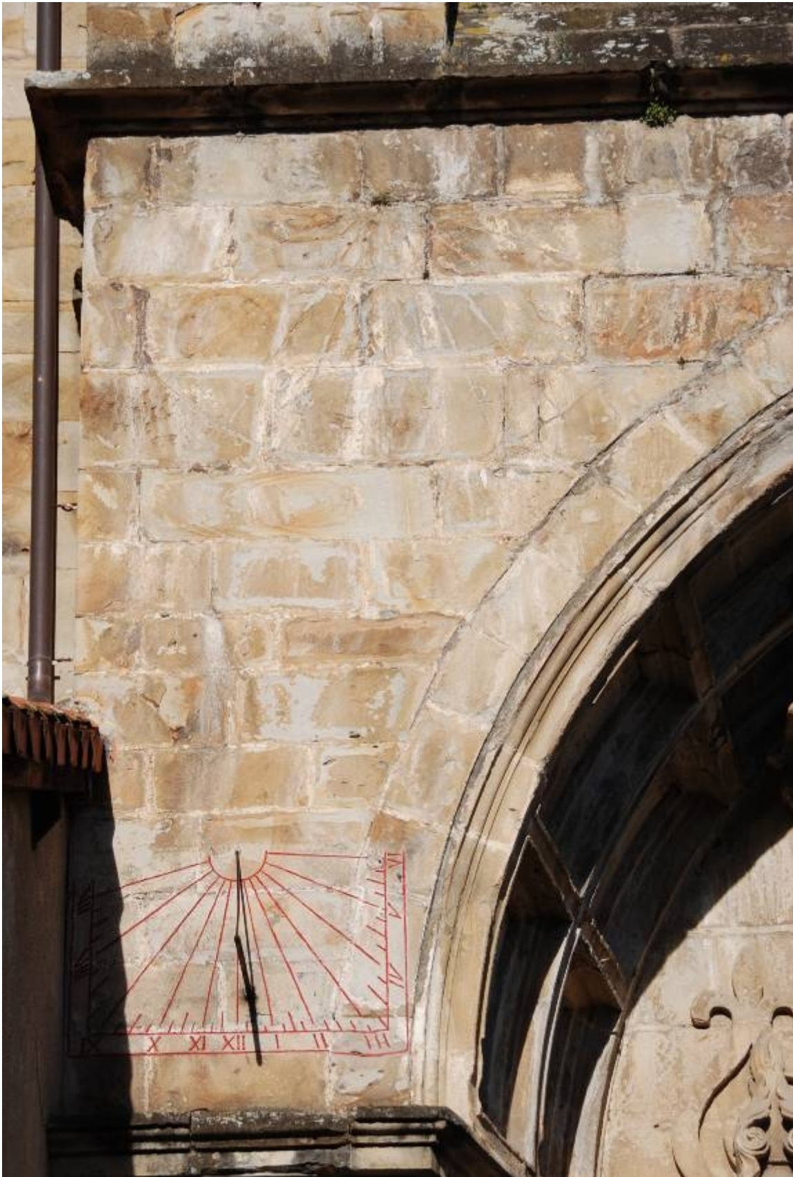
El reloj semicircular es meridional y la fachada sur delina 3 grados a poniente.
