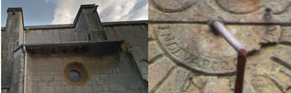
Situado sobre el contrafuerte de la esquina SE de una capilla lateral.
