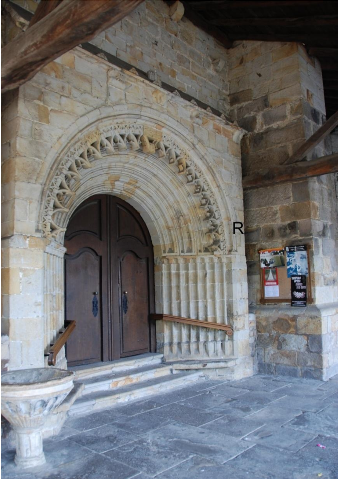
Reloj de sol a la derecha de la portada. Siglo XIII. Contrafuerte. Siglo XVI.
