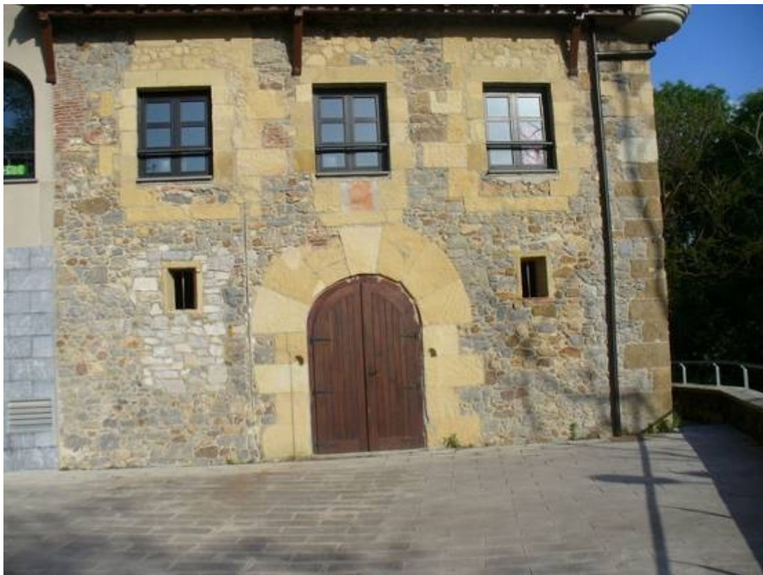
La pequeña ventana ha sido cegada con ladrillo.
