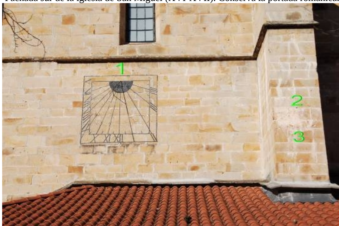
Situación de los tres cuadrantes. Último tramo de la nave.
