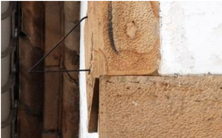
Varilla acodada sujeta con plomo. Esviaje.
