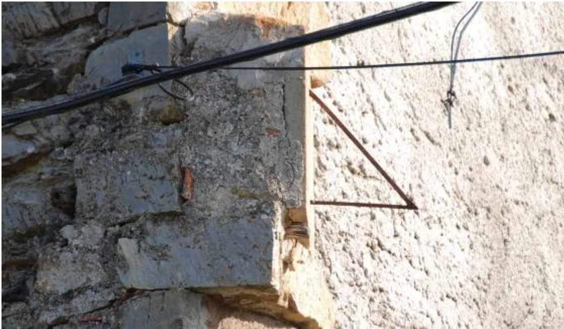
Varilla acodada con el tramo de apoyo horizontal.
