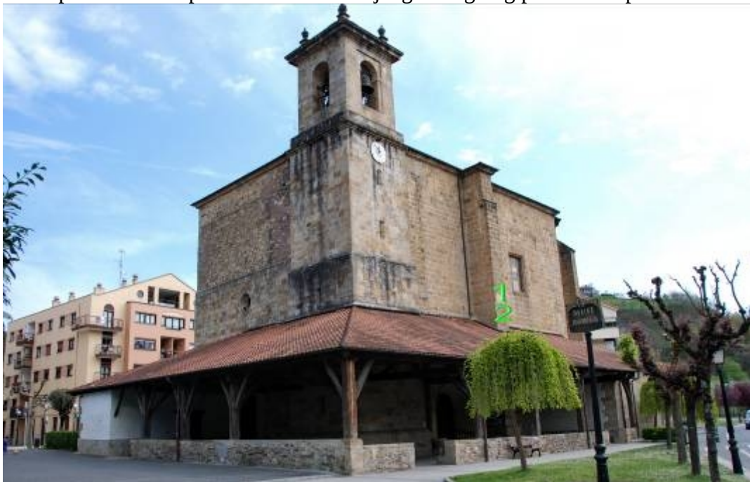
Situación de los relojes de sol 1 y 2 en el contrafuerte de la nave sobre el pórtico.
