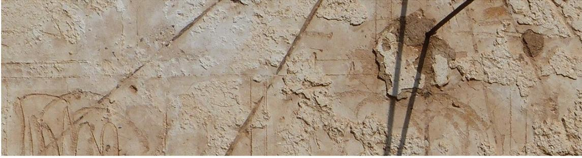
1ª. Capa de revoco liso, sobre la mampostería del muro, con líneas dobles esgrafiadas imitando obra de sillería. Líneas finas en las caras de los sillares, excepto en la zona rectangular reservada para el reloj de sol.
