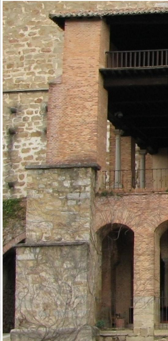
El contrafuerte reconstruido es prismático, de piedra, más ancho en la parte superior que el de ladrillo y envuelve al pilar por el costado oeste.
