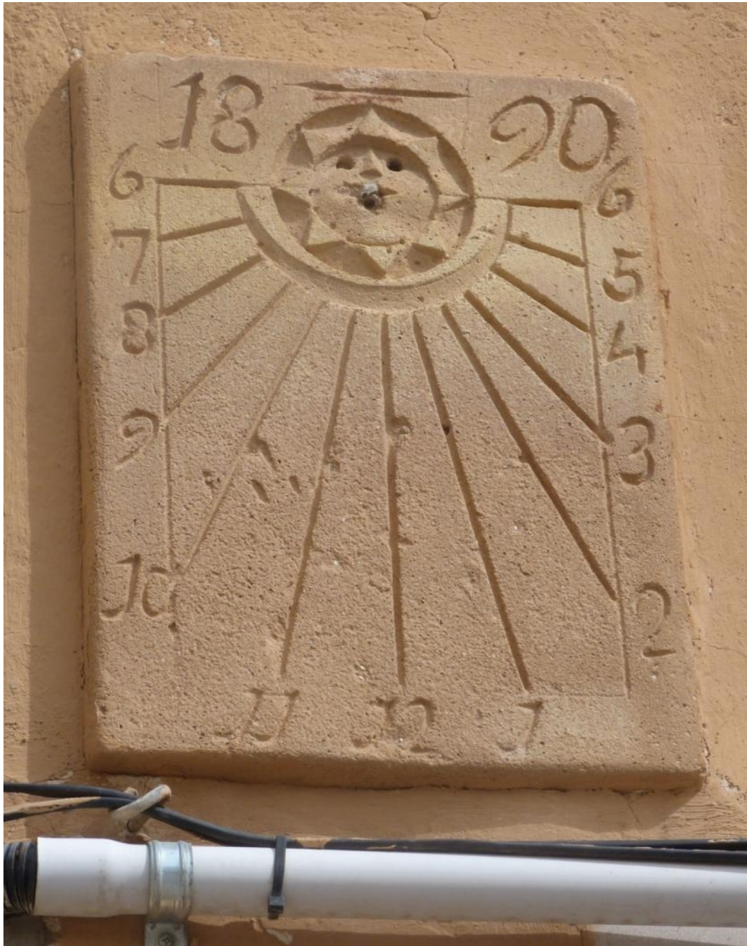
Grabado en una placa de barro cocido. Horas en números arábigos, de 6 de la mañana a 6 de la tarde. Cifra 1 'de anzuelo, 4 abierto y 5 con el trazo superior desarrollado. Semicírculo distribuidor inciso muy marcado. Cara de sol en hueco relieve con la varilla de un solo apoyo que le sale de la boca y la fecha en números grandes partida a sus dos lados: 1890.
