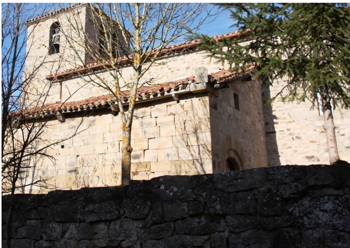
Situado en la esquina sureste del tejado del pórtico.
