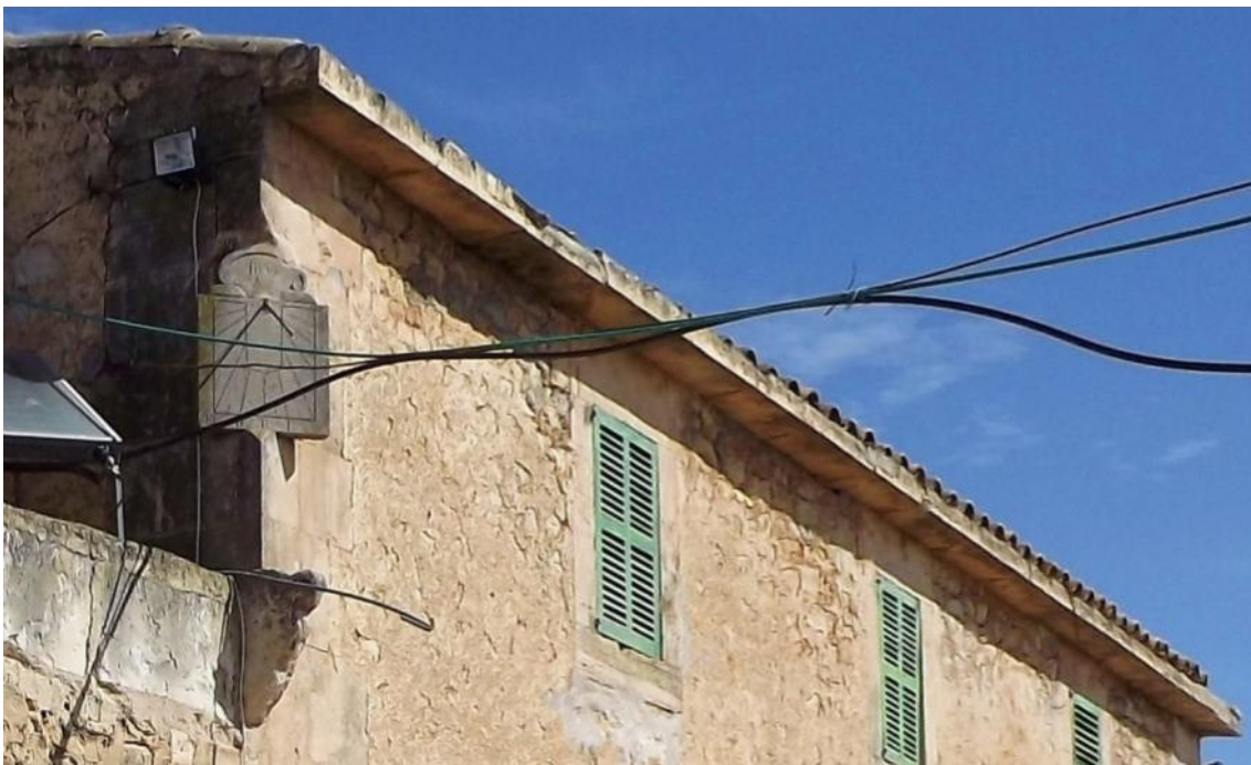
Empotrado en la esquina suroeste del edificio principal.
