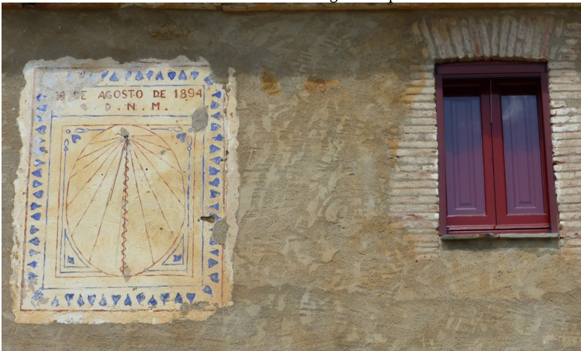
Grabado y pintado a dos colores, ocre rojo y azul, sobre el enlucido de la fachada.
