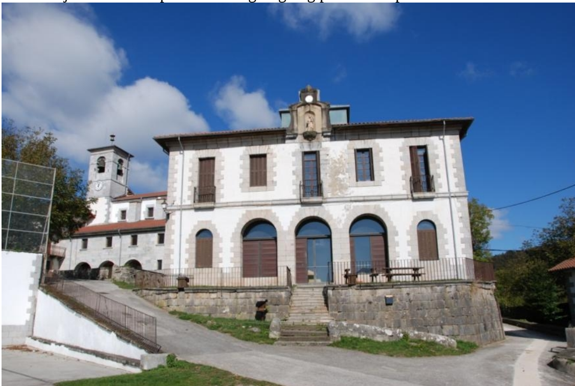
La iglesia y las escuelas. En el centro del tejado, la hornacina modernista.
