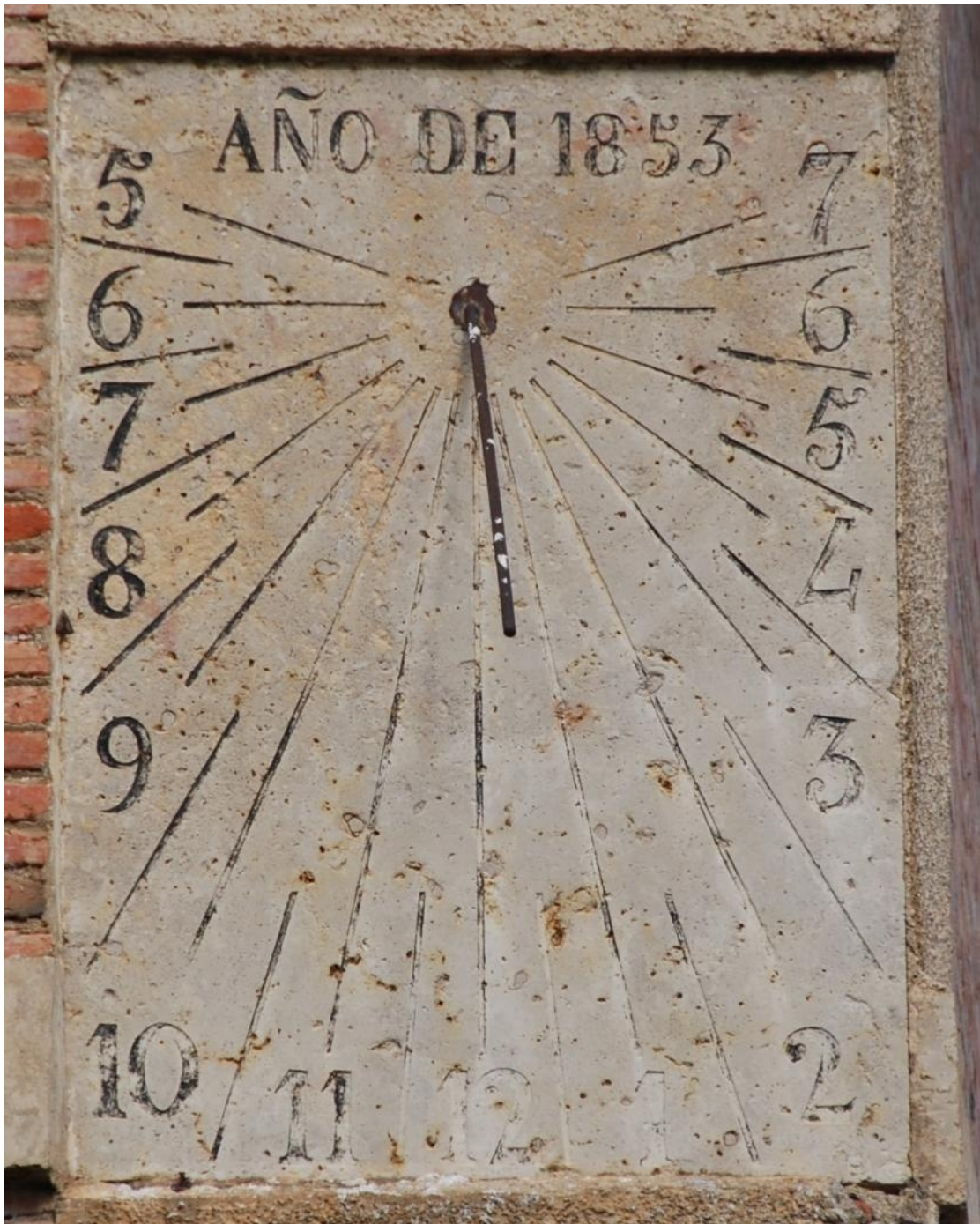
Grabado y pintado de negro en una placa de piedra empotrada en la esquina de la segunda planta de la casa del guarda. Horas en números arábigos de 5 de la mañana a 7 de la tarde. Líneas de medias horas grabadas entre los números. Varilla de un solo apoyo. Las obras del canal se iniciaron en 1753, el reloj lleva la fecha del centenario: AÑO DE 1853.
