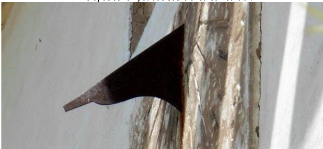
Gnomon triangular de chapa de hierro recortado en la base.
