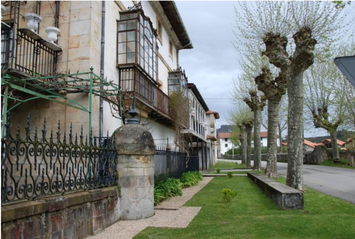
En primer término la casona de Avendaño, detrás la casa de los trabajadores.
