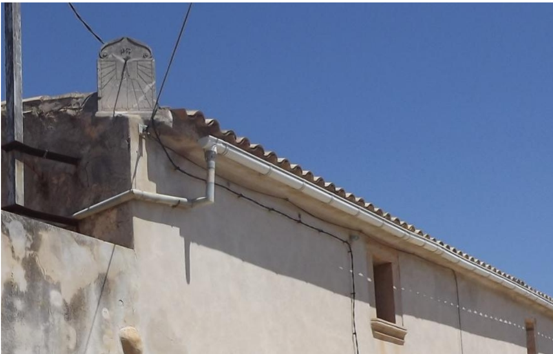
Situado sobre una losa de piedra la esquina suroeste del tejado.
