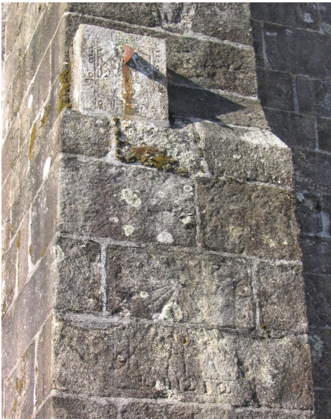
Dos filas de sillares bajo el reloj fechado hay otro reloj grabado en el contrafuerte.
