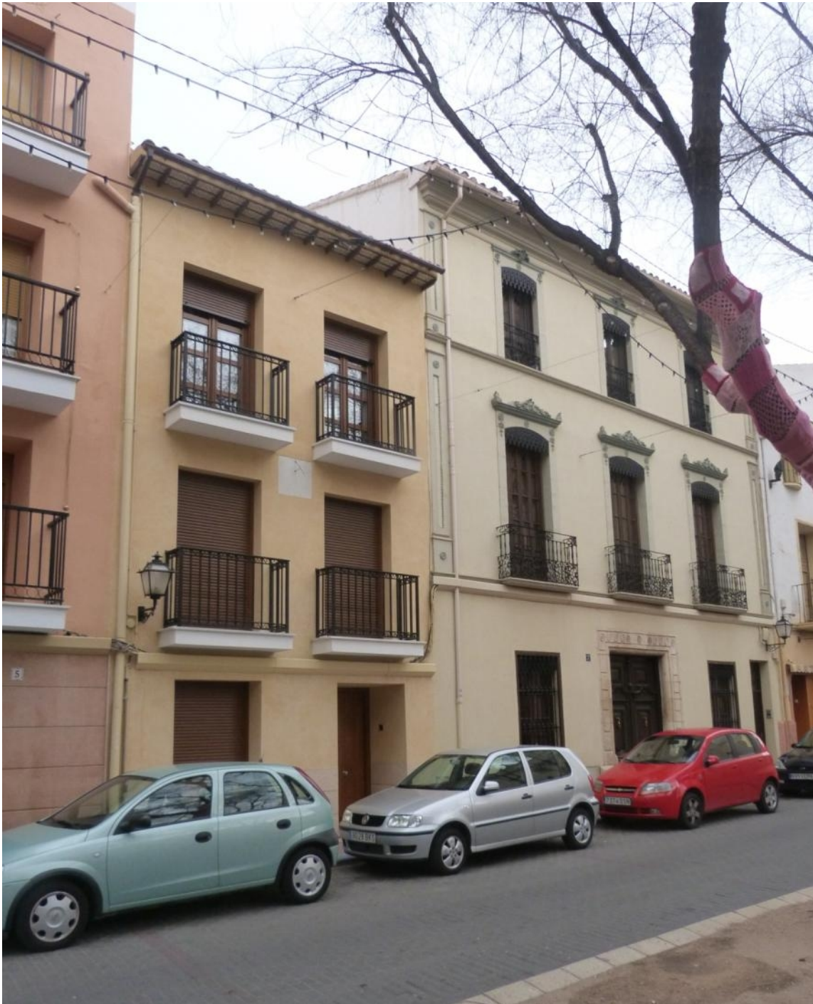
Empotrado en el centro de la fachada. entre las plantas primera y segunda.
