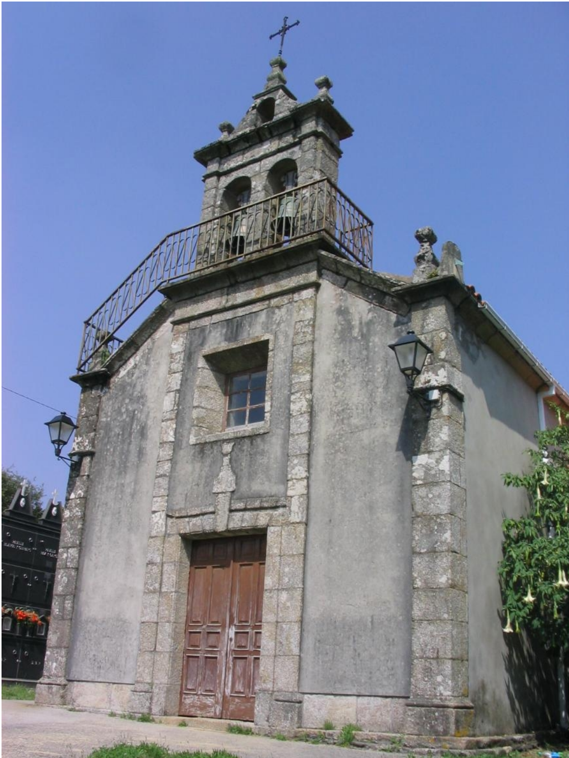
Apoyado sobre la cornisa del tejado en la esquina suroeste de la nave.
