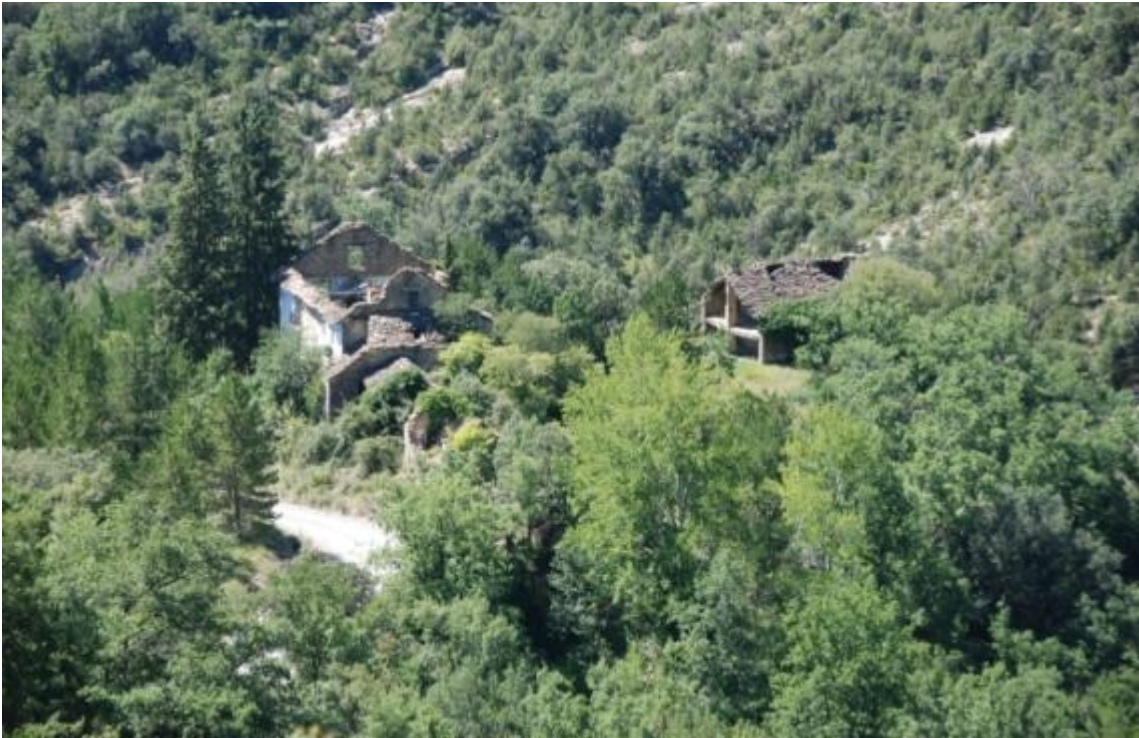
Pardina de Santa María vista desde la pista que sube a Ascaso. Vivienda y pajar.
