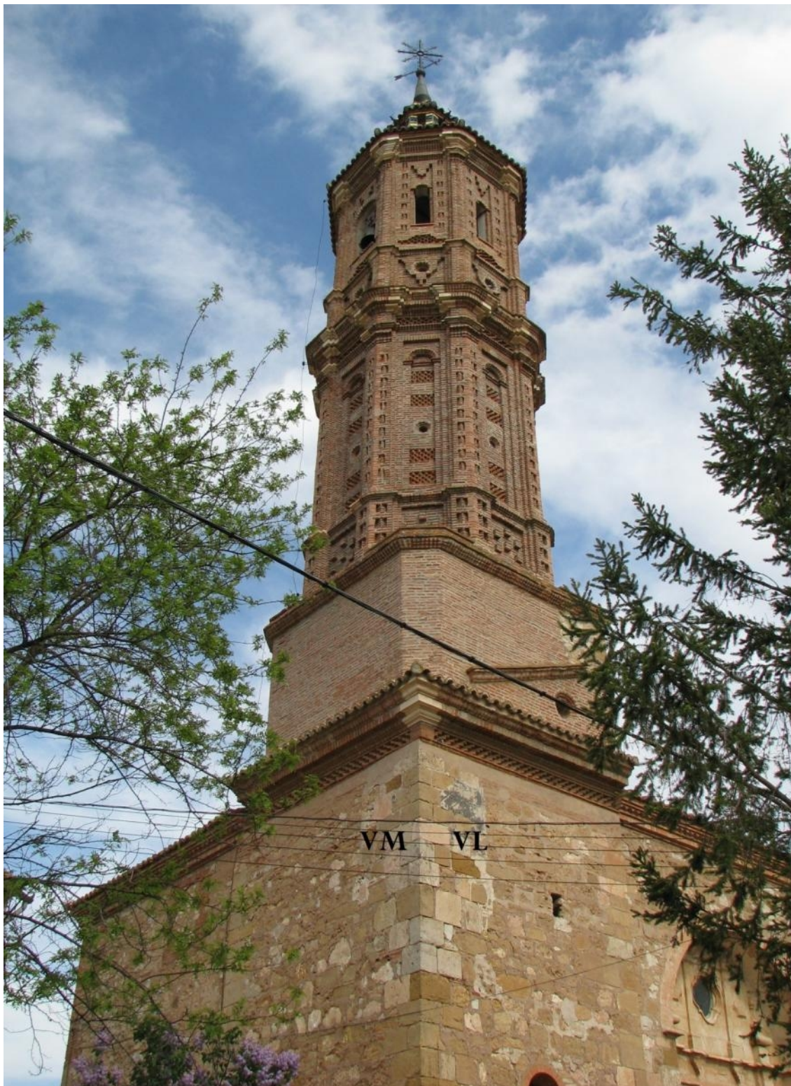
Reloj de sol doble en la esquina suroeste del primer cuerpo de la torre.
