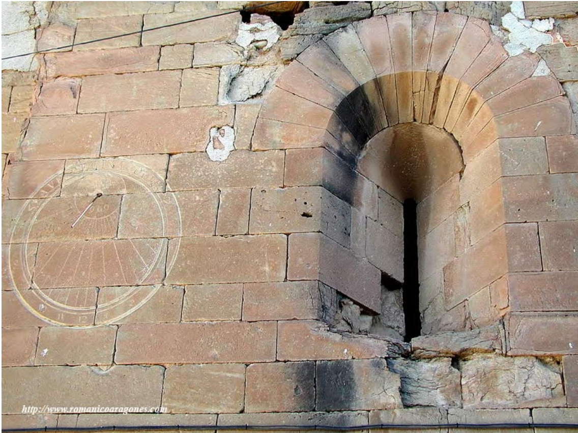
Grabado a la izquierda del ventanal abocinado del primer tramo de la nave.
