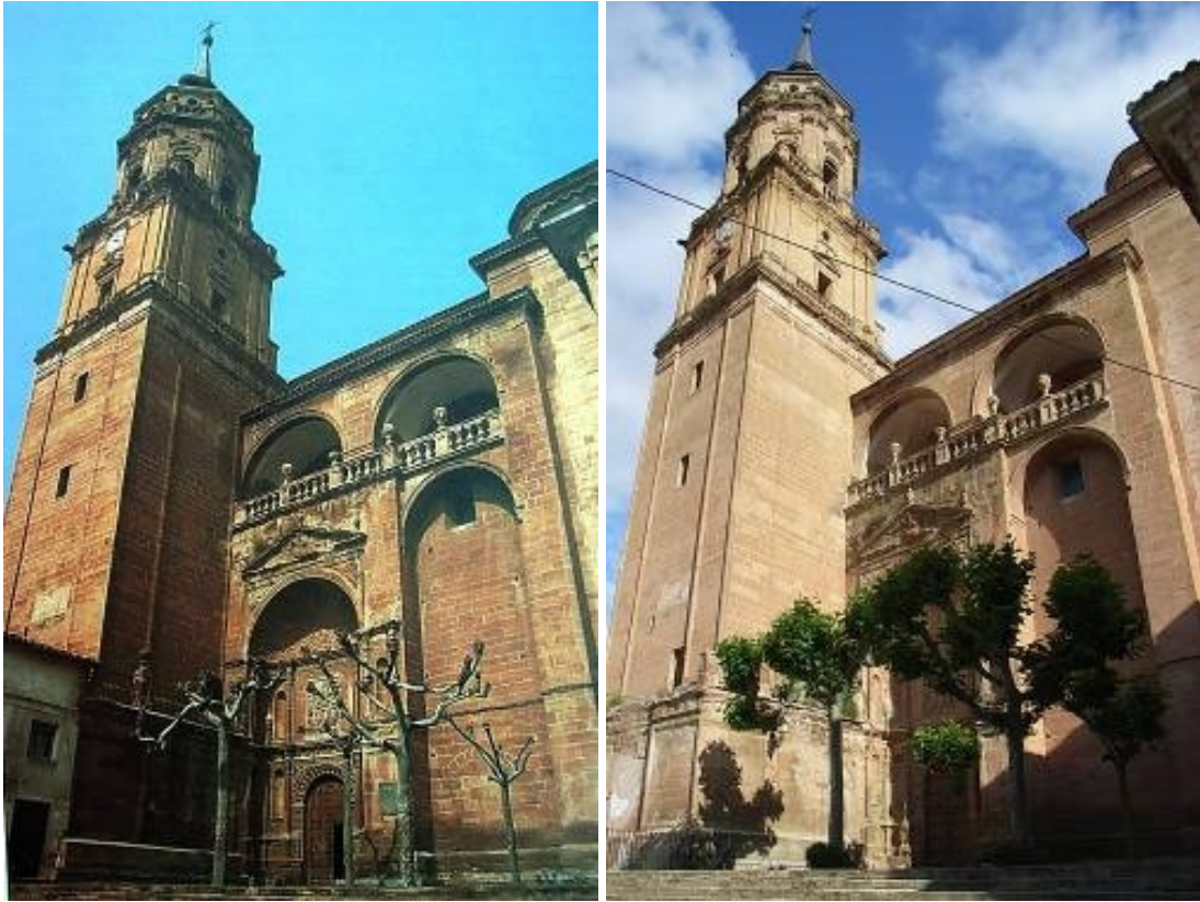
La torre antes y después del derribo del edificio adosado a su costado sur.
