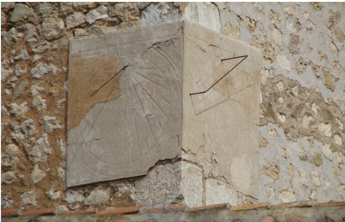
Situado en la esquina sureste de la cabecera por encima del tejado del pórtico.
