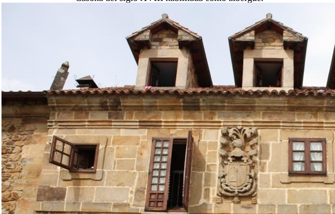
Situado sobre la esquina del tejado, a la izquierda de la fachada principal.
