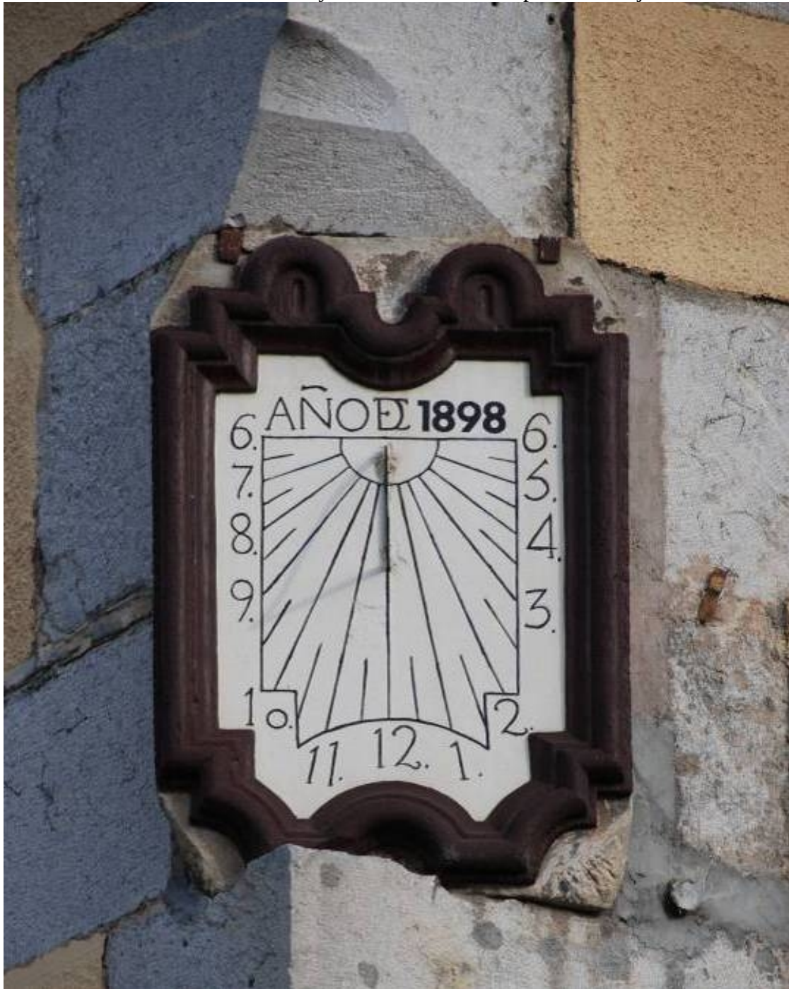
Repintado durante la restauración de la fachada.
