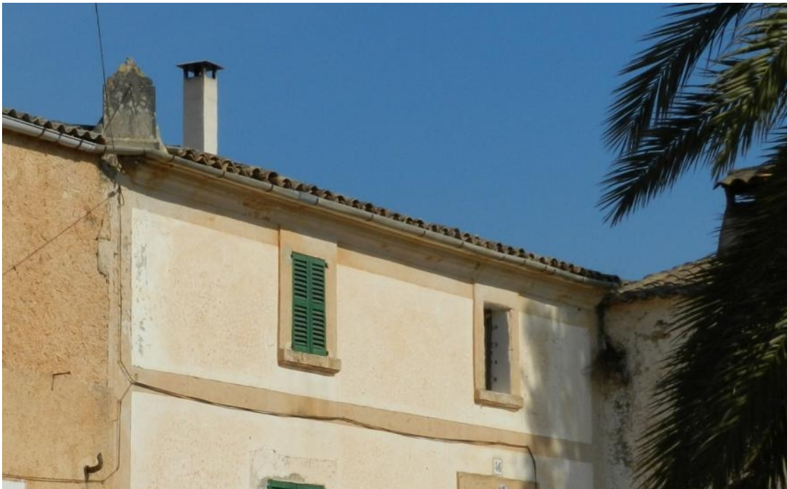
Situado sobre la esquina suroeste del tejado del edificio principal.
