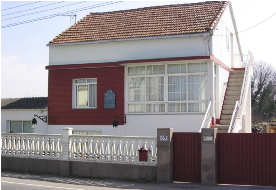
Mal orientado. Situado en la fachada norte de la vivienda.
