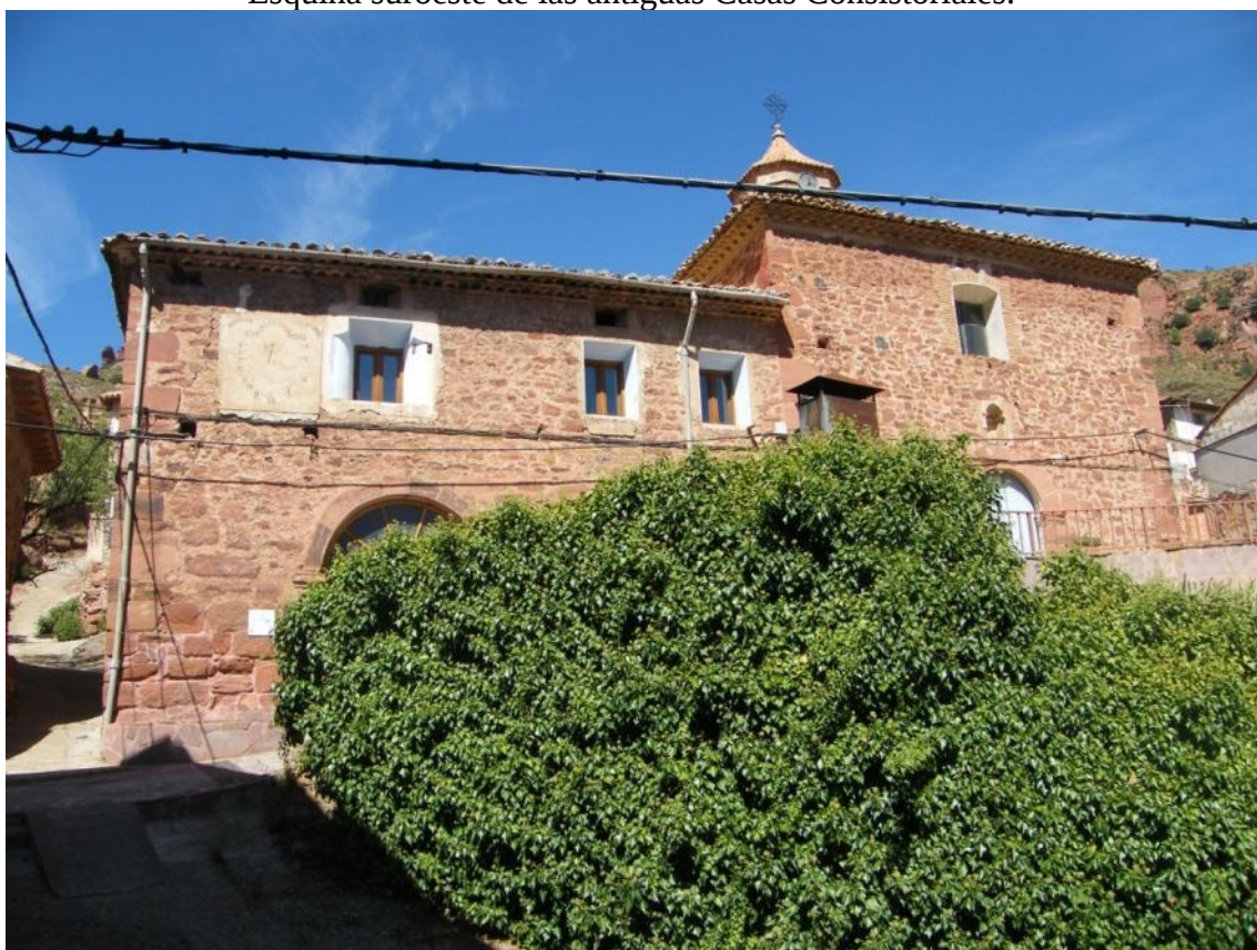
Fachadas principales de las antiguas Casas Consistoriales y de la iglesia.
