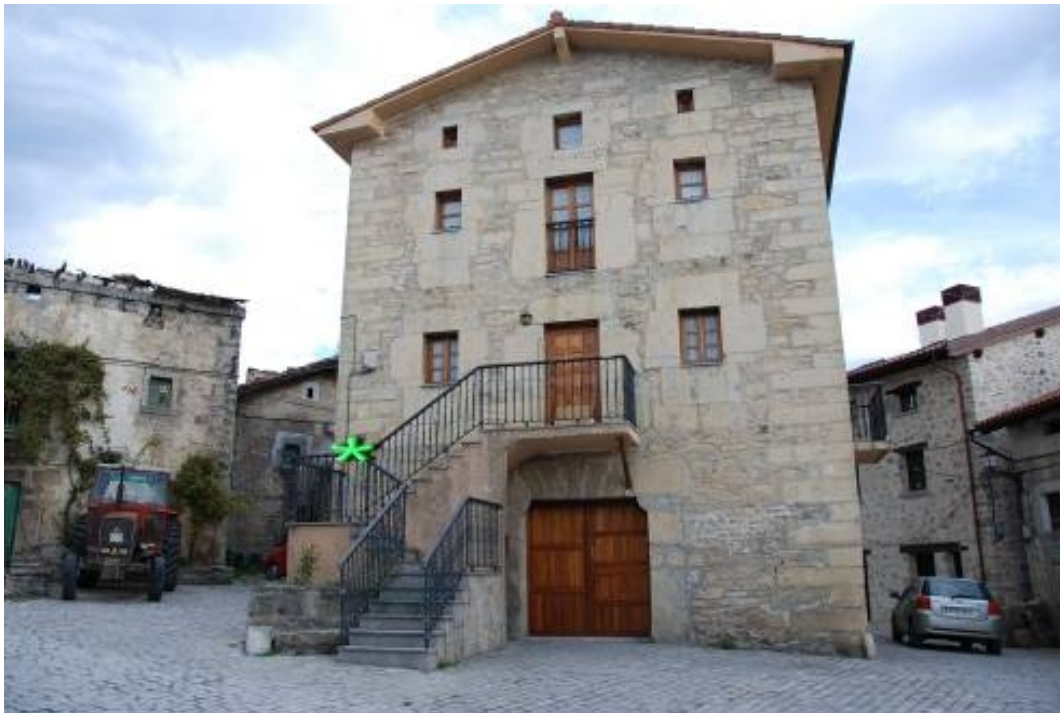
Torre Villota. Situación del reloj de sol.
