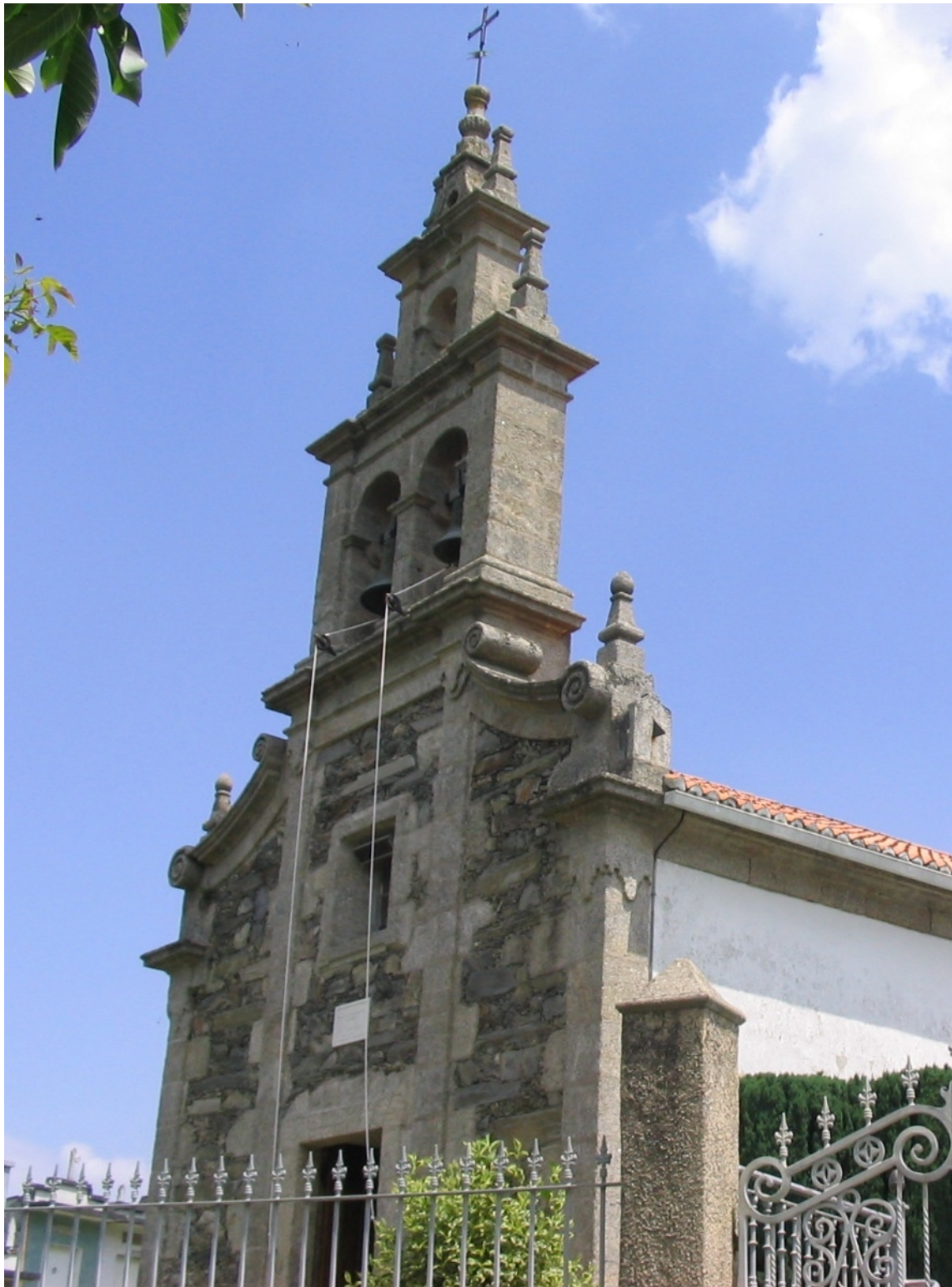
Situado en la esquina suroeste del tejado, apoyado en el costado de la espadaña.
