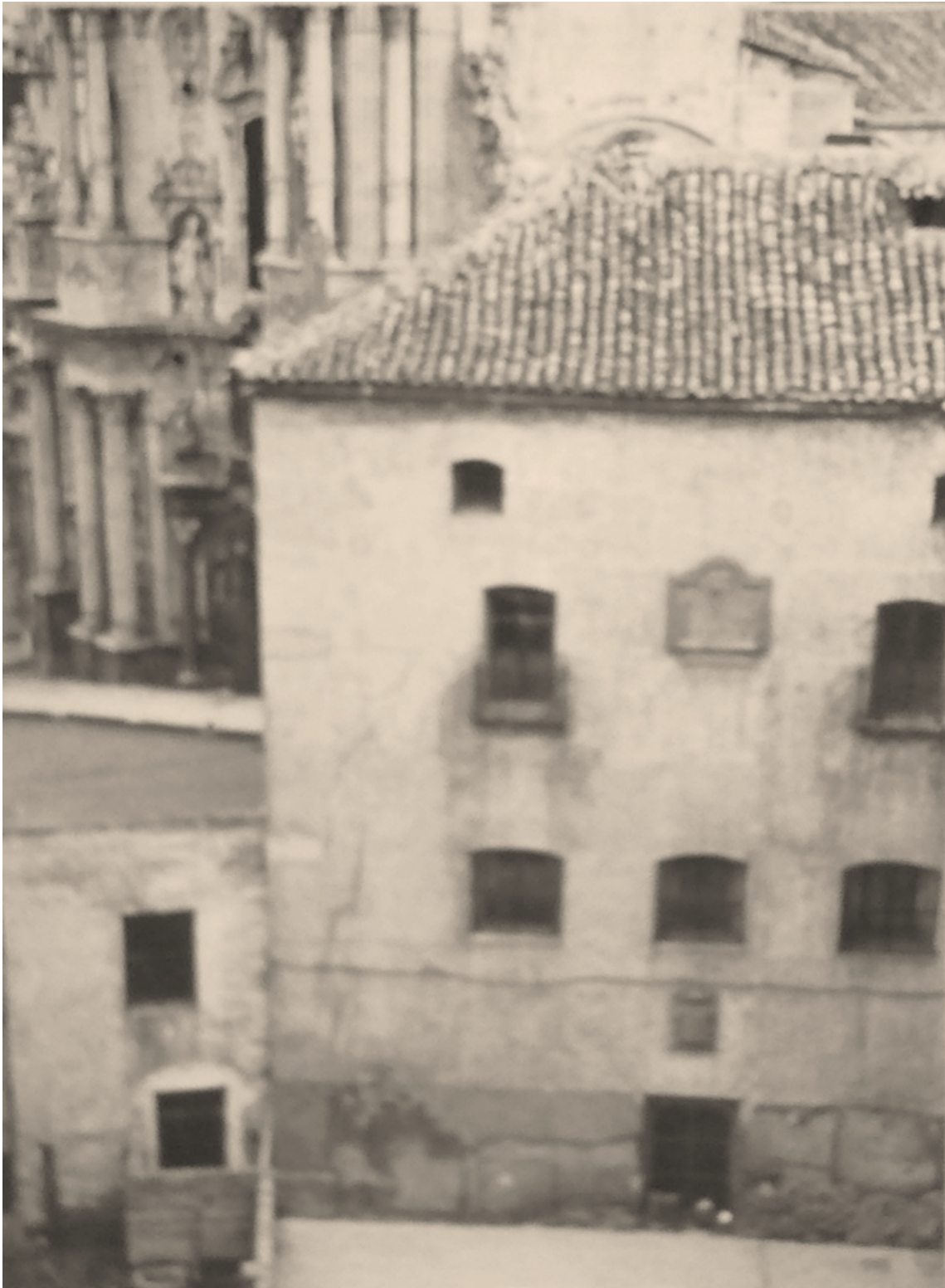
Situado entre los dos balcones de la segunda planta. Foto anterior a la restauración.
