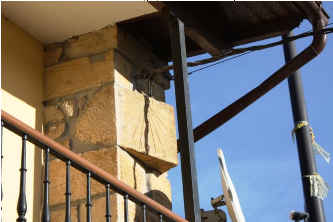
Situado en el cortafuegos, apenas visible entre el alero y la antena parabólica.
