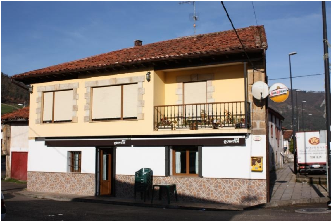
Situado en el cortafuegos, detrás de la antena parabólica.
