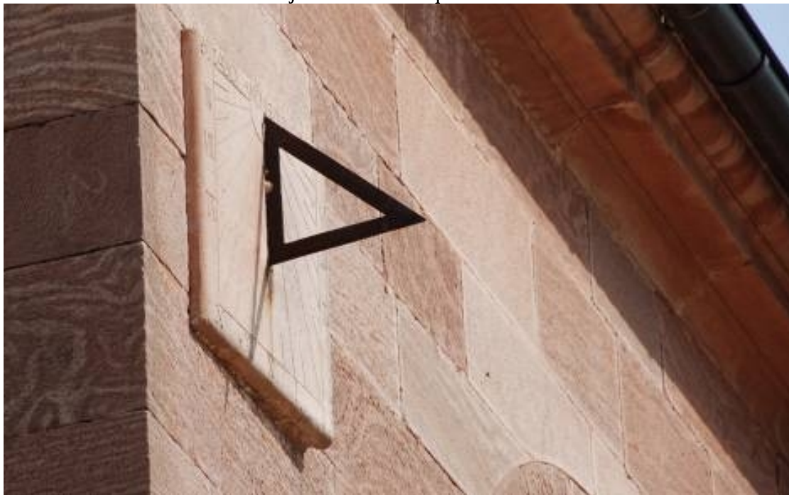
El muro declina 10^\circ a levante. Gnomon triangular tipo cartabón.
