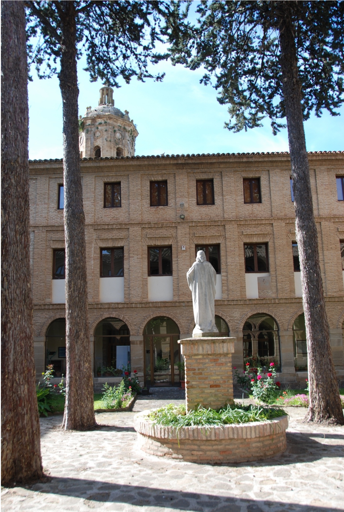
Empotrado bajo una de las ventanas del segundo piso del ala norte del claustro.
