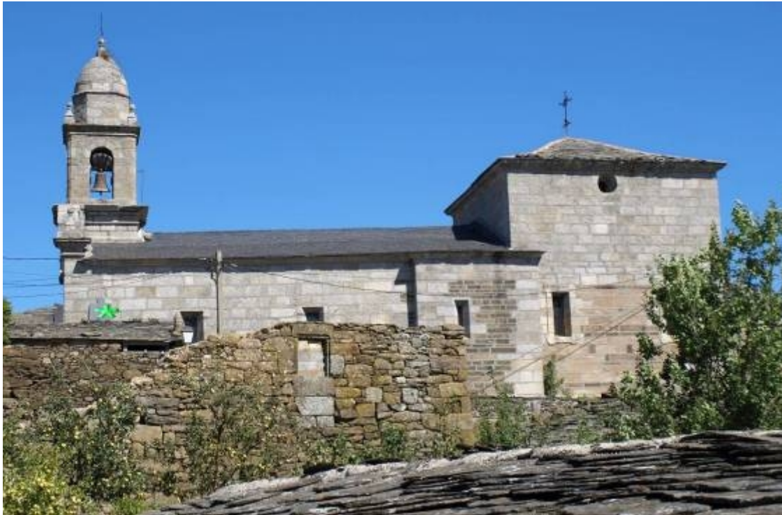
Situado en el muro de la nave bajo la torre.
