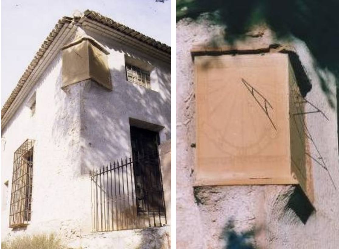
Reloj de sol doble: vertical declinante a levante y vertical declinante a poniente.
