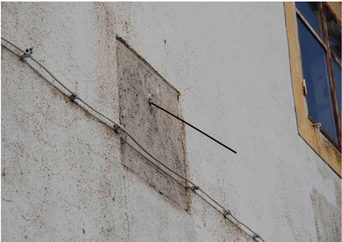
Varilla de un solo apoyo repuesta, sujeta con un taco de plástico.
