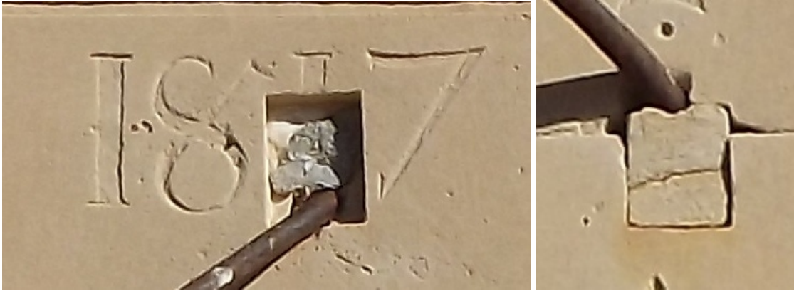
En el polo se ha desprendido la pequeña tapa de piedra. Emplomado.
