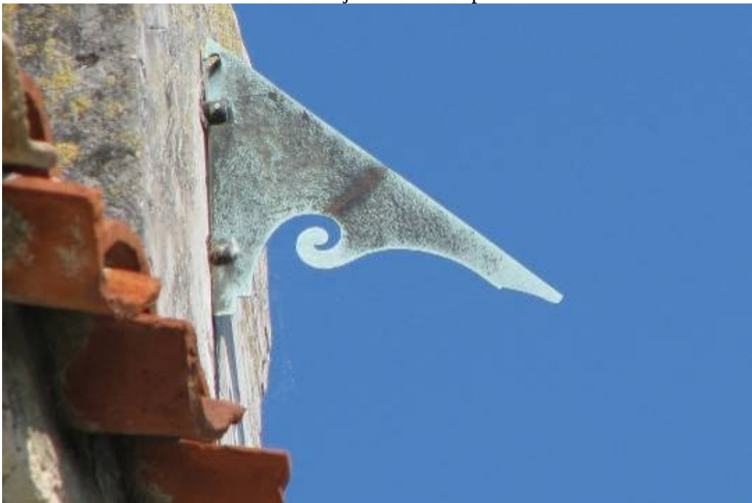
Detalle: gnomon triangular de bronce con recorte decorativo en la base.
