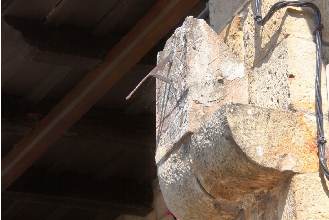
Reloj de sol triple. Cuadrante vertical a levante.
