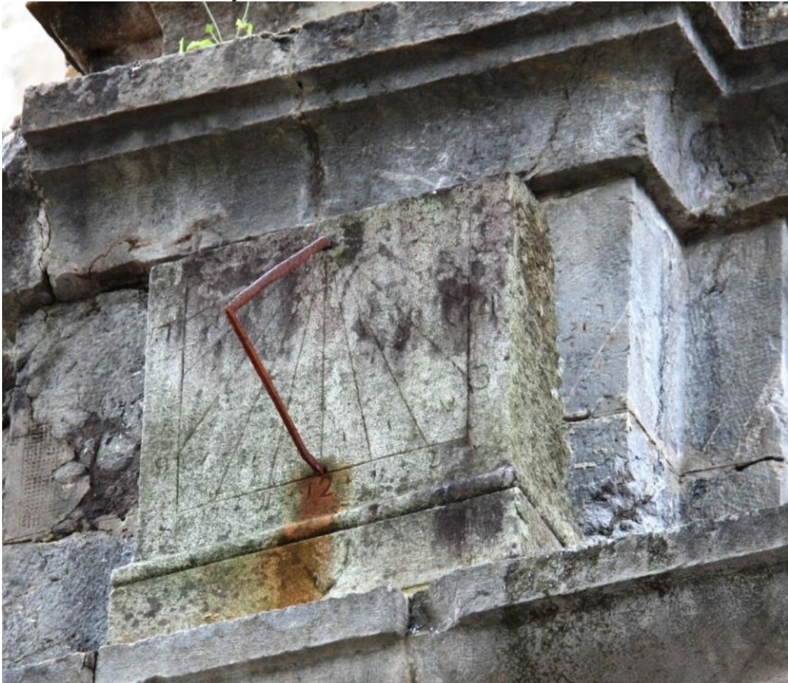
El reloj de sol está mal orientado. Declinación: 14.
