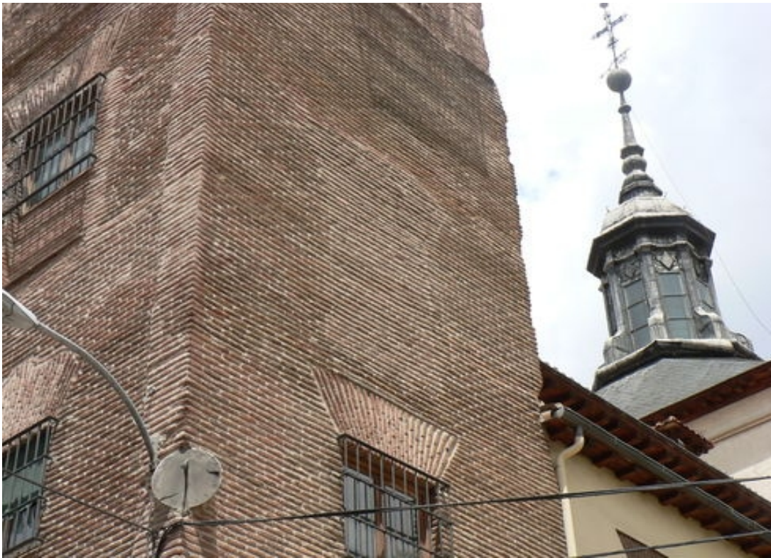
Empotrado y orientado en la esquina derecha de la fachada principal.
