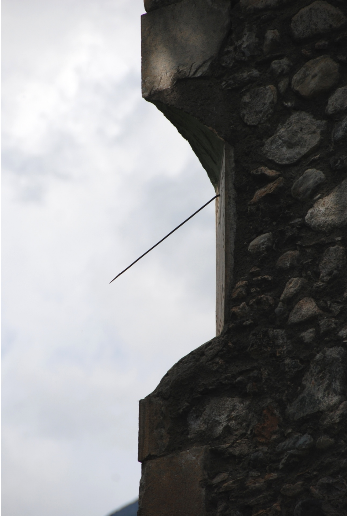
Varilla de un apoyo terminada en punta de flecha.
