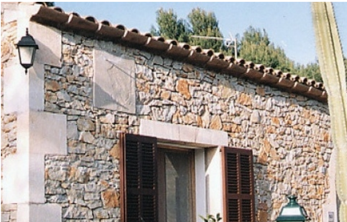
Empotrado en el muro de mampostería, en la esquina suroeste, cerca del tejado.
