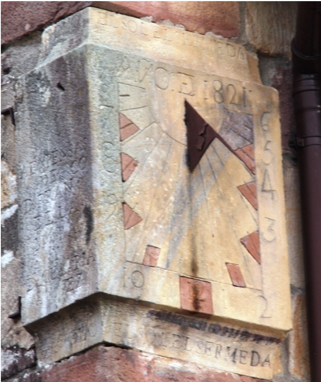
Vista lateral donde se aprecia el orificio de la varilla del cuadrante a poniente.
