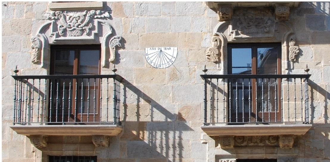
Situado entre los balcones central e izquierdo de la primera planta.
