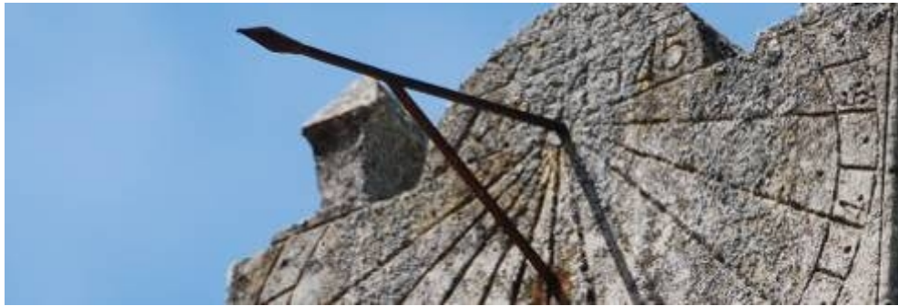
Varilla en 'Y' terminada en punta de flecha y sujeta con plomo.
