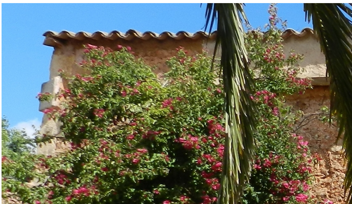
Empotrado en la esquina suroeste de la casa, cerca del tejado.
