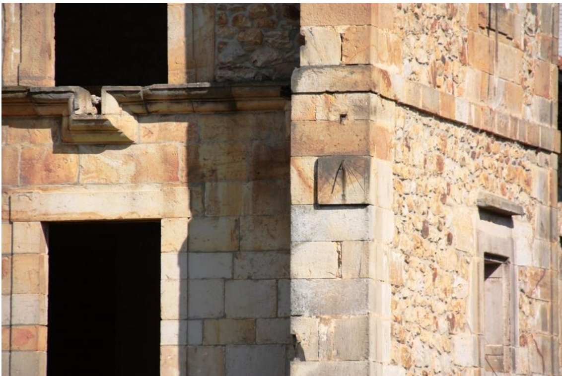
Situado en el contrafuerte derecho, a la altura del segundo cuerpo de la torre.
