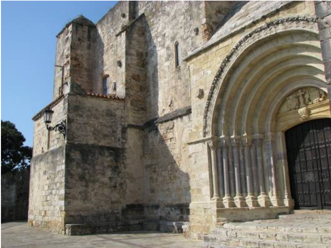
Situado sobre el tejado de una capilla lateral.
