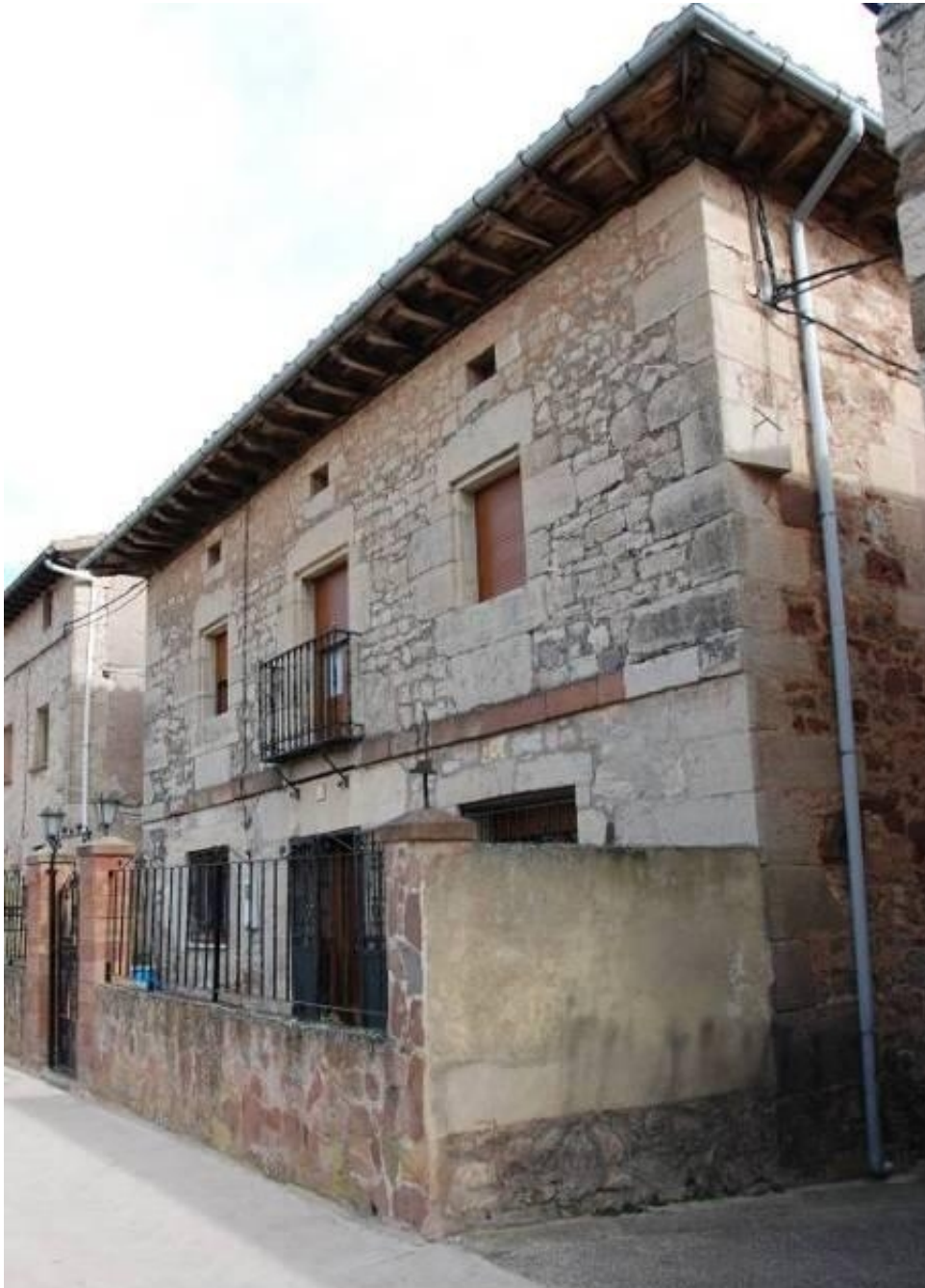
Situación del reloj en la fachada lateral de la casa.
