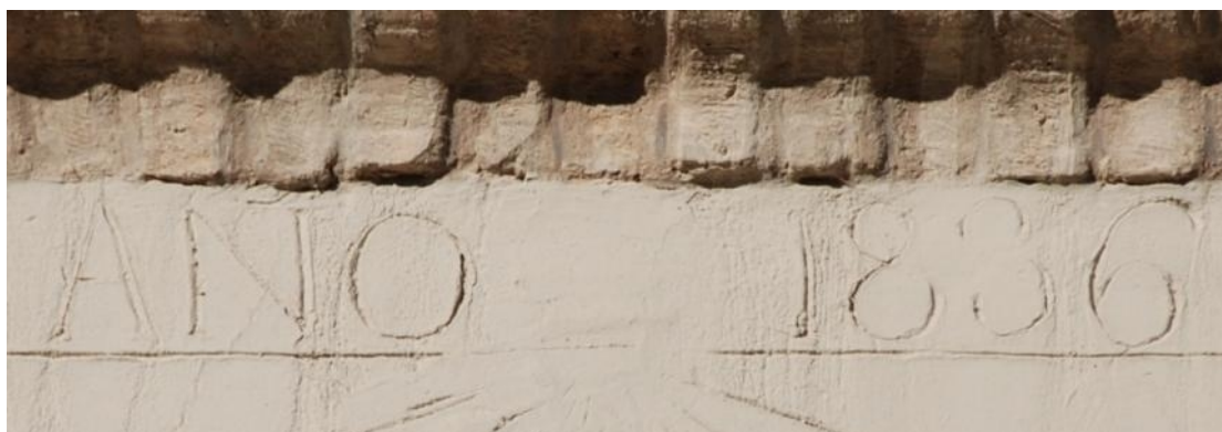
La fecha es correcta, se leía sin dificultad antes de la restauración.
