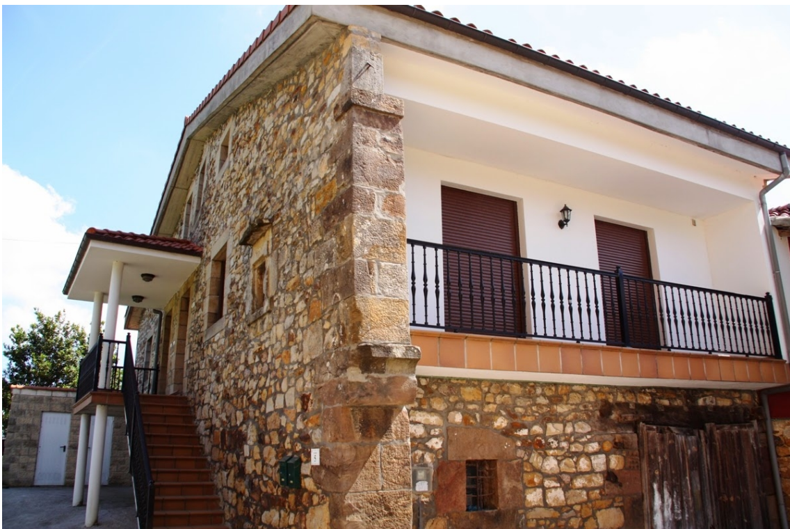
Apoyado en una repisa en la parte superior del cortafuegos izquierdo.
