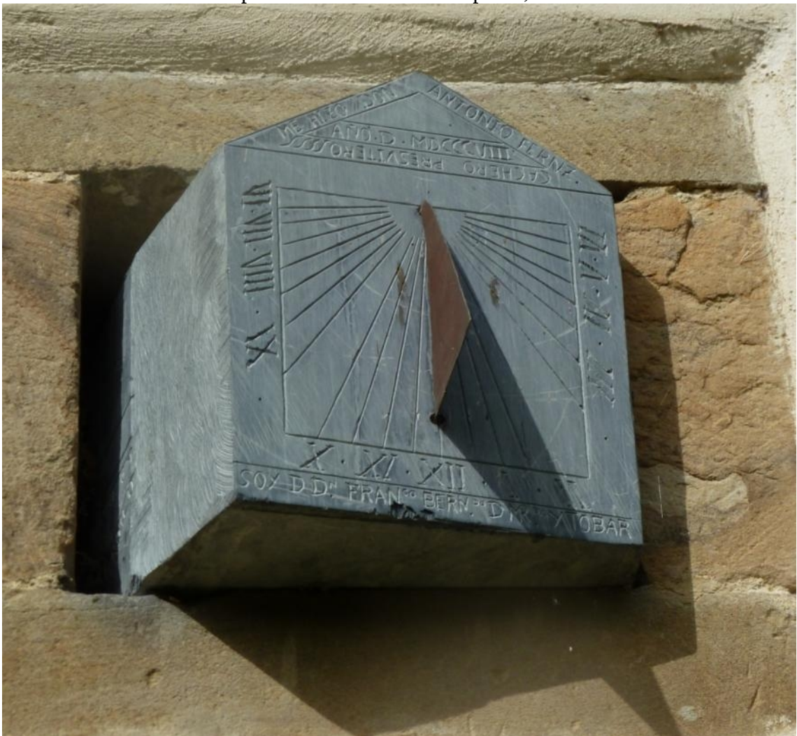
Copia. Rectangular horizontal. Mal trazado.
