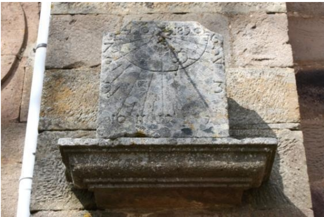
Apoyado sobre ménsula en el contrafuerte situado a la derecha de la portada.
