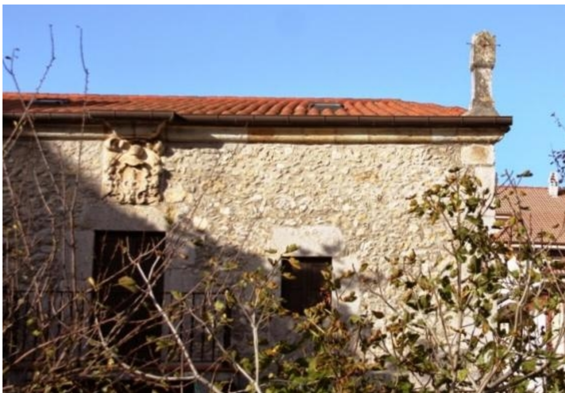
Apoyado sobre la cornisa del tejado en la esquina sureste de la casa.
