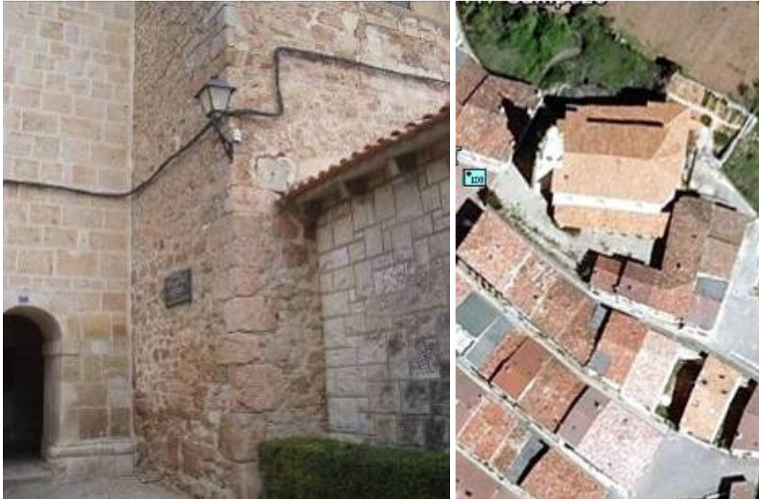
El reloj de sol en la esquina suroeste de la nave. Declinación a poniente del muro.
