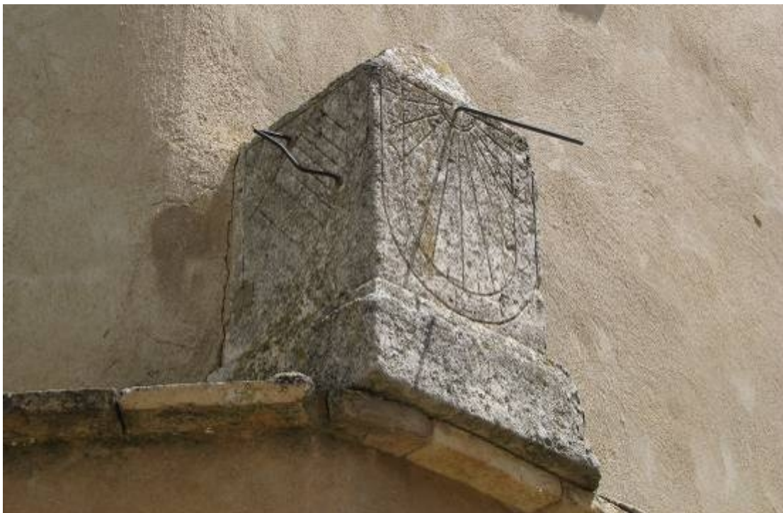
Reloj triple. Cuadrantes vertical a mediodía y vertical a poniente.
