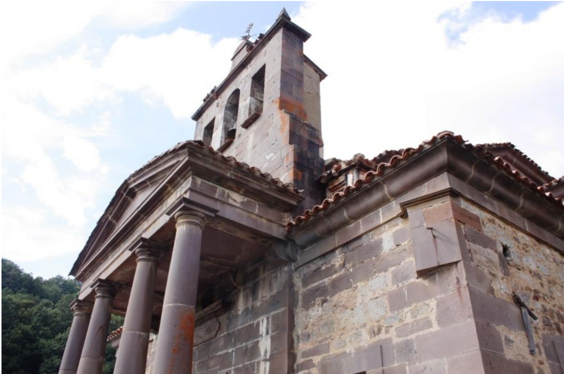
Situado en la esquina sureste de la nave, a la derecha del pórtico neoclásico
