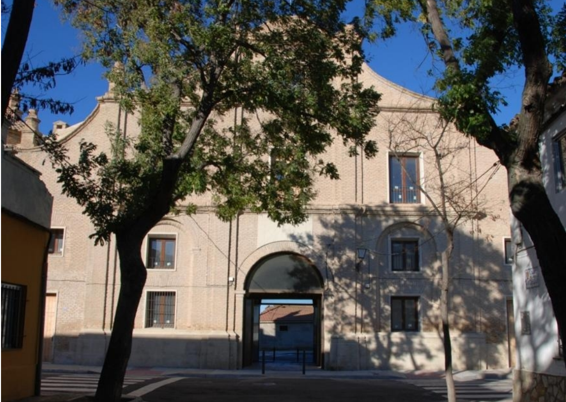
Fachada interior de la portería de la cartuja tras la última restauración.
