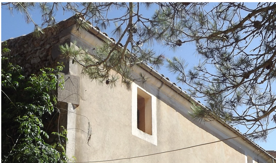
Empotrado en la esquina suroeste de la casa, cerca de la cornisa del tejado.
