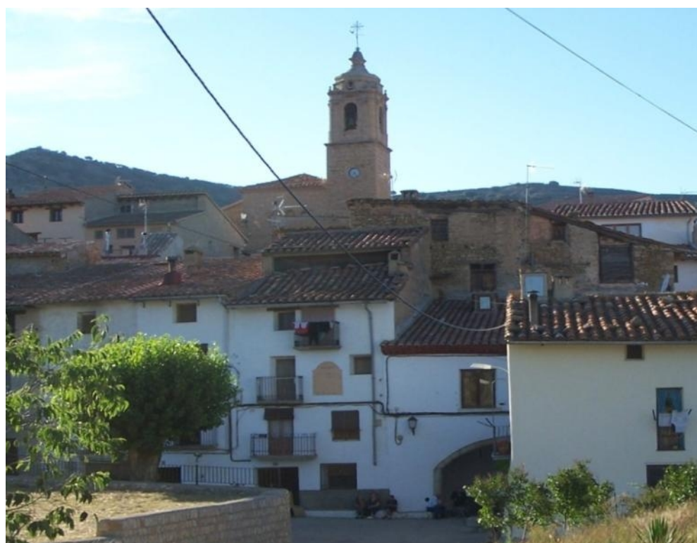
La casa del reloj de sol antes y después de la restauración.
