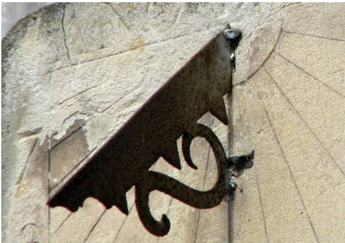
Detalle. Gnomon decorativo de chapa de hierro. Tramo de apoyo en 'S'.
