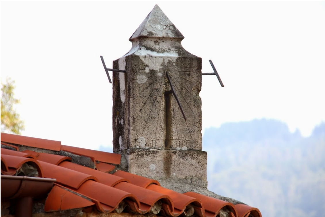
Apoyado sobre otro sillar encima del tejado, en la esquina sureste de la iglesia.
