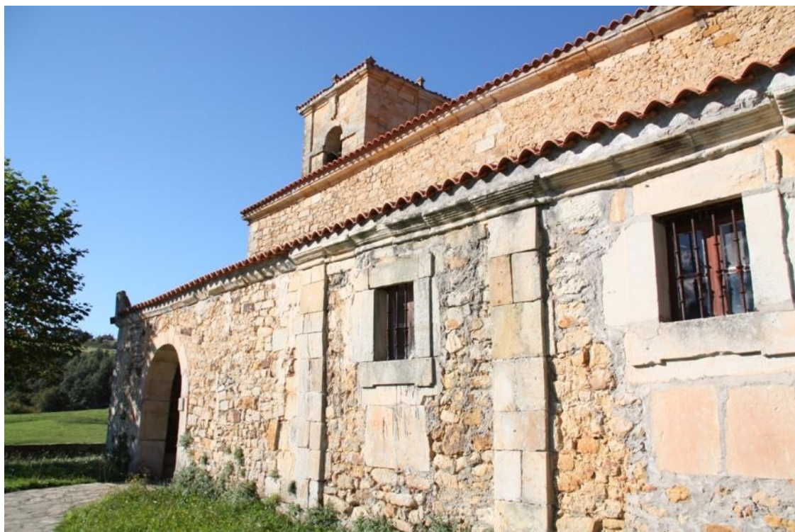
Apoyado sobre la cornisa de la esquina suroeste del pórtico.
