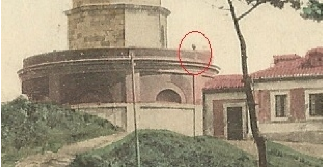
En el pretil de la azotea del faro sobresale la bola del reloj de sol esférico.
