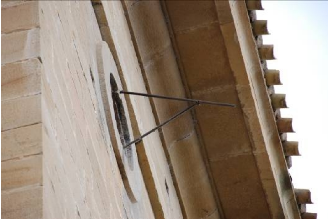
Varilla original de dos apoyos en “y”. Orificio de apoyo en la vertical.
