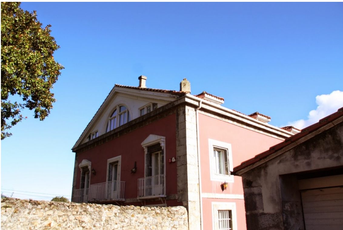
Apoyado sobre la esquina suroeste del tejado.
