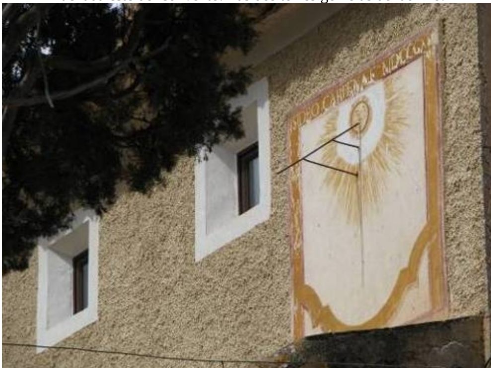
Pintado en una superficie enlucida en la esquina SE del convento.
