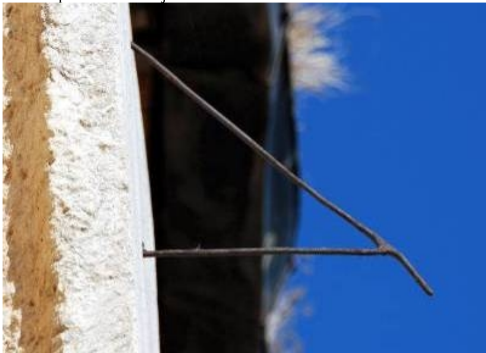
Varilla de dos apoyos en 'Y' con el extremo doblado.
