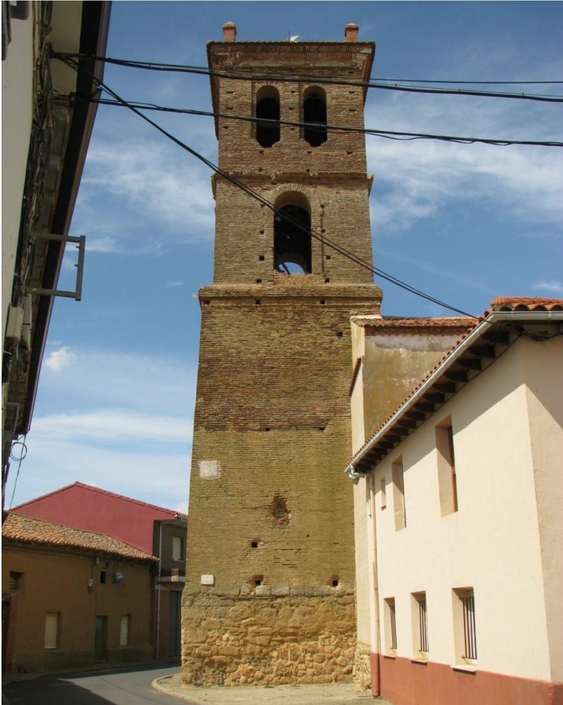
Reloj de sol empotrado en el primer cuerpo de la torre. Restaurado.
