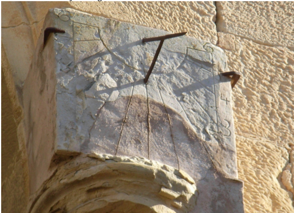
El reloj de la iglesia de Moreda después de la restauración. 03/08/2007.
