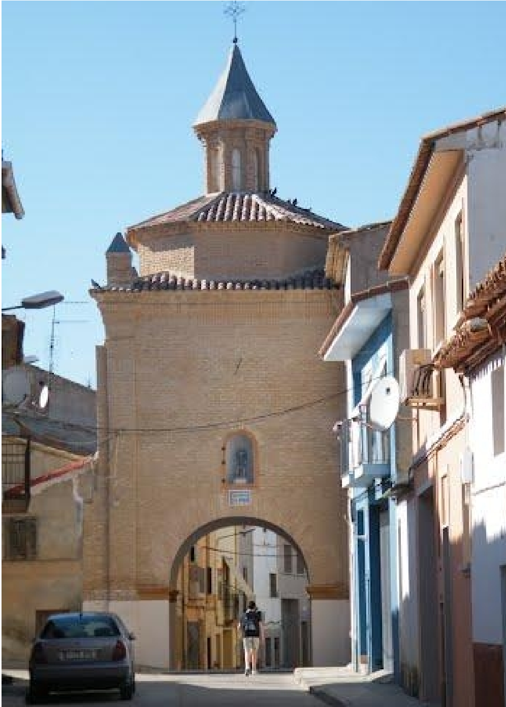
El portal de San Roque tras la restauración del año 2010.
