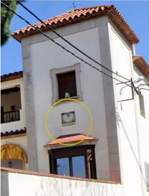
Mural cerámico cuadrado (60x60) compuesto por 16 azulejos. Trazo vertical a mediodía. Numeración horaria en arábigos, de 6 de la mañana a 6 de la tarde. Varilla de un solo apoyo, mal orientada.
