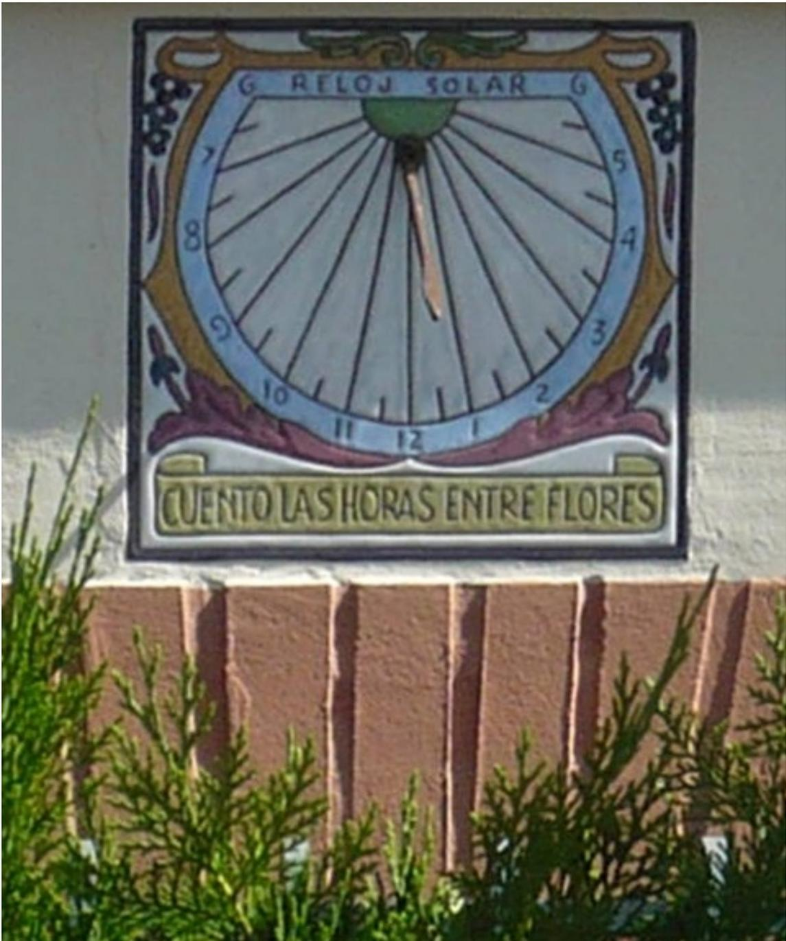
Mural cuadrado de una sola pieza (15x15 cm) realizado a la cuerda seca. Traza vertical a mediodía. Numeración horaria en arábigos, de 6 de la mañana a 6 de la tarde. Líneas cortas de medias horas. Varilla de un apoyo terminada en punta de flecha, mal colocada en uno de los orificios destinado a sujetar un gnomon triangular. . Inscripción superior: “RELOJ SOLAR”. Leyenda: “CUENTO LAS HORAS ENTRE FLORES”. Firma ilegible.
