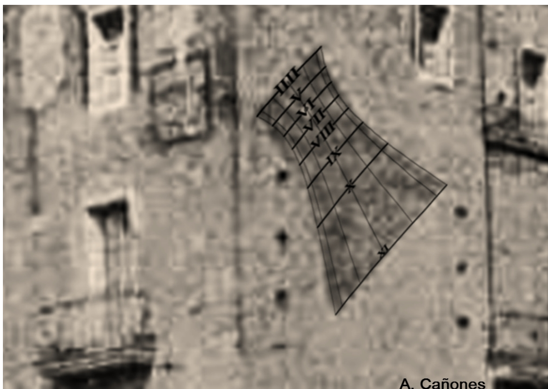
Reconstrucción del cuadrante a levante del reloj de sol triple de la Casa Blanca.
