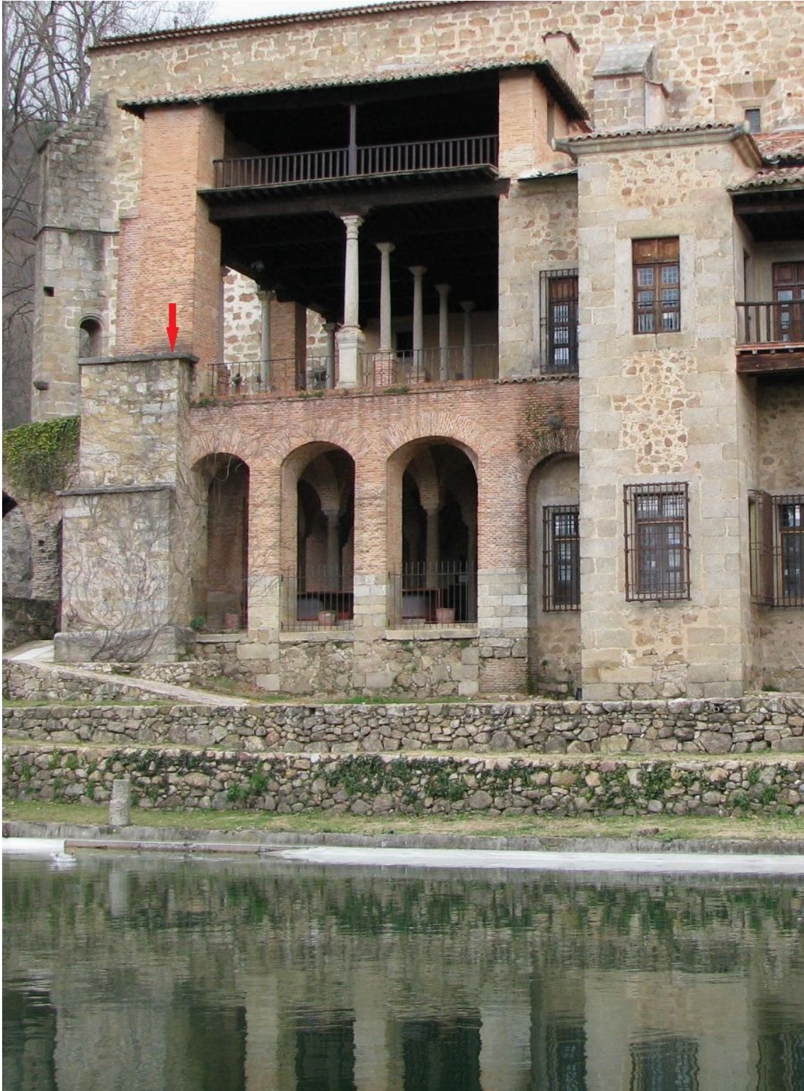
Situación del reloj de sol horizontal sobre el contrafuerte de la esquina.
