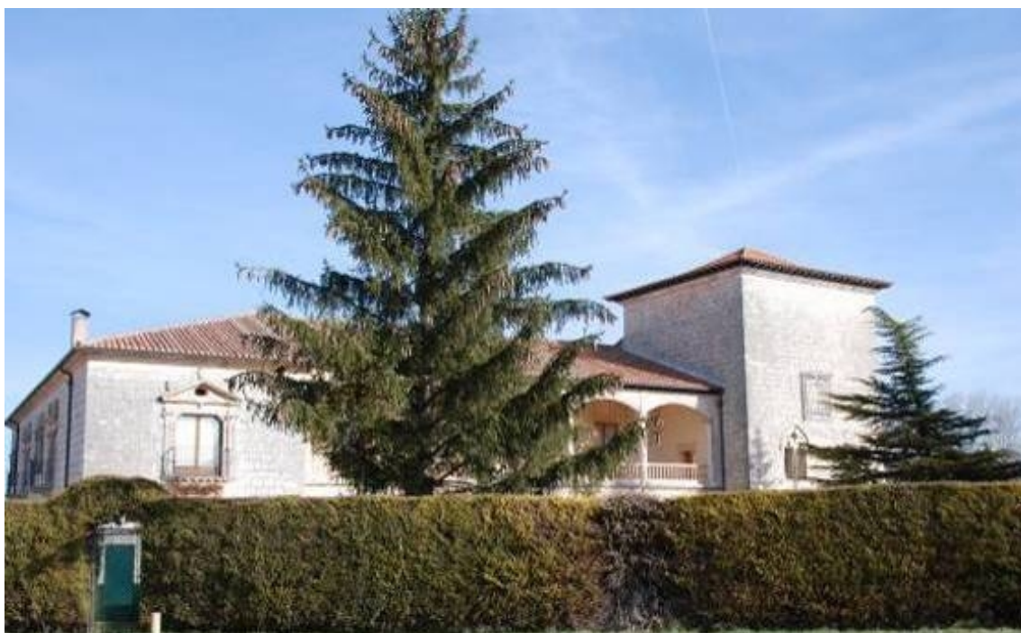
Fachada sur del Palacio de Saldañuela.
