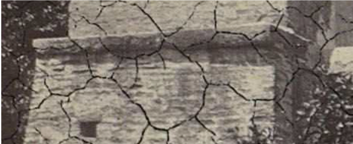
El contrafuerte original era de ladrillo y tenía forma de tronco de pirámide. Año 1858.
