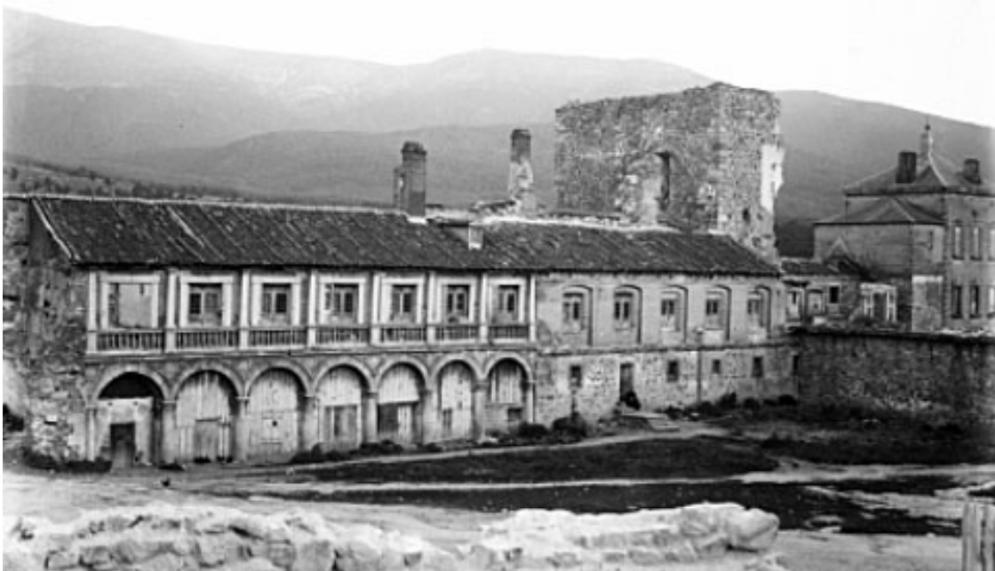
Valsáin. Fachada principal, ruinas de la Torre Vieja y la Torre Nueva.
