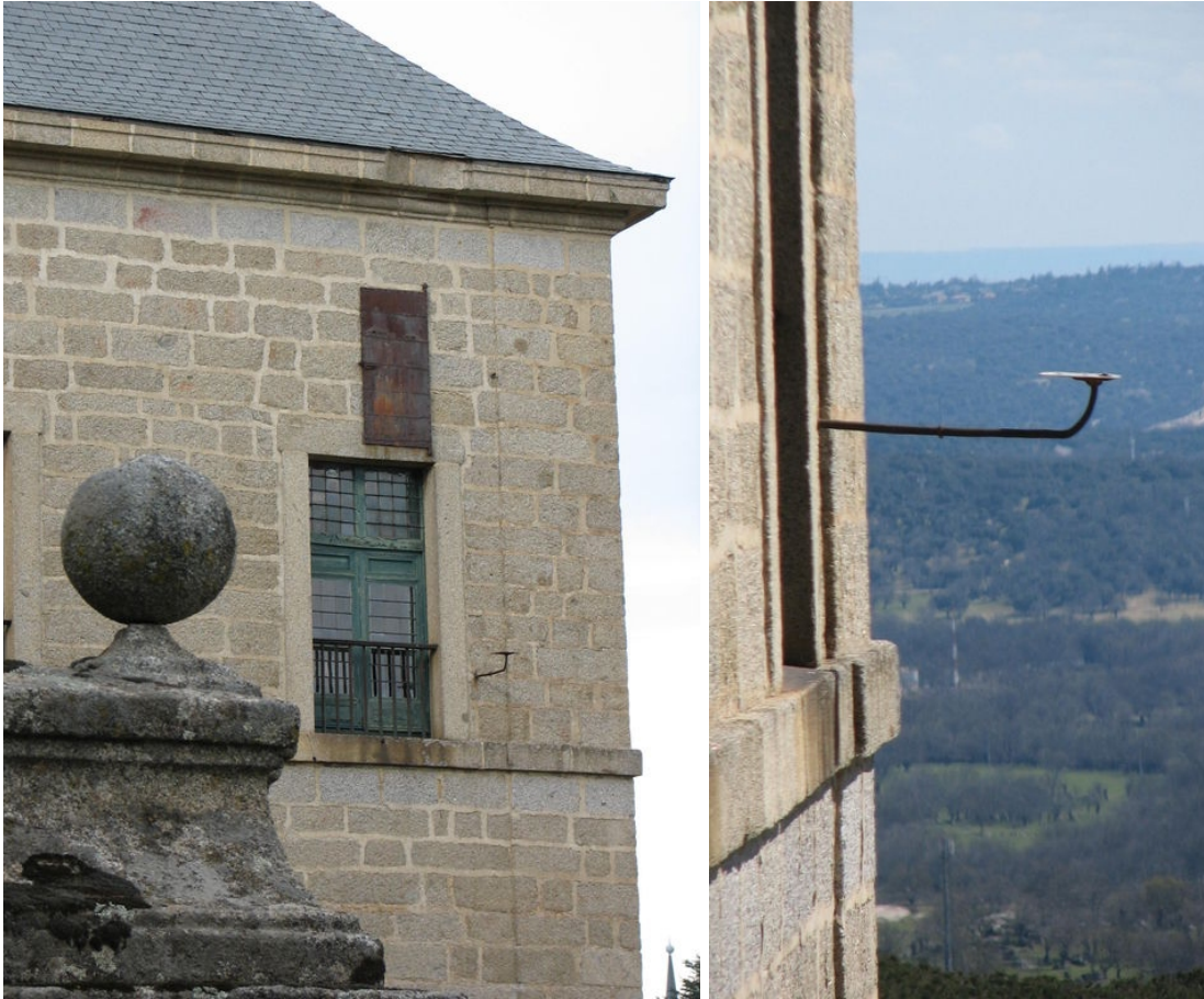
3. Reloj horizontal del balcón del Salón de Paseo.
