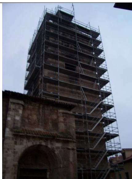
Andamiaje de la torre
