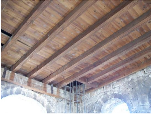
Estructura de la Sala del reloj (Tercer piso)
