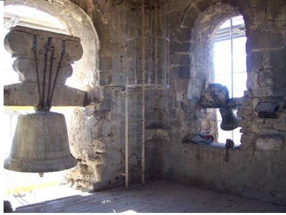
Campanas (1) y (7) Escaleras de acceso a la sala del reloj
