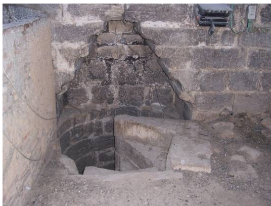
Finalización de las escaleras de Subida (Interior del primer piso)
