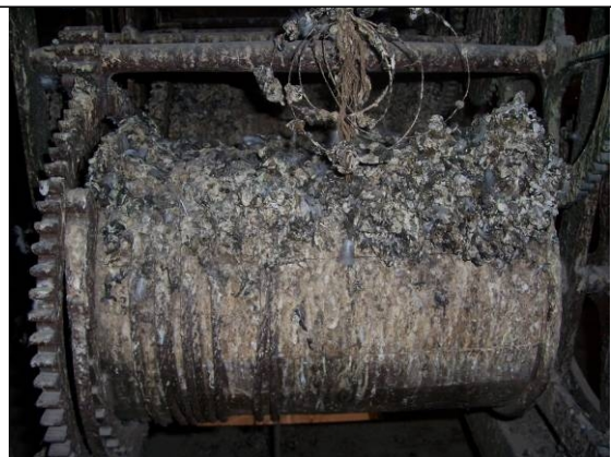
Estado de conservación del reloj
