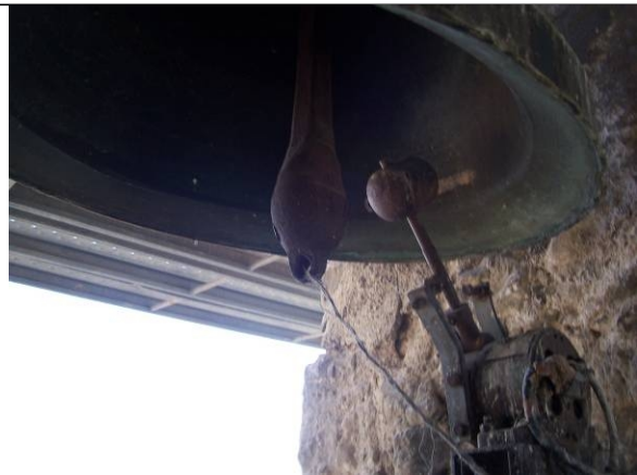
Boca de la Campana y Electromazo interno sin uso.
