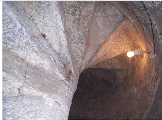
Escaleras de piedra de la Subida
