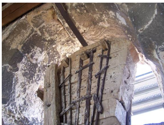
Yugo de la Campana – Tira de hierro anclada a la campana para impedir su volteo.
