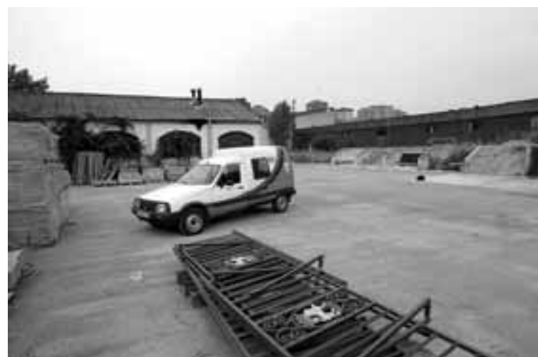
Las cinco naves del almacén municipal se derribarán en breve.
