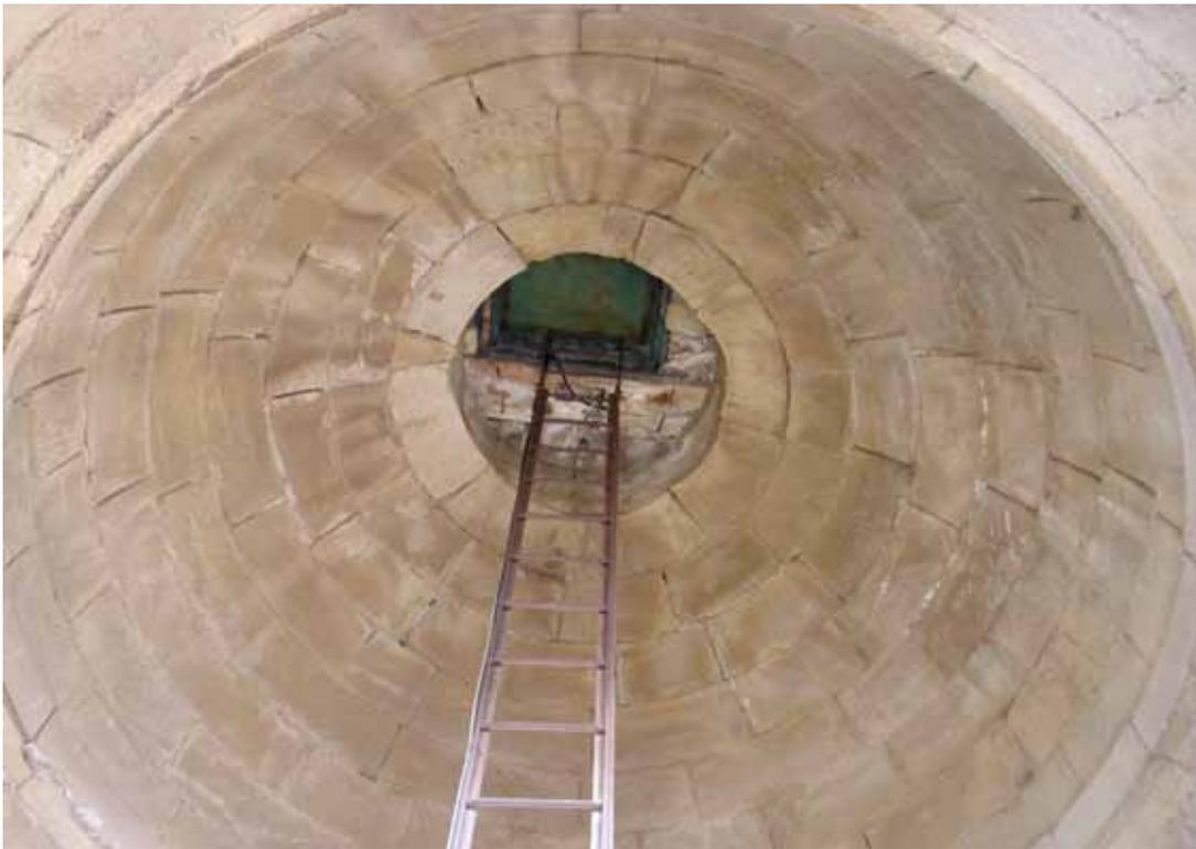
Un hueco de paso al interior resulta de escasa entidad, abierto junto al muro que constituye la fachada suroeste, permite acceder desde la nave a la escalera que asciende en vertical la altura de la torre. Contiguo, y volcado a ese primer tramo de acceso hay un altar cuya profundidad se practicó desmontando parcialmente el espesor de ese nivel que coincide con la nave principal.
