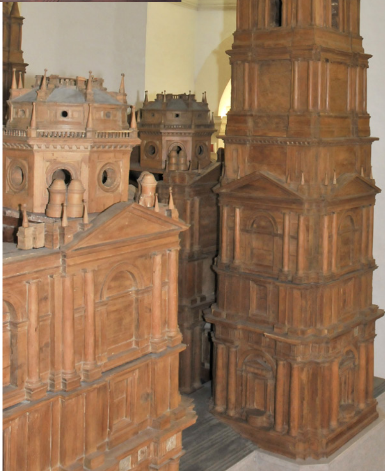
Modelo en madera de la basílica de Antonio de San Gallo. Pensaba construir dos campanarios a ambos lados de la fachada (supra), pero separados del cuerpo de la Basílica (infra)
