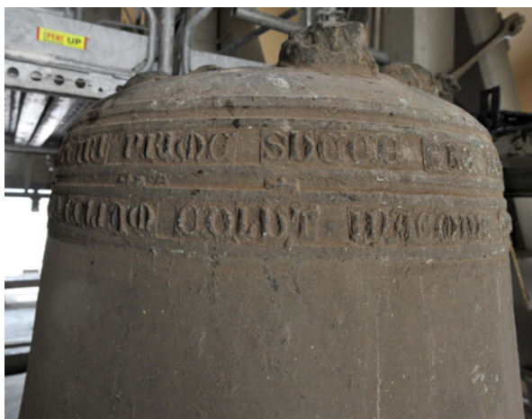
Campana de la Rota bajada para ponerla a tono. Obsérvense los orificios practicados en la parte superior para colgarla, una vez que, desde tiempo impreciso, se habían quebrado las asas
