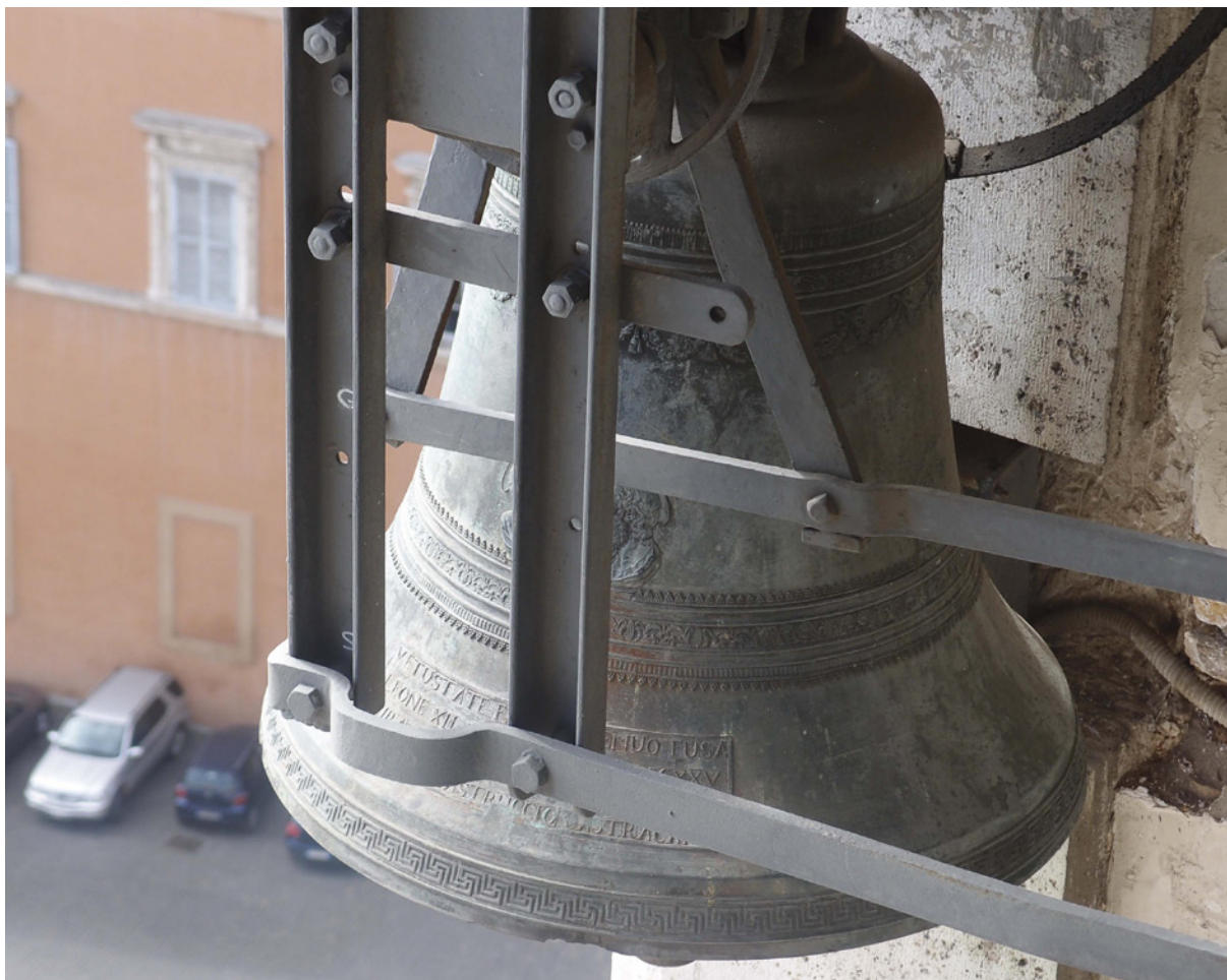
Imagen de la Campanella y su sistema de sujeción
