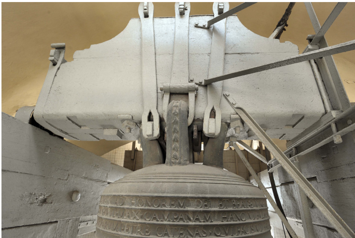
Campanoncino. Detalle del hombro, las asas y el yugo. Se aprecia el modo de unión de las asas con el yugo, así como el apoyo sobre cojinetes en los travesaños, de manera que la camapana se bandeja fácilmente
