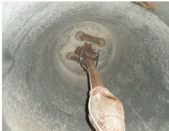
Detalles de la sujeción de la campana de la Rota al exterior e interior
