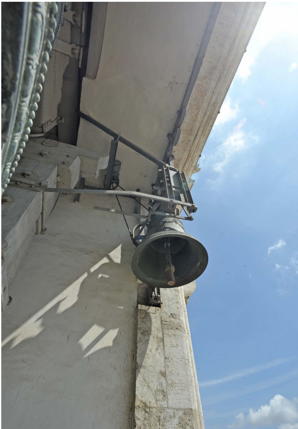
Campana del Ave María. Colgada en la parte exterior del ventanal de la campanas. En la parte superior izquierda el borde del campanone
