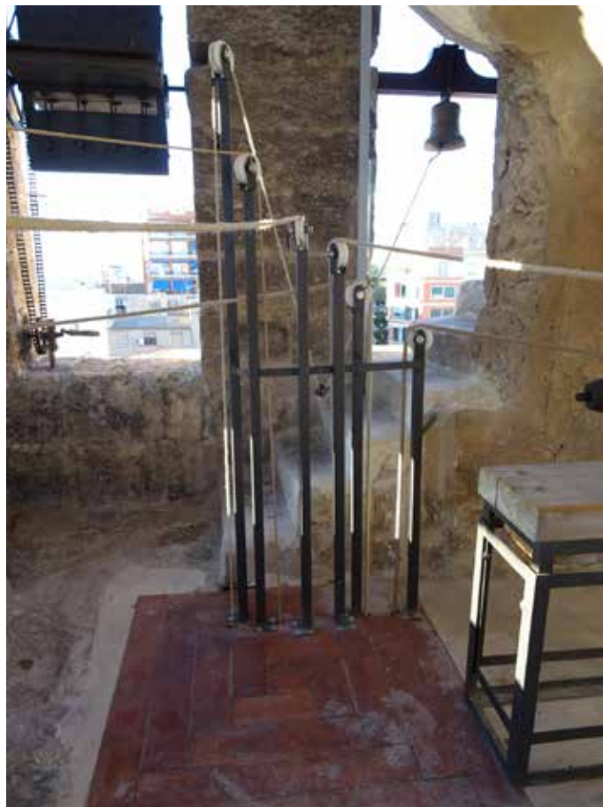
Fig. 5: La nueva estructura de poleas para el toque manual en Santiago (25-10-2018).
