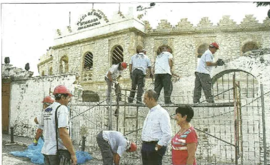
Los operarios echan abajo el muro perimetral que tapaba la plaza de la Joya Levantina. LEVANTE EMV
