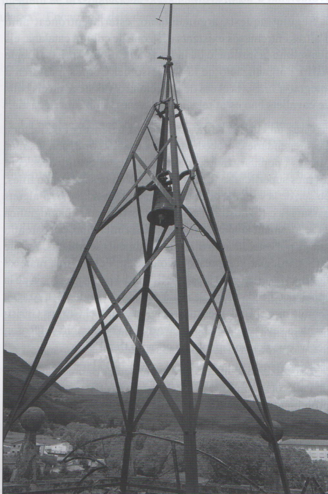
Estructura metàl·lica del terrat amb la campana del rellotge
