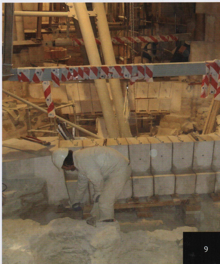
Arcos de refuerzo de las cimentaciones. Nave central.
