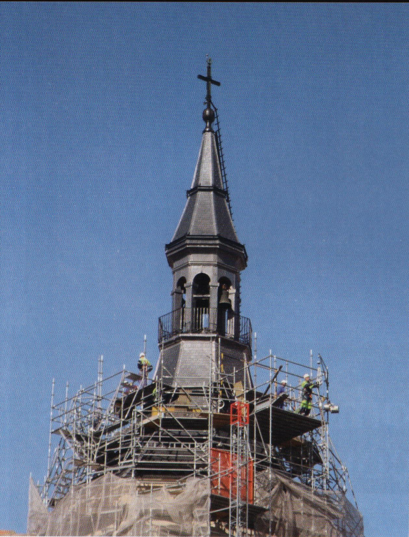
Desmontaje del andamiaje del chapitel de la torre.
