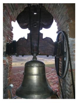
HECHOS A FORJA SIN SOLDADURA PARA EVITAR ROTURAS, CON ROSCA DE PASO MILIMÉTRICA NORMALIZADA CON TUERCAS Y CONTRATUERCAS, CON PROTECCIÓN DE DOS CAPAS DE PINTURA ANTIOXIDANTE Y OTRA DE COLOR NEGRO.
