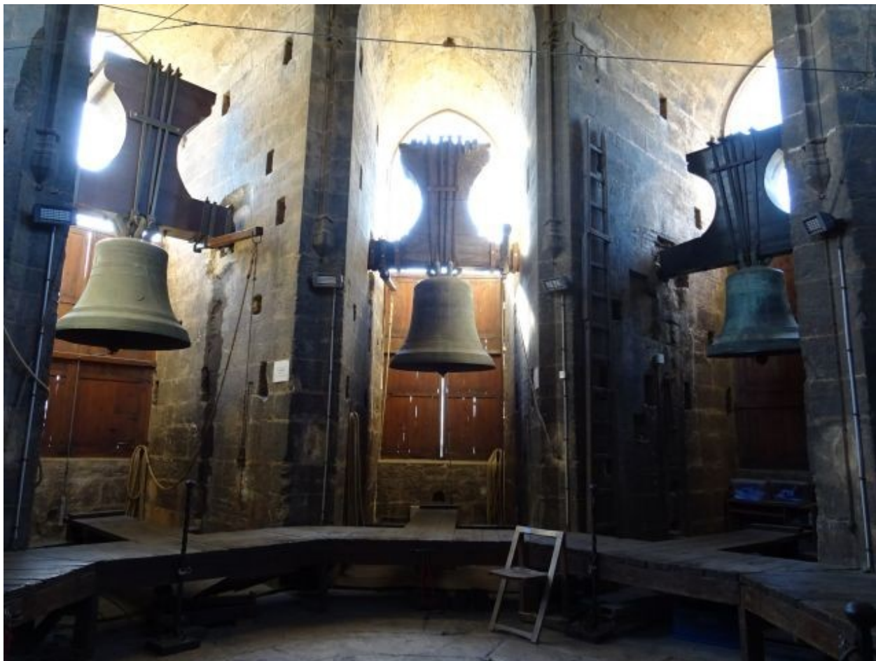
La sala de campanes (01-12-2017)
