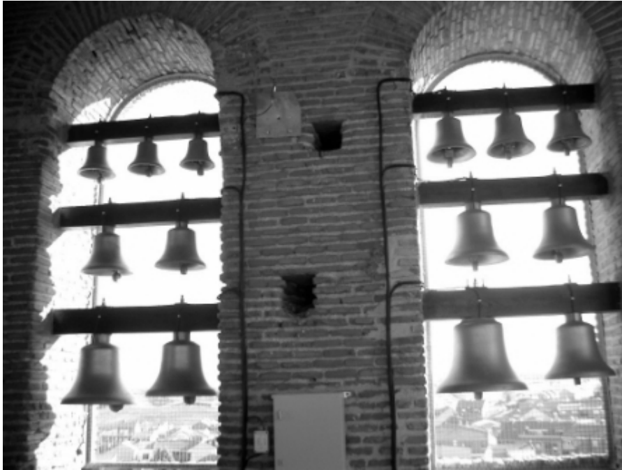
Lám. 33. Carillones instalados.
