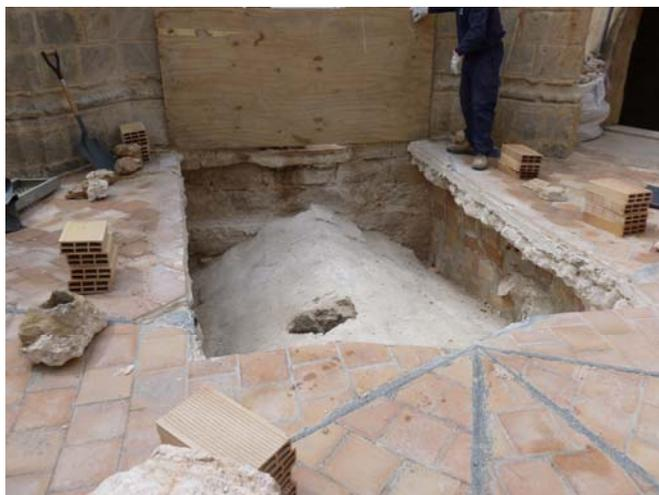
Los yugos de las campanas se van desmontando dejando los broncees libres, colocados sobre vigas que reparten el peso con las estructuras de madera del campanario. Con la ayuda de poleas y raíles de desplazarán hasta coincidir con el hueco abierto para ser izadas con la grúa (mientras no se utilice el hueco se instalará una cubierta par proteger de la lluvia el interior del campanario.
